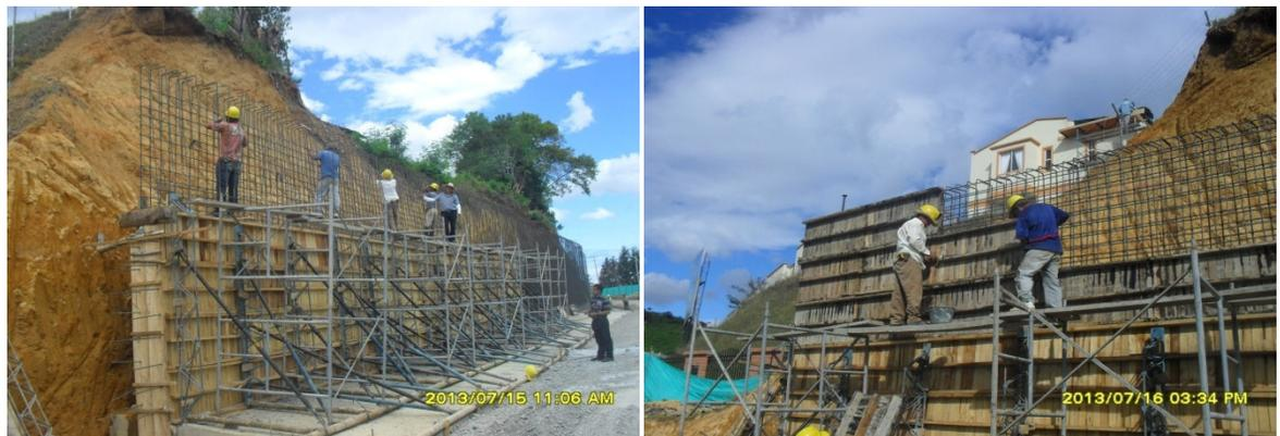
IMÁGENES No.71. INSTALACIÓN DE ACERO Y FORMALETA PARA LA FUNDICIÓN DEL SEGUNDO NIVEL ENTRE LAS ABSCISAS K0+800 Y K0+820
