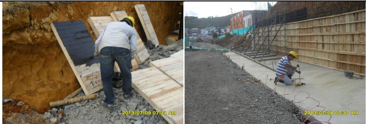
IMÁGENES No.67. PREPARACIÓN DE FORMALETA E INSTALACIONES DE PINES EN LA ZARPA DEL MURO PARA USARLOS COMO ATRAQUES EN LA FUNDICIÓN DEL VÁSTAGO.
