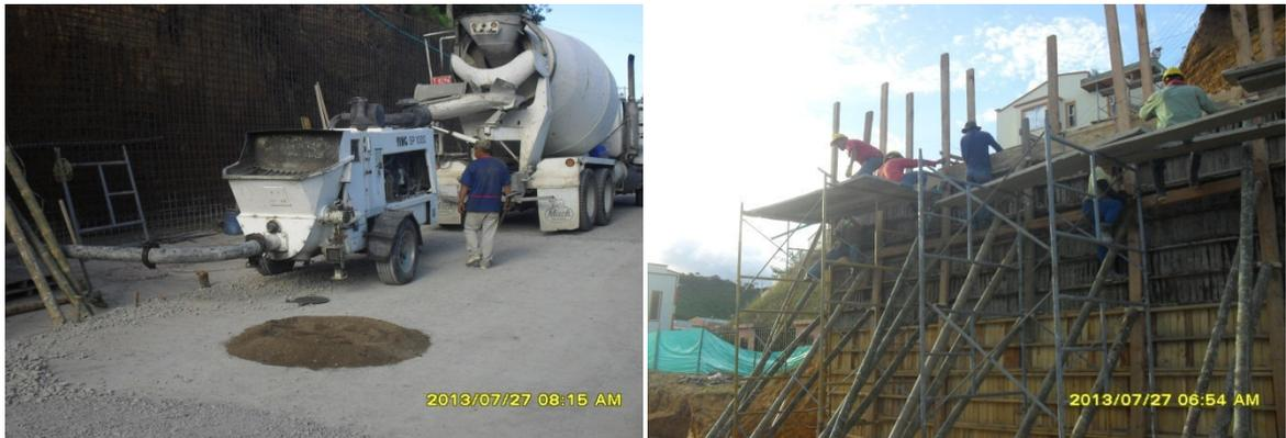
IMÁGENES No.72. PREPARACIÓN DE MORTERO FLUIDO PARA EL CEBADO DE LA BOMBA PARA LA FUNDICIÓN DEL SEGUNDO NIVEL ENTRE LAS ABSCISAS K0+800 Y K0+820
