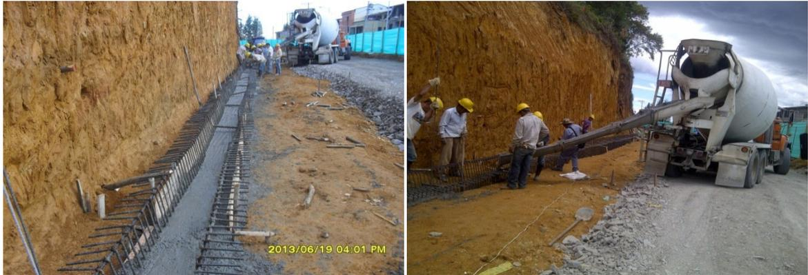
IMÁGENES No.53. FUNDICIÓN DEL DIENTE CON CONCRETO PREMEZCLADO CLASE D.
