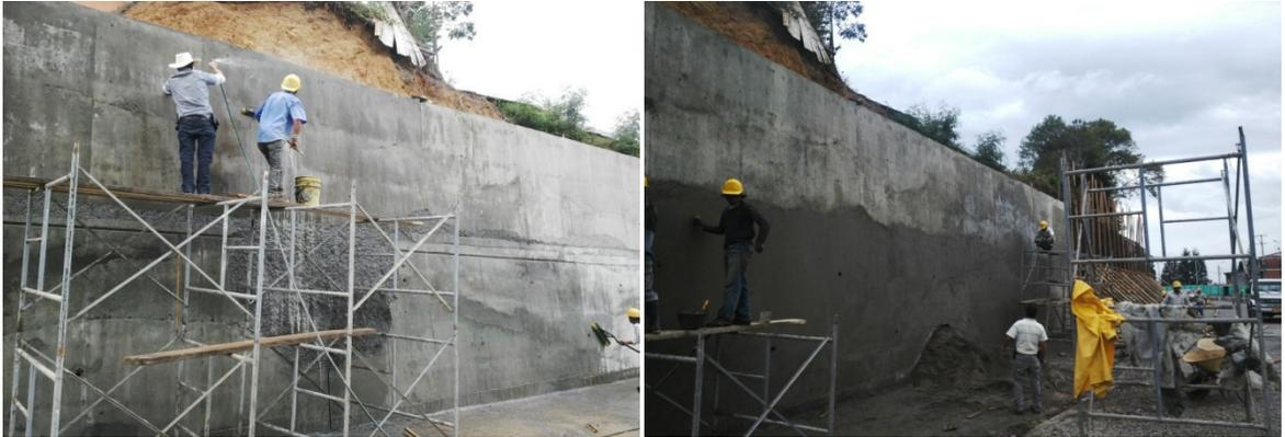
**IMAGENES No.75. RESANE DEL VÁSTAGO DEL MURO ENTRE LAS ABCISAS K0+800 Y K0+820, PRIMERO Y SEGUNDO NIVEL.**
