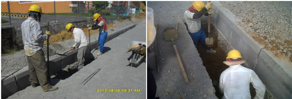
IMÁGENES No.86. EXCAVACIÓN PARA CONSTRUCCIÓN DE SUMIDEROS.
