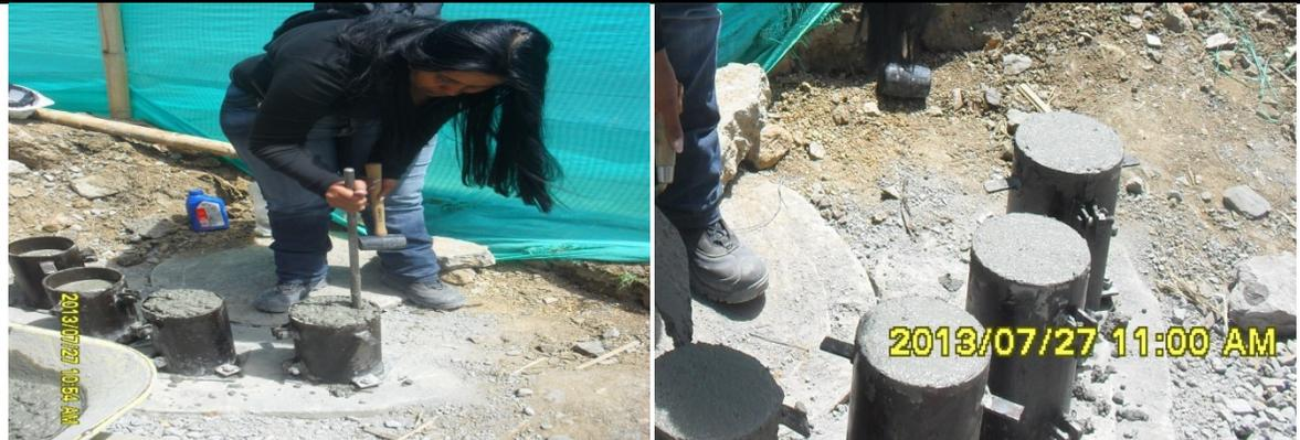
**IMÁGENES No.73. LLENO DE CILINDROS PARA EL CONTROL DE CALIDAD DE LA RESISTENCIA A LA COMPRESIÓN DEL CONCRETO EMPLEADO EN LA FUNDICIÓN DEL SEGUNDO NIVEL ENTRE LAS ABCISAS K0+800 Y K0+820**
