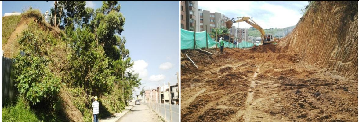
**IMÁGENES No. 47. CORTE Y PERFILADO MECÁNICO DEL TALUD PARA GARANTIZAR EL ANCHO DE LA CALZADA.**
