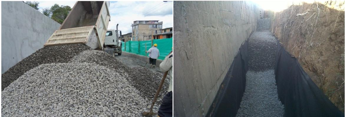
IMÁGENES No.79. LLENO DE MATERIAL FILTRANTE, GRAVA DE 2", PARA LA CONSTRUCCION DEL FILTRO DEL MURO.
