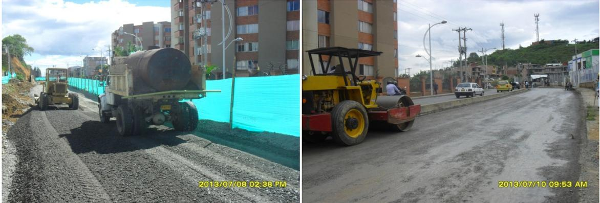
IMAGENES No.38. COMPACTACION DEL MATERIAL DE SUB BASE, VIBRO COMPACTADOR DE 7 TON.
