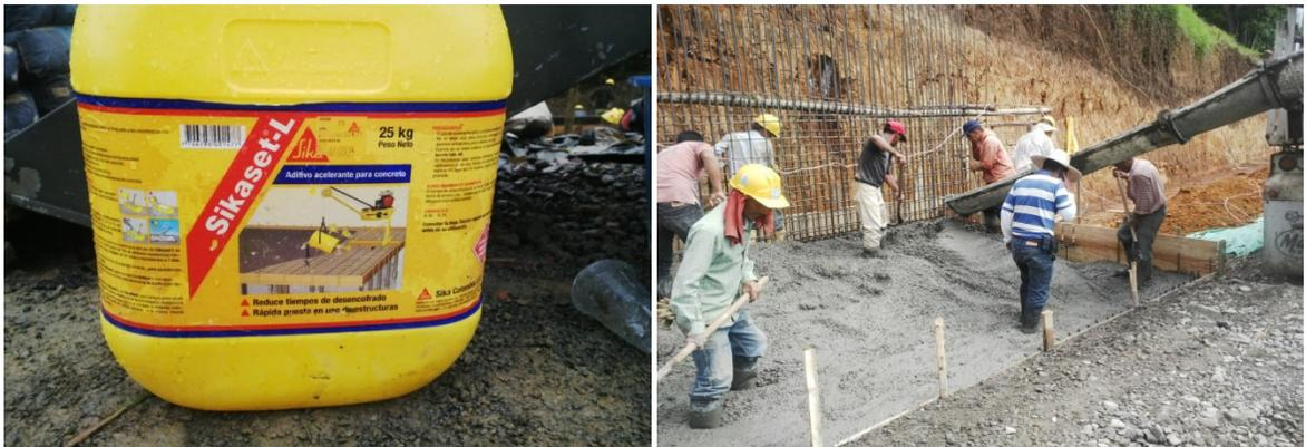
IMÁGENES No.59. ADITIVO ACELERANTE Y FUNDICIÓN DE LA ZARPA DEL MURO.
