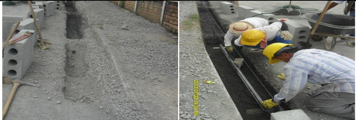
IMÁGENES No.81. EXCAVACIÓN Y CONTROL DE NIVELES PARA LA INSTALACIÓN DE SARDINEL PREFABRICADO.
