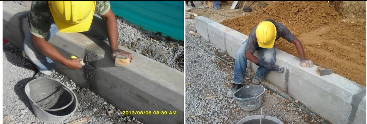
IMÁGENES NO.83. ANILLADO Y EMBOQUILLADO DE SARDINEL PREFABRICADO.
