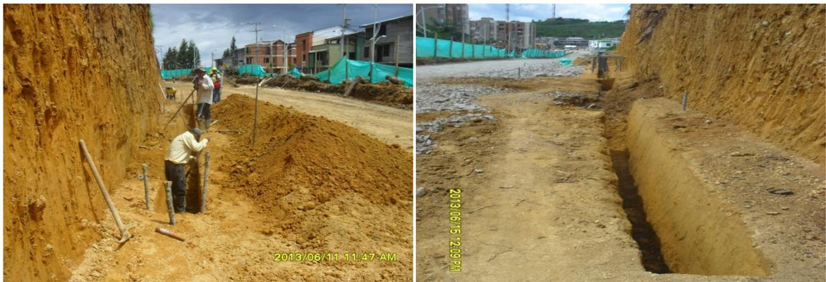
IMÁGENES No. 50. EXCAVACIÓN MANUAL DEL DIENTE DEL MURO DE CONTENCIÓN.
