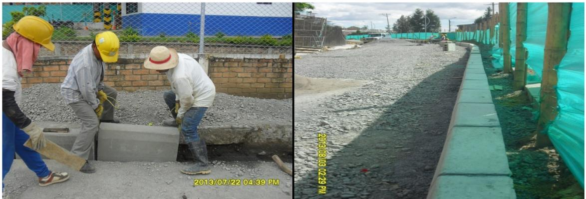
IMÁGENES No.82. INSTALACIÓN DE SARDINEL PREFABRICADO.
