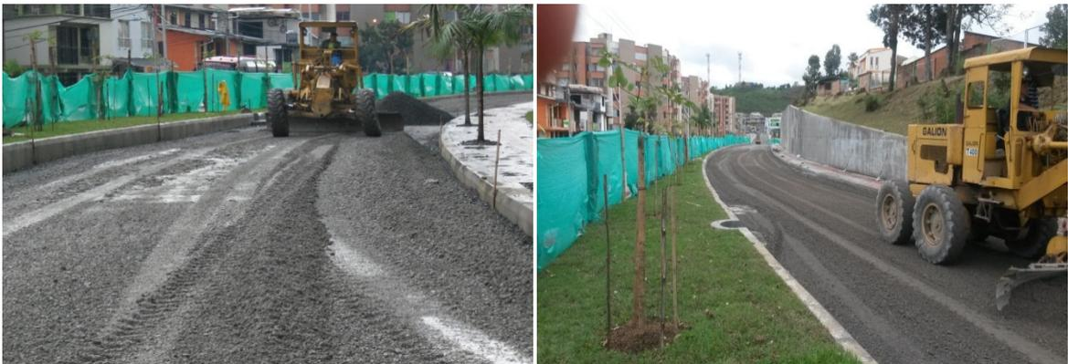
IMÁGENES No.42. COLOCACIÓN DEL MATERIAL DE BASE EN CORDÓN UNIFORME Y EXTENSIÓN CON MOTONIVELADORA.
