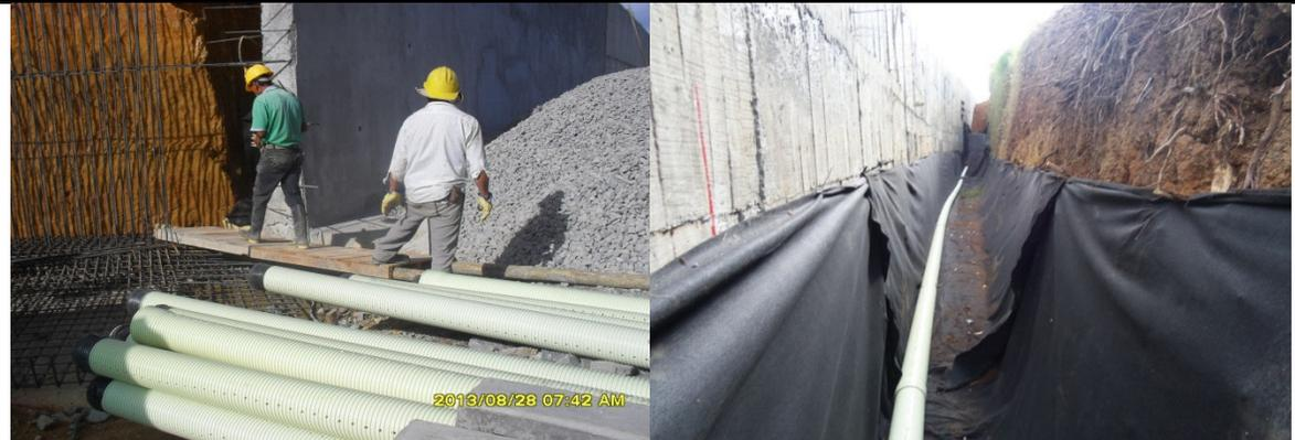
IMÁGENES No. 78. INSTALACIÓN DE GEOTEXTIL Y TUBERÍA PERFORADA DE 8" PARA LA CONSTRUCCIÓN DEL FILTRO DEL MURO
