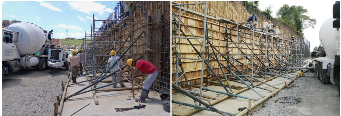
IMÁGENES No.70. ATRAQUE DE FORMALETA CON GATOS HIDRÁULICOS Y CERCHAS Y FUNDICIÓN DE UN TRAMO DEL PRIMER NIVEL, ABSCISAS K0+800-K0+820.
