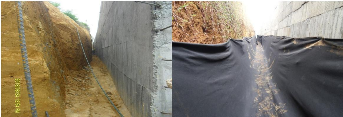
IMÁGENES No. 77. NIVELACIÓN DE LA SUPERFICIE DEL FILTRO E INSTALACIÓN DE GEOTEXTILNT
