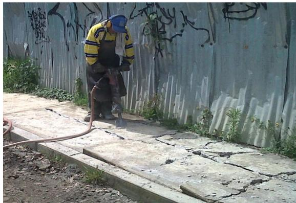
IMAGEN No. 7. DEMOLICIÓN DE ANDÉN
