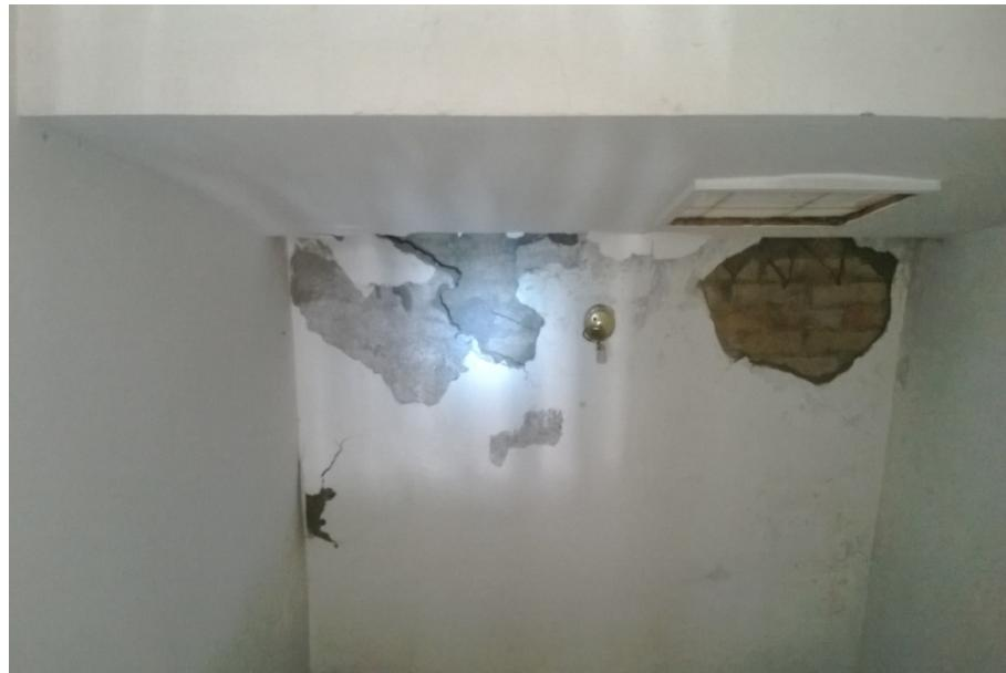
**Figura 20.** Vista de muros en mal estado
