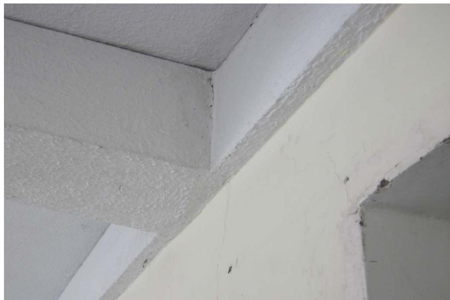
**Figura 8.** Visualización de vigas y algunas fisuras en los muros no estructurales
