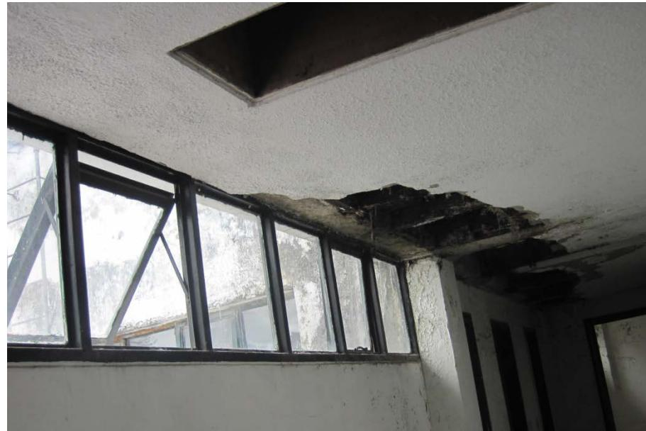
**Figura 10.** Vista del daño total del cielo raso en el tercer piso
