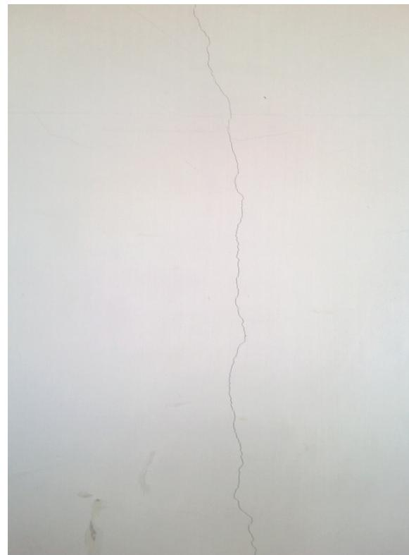
**Figura 14.** Fisuras en muros no estructurales
