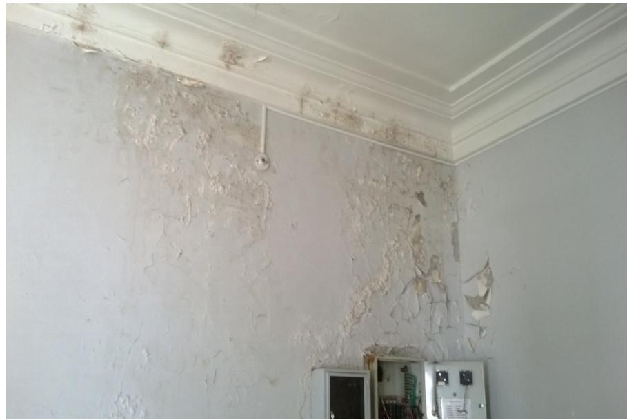
**Figura 21.** Muro deteriorado por Humedad
