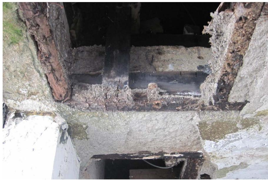
**Figura 9.** Deterioro de estructura de cubierta y cielo raso encontrados en menor área
