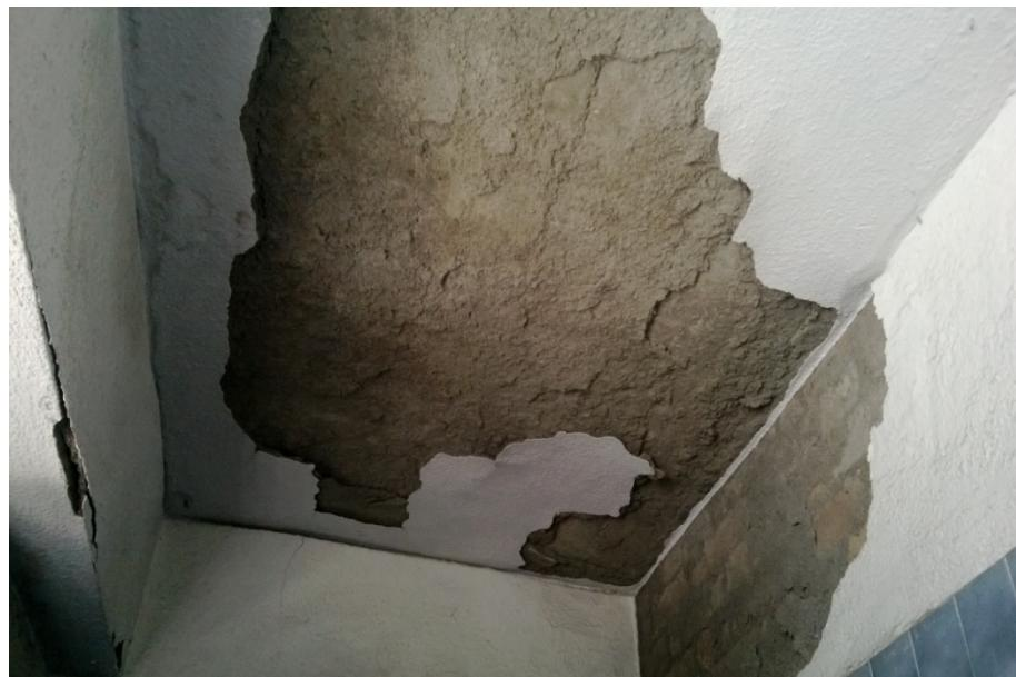
**Figura 24.** Vista de cielo raso en deterioro
