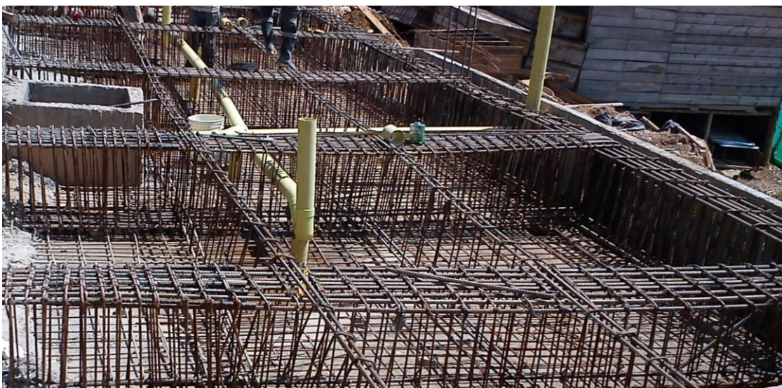
Conjunto residencial torres de cattania. Losa Cimentación torre D. (Registro fotográfico)
