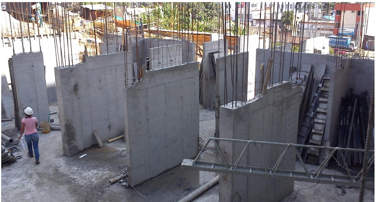
Conjunto residencial torres de cattia. Sótano torre D. (Registro fotográfico)
