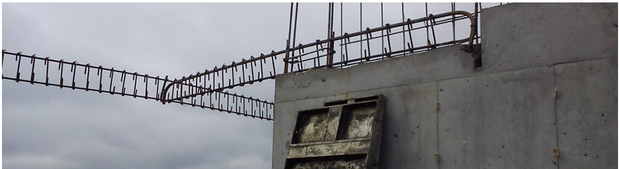
Figura 59 Armado dinteles de semisótano
