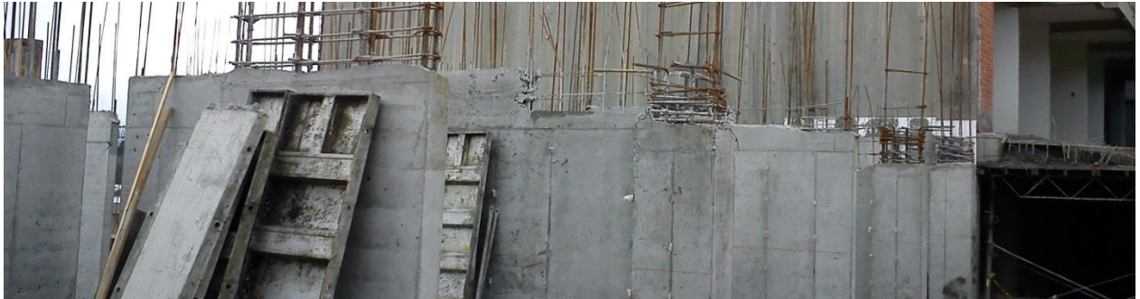
Figura 58 Fundición escaleras de sótano
