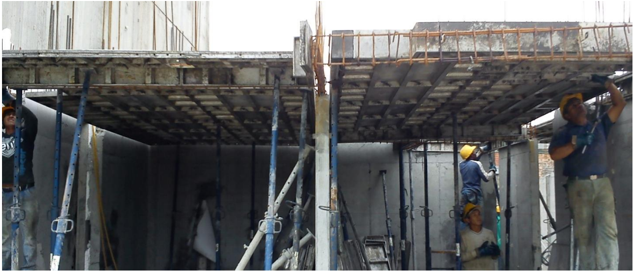
Conjunto residencial torres de cattania. Losa semisótano torre D. (Registro fotográfico)
