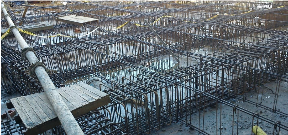
Conjunto residencial torres de cattania. Losa Cimentación torre D. (Registro fotográfico)
