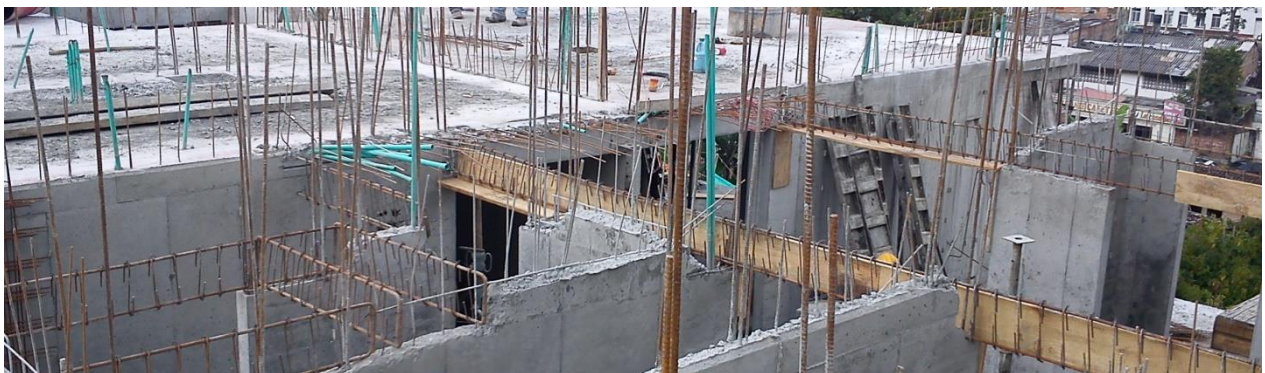
Conjunto residencial torres de cattania. Piso 1 torre D. (Registro fotográfico)
