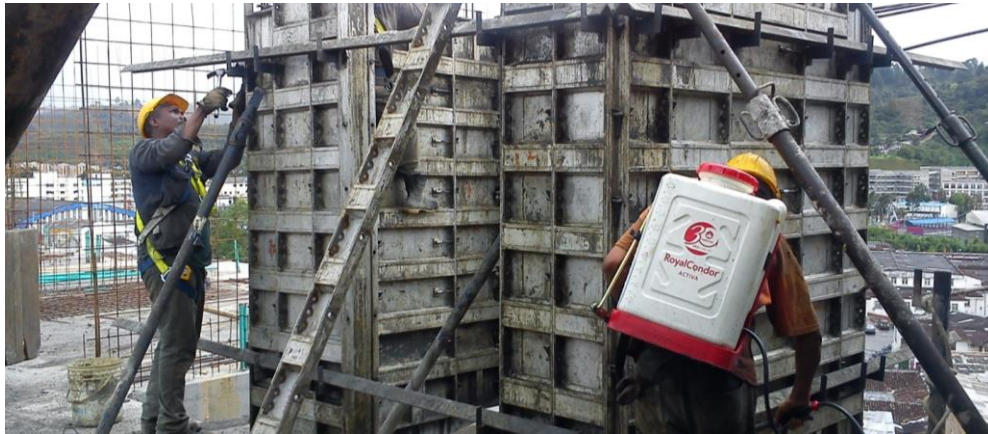
Figura 14 Muros ascensor modulados con FORSA
