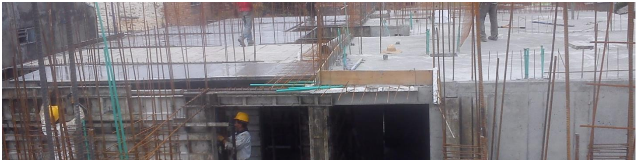
Conjunto residencial torres de cattania. Piso 1 torre D. (Registro fotográfico)
