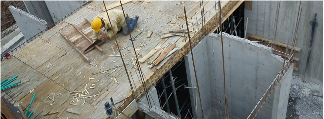
Figura 88 Fundición losa punto fijo piso 1
