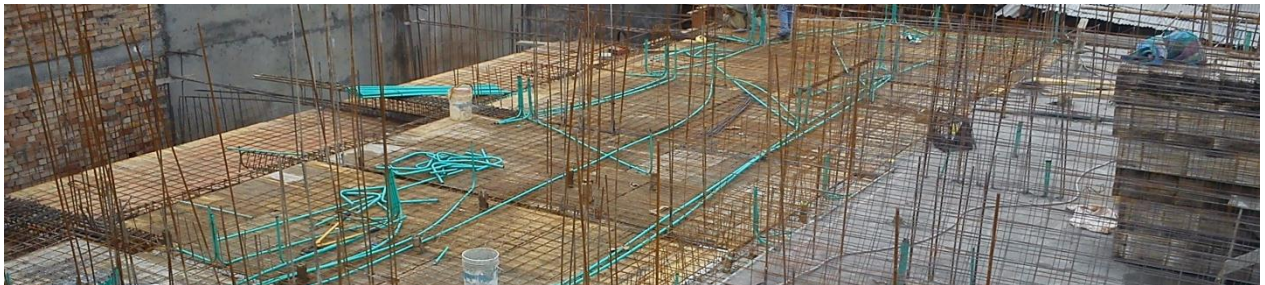
Conjunto residencial torres de cattiaia. Losa semisótano torre D. (Registro fotográfico)
