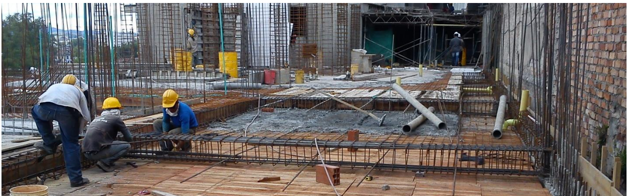
Conjunto residencial torres de cattania. Losa Sótano torre D. (Registro fotográfico)
