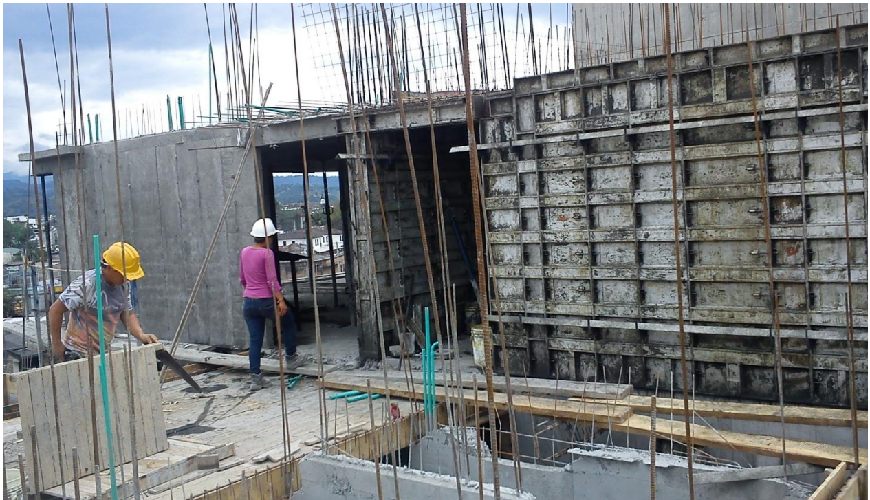
Conjunto residencial torres de cattania. Piso 2 torre D. (Registro fotográfico)
