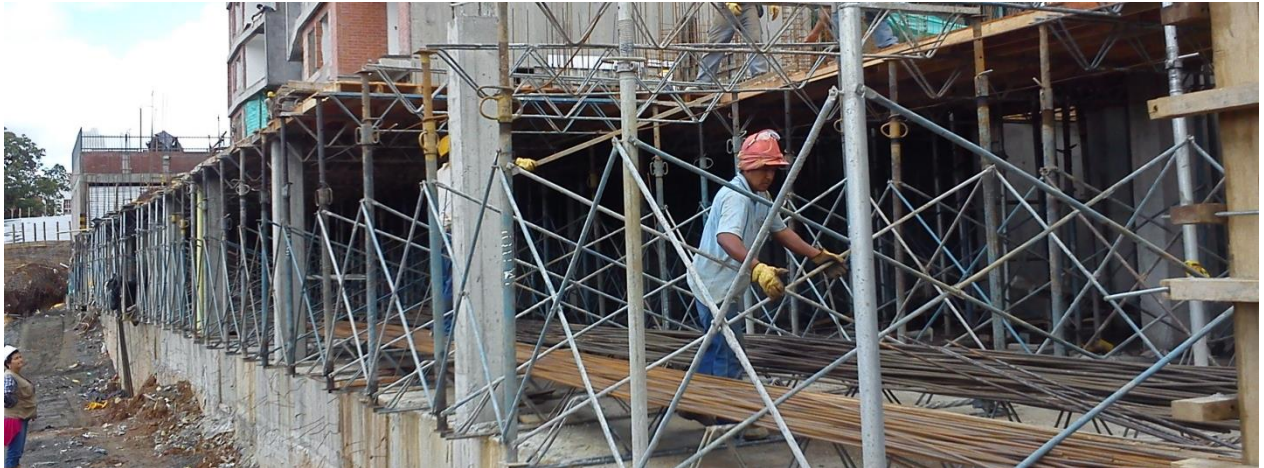
Conjunto residencial torres de cattania. Losa Sótano torre D. (Registro fotográfico)
