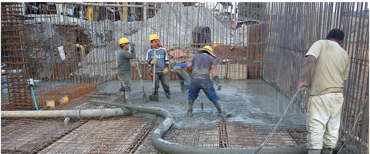
Figura 40 Fundición por tramos
