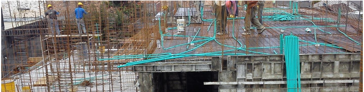
Figura 84 Encofrado losa apartamento 4 piso 1
