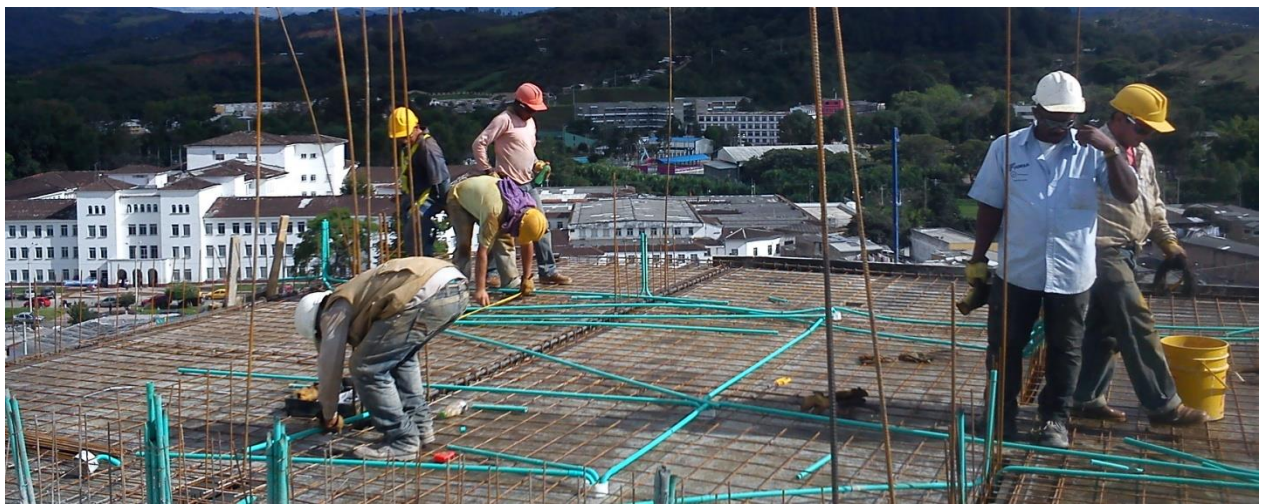
Figura 17 Instalaciones eléctricas apartamentito piso 7
