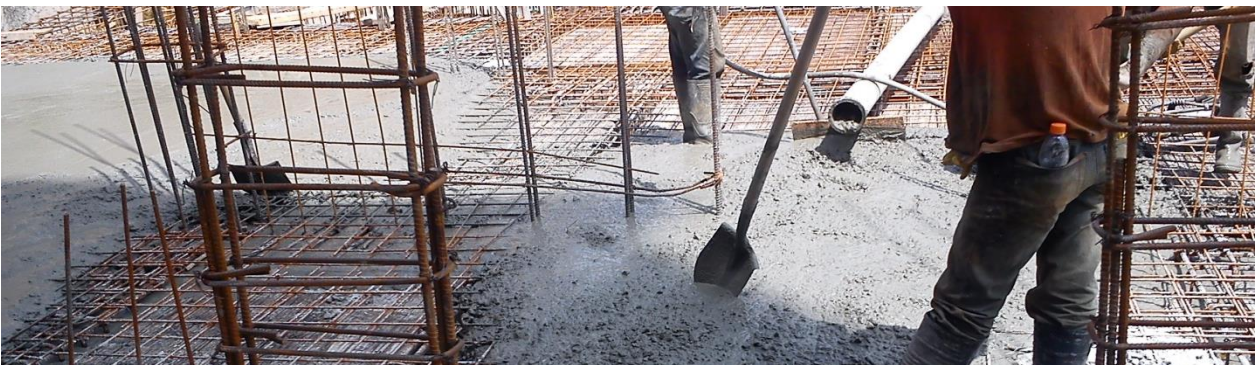
Figura 34 Fundición de losa
