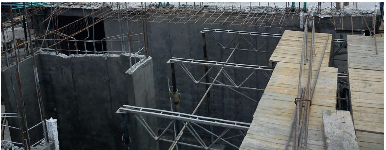
Figura 90 Andamios losa punto fijo piso 3
