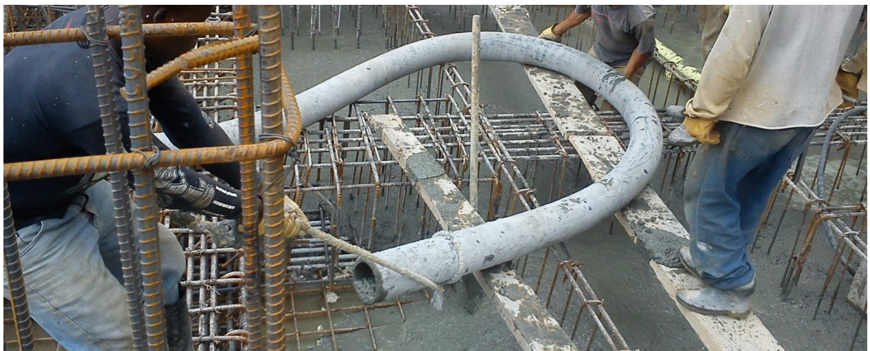
Conjunto residencial torres de cattania. Losa Cimentación torre D. (Registro fotográfico)
