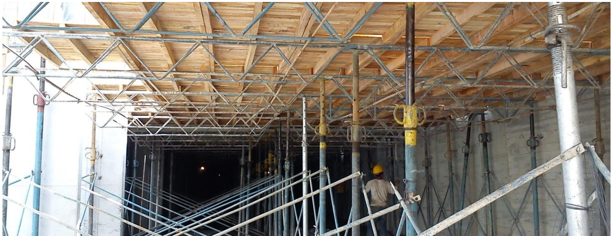
Figura 49 Encofrado losa de sótano en madera
