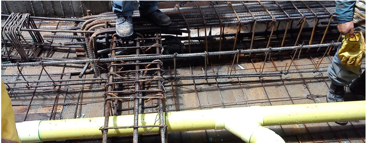
Conjunto residencial torres de cattania. Losa Sótano torre C. (Registro fotográfico)
