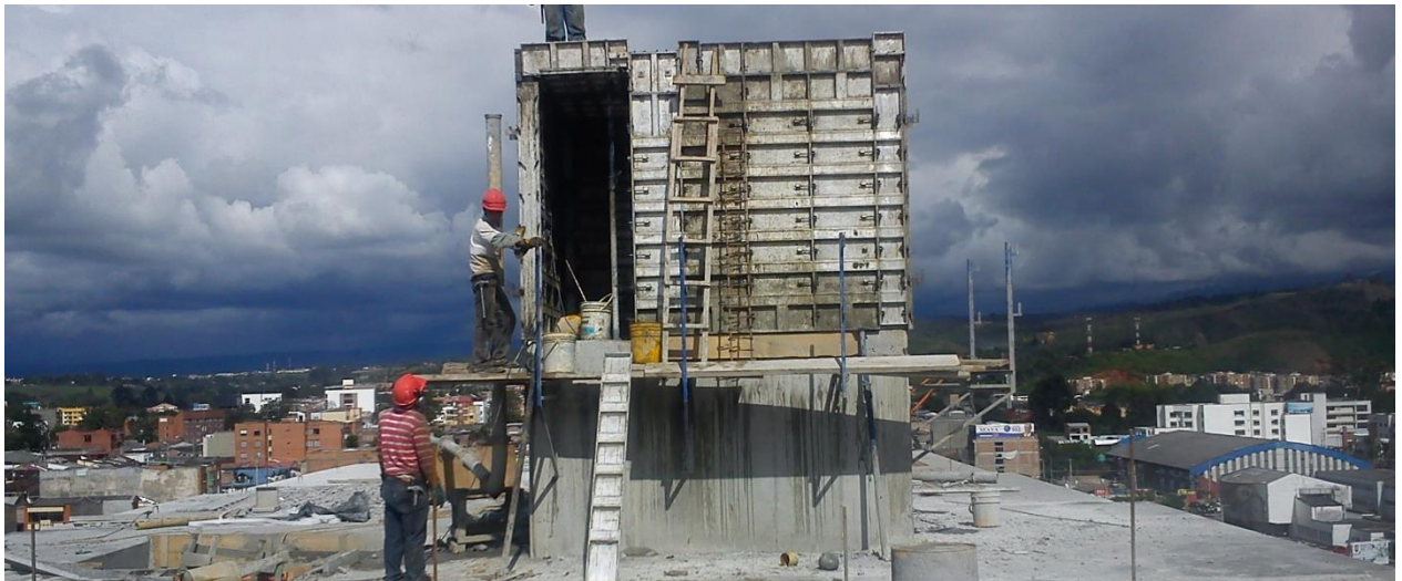
Conjunto residencial torres de cattania. Torre C. piso 8 (Registro fotográfico)
