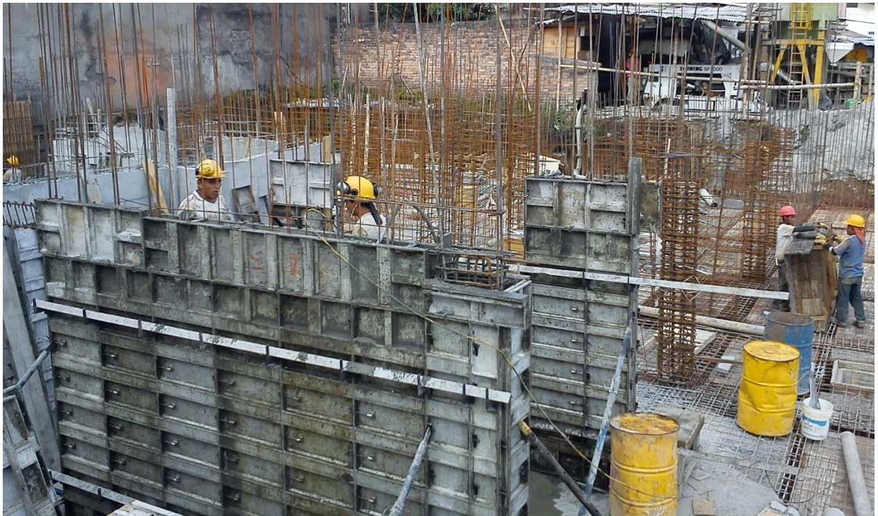
Figura 45 Encofrado de muros de sótano
