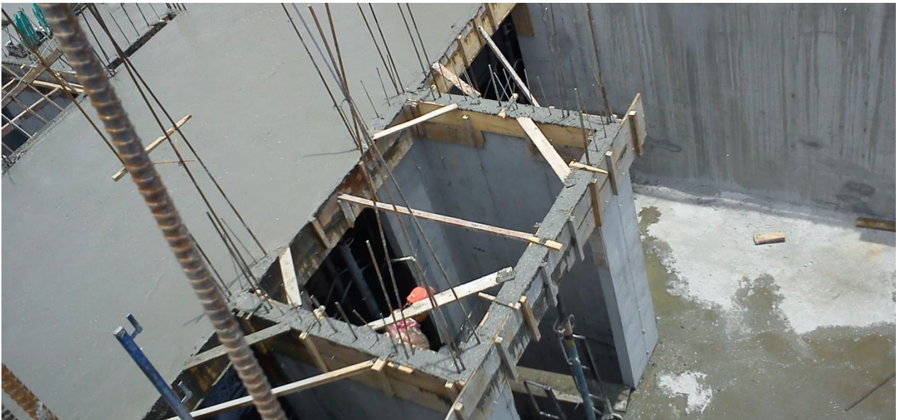
Conjunto residencial torres de cattania. Piso 2 torre D. ( Registro fotográfico )
