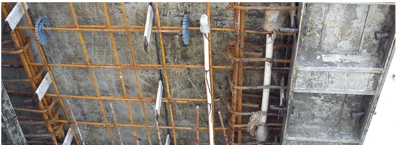
Figura 69 Encofrado y corbatas apartamento 1 piso 1
