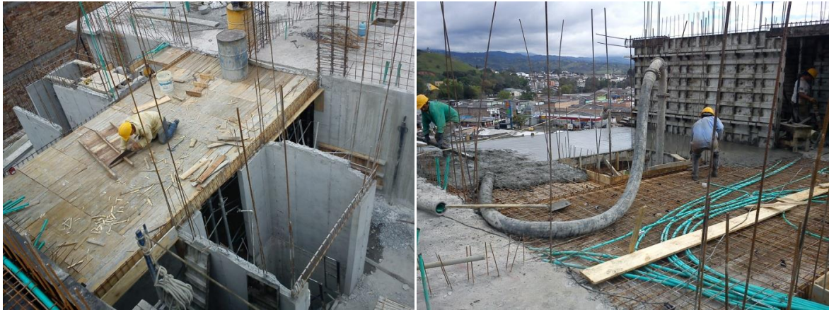
Conjunto residencial torres de cattania. Torre C. piso 7. (Registro fotográfico)
