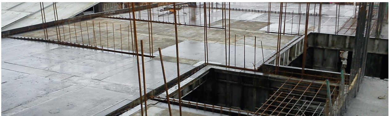
Figura 79 Encofrado losa apartamento 2 piso 1
