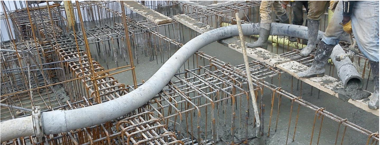
Conjunto residencial torres de cattania. Losa Cimentación torre D. (Registro fotográfico)
