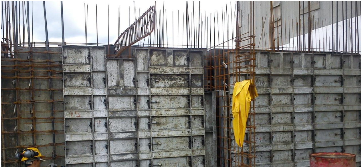
Figura 72 Encofrado apartamento 1 piso 1
