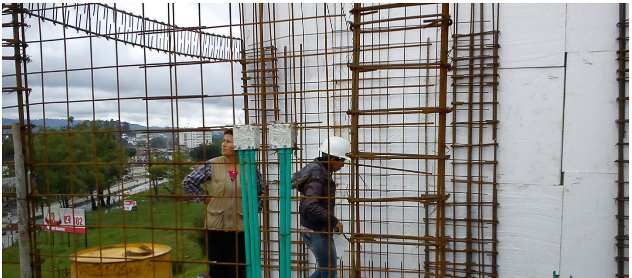
Conjunto residencial torres de cattania. Piso 1 torre D. (Registro fotográfico)
