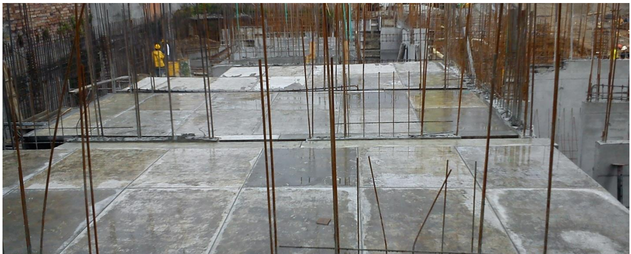
Figura 50 Encofrado losa de sótano en FORSA
