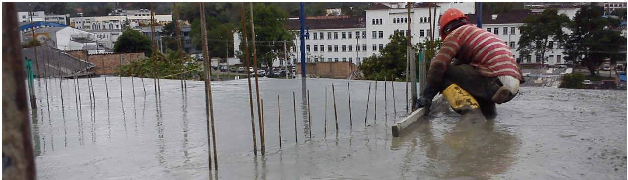
Conjunto residencial torres de cattania. Piso 1 torre D. (Registro fotográfico)
