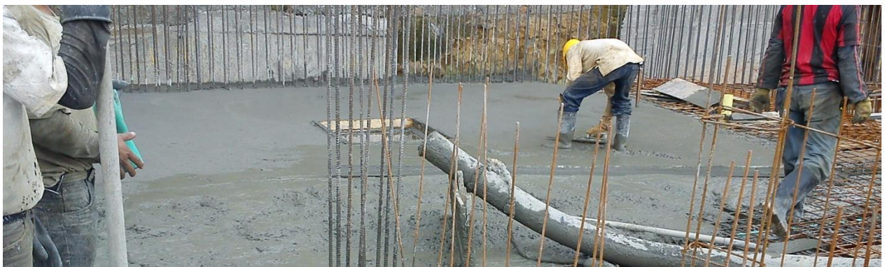
Conjunto residencial torres de cattanía. Losa Cimentación torre D. (Registro fotográfico)
