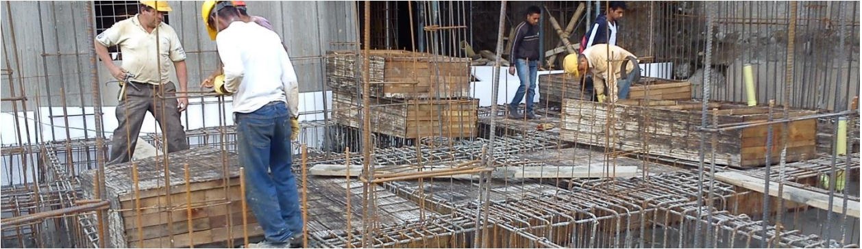
Figura 32 Instalación casetones
