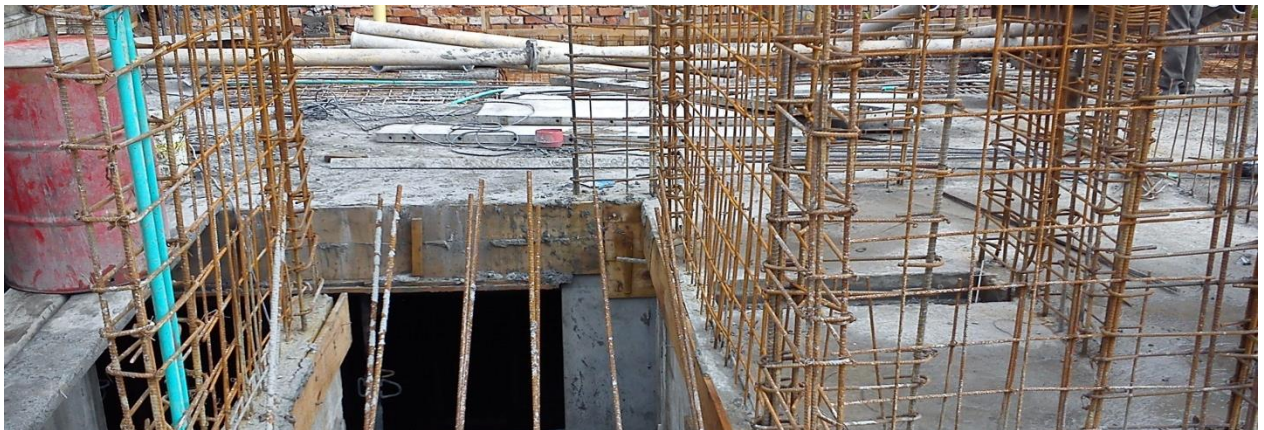
Figura 56 Armado muros punto fijo semisótano
