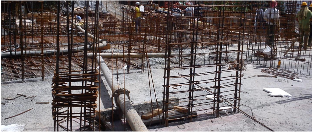
Conjunto residencial torres de cattania. Losa Cimentación torre D. (Registro fotográfico)
