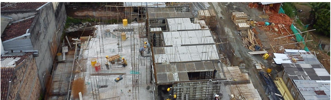
Figura 82 Encofrado losa apartamento 3 piso 1
