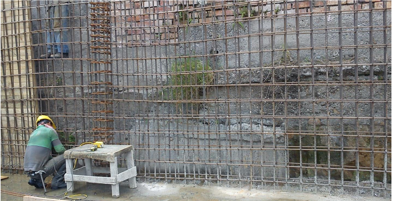
Figura 48 Formaletas de muro de contención
