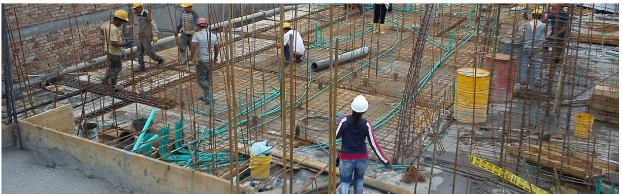
Conjunto residencial torres de cattiaia. Losa semisótano torre D. (Registro fotográfico)
