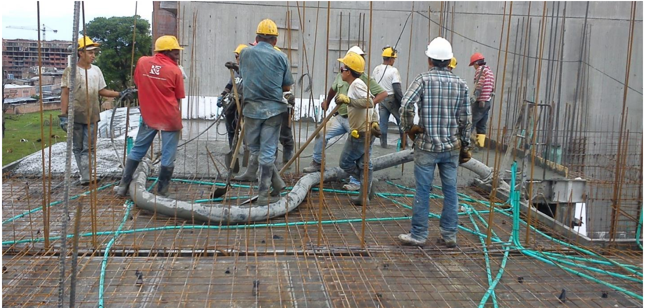
Conjunto residencial torres de cattania. Piso 1 torre D. (Registro fotográfico)
