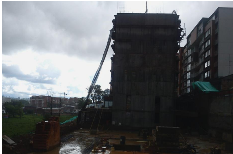
Conjunto residencial torres de cattania. ( Registro fotográfico )
