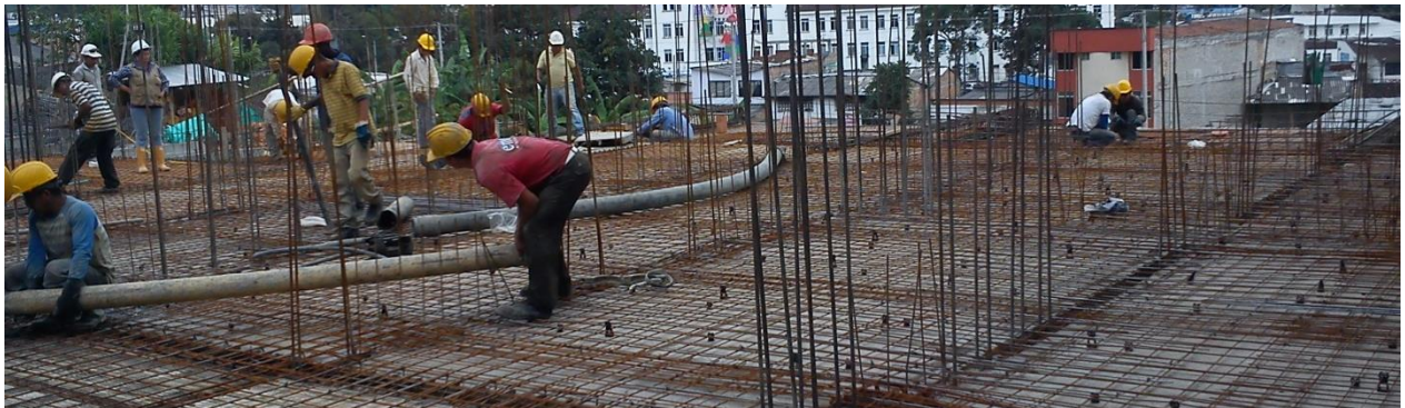
Conjunto residencial torres de cattania. Losa Sótano torre D. (Registro fotográfico)
