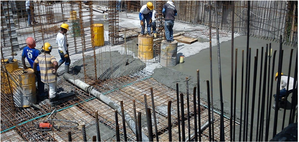
Conjunto residencial torres de cattanía. Losa Cimentación torre D. (Registro fotográfico)
