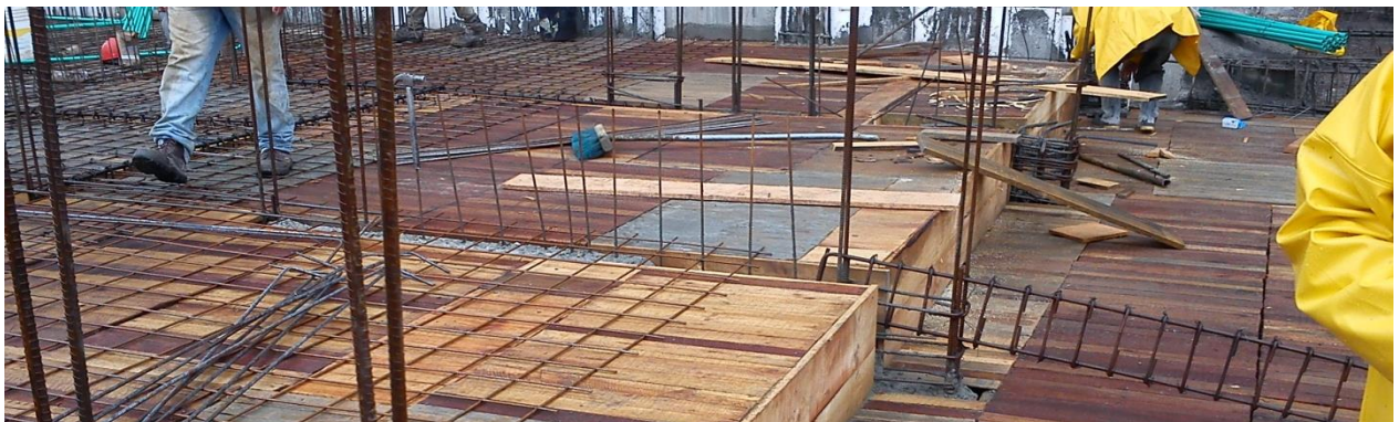
Conjunto residencial torres de cattania. Losa Sótano torre D. (Registro fotográfico)
