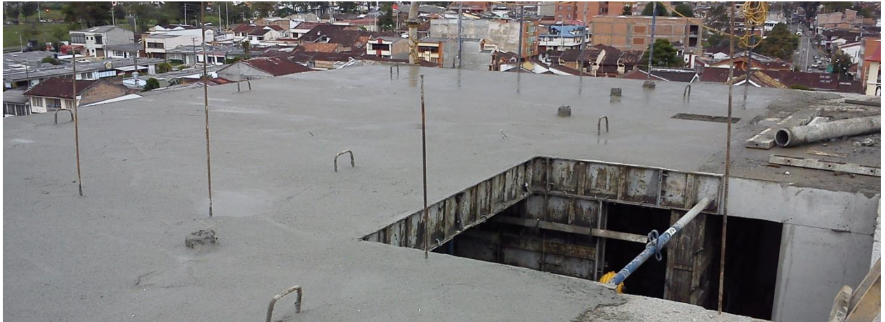
Figura 19 Cuarto de máquinas del ascensor
