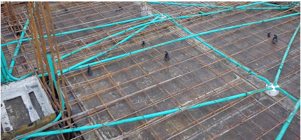
Conjunto residencial torres de cattania. Losa semisótano torre D. (Registro fotográfico)
