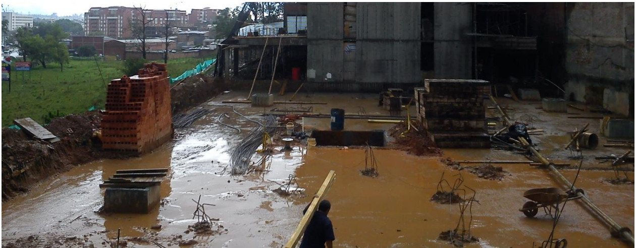
Conjunto residencial torres de cattania. Cimentación torre D. (Registro fotográfico)
