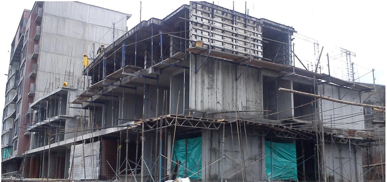
Conjunto residencial torres de cattania. Torre D. (Registro fotográfico)
