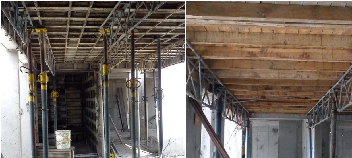
Figura 15 Losa punto en FORSA y en madera
