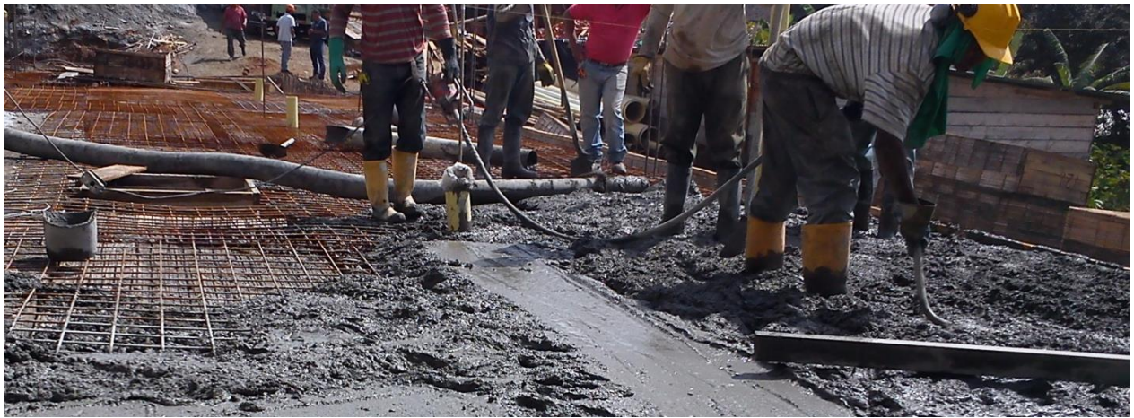
Figura 36 Tallado final de la losa
