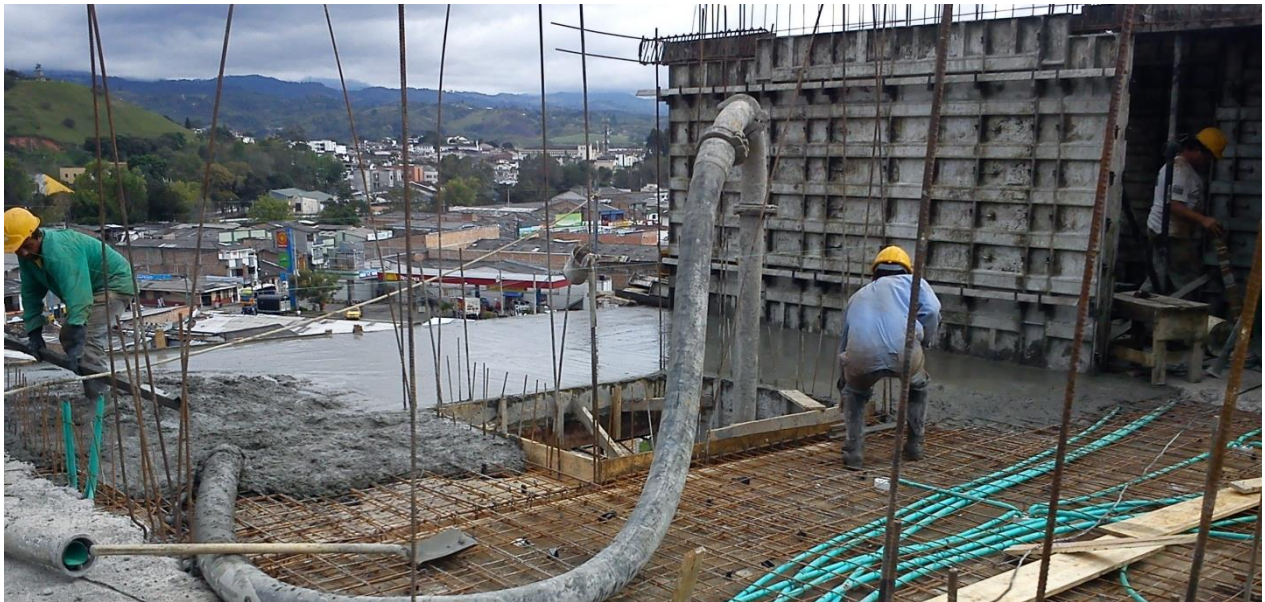
Figura 92 Tercer nivel torre D terminado
