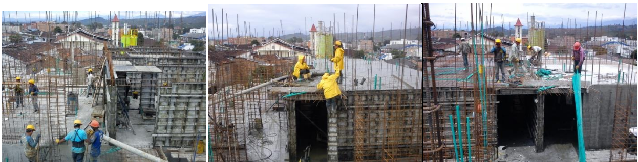
Conjunto residencial torres de cattania. Torre D. (Registro fotográfico)
