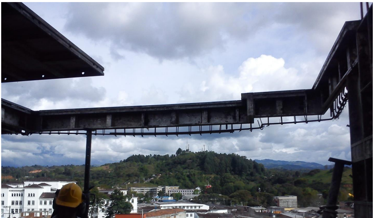
Figura 73 Encofrado dinteles apartamento 1 piso 1
