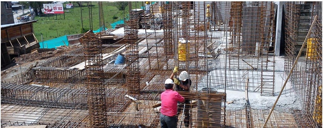
Figura 44 Avance de muros de sótano
