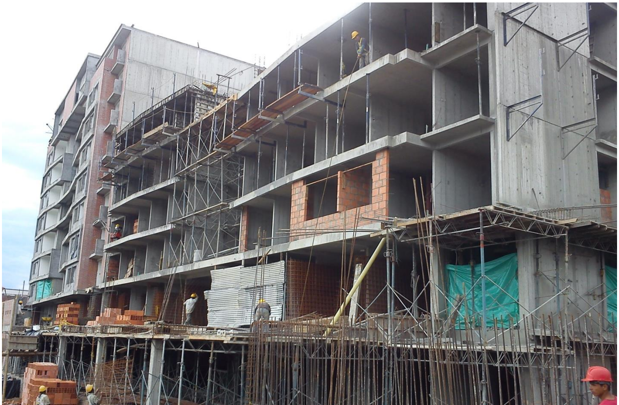
Conjunto residencial torres de cattania. Torre D. (Registro fotográfico)
