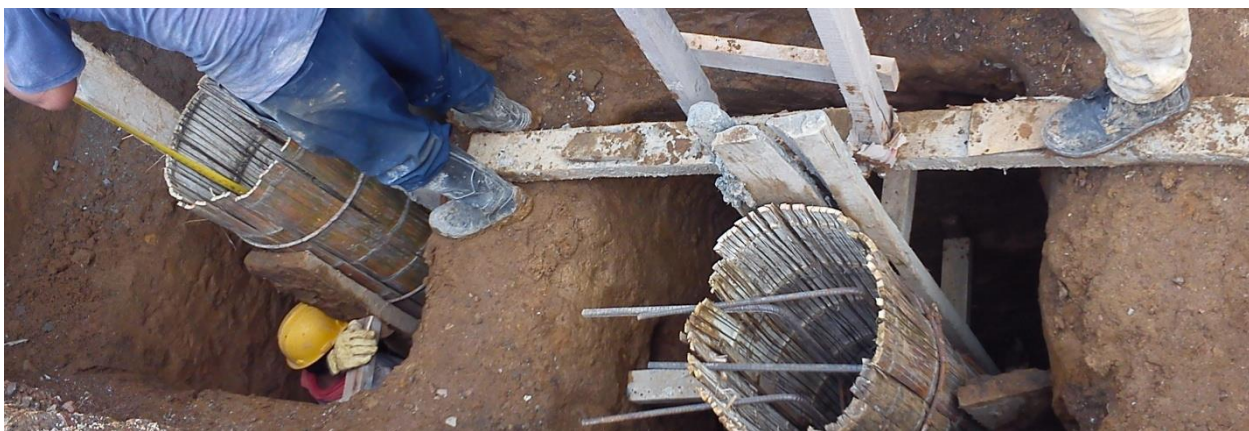
Figura 22 Cimientos muro de contención de la piscina
