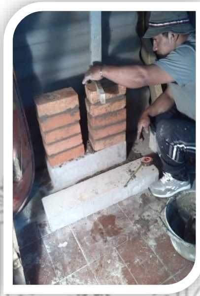
Foto 13 Verificación de horizontalidad y verticalidad de los prismas
