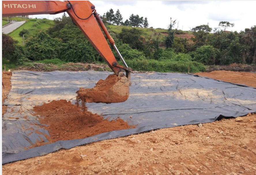
Figura 8. Geotextil como material de fundación para el relleno
