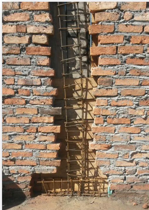
Figura 47. Corrección de columna corrida
