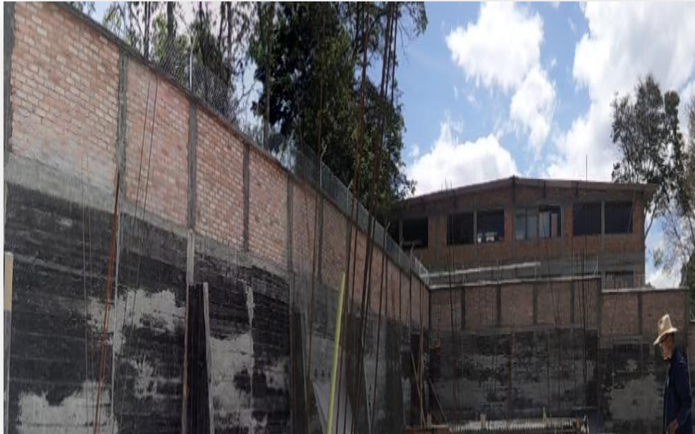
Figura 25. Construcción de muros de cerramiento en mampostería confinada
