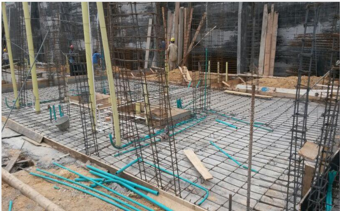
Figura 40. Refuerzo de cimentación y columnas
