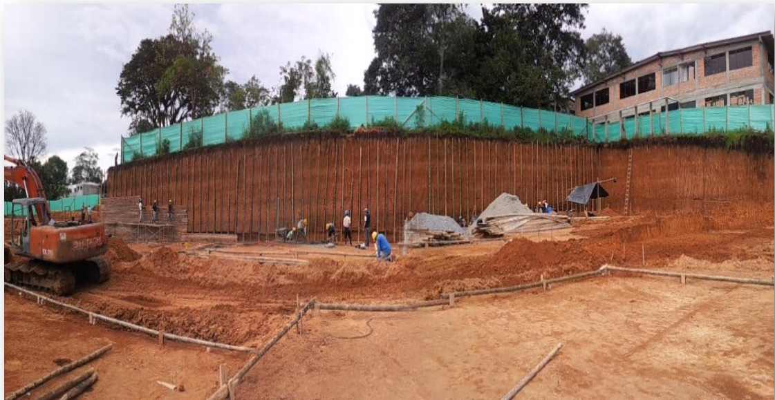
Figura 19. Entibado del talud para muros de contención
