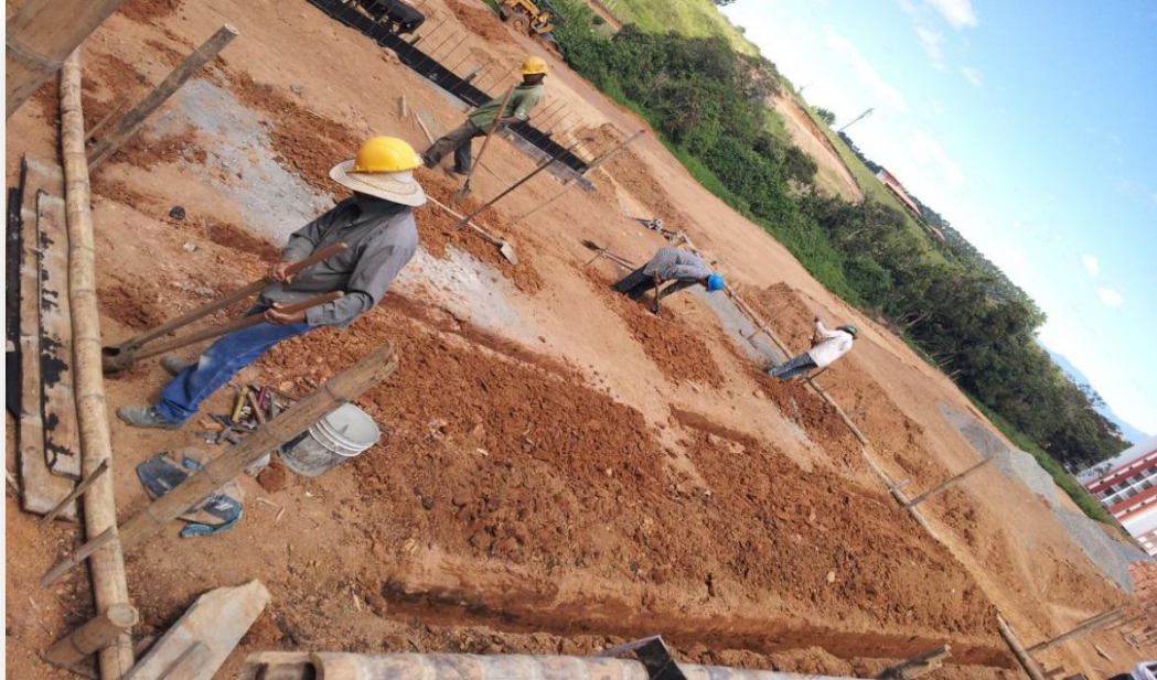
Figura 28. Excavaciones e instalación de tubería
