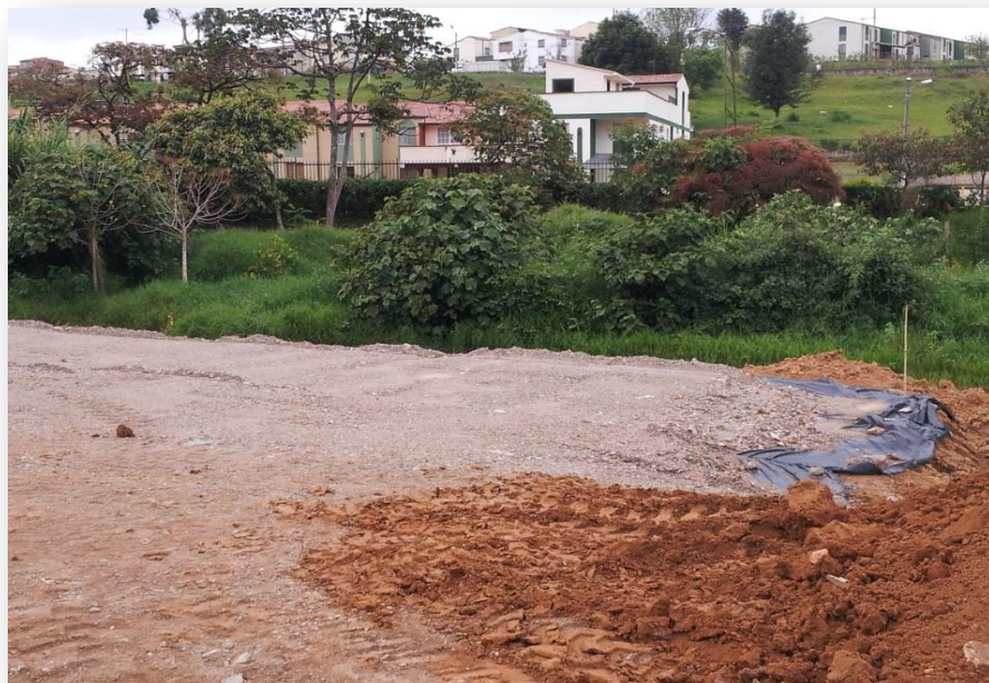
Figura 9. Roca muerta como material de relleno
