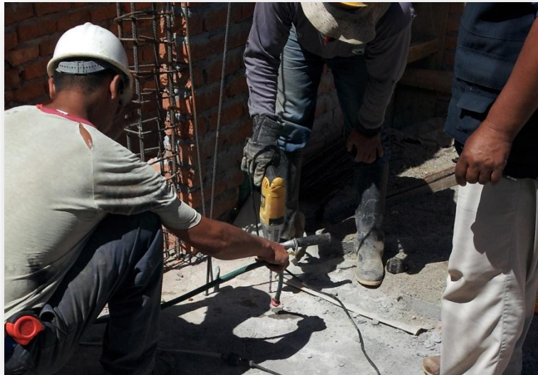
Figura 46. Anclajes de columnas
