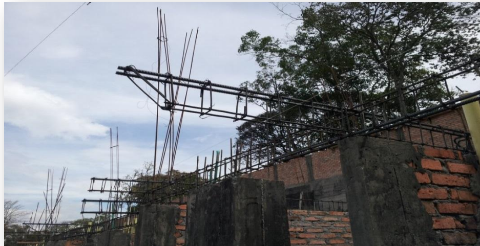
Figura 51. Vigas en voladizo
