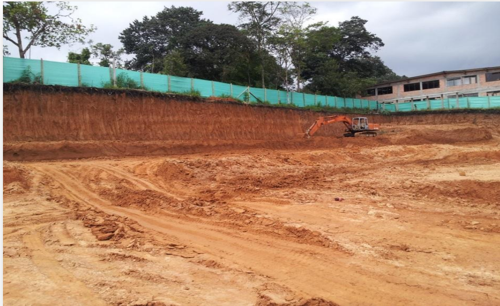
Figura 7. Talud en zona limítrofe con edificaciones vecinas
