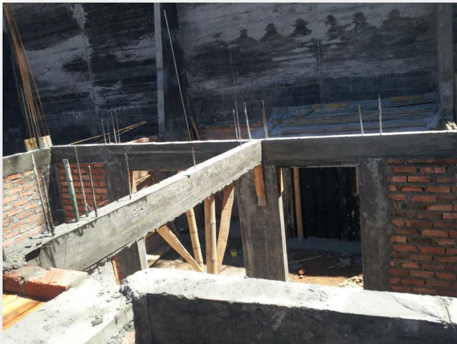
Figura 50. Vigas de amarre de primer piso
