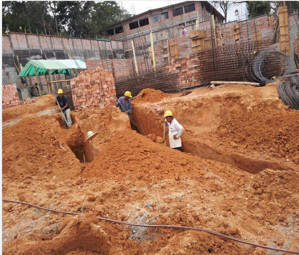
Figura 35. Excavación para acometidas domiciliarias
