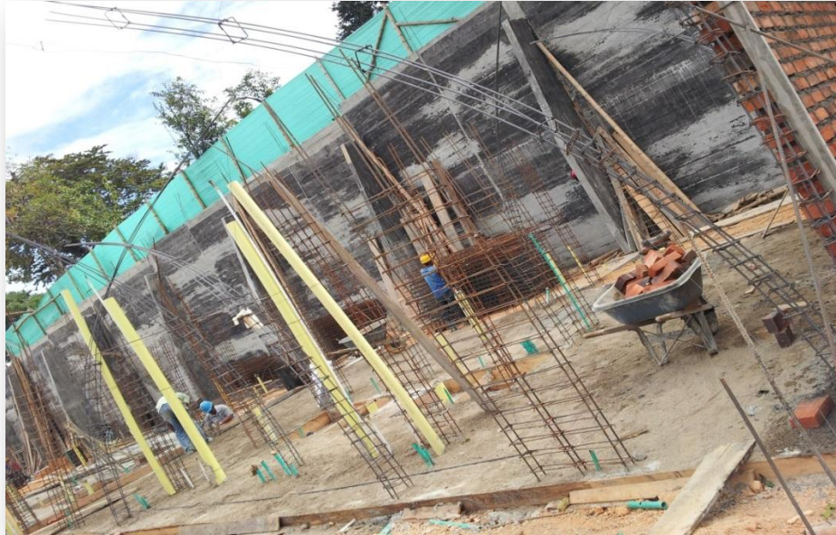
Figura 41. Losa de cimentación terminada
