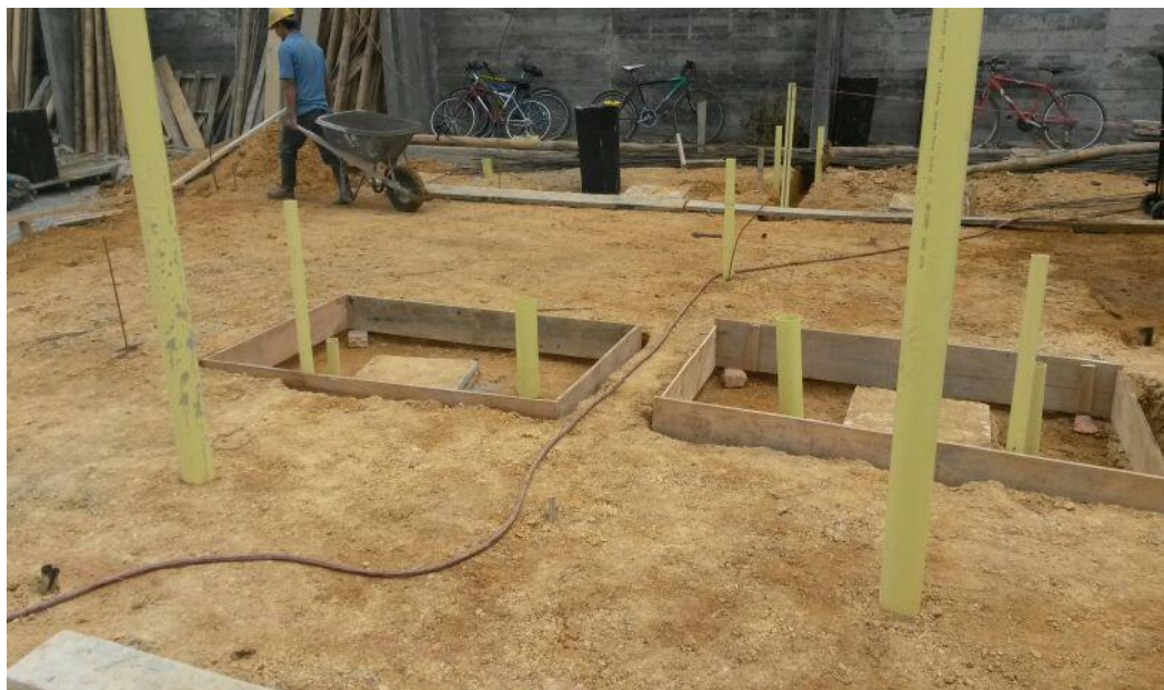
Figura 29. Tubería instalada y cajas de inspección
