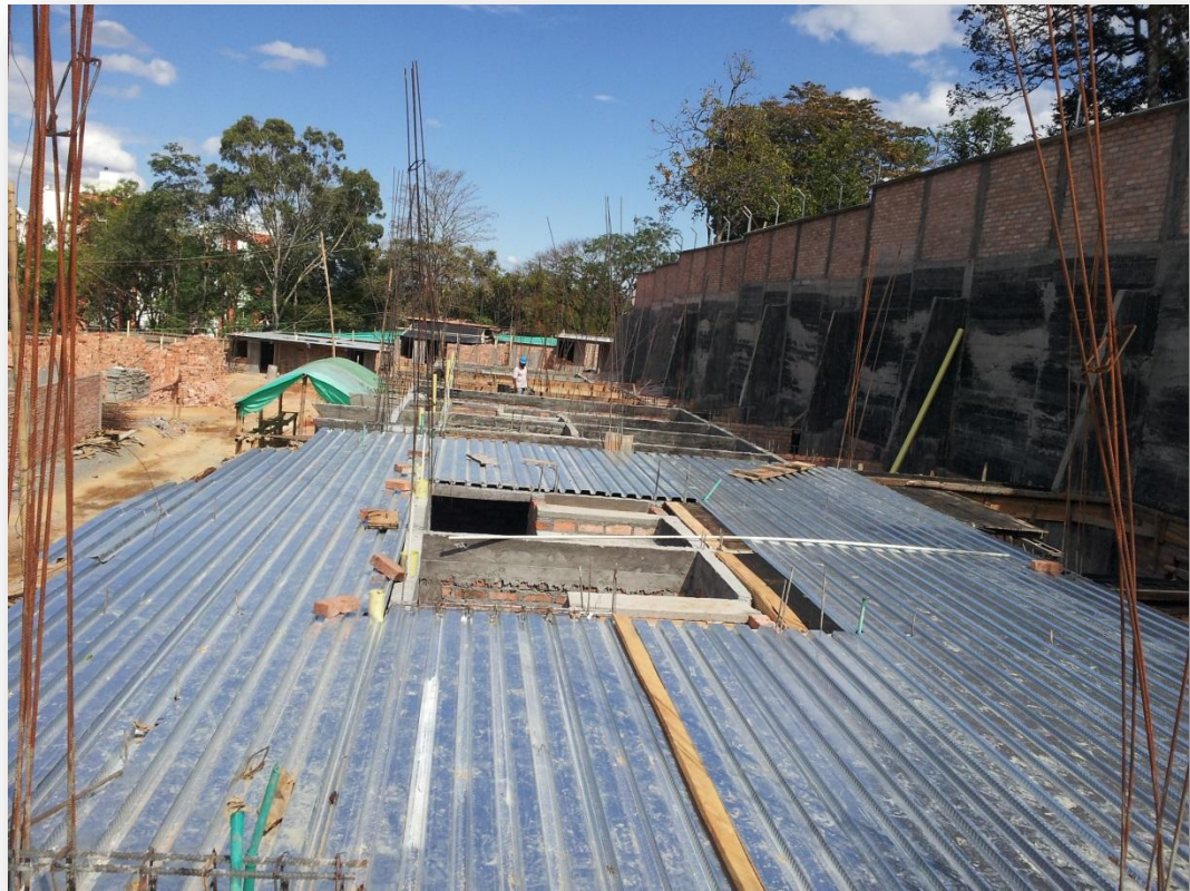
Figura 53. Corpalosa instalada
