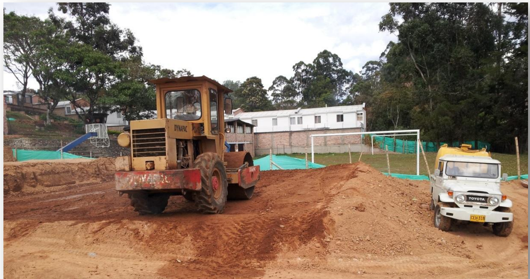
Figura 13. Humedecimiento de terrazas y re compactación
