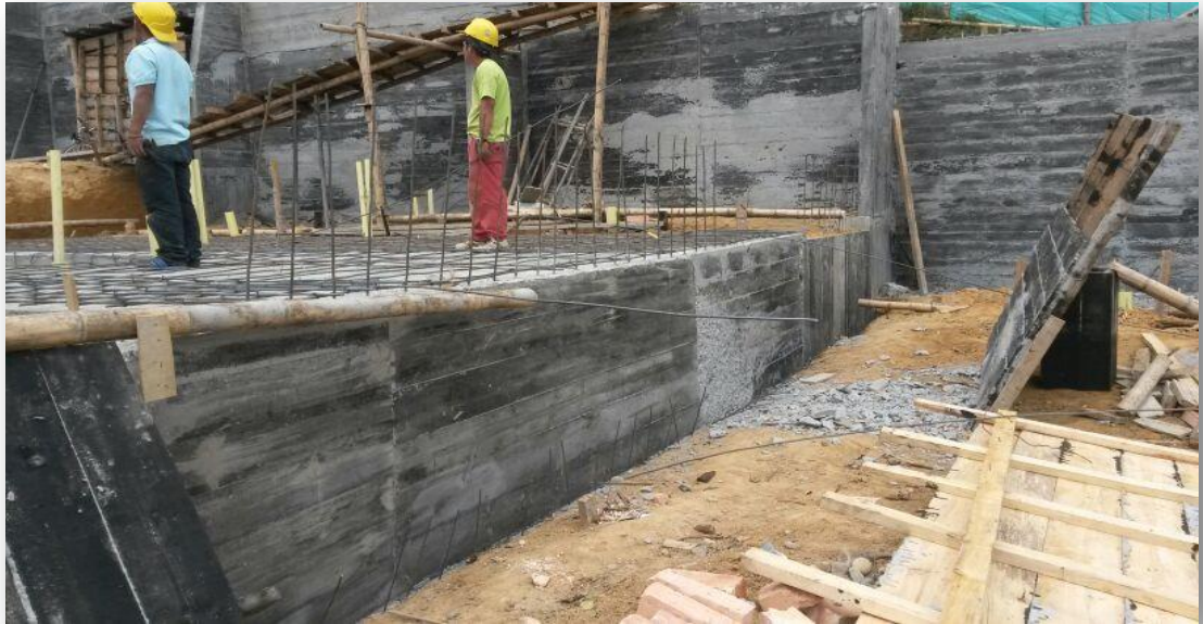
Figura 26. Muro de contención entre terrazas terminado
