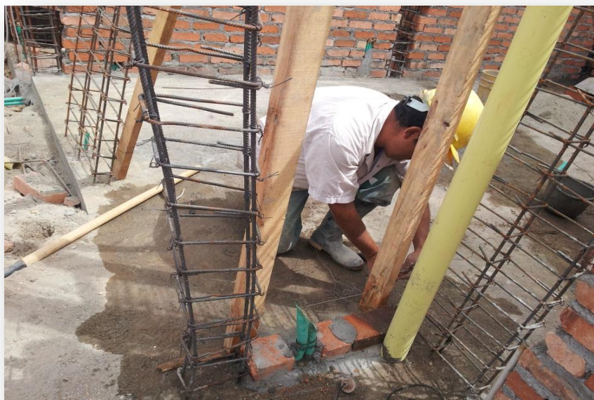
Figura 43. Nivelación y alineamiento
