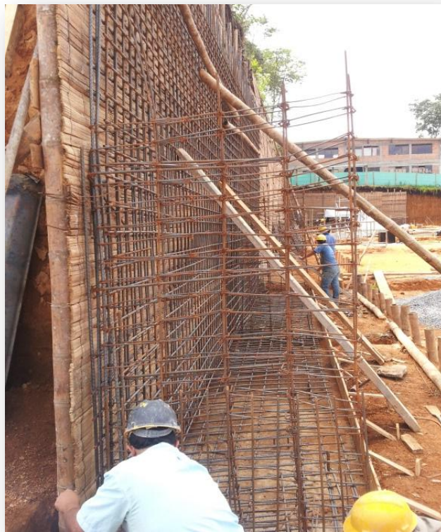
Figura 21. Refuerzo muro de contención
