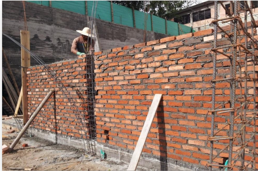
Figura 42. Muros de primer piso
