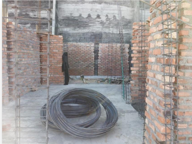
Figura 45. Columnas y pantallas de primer piso
