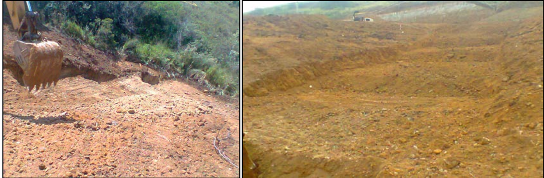
Gráfica 48 y 49. Terrazas para ejecución de los llenos
