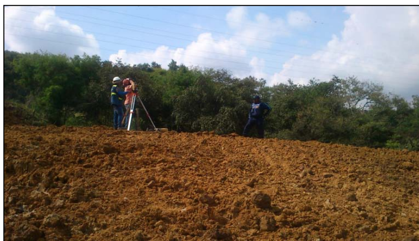
Gráfica 31. Levantamiento Topográfico con estación total
