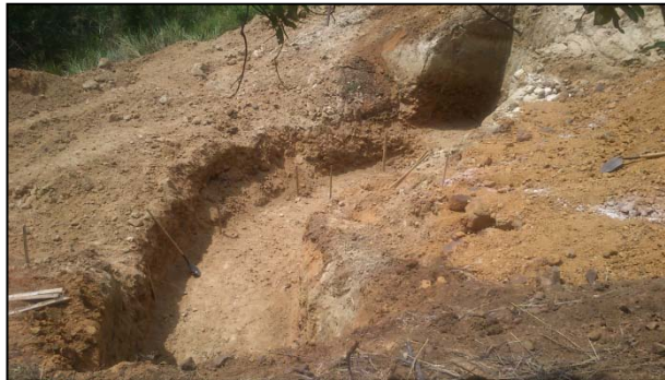
Gráfica 80. Excavación del muro
