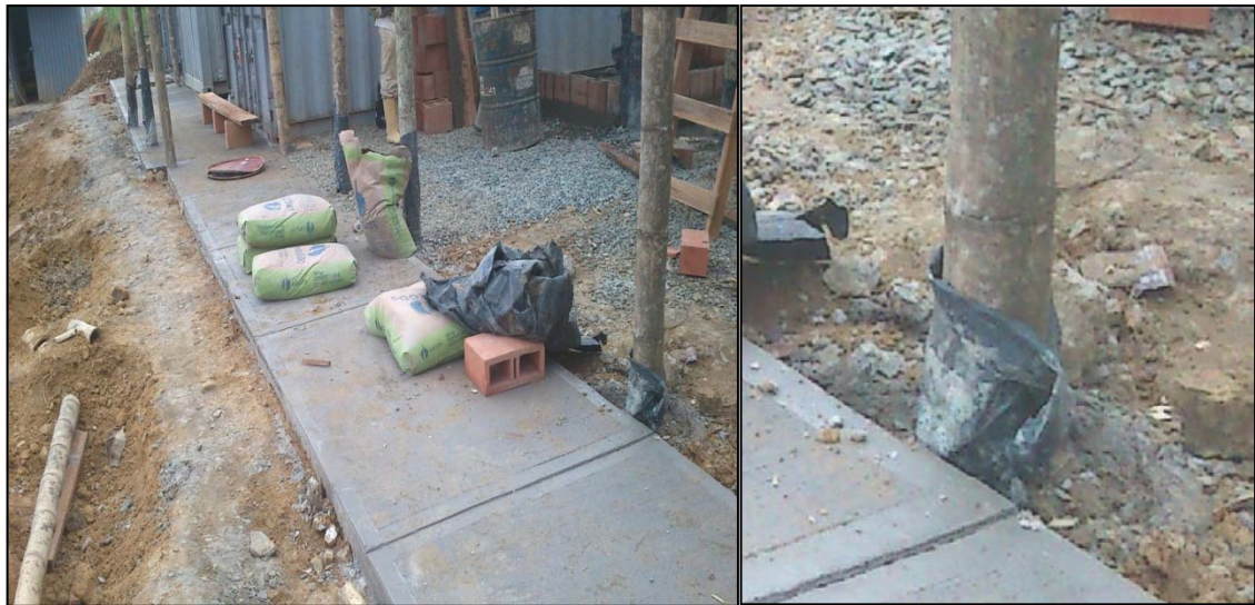
Gráfica 64 y 65. Guaduas de la estructura embebidas y ancladas con concreto
