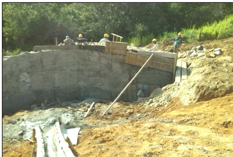
Gráfica 83. Desencofrado de muro de contención
