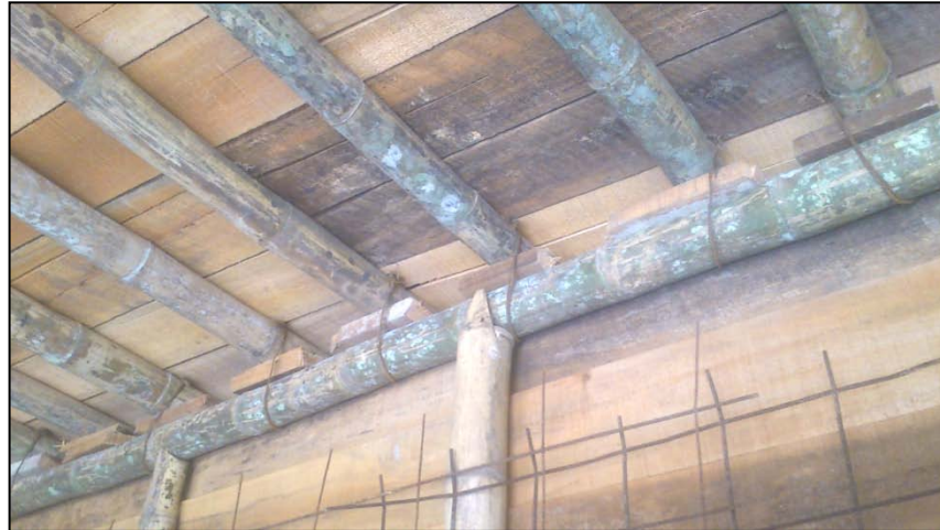
Gráfica 70. Cubrimiento de malla Electrosoldada y amarre lateral interno
