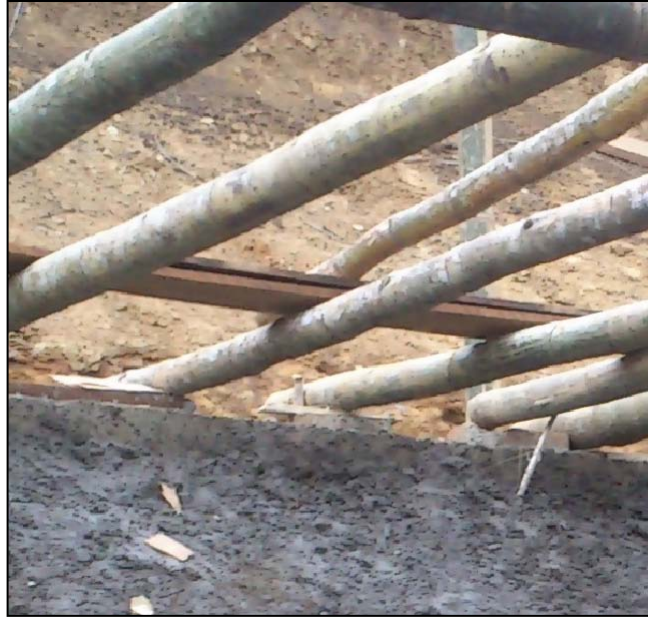
Gráfica 66. Bordillo y champeo de talud en la parte posterior del campamento
