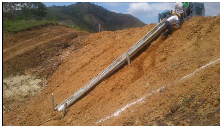
Gráfica 78. Canal para transporte del concreto
