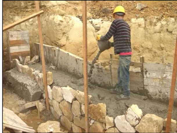
Gráfica 82. Vaciado de concreto
