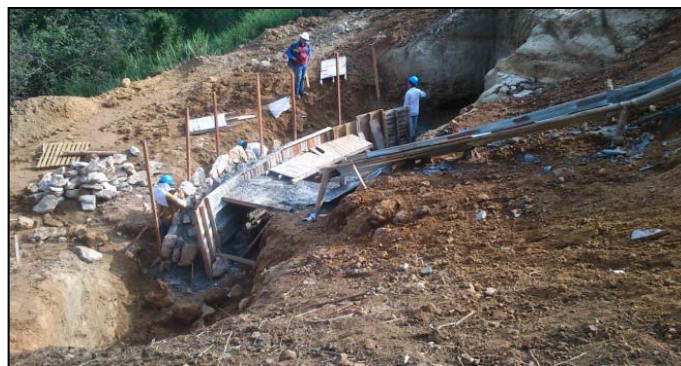
Gráfica 81. Formaleta lateral para muro de contención y construcción del brazo
