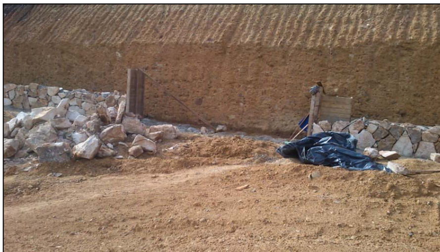
Gráfica 87. Intercalado de la construcción del muro 2 cada 5 m
