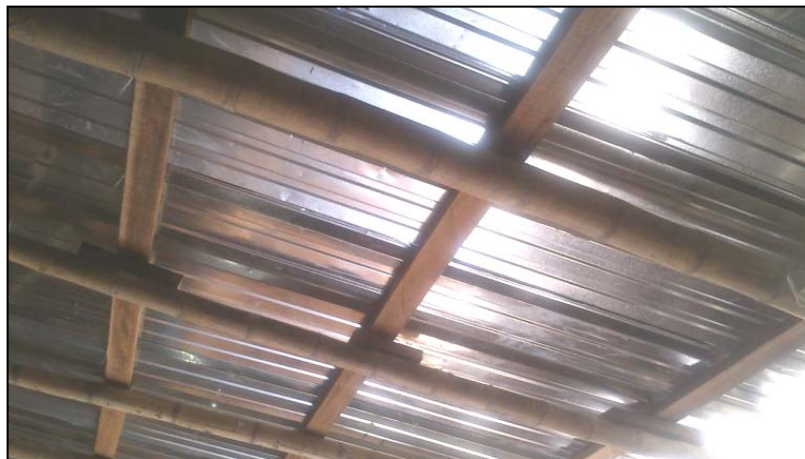
Gráfica 71. Cubierta con teja de zinc
