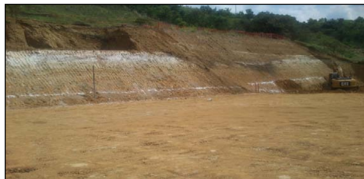
Gráfica 85. Marcado del muro con cal en el pie del talud
