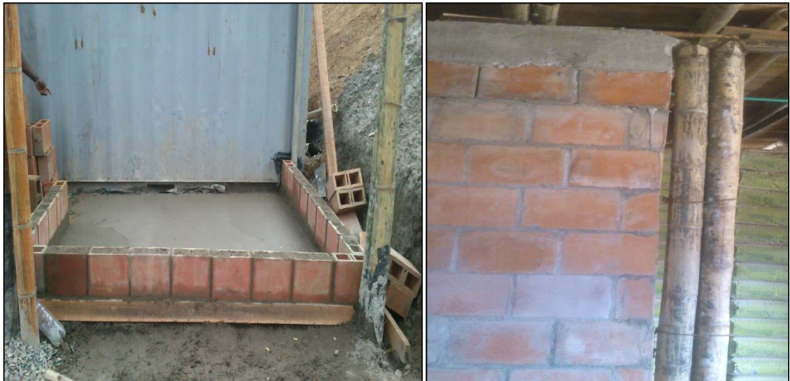
Gráfica 67. Construcción del bunker para almacenamiento seguro.
