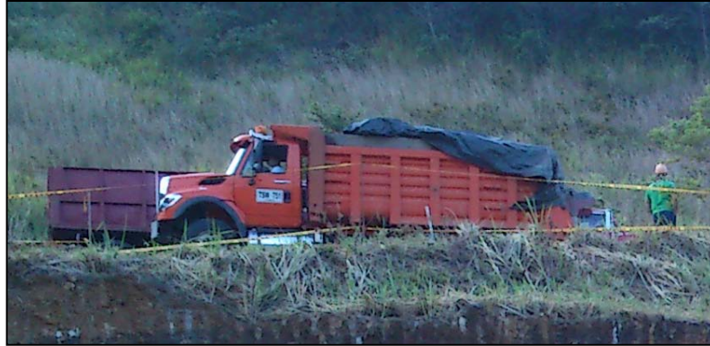
Gráfica 43. Cubrimiento de Volquetas antes de la salida de la Obra
