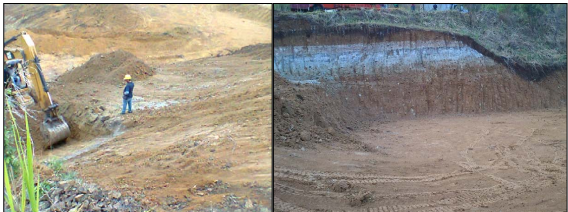
Gráfica 35 y 36. Talud perfilado.
