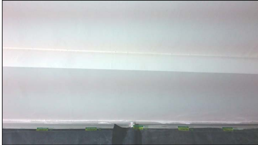
Gráfica 107. Vista con reflector del cielo raso descolgado en panel Yeso.
