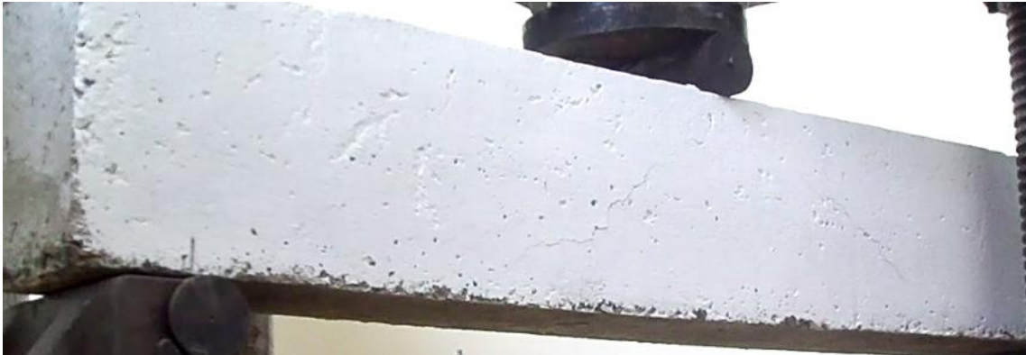
Fig.69. Aparición de las fisuras de cortante en el alma tímidamente (Viga 1)
