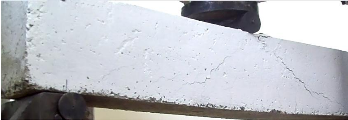
Fig.71. Fisuras ensanchadas con dirección al punto de aplicación de la carga
