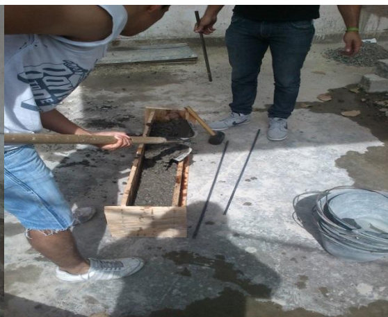
Fig.4. Llenado de las formaletas cumpliendo Con la especificación NTC
