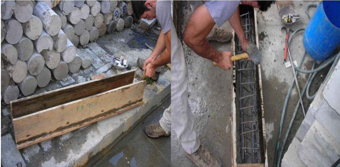
Fig.37. Engrasado de las formaletas Fig.38. Vaciado de concreto y chequeo de “d”
