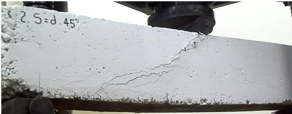
Fig.73. Viga 2 Con estribos a 45° Fallada
