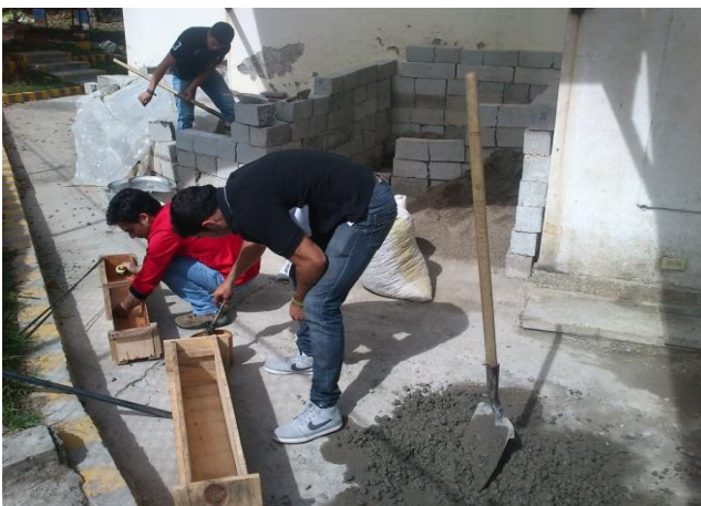
Fig.3. Engrasado de los Moldes
