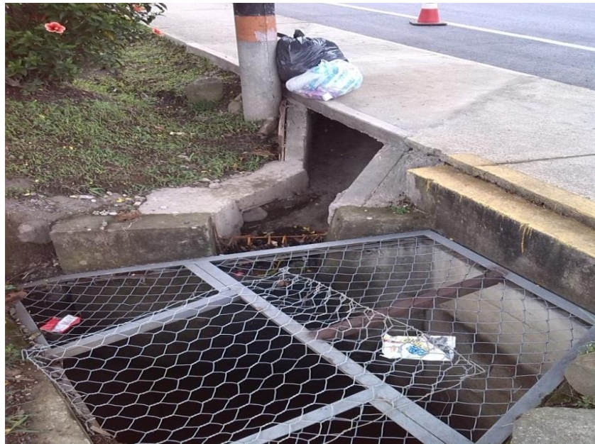
Figura 4. Mejoramiento de la seguridad de los colectores
