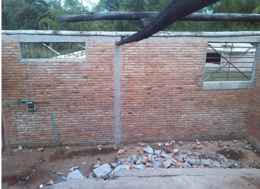
Figura 28. Demolición de la losa de la antigua trilladora de café
