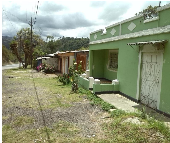
Figura 12. Fachada principal de las viviendas
