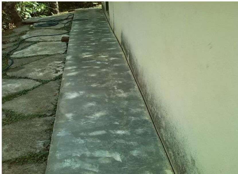
Figura 9. Anden trasero de esta vivienda
