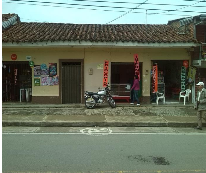
Figura 19. Fachada principal de la vivienda afectada
