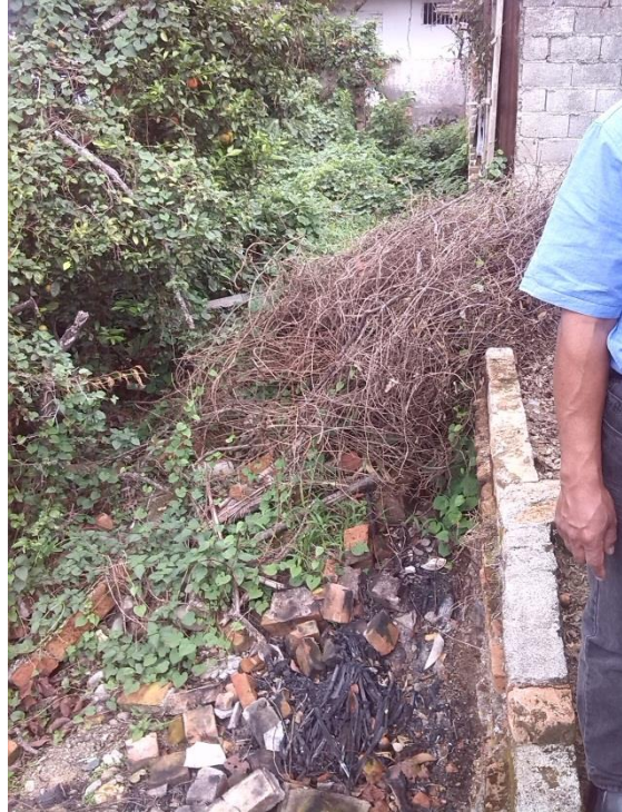
Figura 13. Parte trasera de las viviendas Afectadas
