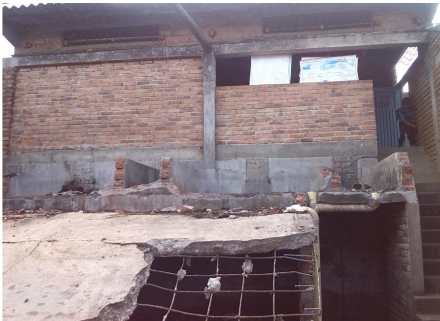
Figura 29. Demolición de la losa de la antigua trilladora de café
