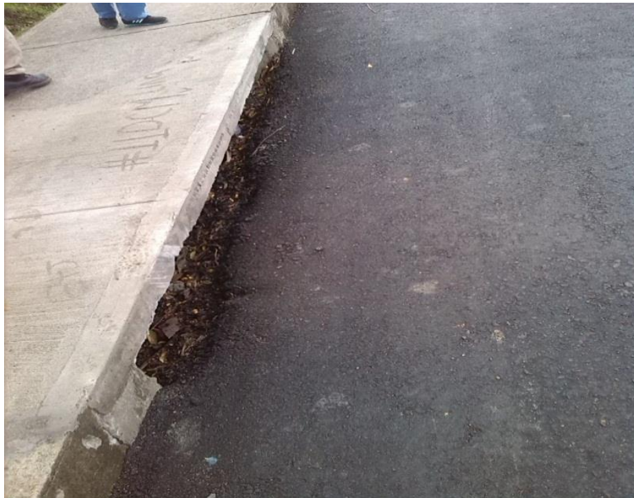
Figura 3. Mejoramiento para la entrada del agua lluvia al recolector
