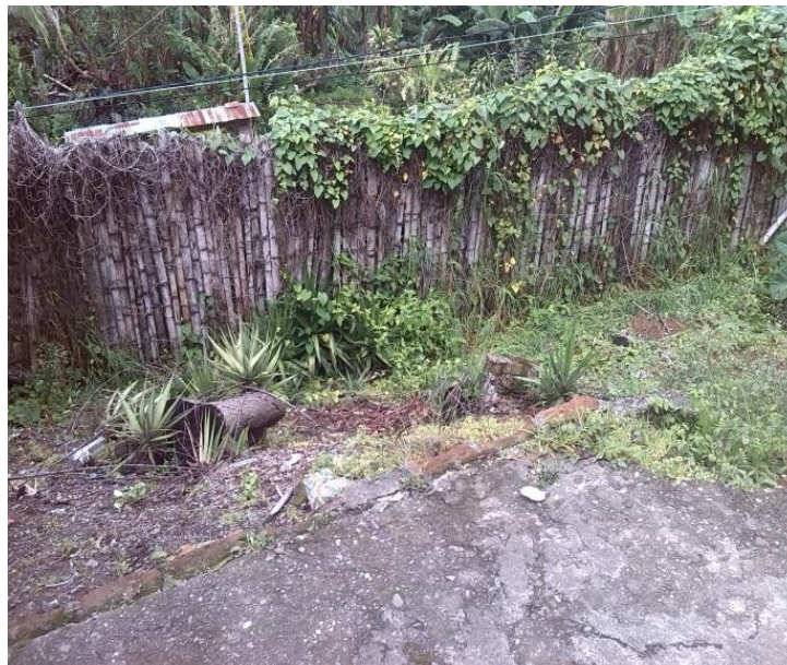
Figura 20. Parte trasera de la vivienda afectada
