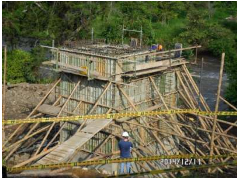
IMAGEN 89 – INSTALACION DE ATRAQUE Y PASARELAS PARA FUNDICION FINAL CAJON IZQUIERDO ESTRIBO No.1
