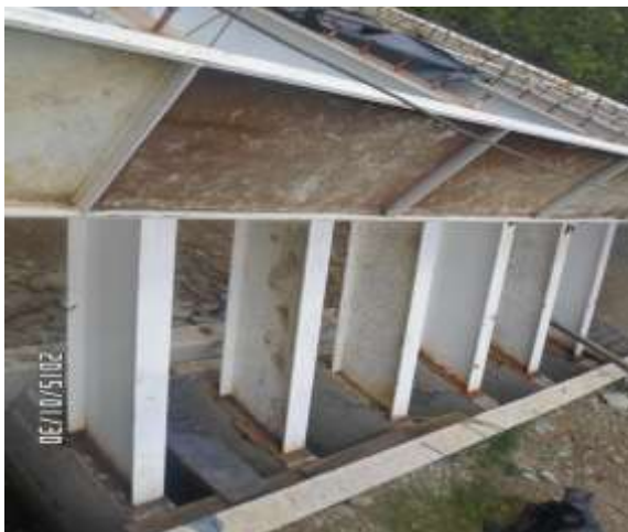
IMAGENES 118 – SOLDADURA CON PLATINA DE TABIQUES PILA CENTRAL
