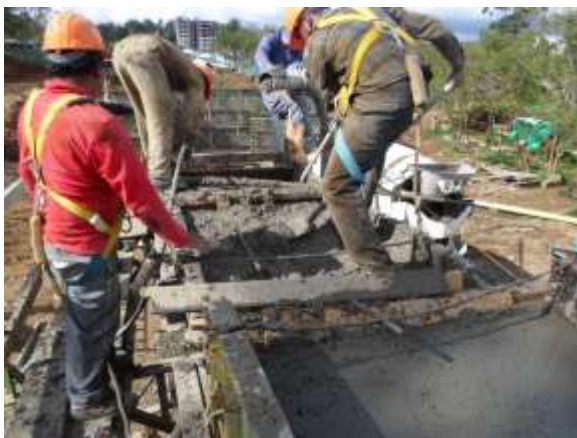
IMÁGENES 29 – FUNDICION VASTAGO IZQUIERDO PILA CENTRAL
