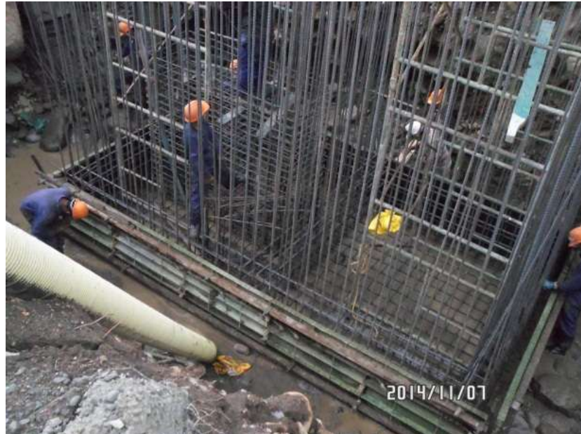
IMAGEN 77 – INSTALACION FORMALETA METALICA CIMENTO ESTRIBO No.1
