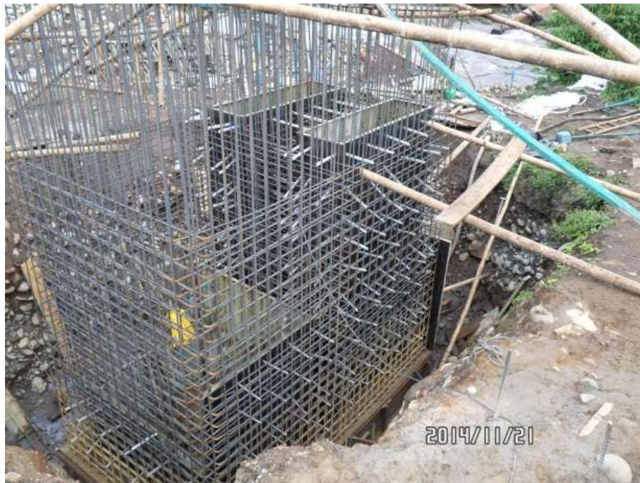
IMAGEN 79 – ACERO DE REFUERZO CAJON Y VASTAGO IZQUIERDO NIVEL PANTALLAS ESTRIBO No.1
