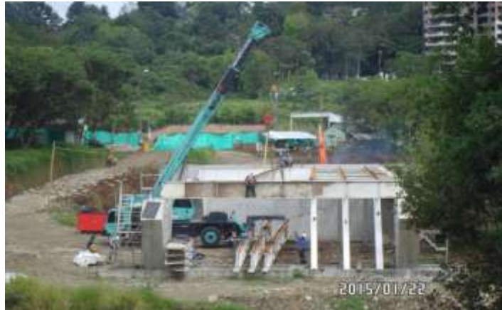
IMAGEN 116 – COLOCACION DE VIGAS DE RIGIDEZ PUENTE SECUNDARIO
