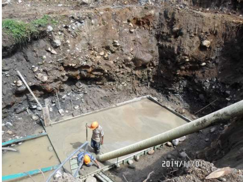
IMAGEN 75 – FUNDICIÓN DE SOLADO DE LIMPIEZA CAJÓN Y VÁSTAGO IZQUIERDO ESTRIBO No.1
