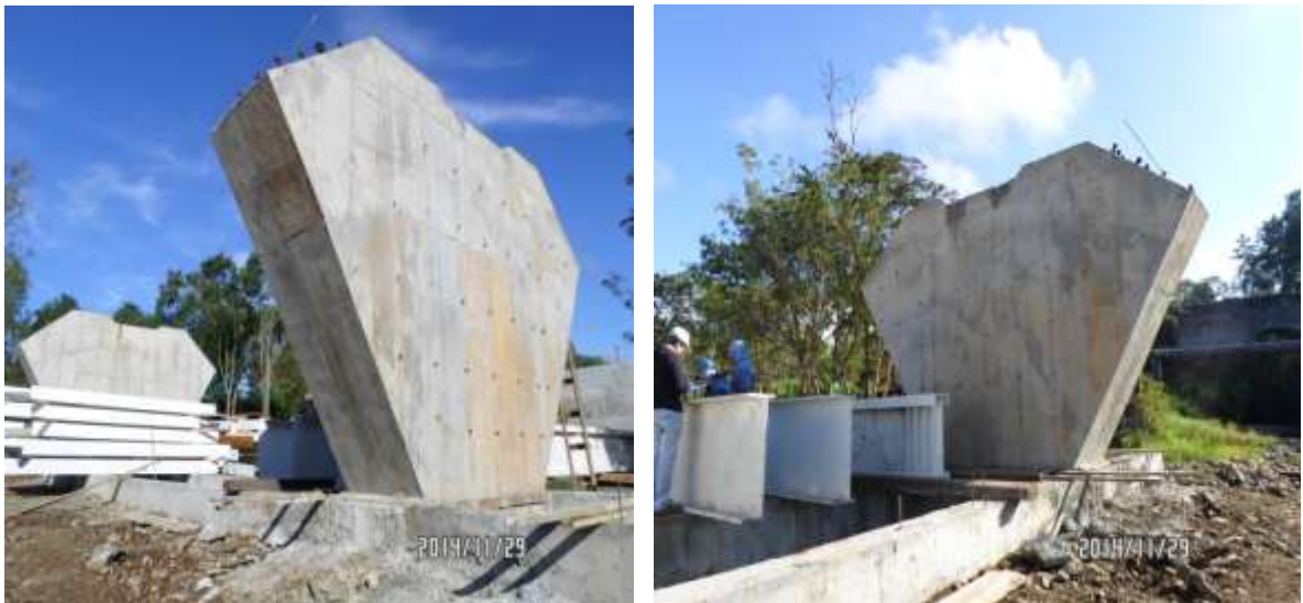
IMAGEN 33 - TERMINACION PILA CENTRAL K0+ 135.32
