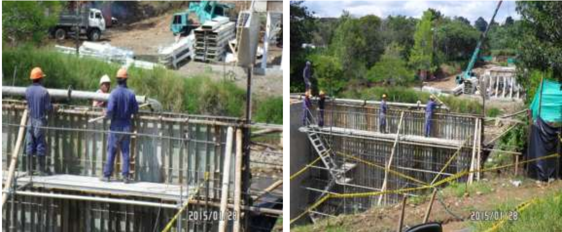
IMÁGENES 105 - FUNDICIÓN FINAL MURO DE CONTENCIÓN ESTRIBO No.1
