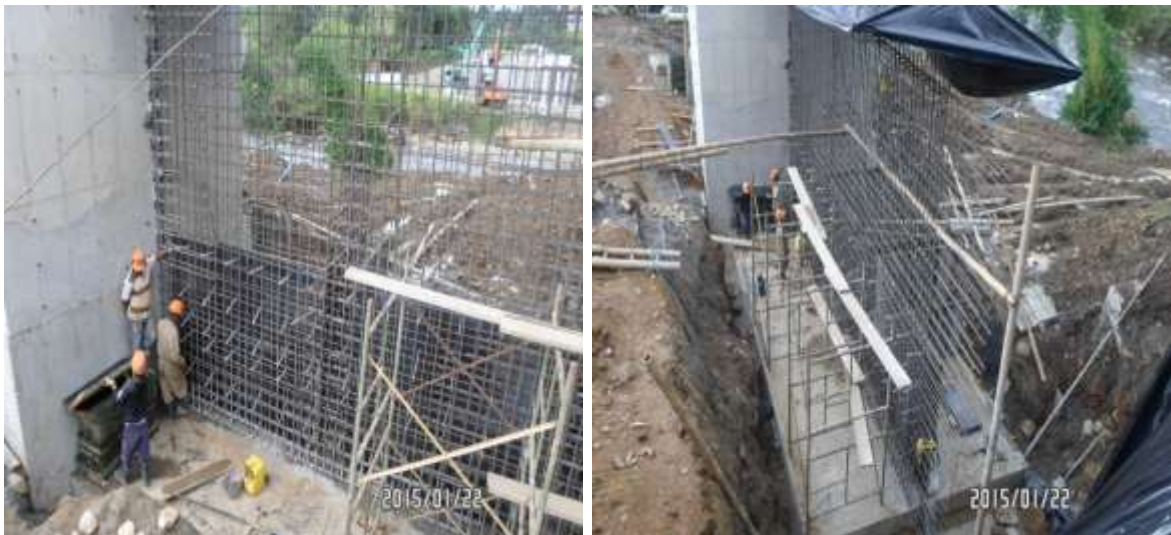
IMÁGENES 101 - INSTALACIÓN Y AMARRE DE ACERO MURO DE CONTENCIÓN Y CONTRAFUERTE MURO ESTRIBO No.1
