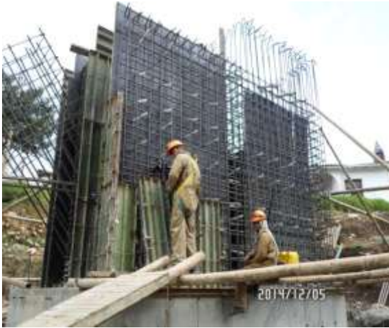
IMÁGENES 88- INSTALACIÓN DE FORMALETA METÁLICA CAJÓN Y VÁSTAGO IZQUIERDO ESTRIBO No.1
