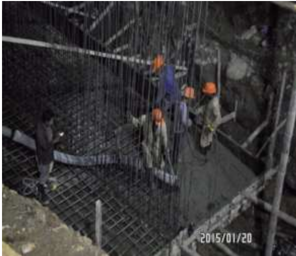
IMÁGENES 99 - FUNDICIÓN DE ZARPA DE MURO DE CONTENCIÓN ESTRIBO No.1
