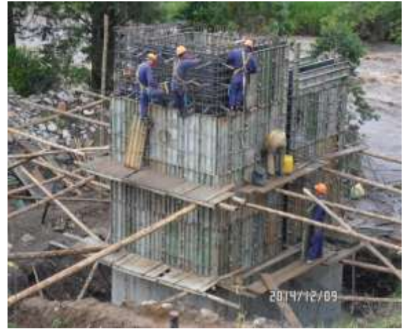
IMÁGENES 88- INSTALACIÓN DE FORMALETA METÁLICA CAJÓN Y VÁSTAGO IZQUIERDO ESTRIBO No.1
