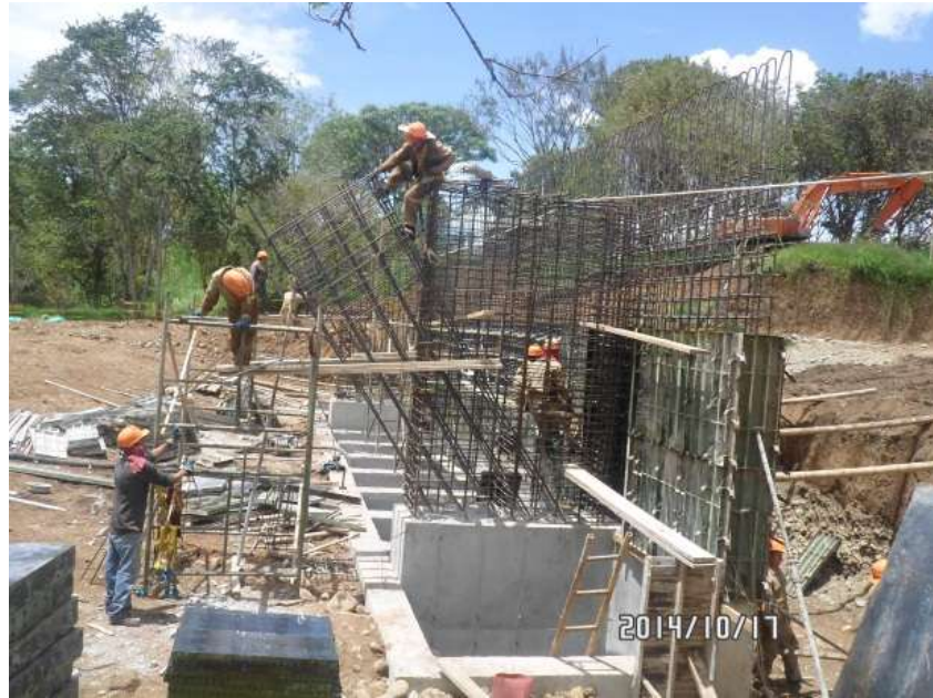
IMAGEN 56 – ACERO DE REFUERZO VASTAGO DERECHO ESTRIBO No.3
