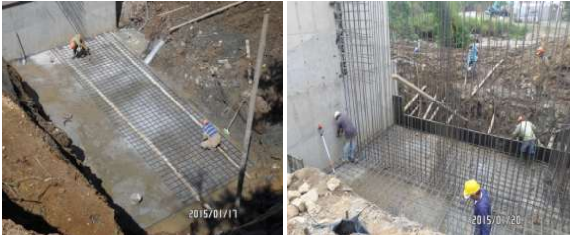
IMAGENES 98 - INSTALACIÓN Y AMARRE DE ACERO DE REFUERZO ZARPA DE MURO DE CONTENCIÓN ESTRIBO No.1
