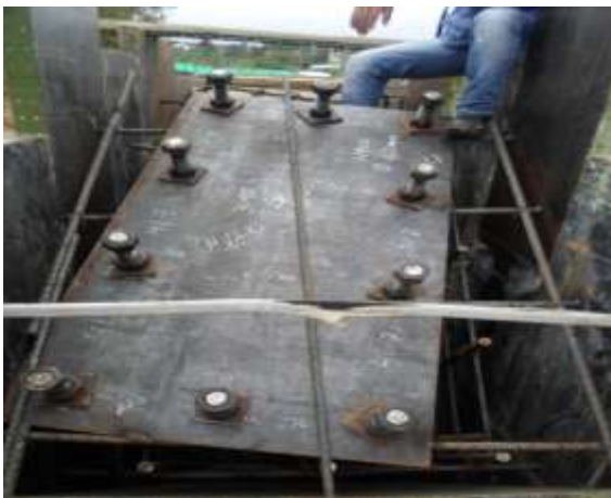
IMÁGENES 28 – INSTALACION DE PLATINAS VASTAGOS PILA CENTRAL
