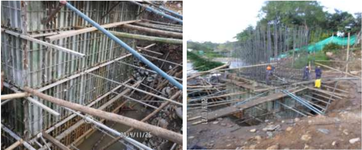
IMÁGENES 82- INSTALACIÓN Y ATRAQUE CAJÓN IZQUIERDO PRIMER NIVEL ESTRIBO No.1
