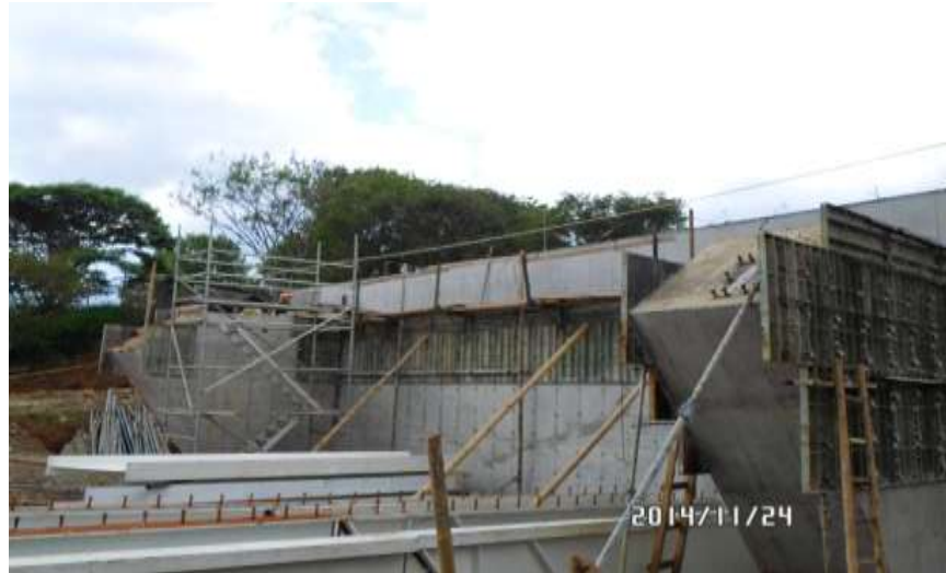
IMAGEN 64 – RETIRO DE FORMAleta MURO DE CONTENCIÓN Y VASTAGOS ESTRIBO No. 3
