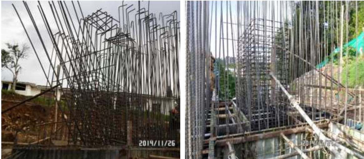
IMÁGENES 80 – ACERO DE REFUERZO MURO DE VASTAGO Y VASTAGO IZQUIERDO ESTRIBO No.1
