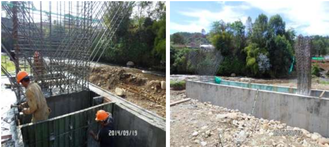
IMÁGENES 18 – RETIRO DE FORMALETA PANTALLAS Y CAJON VASTAGO – PILA CENTRAL
