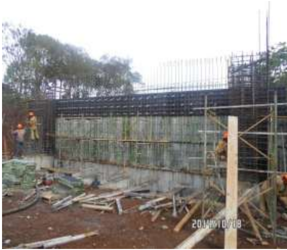
IMÁGENES 59 - INSTALACIÓN DE FORMAleta METÁLICA MURO Y VÁSTAGOS ESTRIBO No. 3
