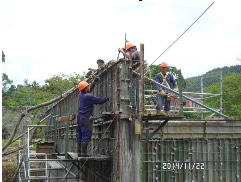
IMAGEN 63 – FUNDICION FINAL MURO DE CONTENCION ESTRIBO No. 3
