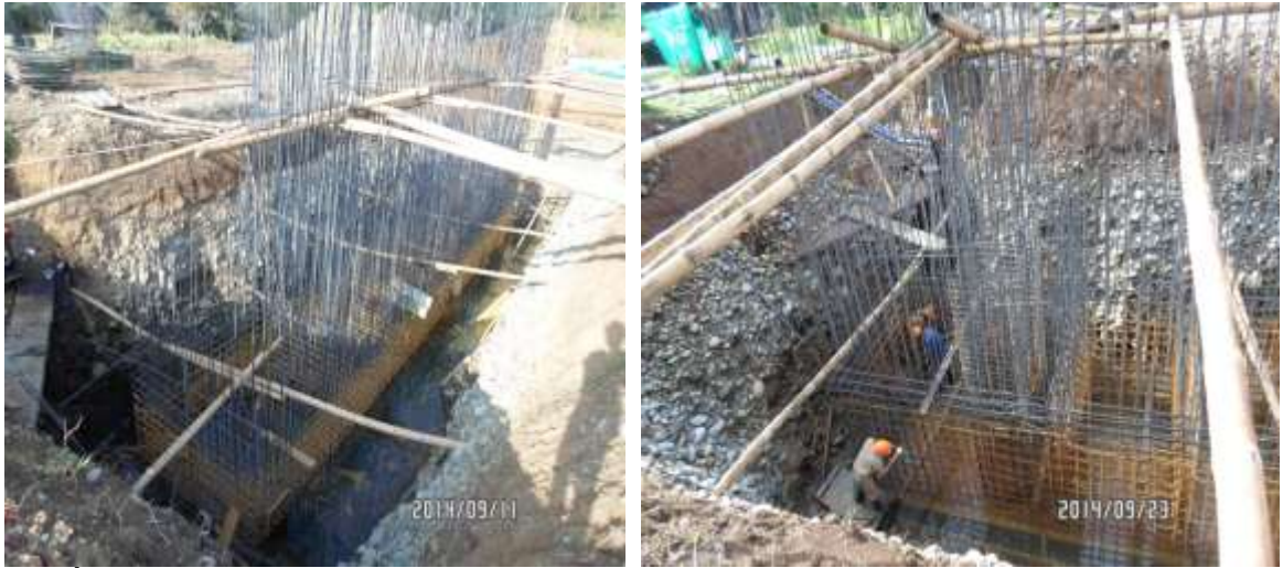
IMÁGENES 41 – INSTALACION Y AMARRE DE ACERO DE REFUERZO ZONA CENTRAL Y CAJON DE VASTAGO PRIMER NIVEL ESTRIBO No. 3
