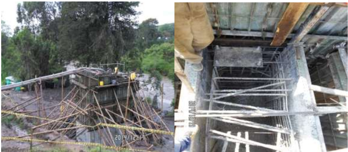
IMÁGENES 92 - FUNDICIÓN PARCIAL DE VÁSTAGO Y CAJÓN ESTRIBO No.1
