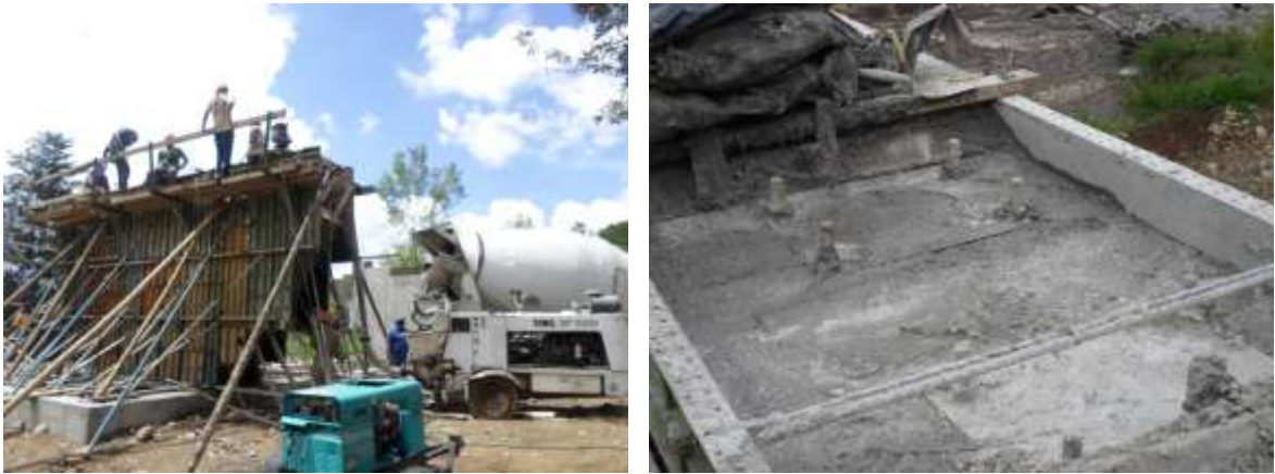
IMÁGENES 30 – FUNDICION VASTAGO DERECHO PILA CENTRAL
