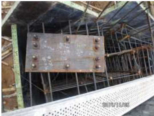
IMÁGENES 61 - INSTALACIÓN DE PLANTILLAS EN VÁSTAGOS ESTRIBO No.3
