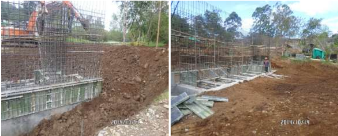
IMÁGENES 51 – RELLENO CON MATERIAL GRANULAR ESTRIBO No.3
