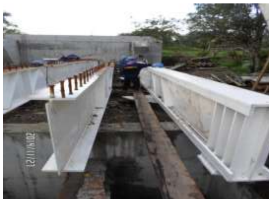
IMAGEN 115 - ARMADO Y SOLDADURA DE VIGAS DE RIGIDEZ PUENTE SECUNDARIO
