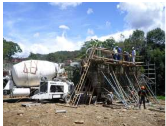
IMÁGENES 29 – FUNDICION VASTAGO IZQUIERDO PILA CENTRAL
