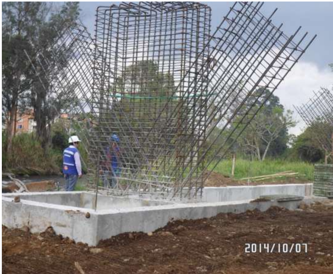
IMAGEN 23 – ACERO DE REFUERZO VASTAGO DERECHO PILA CENTRAL
