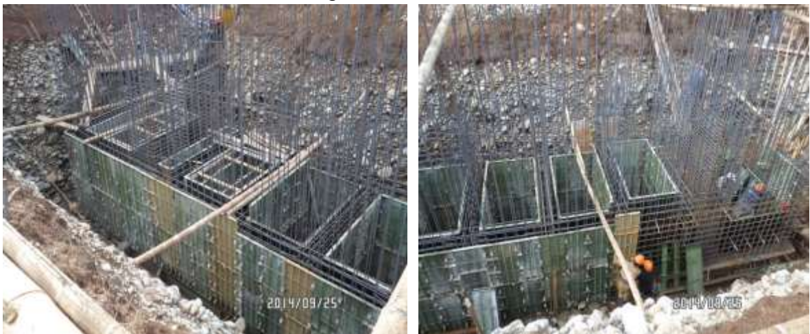
IMÁGENES 42 - INSTALACIÓN DE FORMALETA METÁLICA ZONA CENTRAL Y CAJON DE VASTAGOS PRIMER NIVEL ESTRIBO No.3
