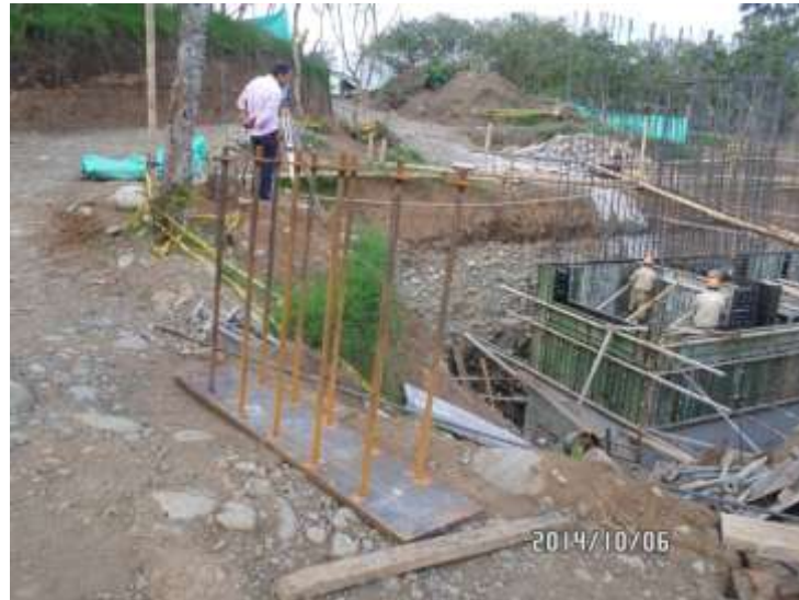
IMAGEN 48- DETALLE PLATINA ESTRIBO No. 3
