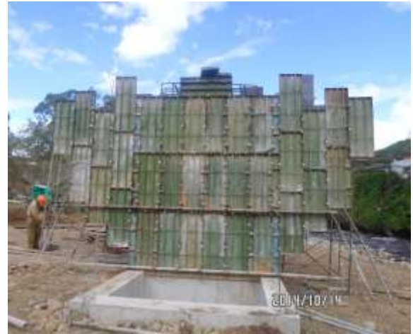
IMÁGENES 27 – INSTALACION DE FORMALETA METALICA VASTAGOS PILA CENTRAL
