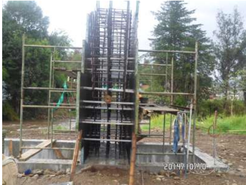
IMAGEN 25 - FORMALETA METALICA Y CORBATAS VASTAGO IZQUIERDO PILA CENTRAL
