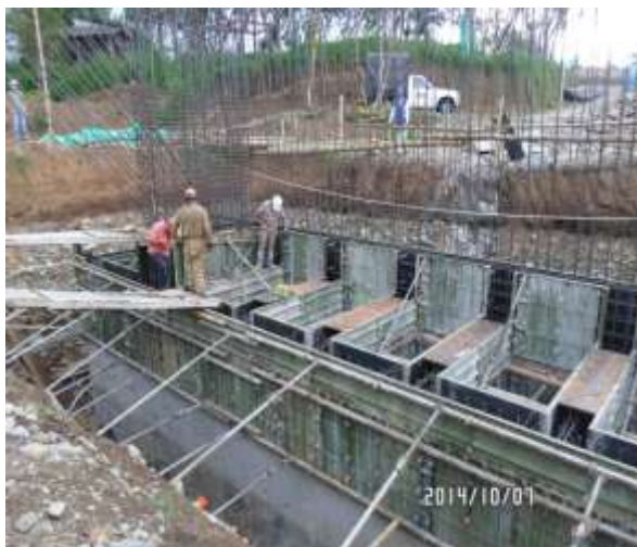
IMÁGENES 49 - INSTALACIÓN DE PLATINAS DE TABIQUES - ESTRIBO No. 3
