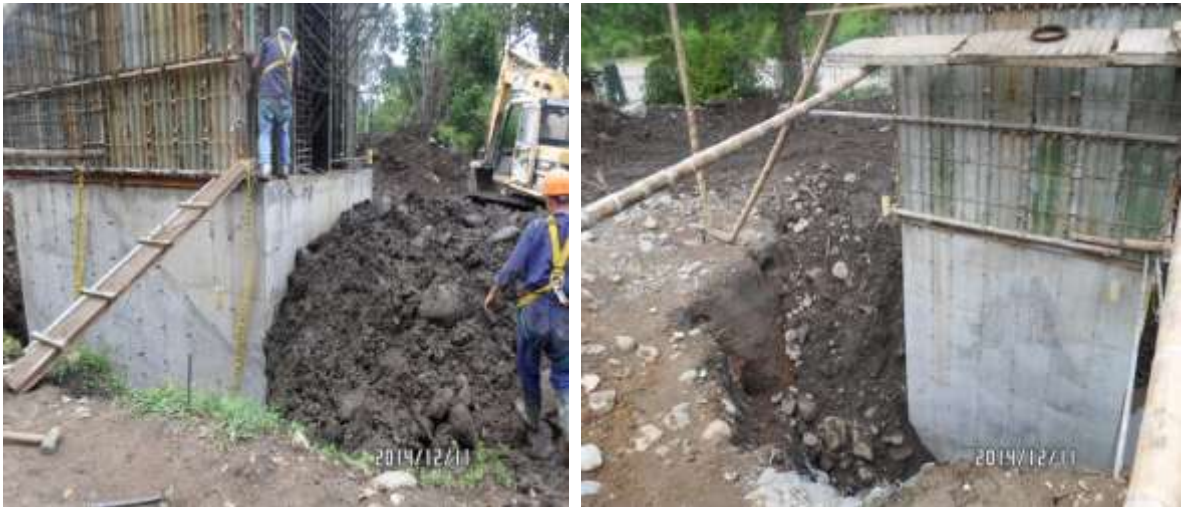
IMÁGENES 90 -RELLENO CON MATERIAL GRANULAR CAJÓN IZQUIERDO ESTRIBO No.1
