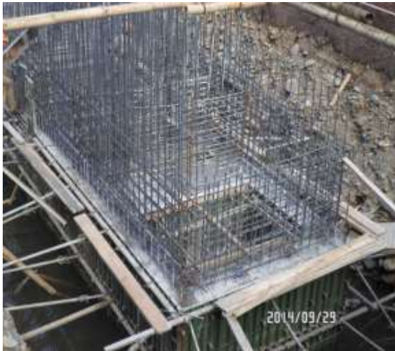
IMÁGENES 43 – PRIMERA FUNDICION DE PANTALLAS, MURO DEL VASTAGO Y TABIQUES - ESTRIBO No. 3
