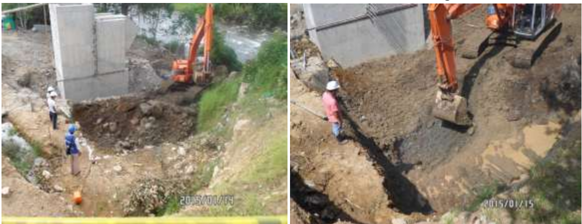
IMÁGENES 95 - EXCAVACIÓN PARA MURO DE CONTENCIÓN ESTRIBO No.1
