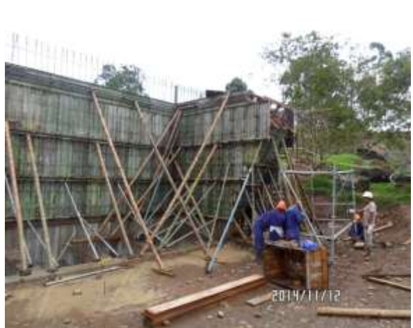
IMÁGENES 60 - INSTALACIÓN DE ATRAQUE EN VÁSTAGOS Y MURO DE CONTENCIÓN ESTRIBO No. 3
