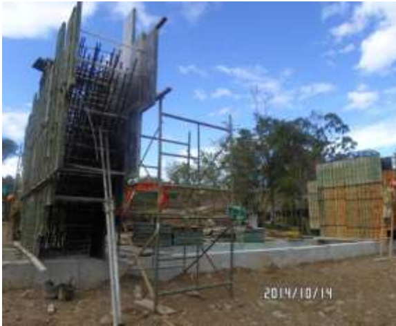
IMÁGENES 27 – INSTALACION DE FORMALETA METALICA VASTAGOS PILA CENTRAL
