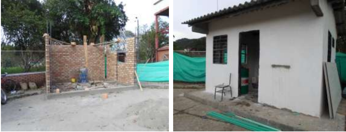
IMAGEN 111 – PROCESO DE CONSTRUCCION CASETA DE VIGILANCIA COLEGIO GABRIELA MISTRAL
