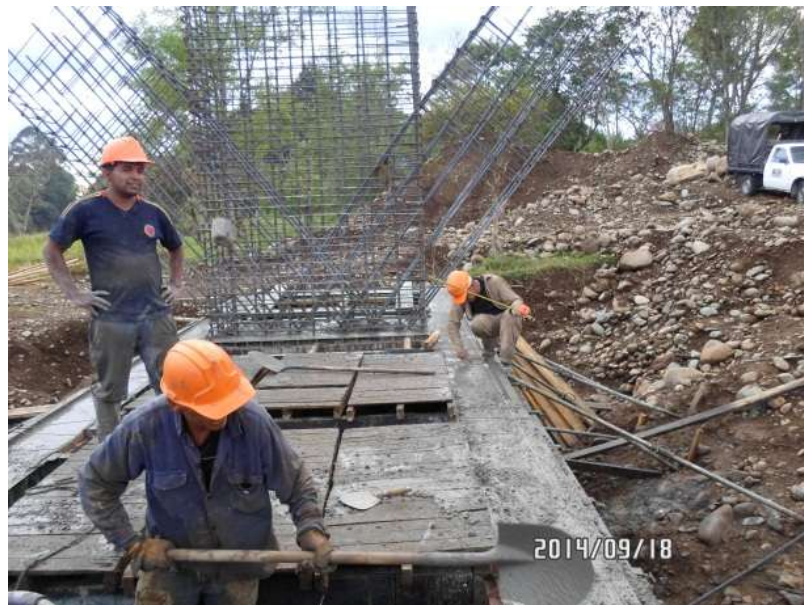
IMAGEN 15 – FUNDICION CAJON VASTAGOS Y CAJON CENTRAL PILA CENTRAL
