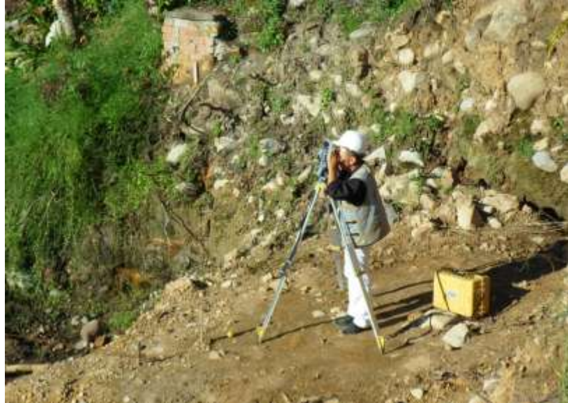
IMAGEN 72 – LOCALIZACION Y REPLANTEO ESTRIBO No.1
