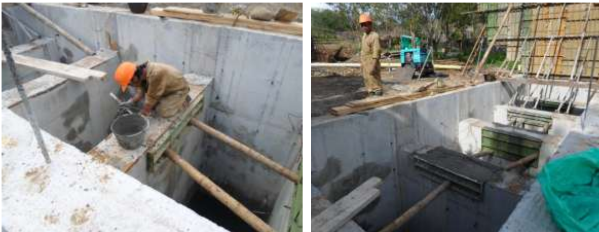
IMÁGENES 31 – ARREGLO DE TABIQUES PILA CENTRAL
