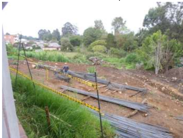
IMAGEN 114 – ALMACENAMIENTO DE ACERO
