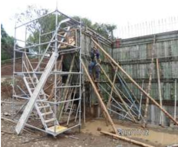
IMÁGENES 60 - INSTALACIÓN DE ATRAQUE EN VÁSTAGOS Y MURO DE CONTENCIÓN ESTRIBO No. 3
