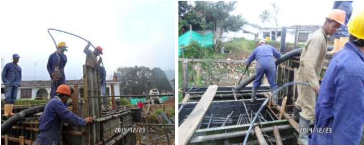
IMÁGENES 93 - FUNDICIÓN FINAL CAJÓN Y VÁSTAGO IZQUIERDO ESTRIBO No.1
