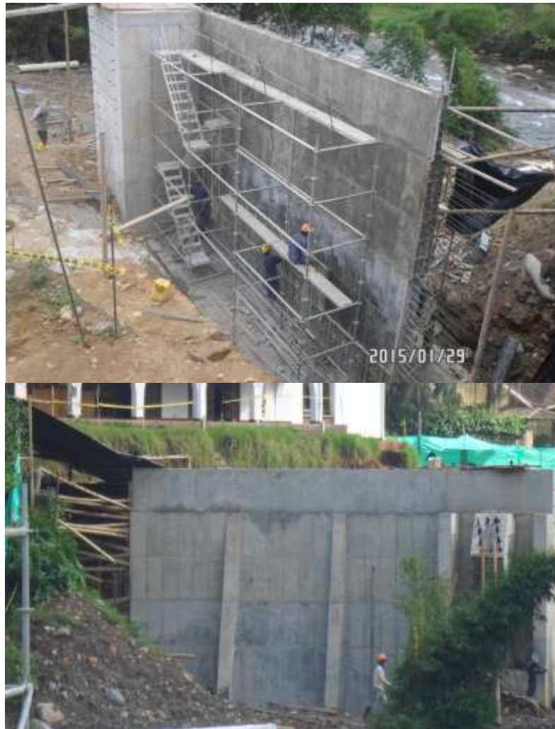
IMÁGENES 106 – RETIRO FORMAleta METALICA MURO DE CONTENCIÓN Y CONTRAFUERTE MURO ESTRIBO No.1
