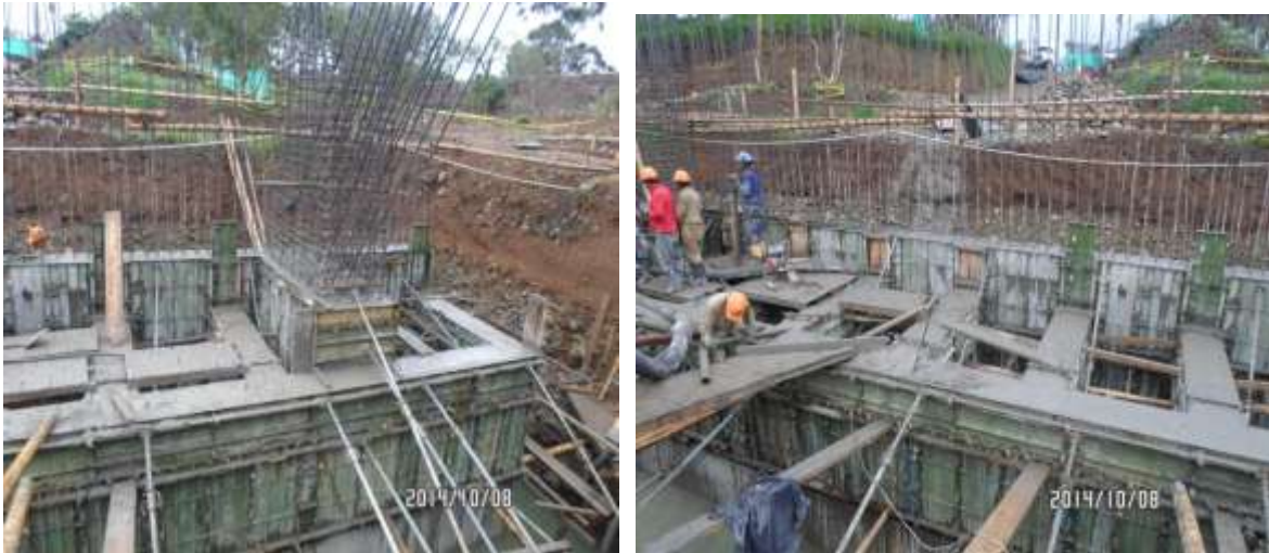
IMÁGENES 50 – FUNDICION FINAL DE PANTALLAS, MURO DEL VASTAGO Y TABIQUES - ESTRIBO No. 3
