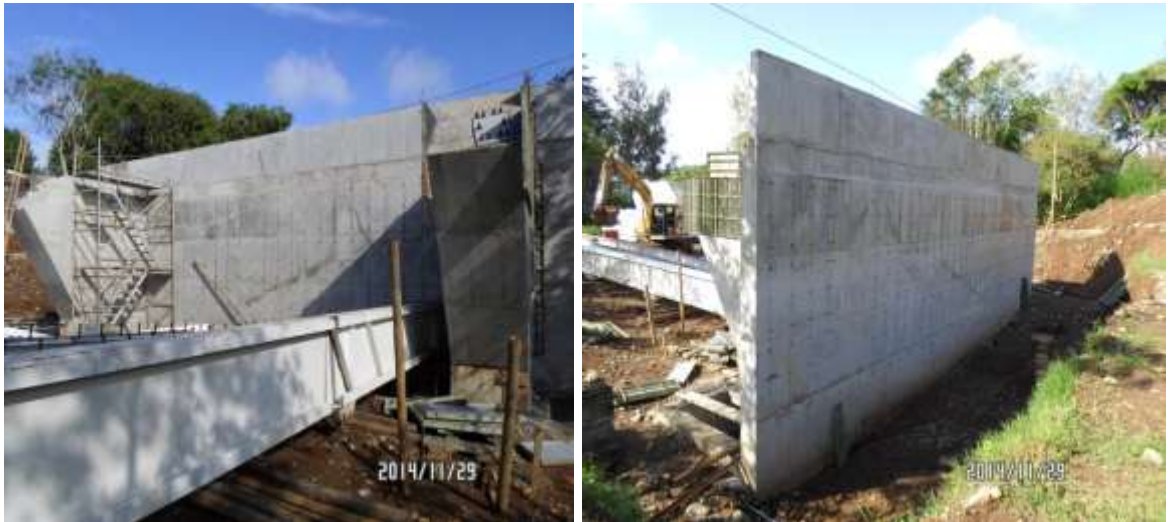
IMÁGENES 66 – TERMINACION ESTRIBO No. 3 k0+165.32
