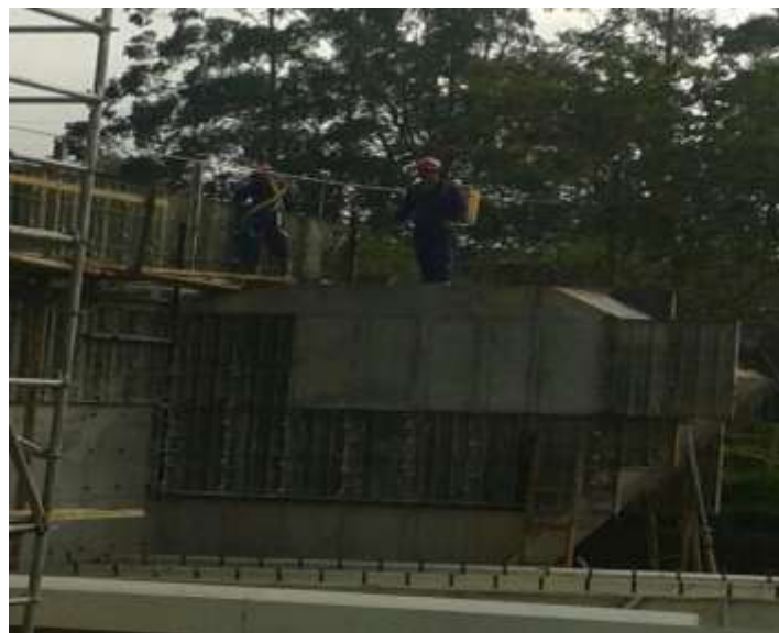
IMAGEN 65 – APLICACIÓN DE ANTI SOL ESTRIBO No.3
