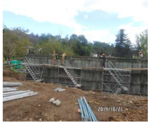
IMÁGENES 59 - INSTALACIÓN DE FORMAleta METÁLICA MURO Y VÁSTAGOS ESTRIBO No. 3
