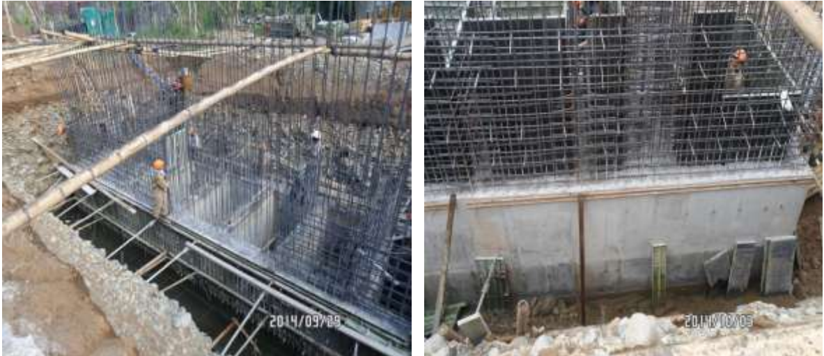
IMÁGENES 44 – RETIRO DE FORMALETA METALICA 1° FUNDICION DE CAJON DE VASTAGOS Y CAJON CENTRAL ESTRIBO No. 3
