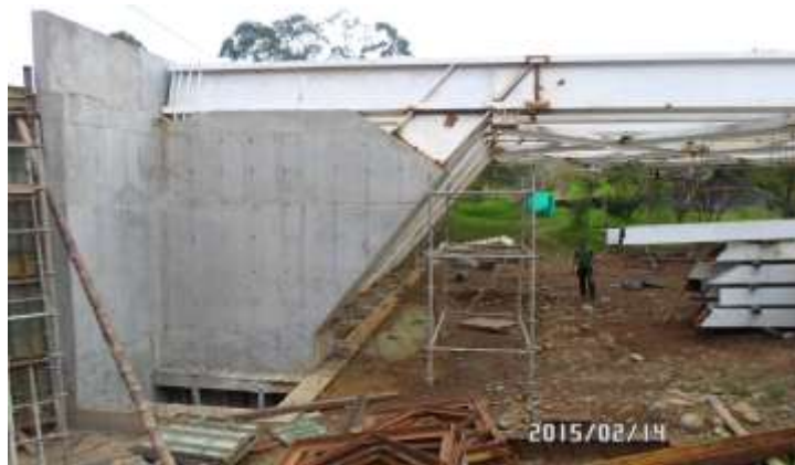
IMAGEN 117 – VIGAS Y VASTAGO ESTRIBO No.3
