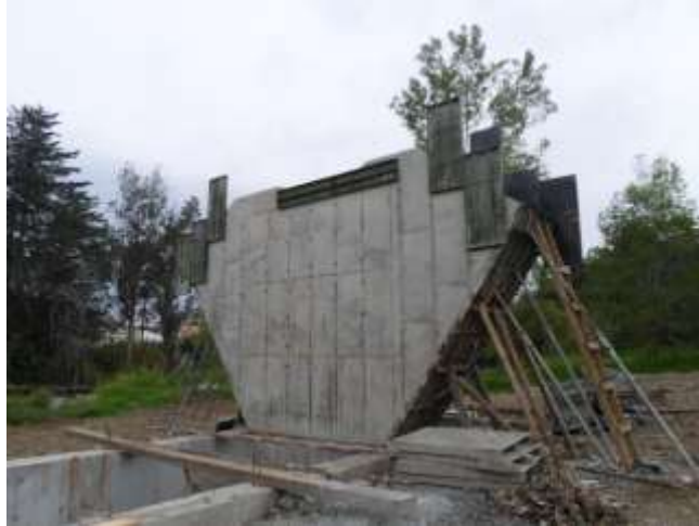
IMAGEN 32 – RETIRO DE FORMAleta VASTAGOS PILA CENTRAL
