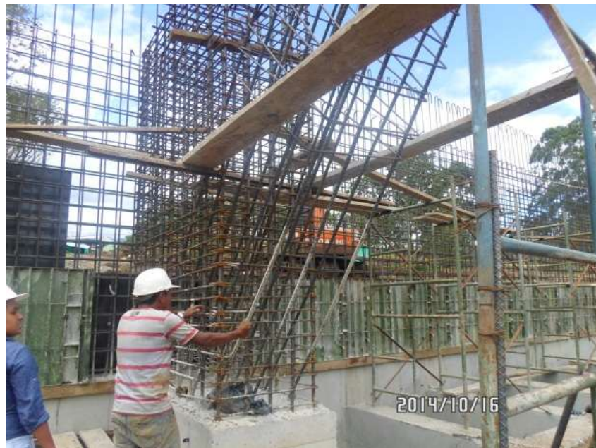
IMAGEN 57 – ACERO DE REFUERZO VASTAGO IZQUIERDO ESTRIBO No. 3
