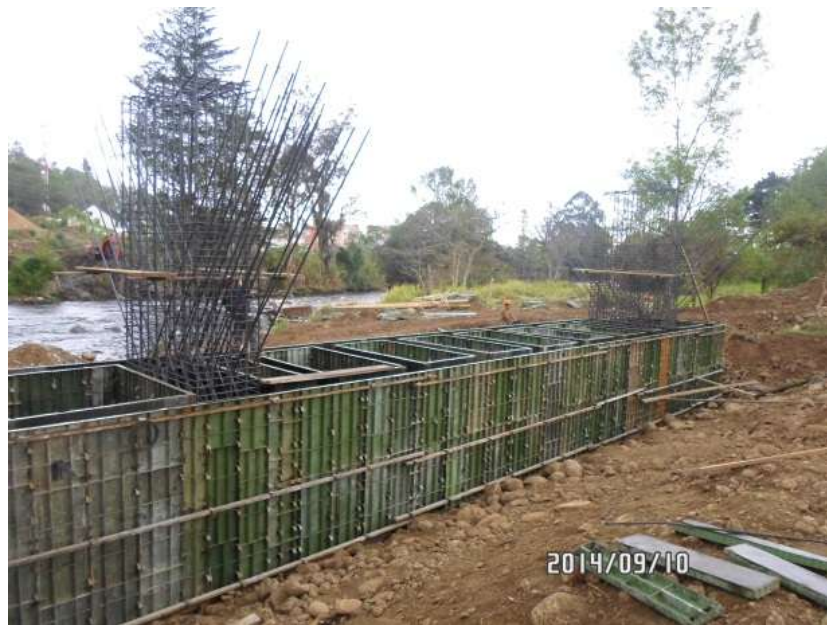
IMAGEN 12 – INSTALACION FORMALETA METALICA PANTALLAS Y CAJON PILA CENTRAL
