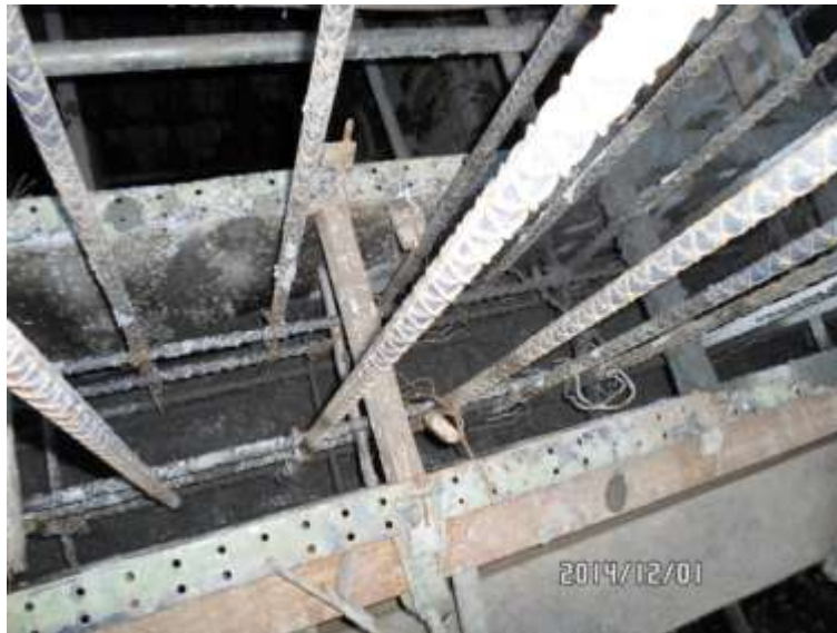
IMAGEN 83 – FUNDICION PARCIAL DE CAJON Y MURO DEL VASTAGO IZQUIERDO – RECUBRIMIENTO – ESTRIBO No.1
