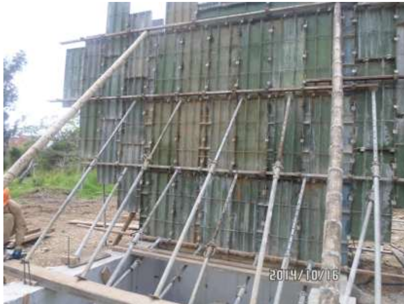
IMAGEN 26- ATRAQUE DE FORMALETA CON GATOS HIDRAULICOS Y TACOS DE GUADUAS EN FUNDICION VASTAGOS - PILA CENTRAL
