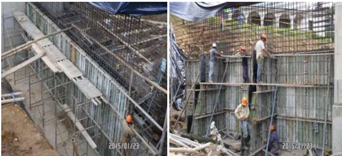
IMÁGENES 102 - INSTALACIÓN DE FORMAleta METÁLICA MURO DE CONTENCIÓN Y CONTRAFUERTE MURO ESTRIBO No.1
