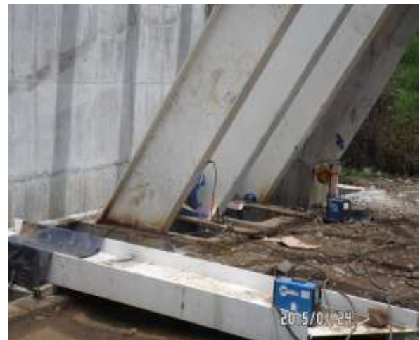
IMAGENES 118 – SOLDADURA CON PLATINA DE TABIQUES PILA CENTRAL
