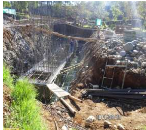
IMÁGENES 43 – PRIMERA FUNDICION DE PANTALLAS, MURO DEL VASTAGO Y TABIQUES - ESTRIBO No. 3
