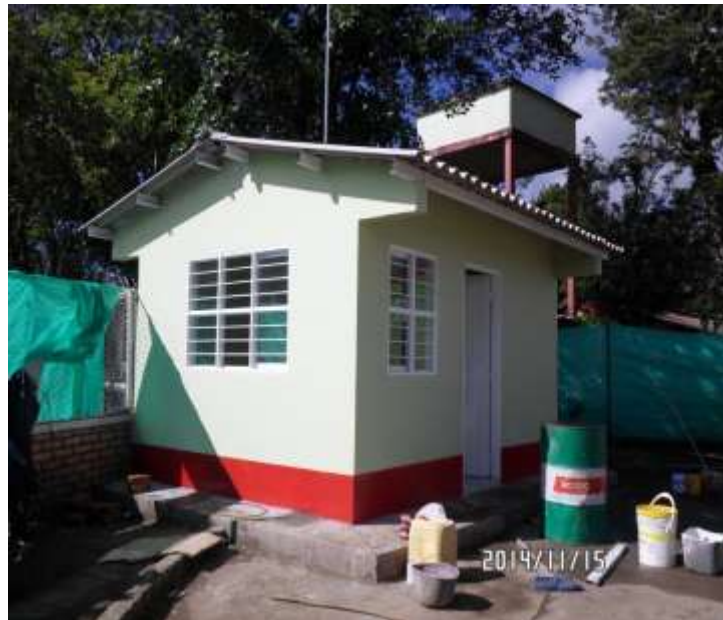
IMAGEN 112 – CASETA DE VIGILANCIA TERMINADA COLEGIO GABRIELA MISTRAL
