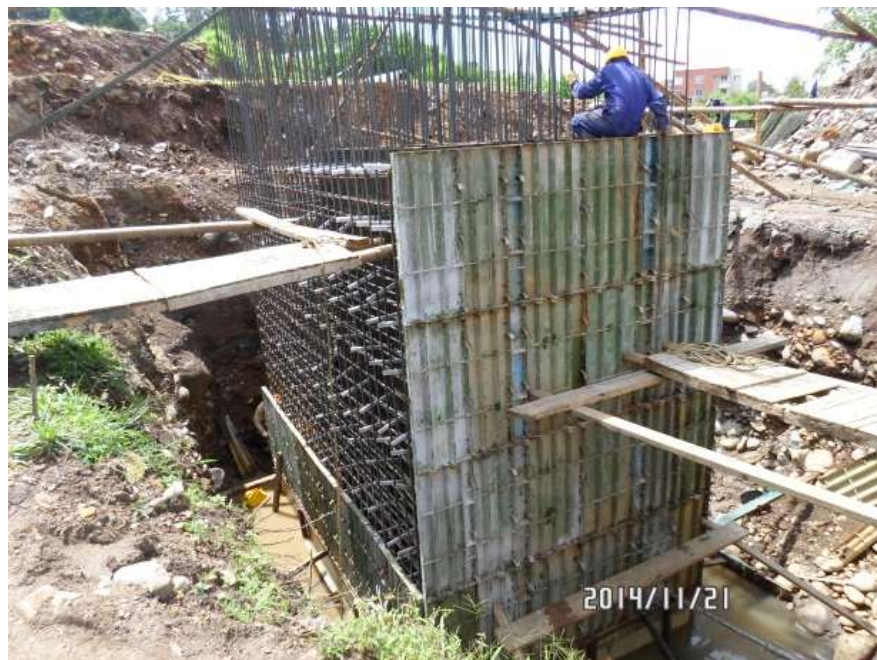
IMAGEN 81 – INSTALACION DE FORMALETA METALICA CAJON IZQUIERDO PRIMER NIVEL ESTRIBO No.1
