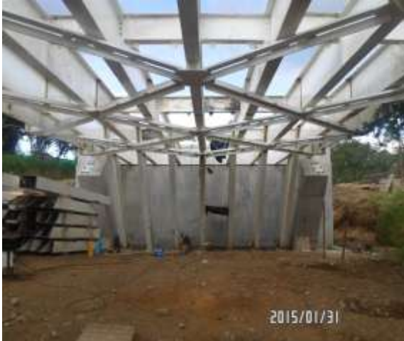
IMAGENES 119 – MONTAJE DE VIGAS PUENTE SECUNDARIO
