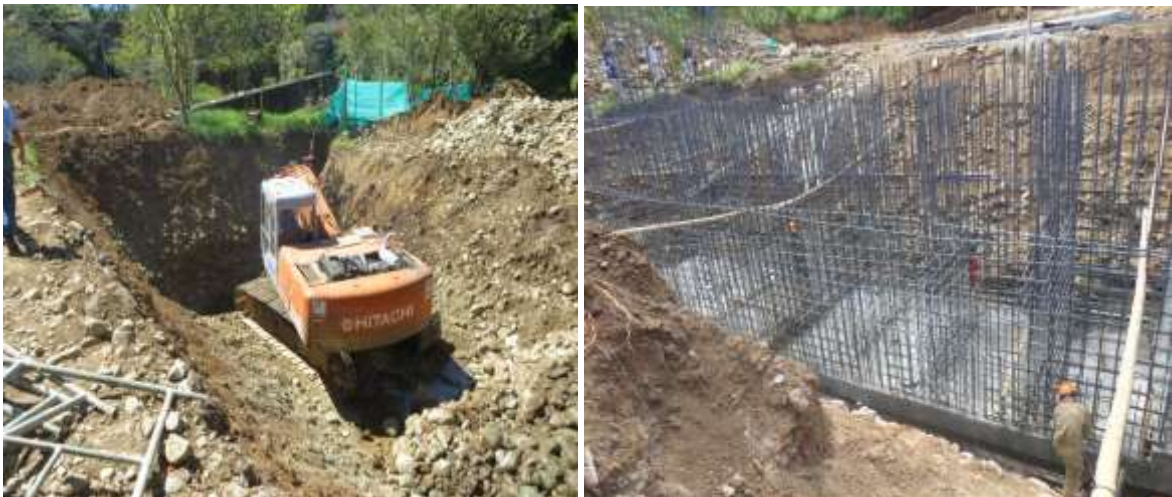
IMAGEN 3 – EXCAVACION SECA MATERIAL GRANULAR Y FUNDACIONES EN CONCRETO PILA CENTRAL
