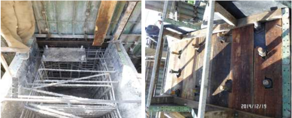
IMÁGENES 91 - INSTALACIÓN DE PLATINA VÁSTAGO IZQUIERDO ESTRIBO No.1
