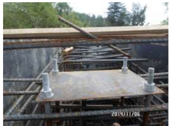
IMÁGENES 61 - INSTALACIÓN DE PLANTILLAS EN VÁSTAGOS ESTRIBO No.3
