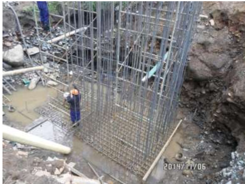
IMAGEN 76 – ACERO DE REFUERZO CIMENTACION CAJON IZQUIERDO ESTRIBO No.1
