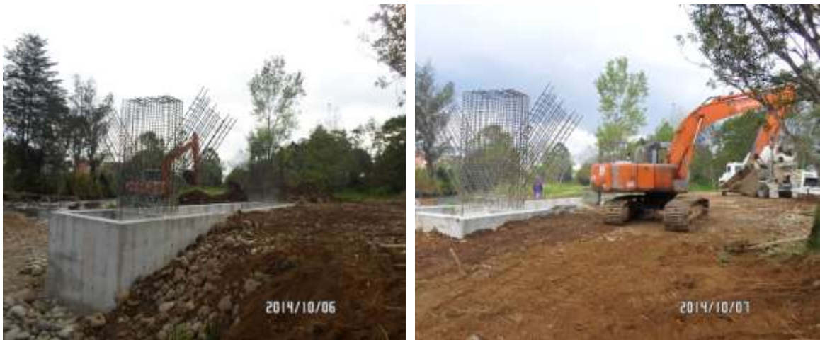
IMÁGENES 19 – RELLENO CON MATERIAL GRANULAR SEGUNDO NIVEL – PILA CENTRAL
