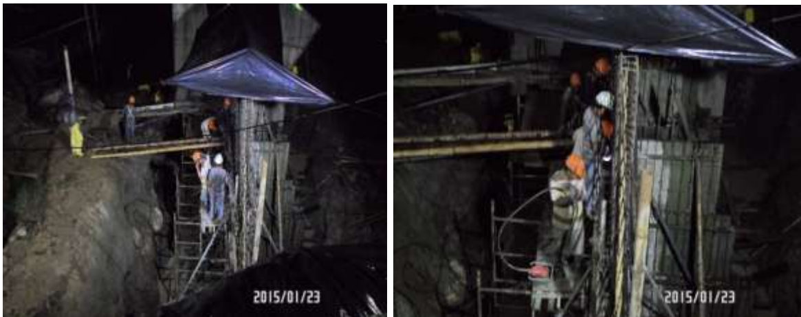
IMÁGENES 104 -FUNDICIÓN DE MURO DE CONTENCIÓN Y CONTRAFUERTE MURO ESTRIBO NO.1
