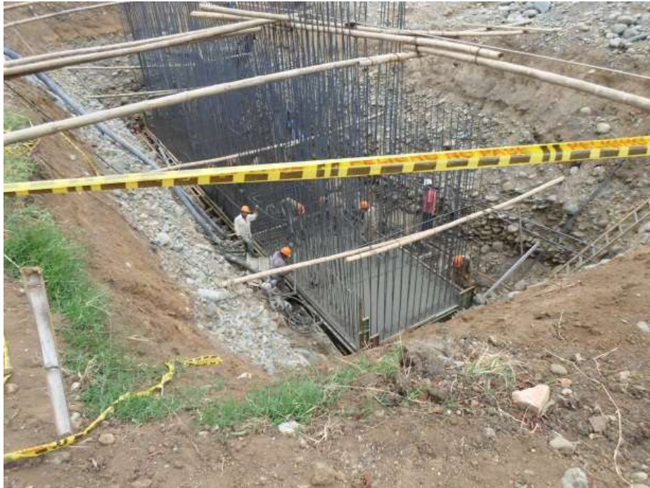
IMAGEN 40 – FUNDICION DE CIMENTACION ESTRIBO No.3
