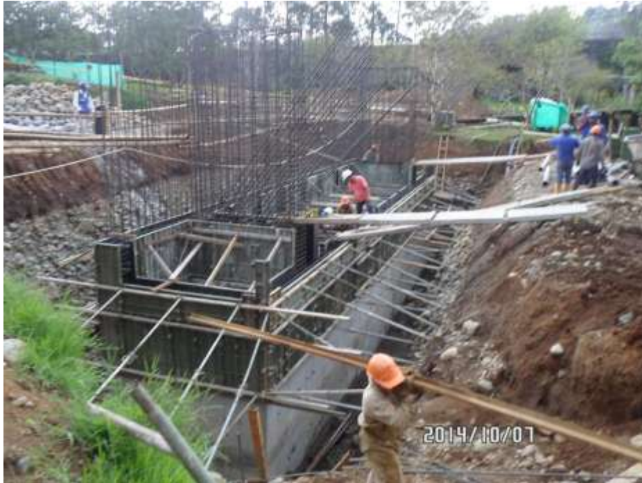
IMAGEN 47 – ATRAQUE DE FORMALETA CON GATOS HIDRAULICOS Y TACOS DE GUADUAS EN FUNDICION CAJON VASTAGOS Y CAJON ZONA CENTRAL – ESTRIBO No.3
