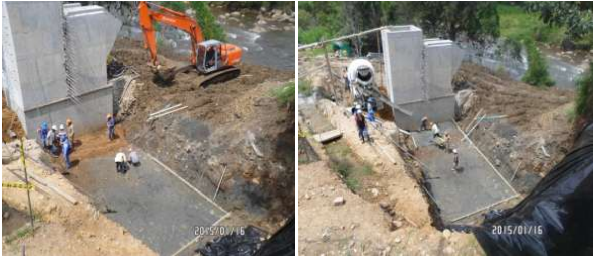
IMÁGENES 96 – SOLADO DE LIMPIEZA DEL MURO DE CONTENCIÓN ESTRIBO No.1
