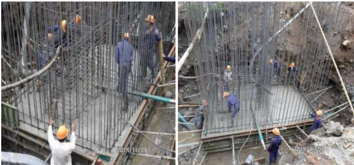
IMÁGENES 78 – FUNDICION CIMENTACION CAJON IZQUIERDO ESTRIBO No.1
