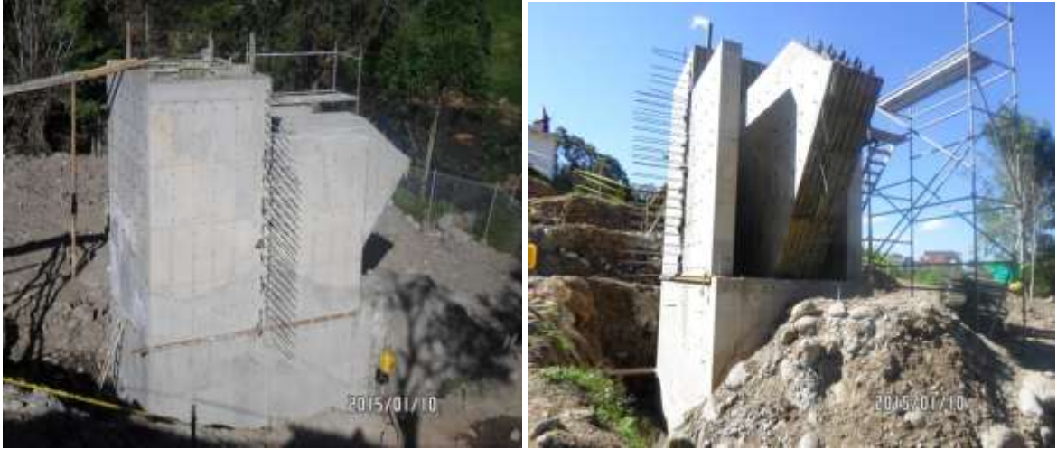
IMÁGENES 94 - RETIRO DE FORMALETA METÁLICA CAJÓN Y VÁSTAGO IZQUIERDO ESTRIBO No.1
