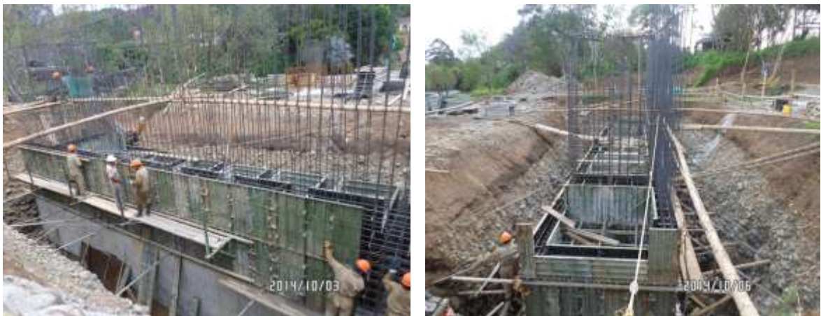
IMÁGENES 46 – INSTALACIÓN DE FORMALETA METÁLICA ZONA CENTRAL Y CAJON DE VASTAGOS SEGUNDO NIVEL ESTRIBO No. 3
