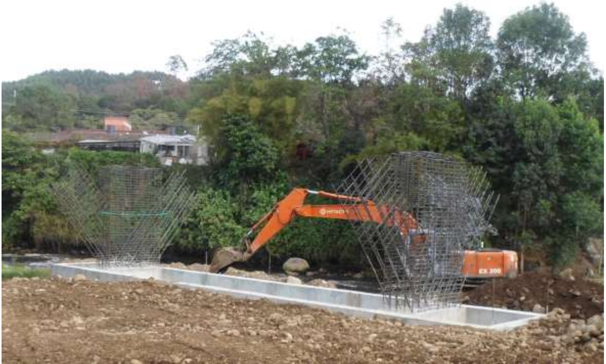
IMAGEN 24 – ACERO DE REFUERZO VASTAGOS PILA CENTRAL
