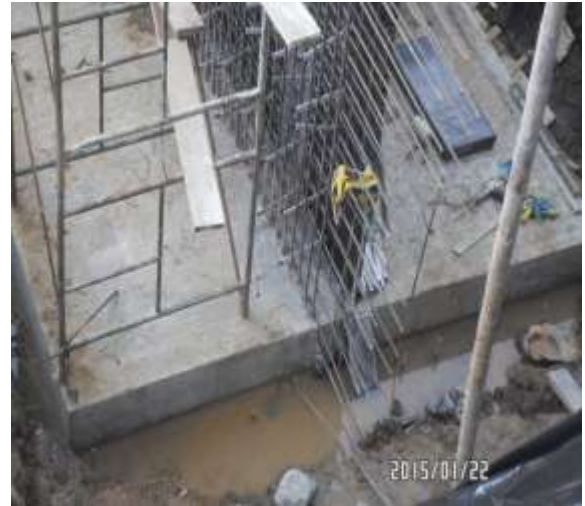
IMÁGENES 99 - FUNDICIÓN DE ZARPA DE MURO DE CONTENCIÓN ESTRIBO No.1
