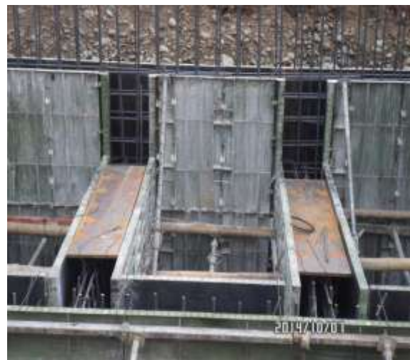
IMÁGENES 49 - INSTALACIÓN DE PLATINAS DE TABIQUES - ESTRIBO No. 3
