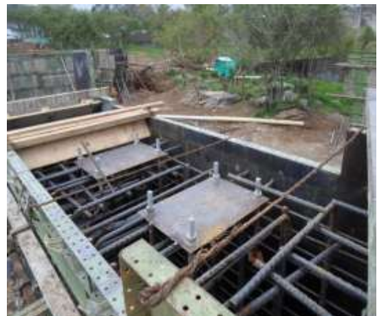
IMÁGENES 28 – INSTALACION DE PLATINAS VASTAGOS PILA CENTRAL
