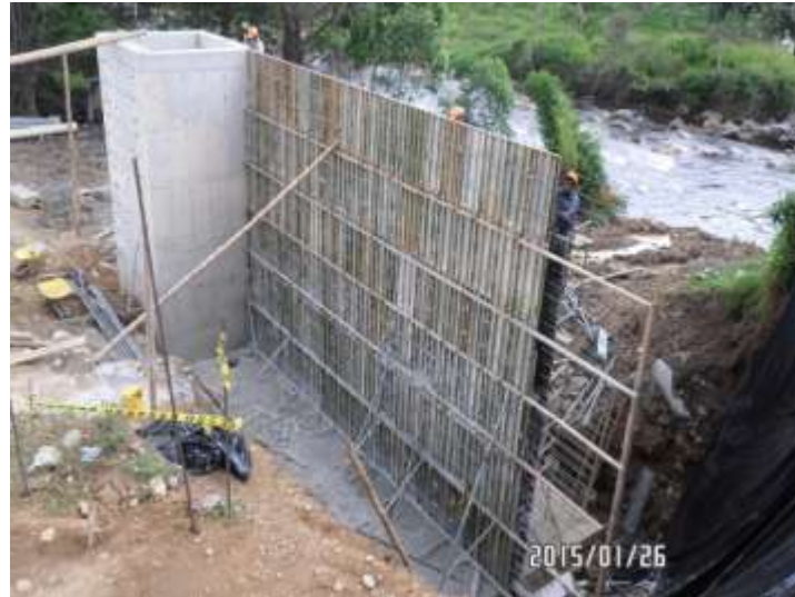
IMAGEN 103 – INSTALACION FORMALETA METALICA FUNDICION DE MURO DE CONTENCIÓN ESTRIBO No.1
