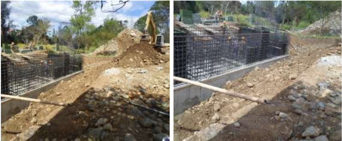
IMÁGENES 11 – RELLENO CON MATERIAL GRANULAR PILA CENTRAL
