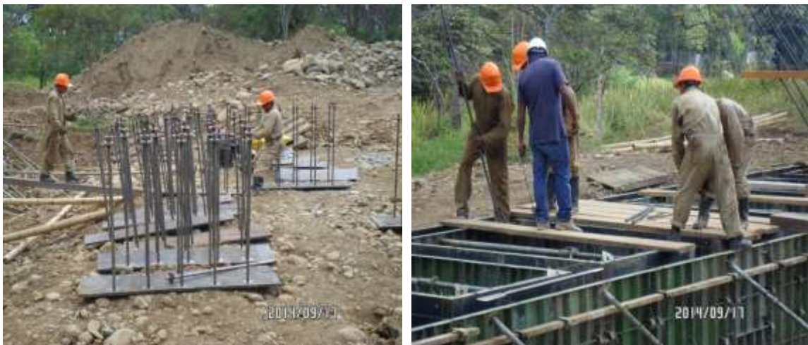
IMÁGENES 14 – INSTALACION PLATINAS DE TABIQUES PILA CENTRAL
