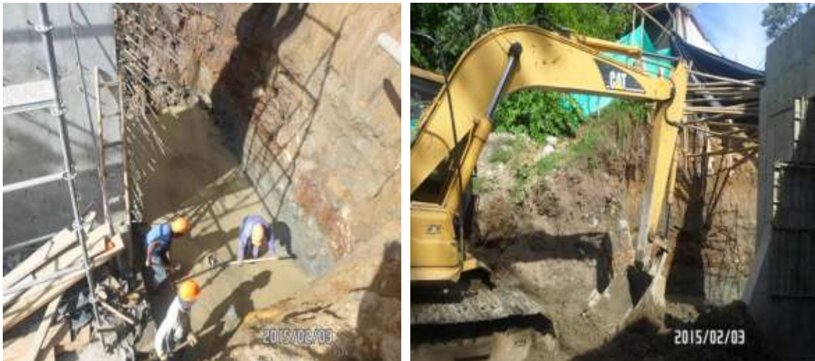
IMÁGENES 107 – EXCAVACION CAJON DERECHO ESTRIBO No.1
