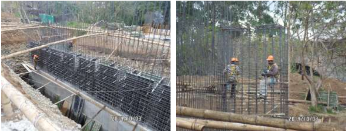
IMÁGENES 45 – INSTALACION Y AMARRE DE ACERO DE REFUERZO ZONA CENTRAL Y CAJON DE VASTAGO SEGUNDO NIVEL ESTRIBO No. 3
