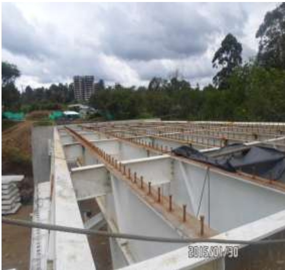
IMAGENES 120 –PUENTE SECUNDARIO EN VIGAS METALICAS
