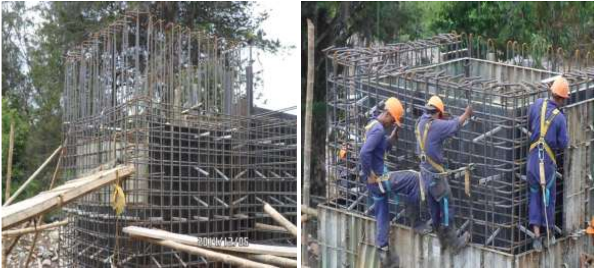
IMÁGENES 86 – INSTALACION TOTAL DE ACERO DE REFUERZO CAJON Y VASTAGO IZQUIERDO – ESTRIBO No.1
