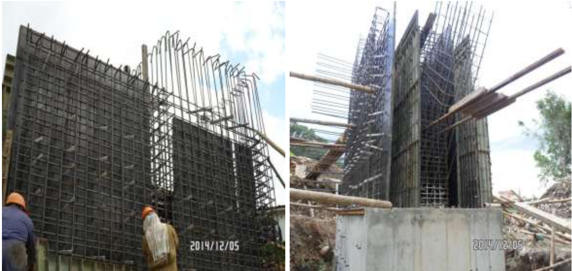
IMAGEN 87 – INSTALACION DE ACERO DE REFUERZO CAJON Y VASTAGO IZQUIERDO NIVEL VASTAGO - ESTRIBO No. 1
