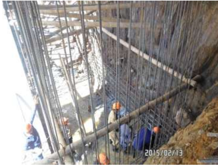
IMAGEN 109 - INSTALACIÓN Y AMARRE DE ACERO DE REFUERZO CAJÓN DERECHO ESTRIBO No.1
