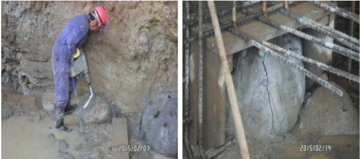
IMÁGENES 108- APLICACIÓN DE AGENTE DEMOLEDOR NO EXPLOSIVO ESTRIBO No.1
