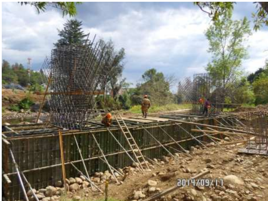
IMAGEN 13 – ATRAQUE DE FORMALETA CON GATOS HIDRAULICOS Y TACOS DE GUADUAS EN FUNDICION CAJON VASTAGOS Y CAJON ZONA CENTRAL - PILA CENTRAL
