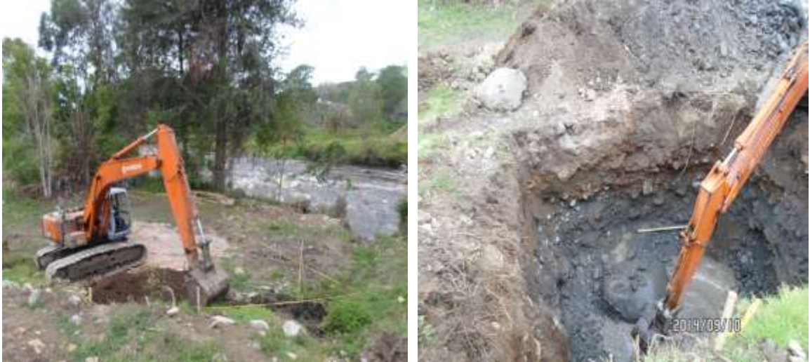
IMÁGENES 73 – EXCAVACION CAJON IZQUIERDO ESTRIBO No.1
