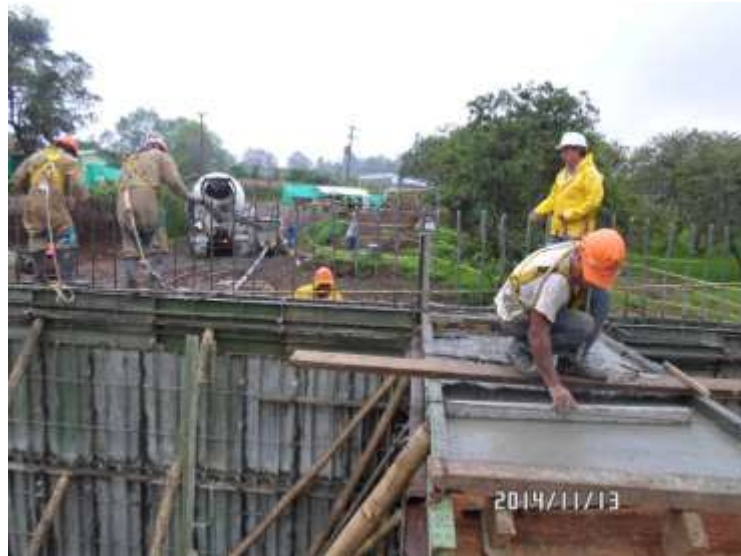
IMAGEN 62 – FUNDICION MURO DE CONTENCION Y VASTAGO ESTRIBO No. 3
