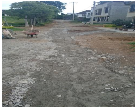
Figura 37. Colocación y compactación de de sub base
