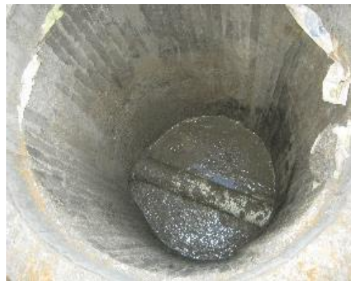
Figura 3 Construcción de cámara de inspección en concreto.
