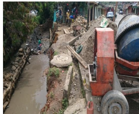
Figura 25. Concreto para cimentación de muro de contención
