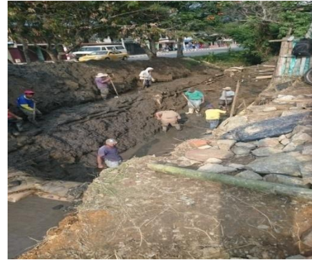
Figura 27. Excavación en conglomerado
