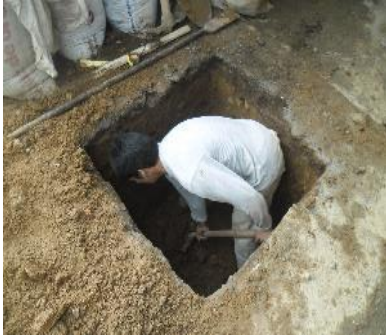
Figura 8. Excavación manual en material común hasta 2,5
