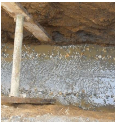
Figura 32. Entibado y apuntalado
