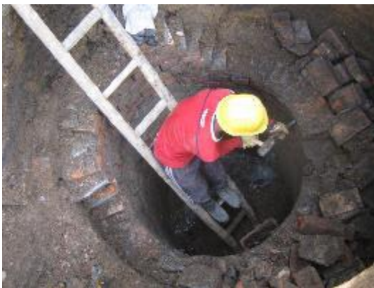
Figura 2 Demolición de cámara de inspección en ladrillo
