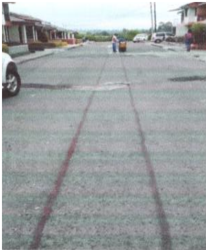
Figura 38. Localización y replanteo
