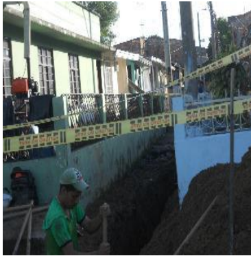
Figura 15. Excavación en material común
