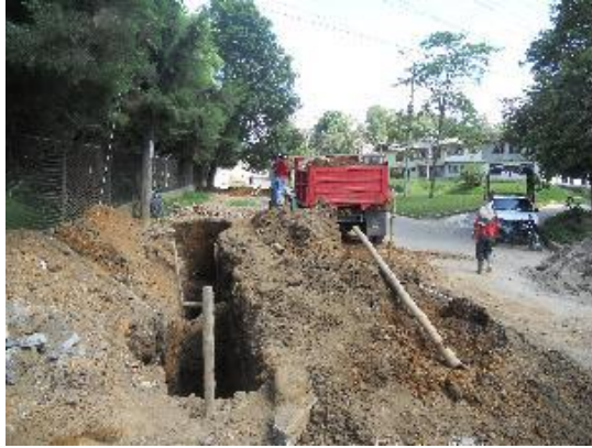
Figura 6. Retiro de sobrantes
