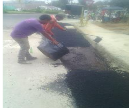
Figura 23. Colocación y compactación de mezcla asfáltica
