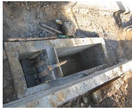
Figura 21 . Construcción de sumideros
