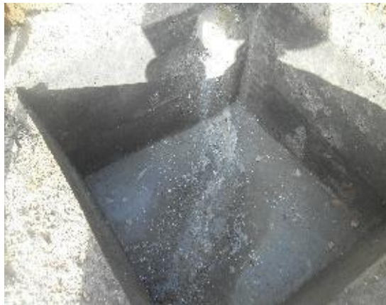
Figura 7 Construcción de cajas de distribución domiciliarias
