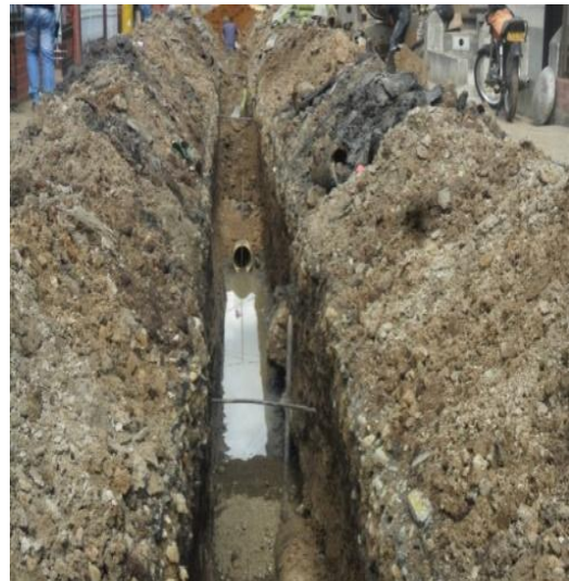
Figura 51. Suministro y colocación de tubería nueva.
