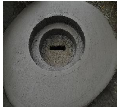
Figura 11. Construcción de brocales en concreto
