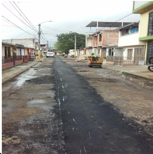
Figura 54. Verificación de espesor de capa asfáltica
