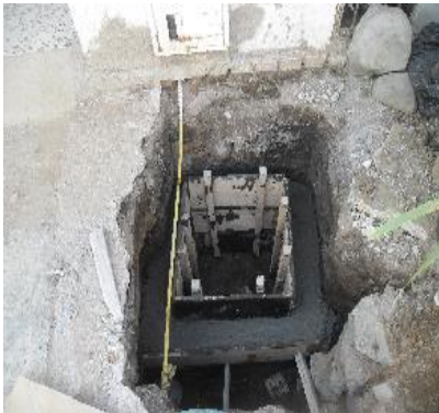
Figura 17. Construcción de cajas de distribución domiciliarias
