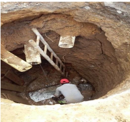
Figura 52. Construcción de cámara de inspección
