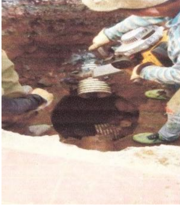
Figura 47. Construcción de de cámara de inspección
