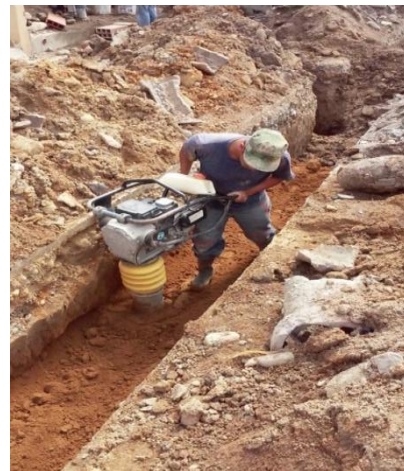
Figura 58. Relleno y compactación
