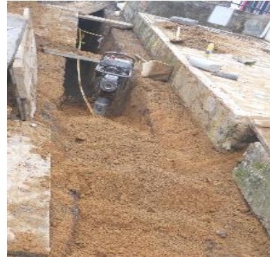
Figura 18. Relleno y compactación de zanjas
