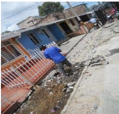
Figura 14. Demolición de andenes Figura 15. Demolición de cámaras
