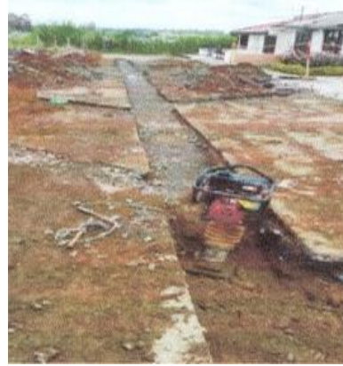
Figura 48. Relleno y compactación
