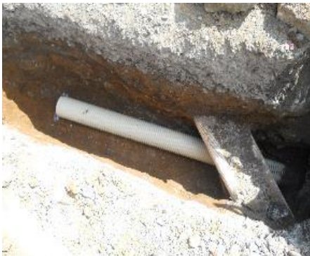
Figura 20. Instalación de tubería
