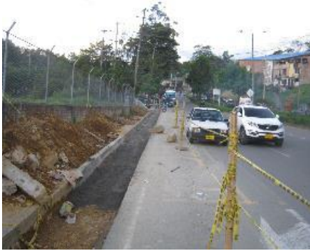
Figura 22. Construcción de sardineles en concreto
