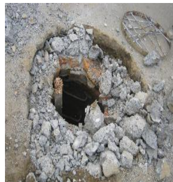
Figura 14. Demolición de andenes Figura 15. Demolición de cámaras
