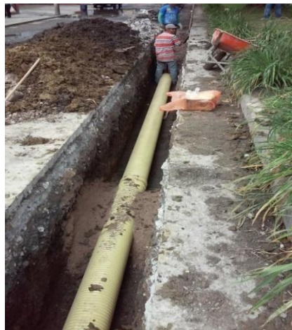
Figura 57. Instalación de tubería
