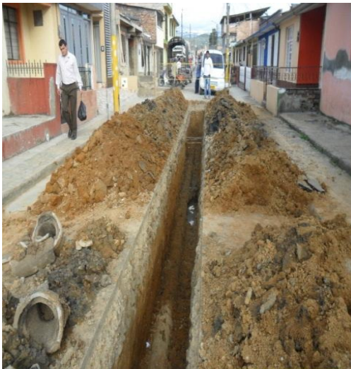
Figura 50. Retiro de tubería existente
