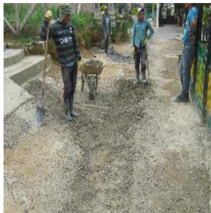
Figura 12. Reposición de pavimento existente
