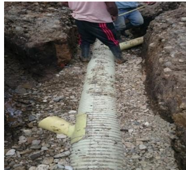
Figura 35. Instalación de tubería
