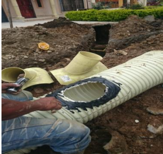
Figura 34. Instalación de Silla yee 12x6
