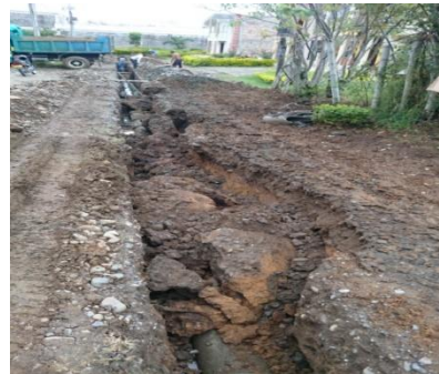
Figura 31. Excavación en material común hasta 2.5 m
