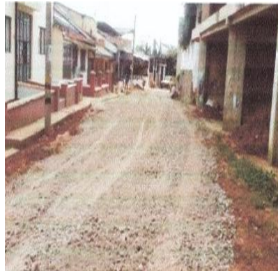
Figura 49. Colocación de Sub base
