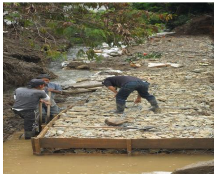
Figura 28. Construcción de gaviones
