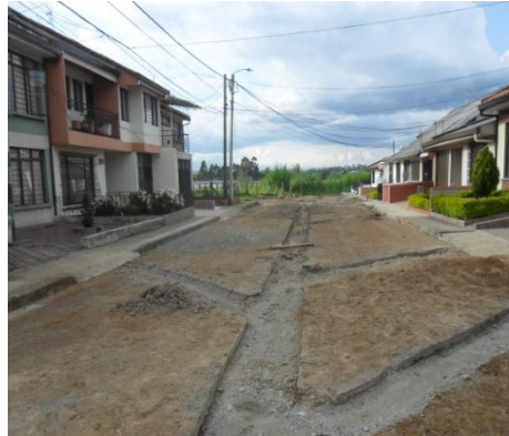
Figura 44. Instalacion de domiciliarias a 45°
