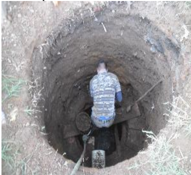
Figura 10. Construcción de cámara de de inspección.
