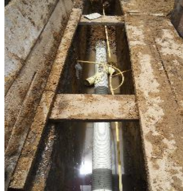
Figura 16. Instalación de tubería y sillas yee para acometidas domiciliarias
