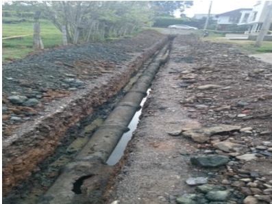
Figura 30. Excavación en conglomerado Hasta 2.5 m
