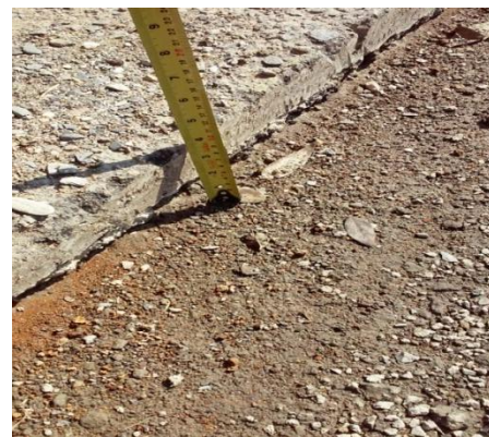
Figura 53. Verificación de espesor de capa asfáltica
