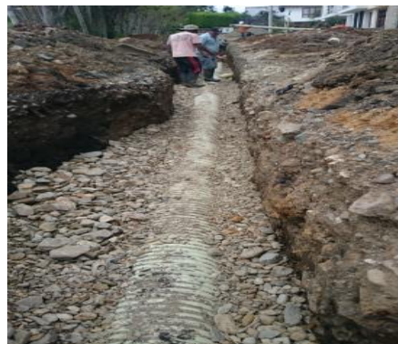
Figura 33. Colocación de material para filtro
