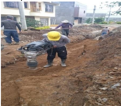
Figura 36. Relleno y Compactación
