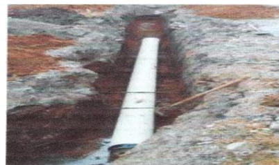
Figura 46. Suministro e instalación de tubería.
