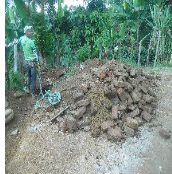
Figura 9. Demolición cámara de inspección en ladrillo
