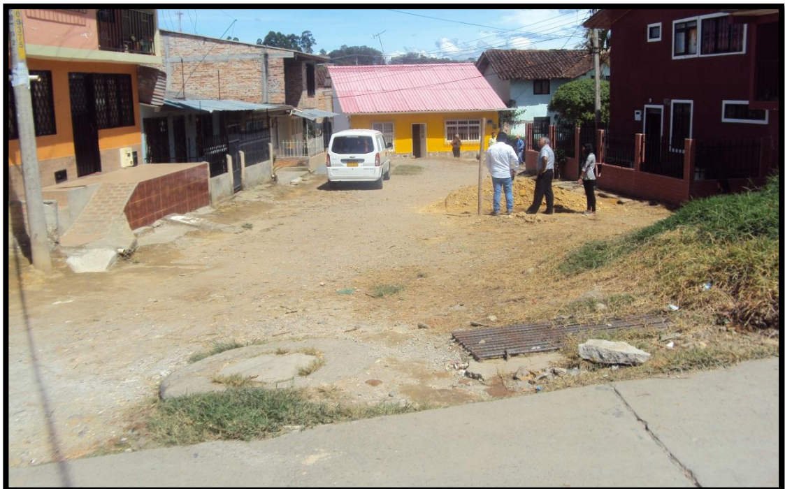
Figura No 27. Barrio Villa España.(Pavimento)
