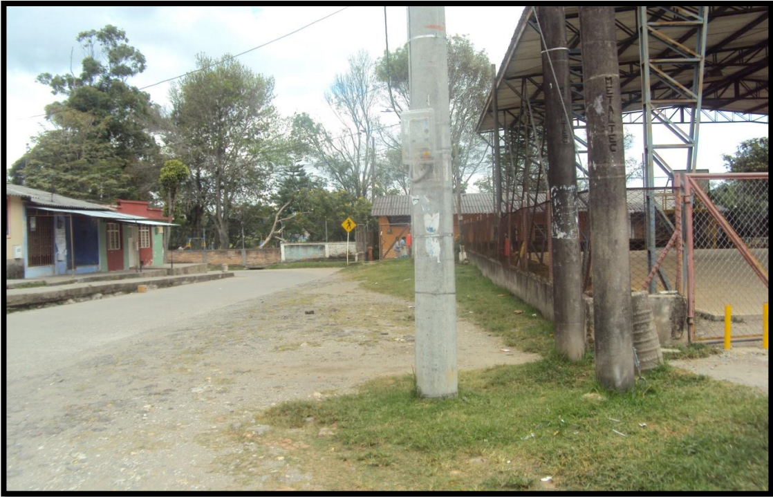
Figura No 34. Barrio San Antonio de Padua (Andenes y Sardineles)
