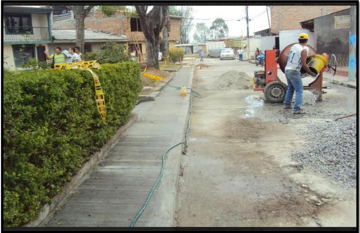
Figura No 46. Barrio Sindical 1 Etapa.
