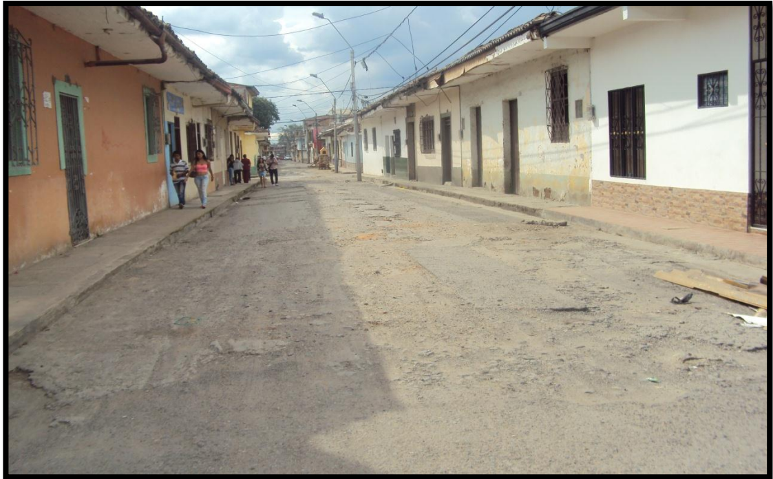
Figura No 14. Barrio El Empedrado.(Pavimentacion)
