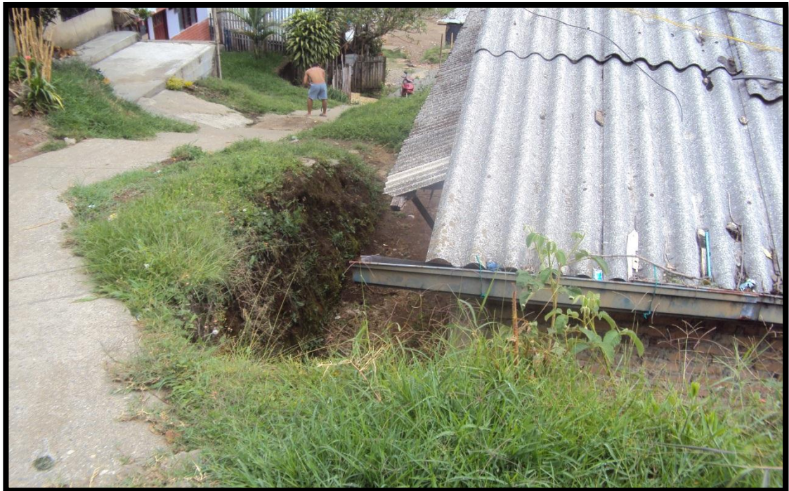
Figura No 18. Barrio Ls Paz Sur.(Muro de Contencion)
