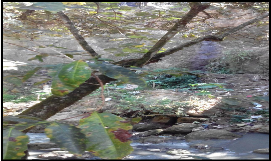
Figura No 32. Barrio La Sombrilla.(muro de contención)
