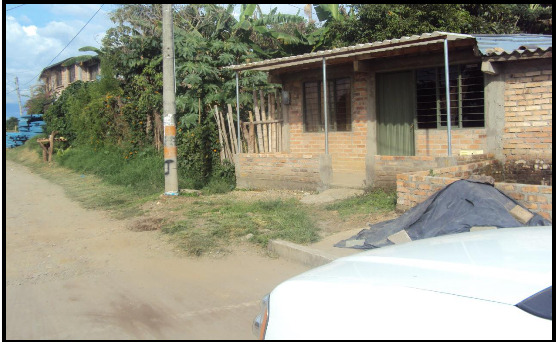
Figura No 6. Barrio El Uvo.(Pavimentacion)
