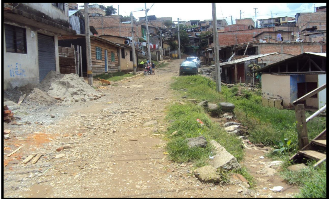
Figura No 28. Barrio Villa Garcia.(muros de contencion)
