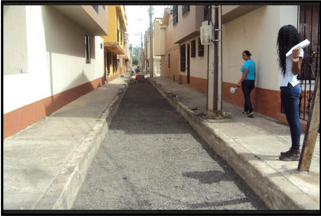
Figura No 49. Barrio San Antonio de Padua (Andenes y Sardineles)
