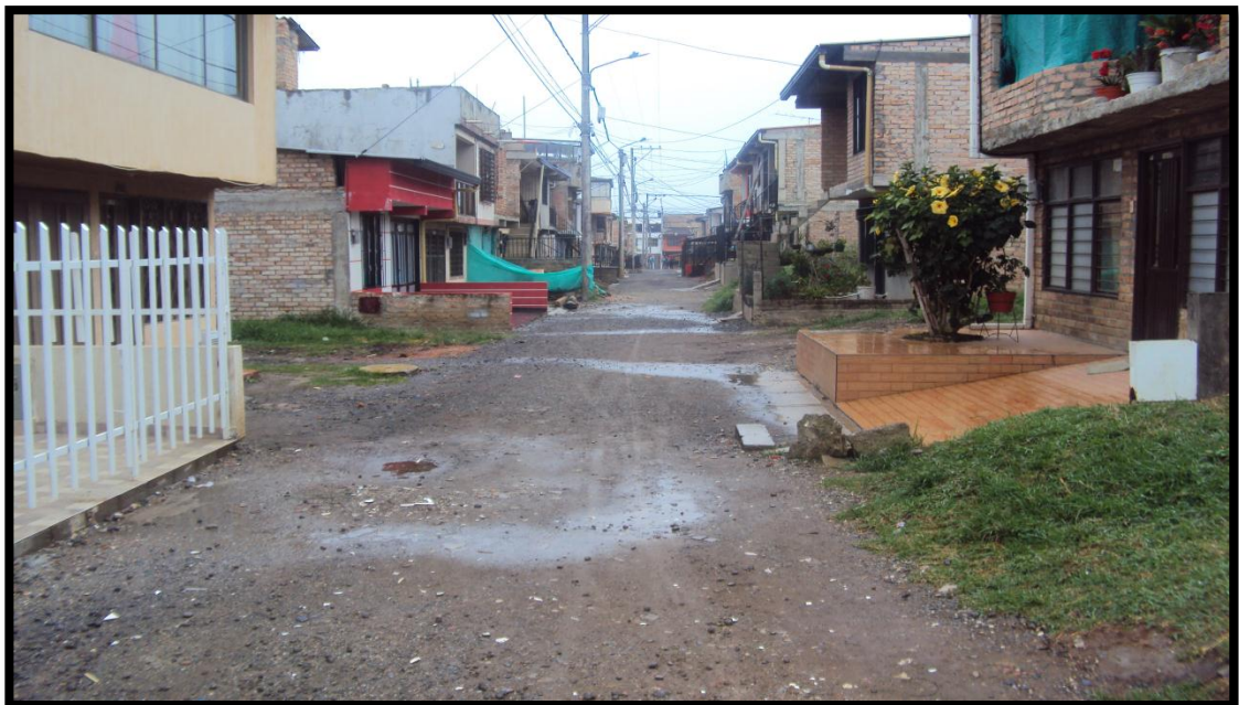
Figura No 7 Villa del Norte Fase A.(Pavimentacion)
