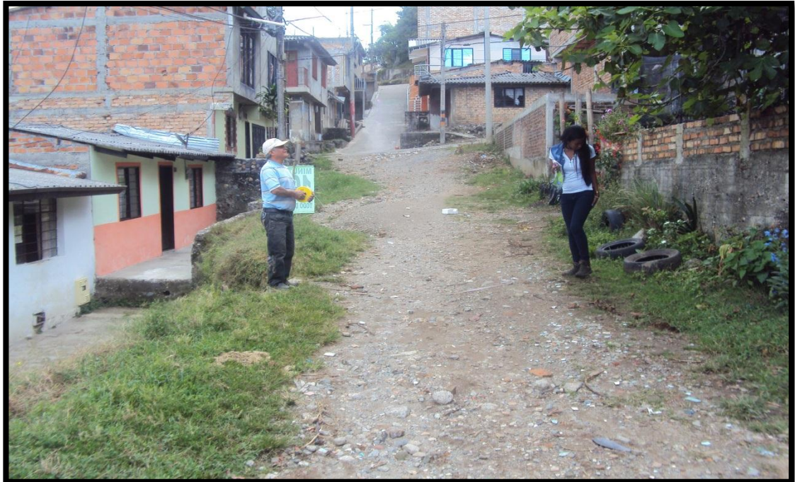
Figura No 26. Barrio Solidaridad.(muros de contencion)
