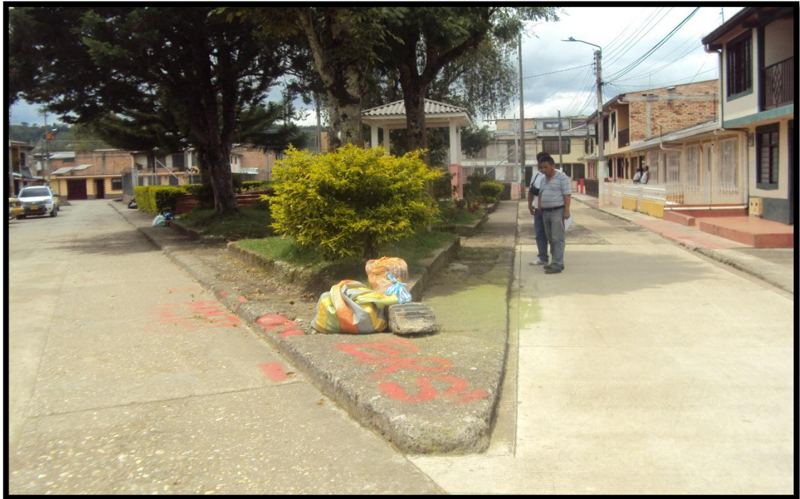
Figura No 23. Barrio Sindical 1 Etapa.(Andenes y Sardineles)
