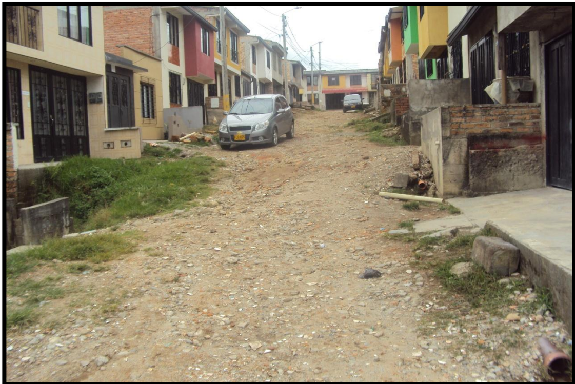
Figura No 31. Barrio Ciudad 200(Pavimento)
