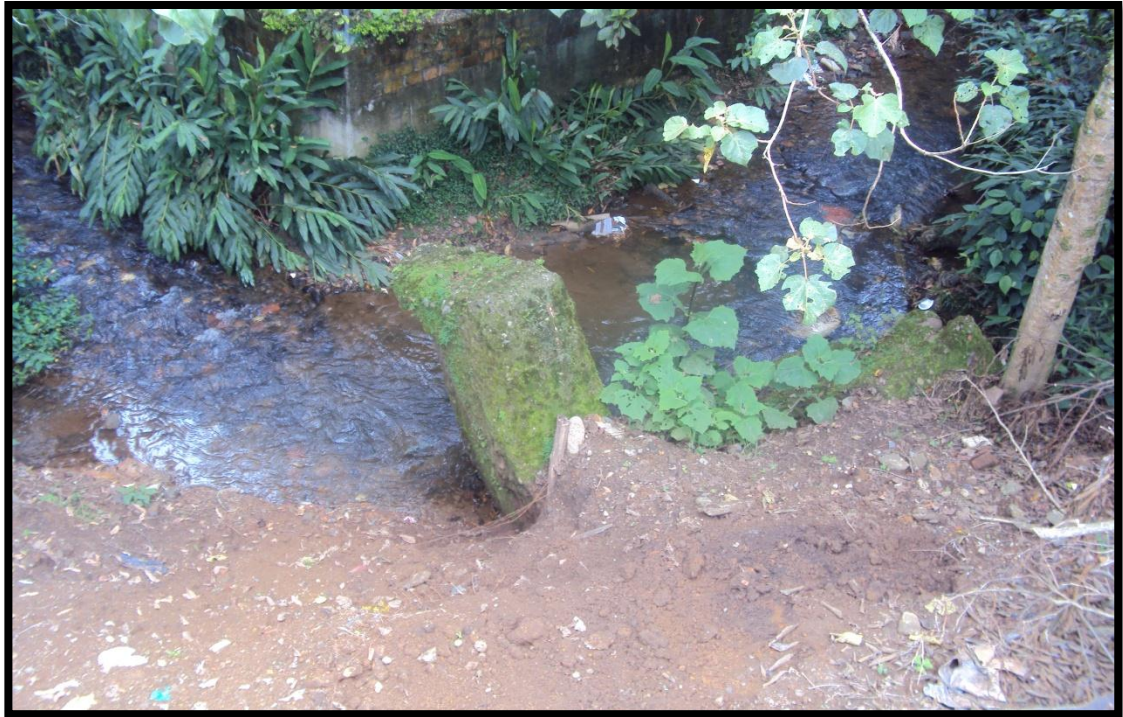
Figura No 12. Barrio Yambitara.(Demolición y construcción de Muro)
