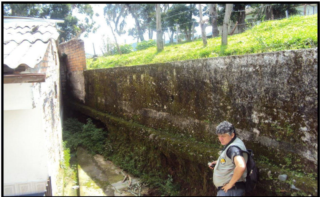
Figura No 19. Barrio Nueva Venecia(Muro de Contencion)
