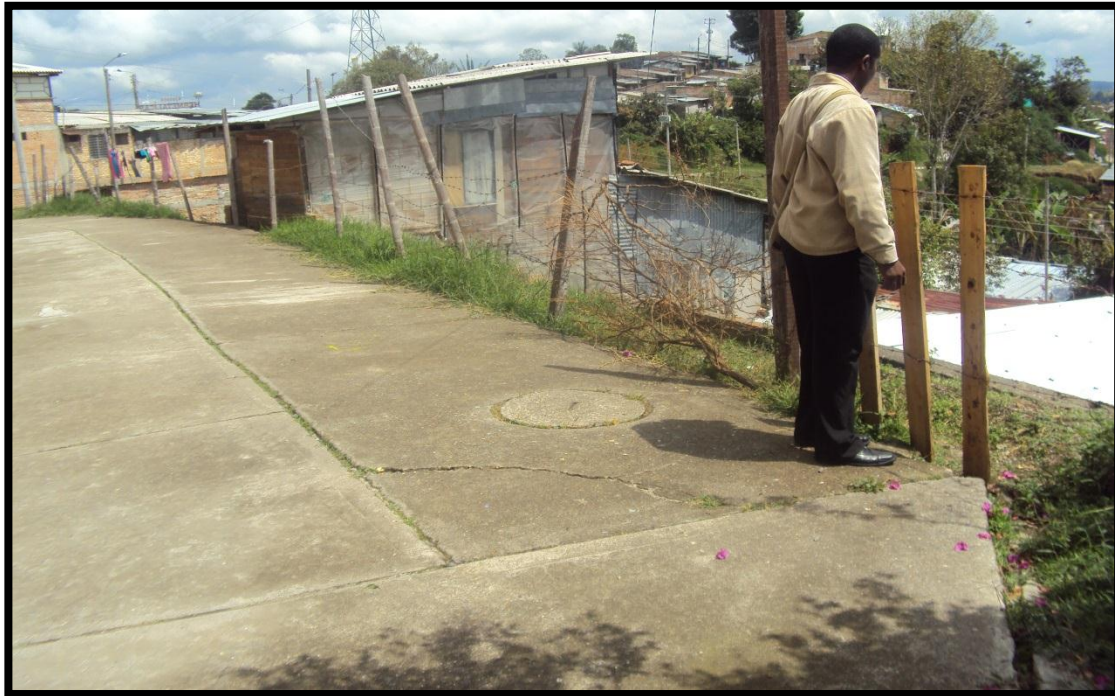
Figura No 25. Barrio Las Veraneras (Andenes)
