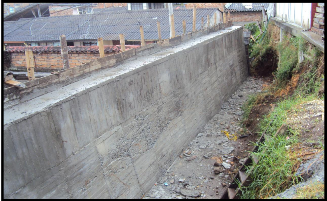
Figura No 10. Jose Antioio Galan.(Muro de contencion)
