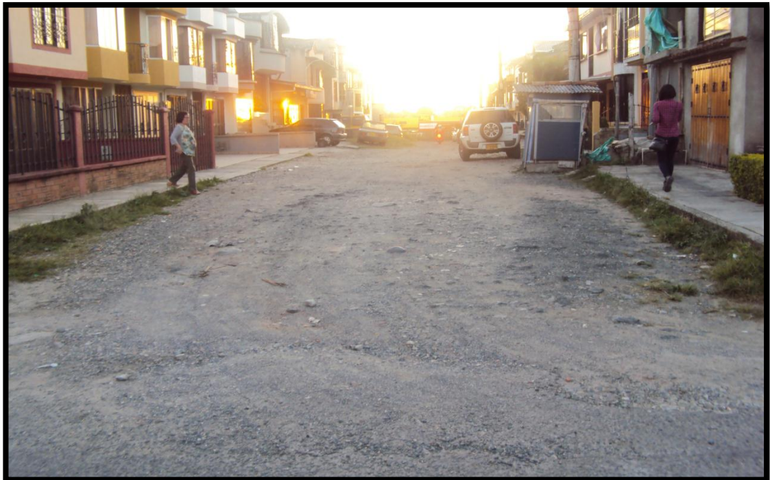
Figura No 5. Santa Clara Fancal.(Pavimentacion)
