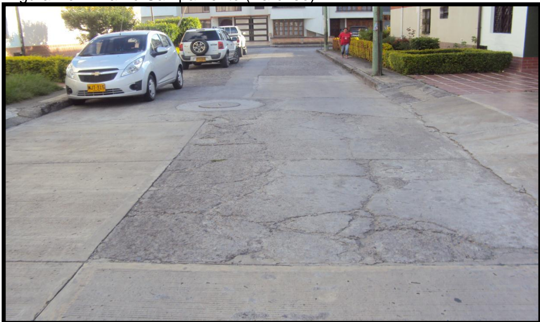
Figura No 3. Barrio Los Rosales.(Pavimentacion)
