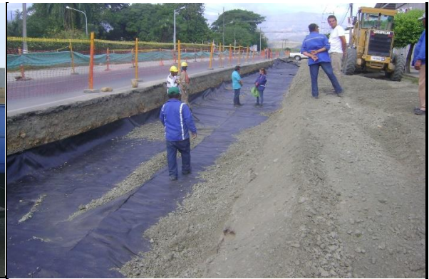
II lado Izq. Contratista instalando geotextil.
