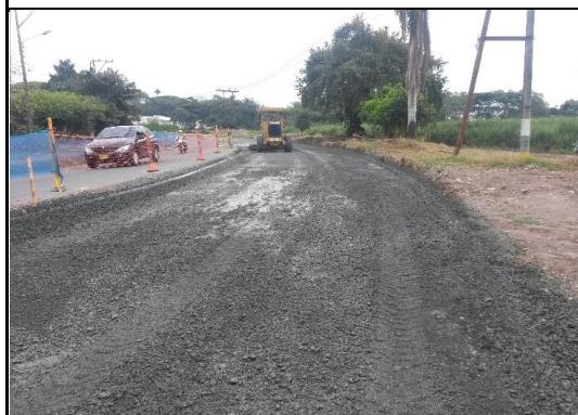
Lad. Der. K85+800 A K85+930 cereo compactación base capa 1 de 20 cms.
