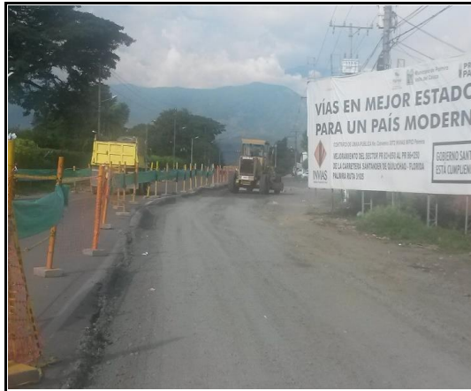
Lad. Izq. K86+200 A K86+300 suministro riego base capa 1 de 20 cms.
