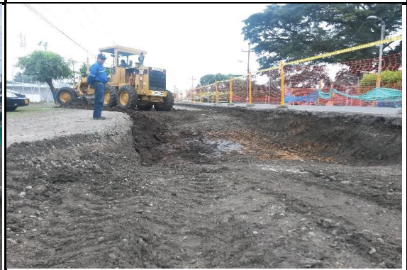
Izq. K86+100 A K86+200 corrigiendo fallo
