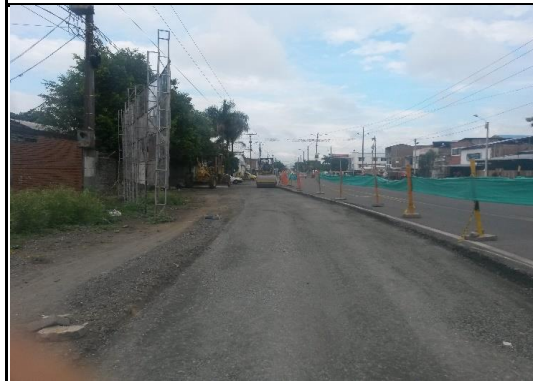
Izq. K86+200 A K86+300 compactación cereo base capa 1 de 20 cms.
