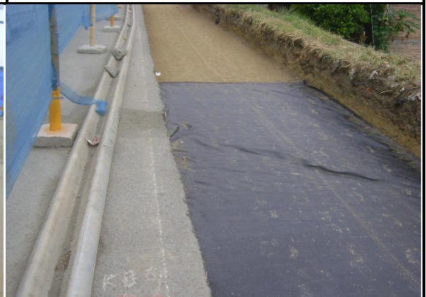
tramo II lado Izq. Contratista instalando geotextil.
