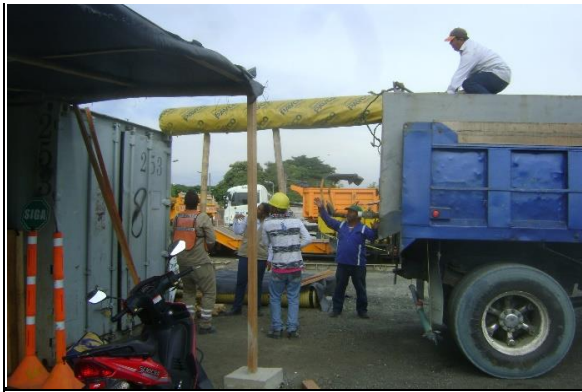
acarreo de geotextil a sitio de obra
