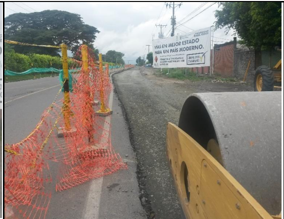
Lad. Izq. K86+200 A K86+300 compactación cereo base capa 1 de 20 cms.
