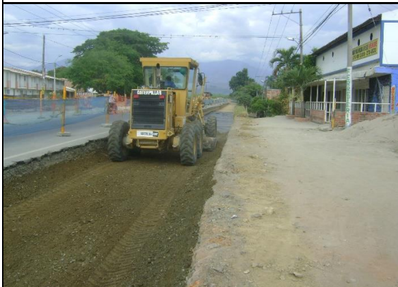
primera capa de mejoramiento, Tramo II lado Izq. K86+100 A K86+200
