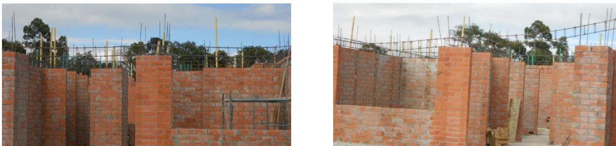
FIGURA. 42 ARMADO DE HIERRO VIGAS DE AMARRE
