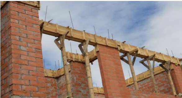
FIGURA. 44 FORMALETAS VIGAS DE AMARRE
