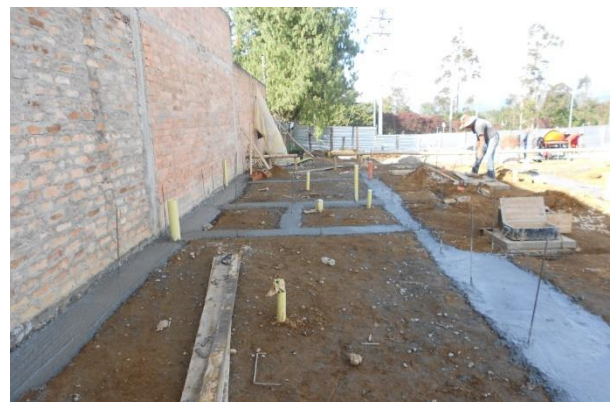
FIGURA. 25 FUNDICION VIGA DE CIMENTACION
