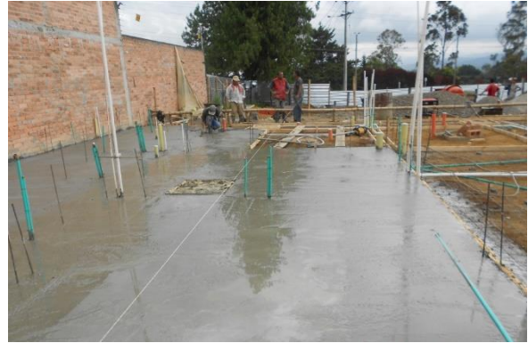
FIGURA. 29 FUNDICION DE CONTRA-PISO
