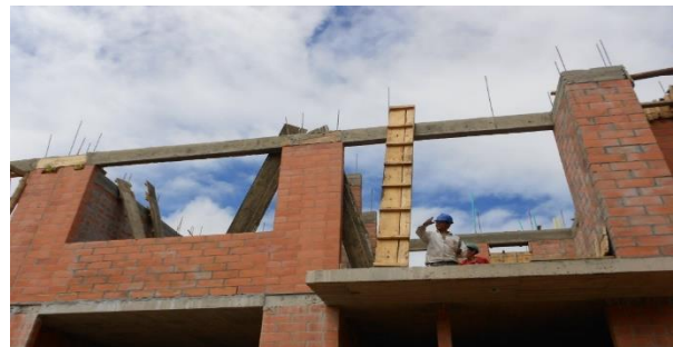
FIGURA. 45 DESENCOFRADO VIGAS DE AMARRE
