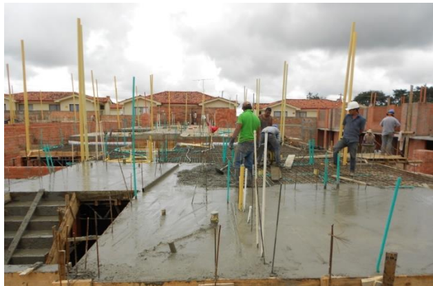
FIGURA. 38 FUNDICION LOSA DE ENTREPISO
