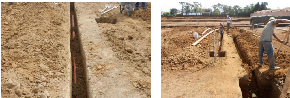
FIGURA. 14 EXCAVACION TUBERIAS SANITARIAS Y AGUAS LLUVIAS
