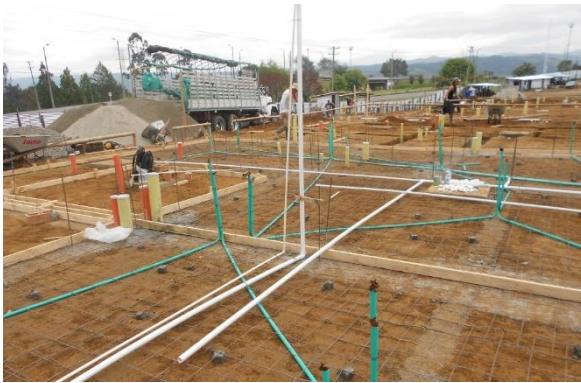
FIGURA. 28 INSTALACION DE TUBERIAS SANITARIAS, ELECTRICAS
