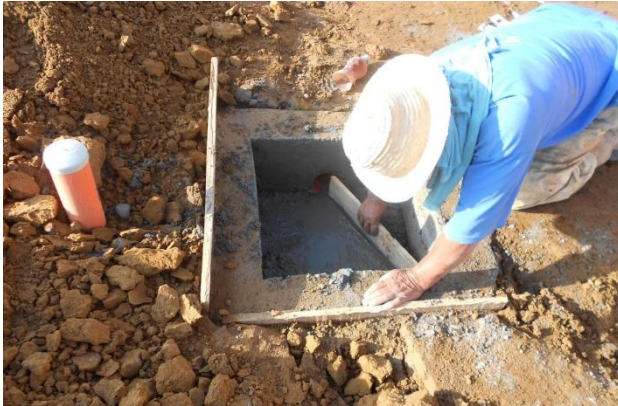
FIGURA. 15 CAJA DE INSPECCION TUBERIAS SANITARIAS
