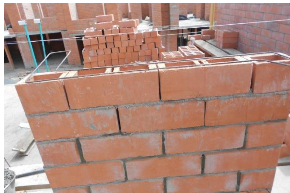
FIGURA. 32 REFUERZO HORIZONTAL MUROS
