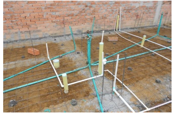
FIGURA. 28 INSTALACION DE TUBERIAS SANITARIAS, ELECTRICAS
