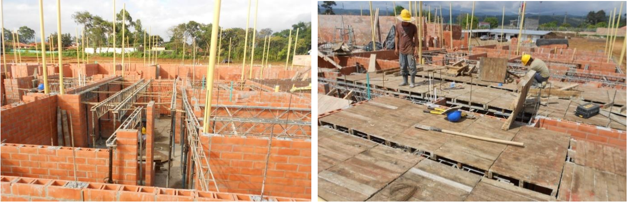
FIGURA. 33 ENCOFRADO LOSA DE ENTREPISO
