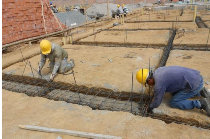
FIGURA. 21 INSTALACION DE DOVELAS VIGA DE CIMENTACION
