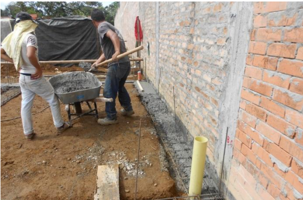
FIGURA. 22 FUNDICION VIGA DE CIMENTACION
