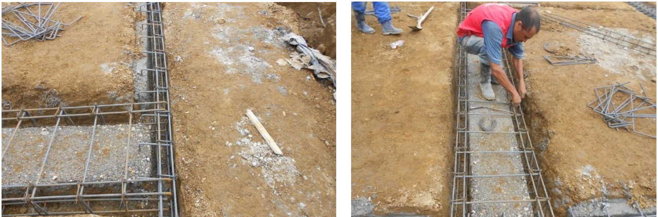
FIGURA. 18 ARMADO DE HIERRO VIGAS DE CIMENTACION
