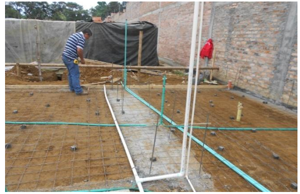
FIGURA. 27 INSTALACION DE MALLA Y FORMAleta PARA FUNDIR CONTRA-PISO
