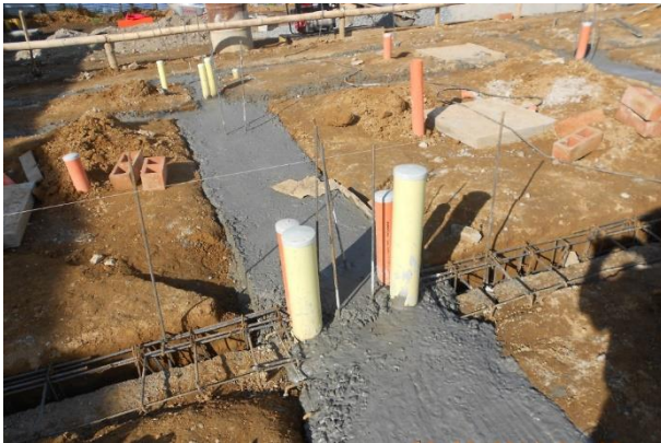
FIGURA. 24 FUNDICION VIGA DE CIMENTACION
