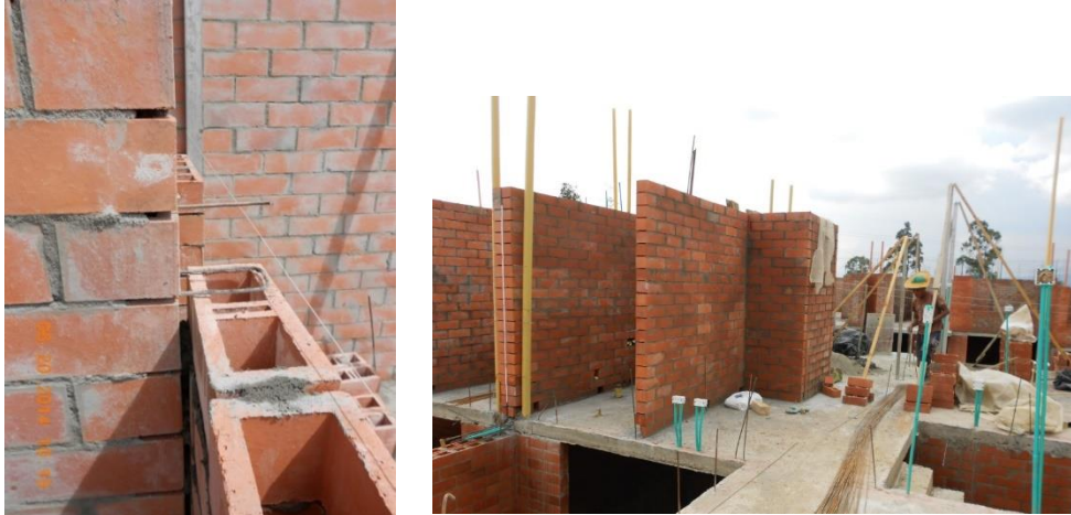
FIGURA. 41 REFUERZO HORIZONTAL Y MUROS SEGUNDO PISO
