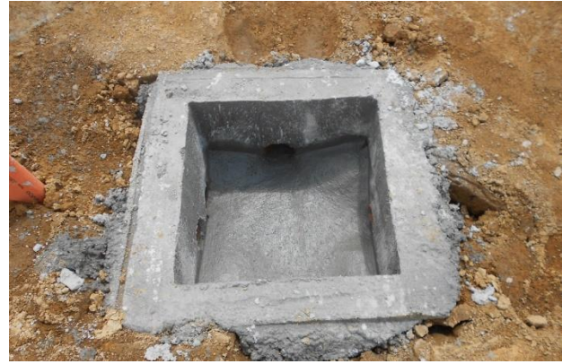
FIGURA. 15 CAJA DE INSPECCION TUBERIAS SANITARIAS
