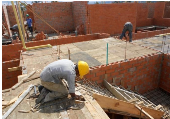
FIGURA. 39 ACERO DE REFUERZO ESCALERAS
