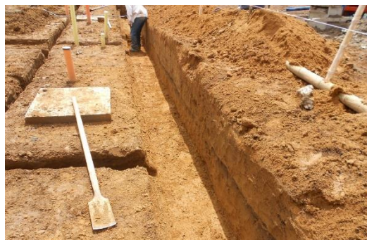
FIGURA. 16 EXCAVACION VIGAS DE CIMENTACION
