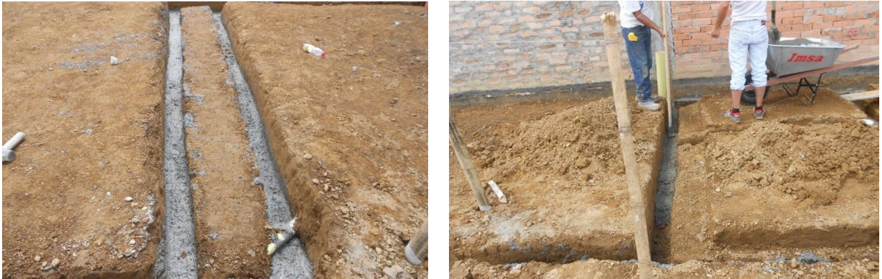
FIGURA. 17 SOLADO DE PROTECCION VIGAS DE CIMENTACION
