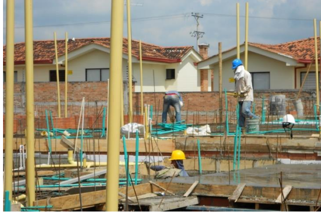
FIGURA. 37 INSTALACION TUBERIAS ELECTRICAS
