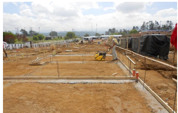
FIGURA. 26 NIVELACION TERRENO PARA FUNDIR CONTRA-PISO
