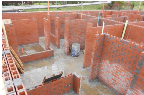
FIGURA. 31 MUROS PRIMER PISO
