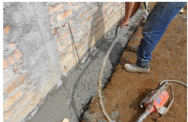
FIGURA. 23 VIBRADO VIGA DE CIMENTACION
