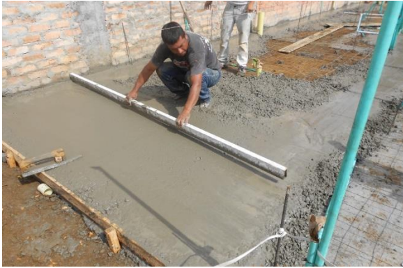
FIGURA. 29 FUNDICION DE CONTRA-PISO
