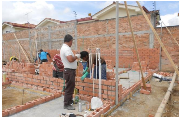
FIGURA. 30 INSTALACION TUBERIAS HIDRAULICAS
