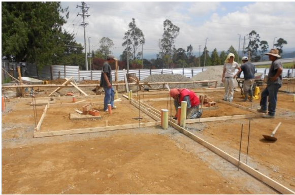
FIGURA. 27 INSTALACION DE MALLA Y FORMAleta PARA FUNDIR CONTRA-PISO
