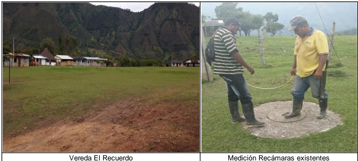
Imagen 21. Replanteo ampliación sistema de alcantarillado El Recuerdo (Fuente: Autoría propia)
