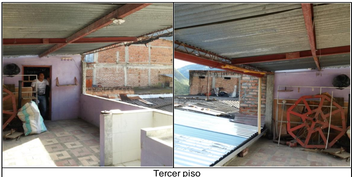
Imagen 9. Espacio disponible para la construcción del cuarto de Archivo (Fuente: Autoría propia)
