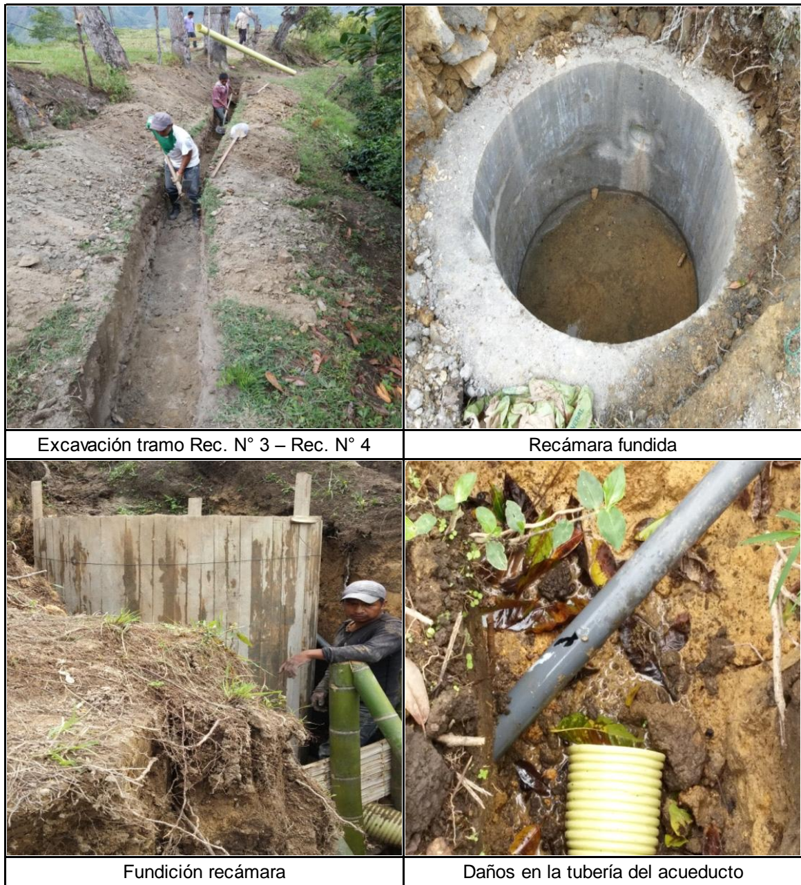
Imagen 19. Avance de obra (Fuente: Autoría propia)
