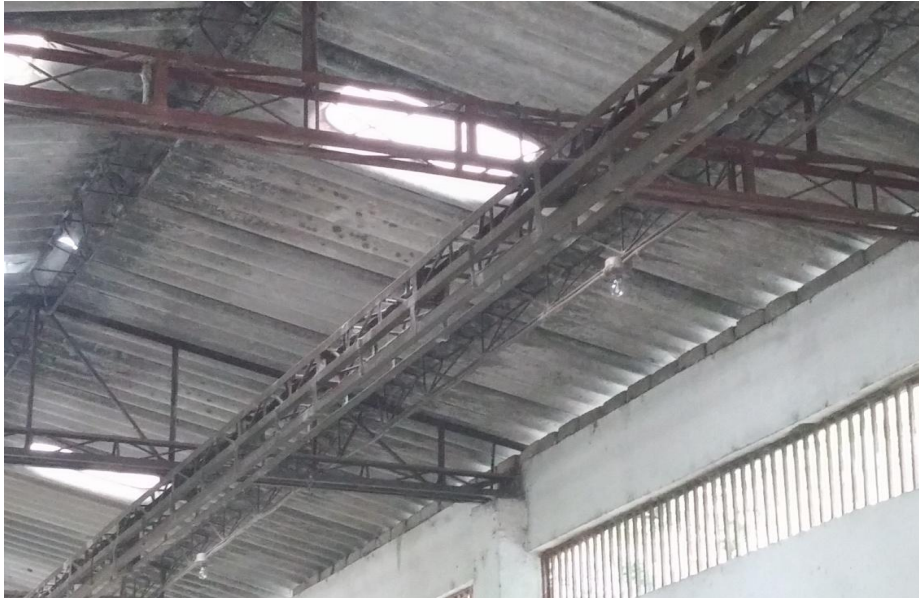
Imagen 6. Riel aéreo no apto para el proceso de sacrificio (Fuente: Autoría propia)
