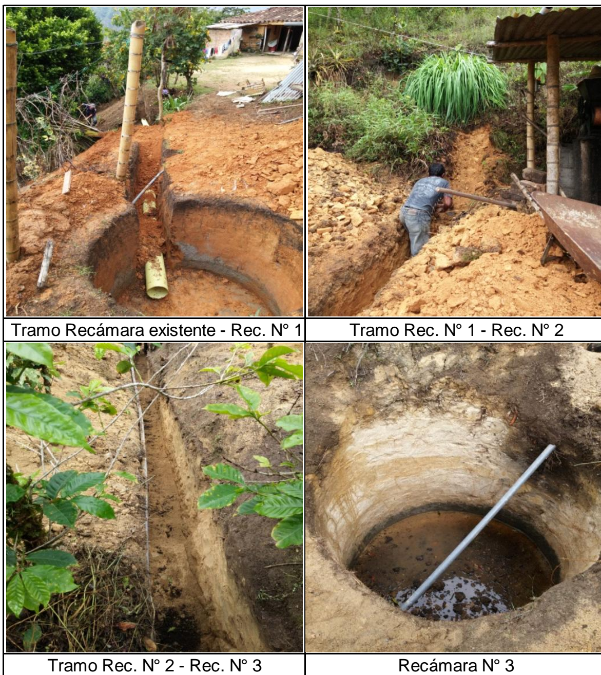
Imagen 18. Supervisión de excavación (Fuente: Autoría propia)
