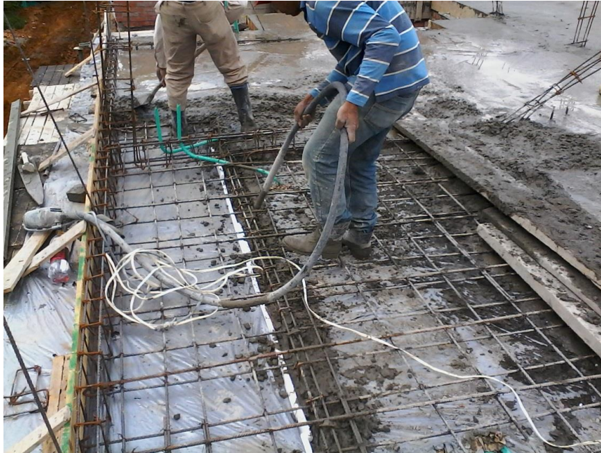
Figura 19. Fundición de losa de entrepiso
