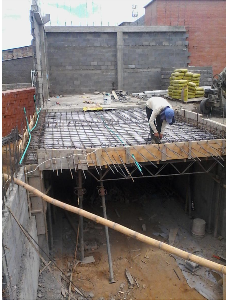
Figura 37. Construcción del Local Comercial
