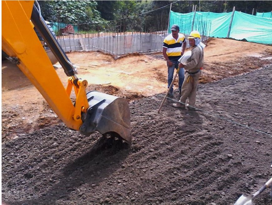
Figura 24. Conformación de la estructura de subbase
