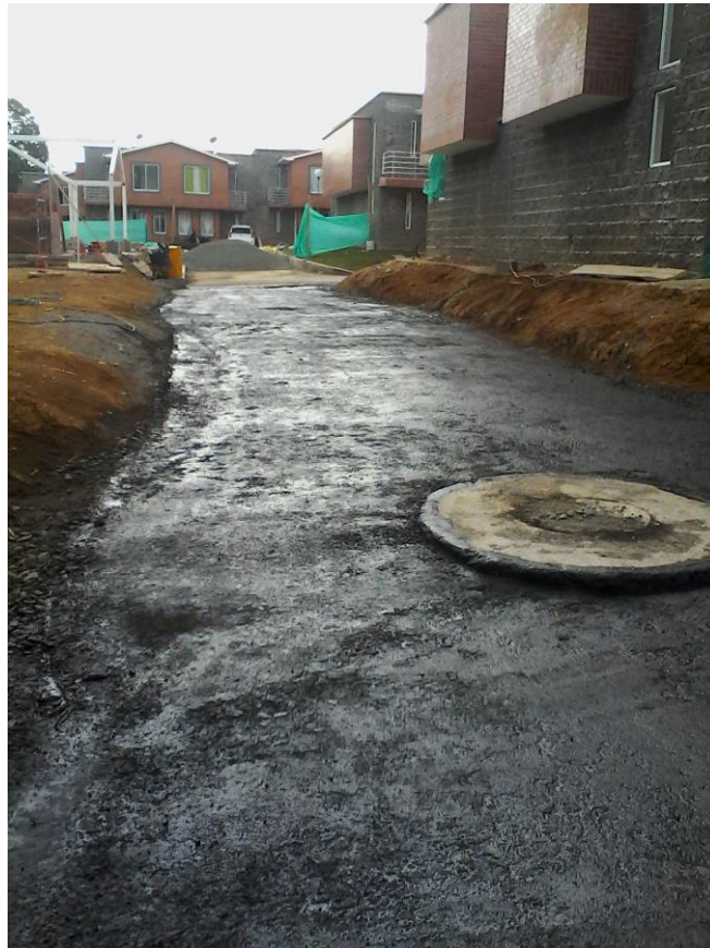
Figura 28. Imprimación Tramo de vía junto a casas 107 y 108
