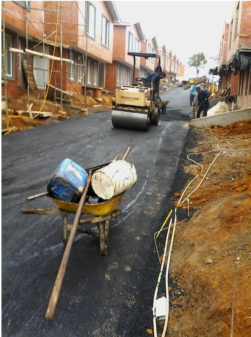
Figura 26. Compactado de la carpeta asfáltica
