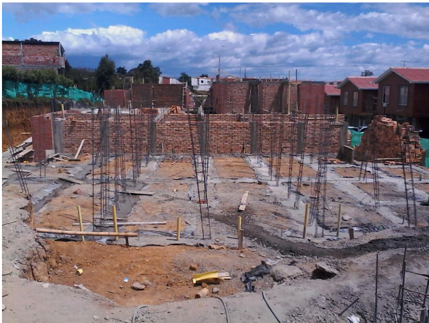
Figura 12. Cimentación en concreto.
