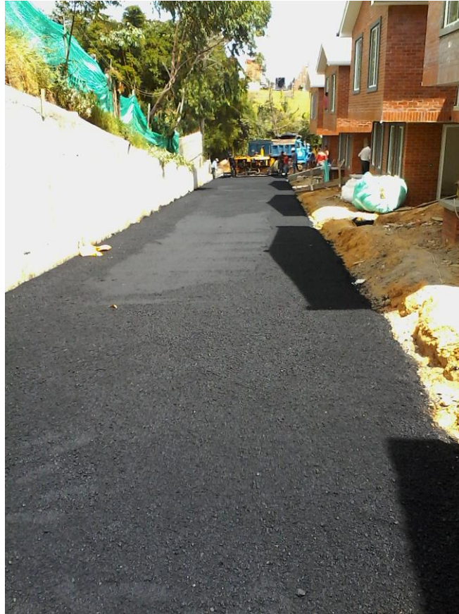
Figura 29. Pavimentación vía junto al muro de contención
