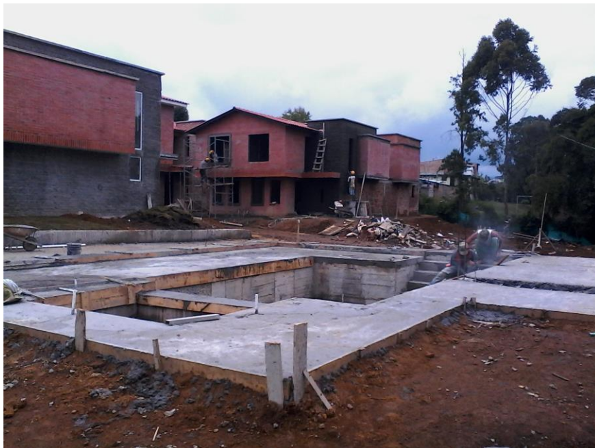
Figura 36. Piscina en obra negra
