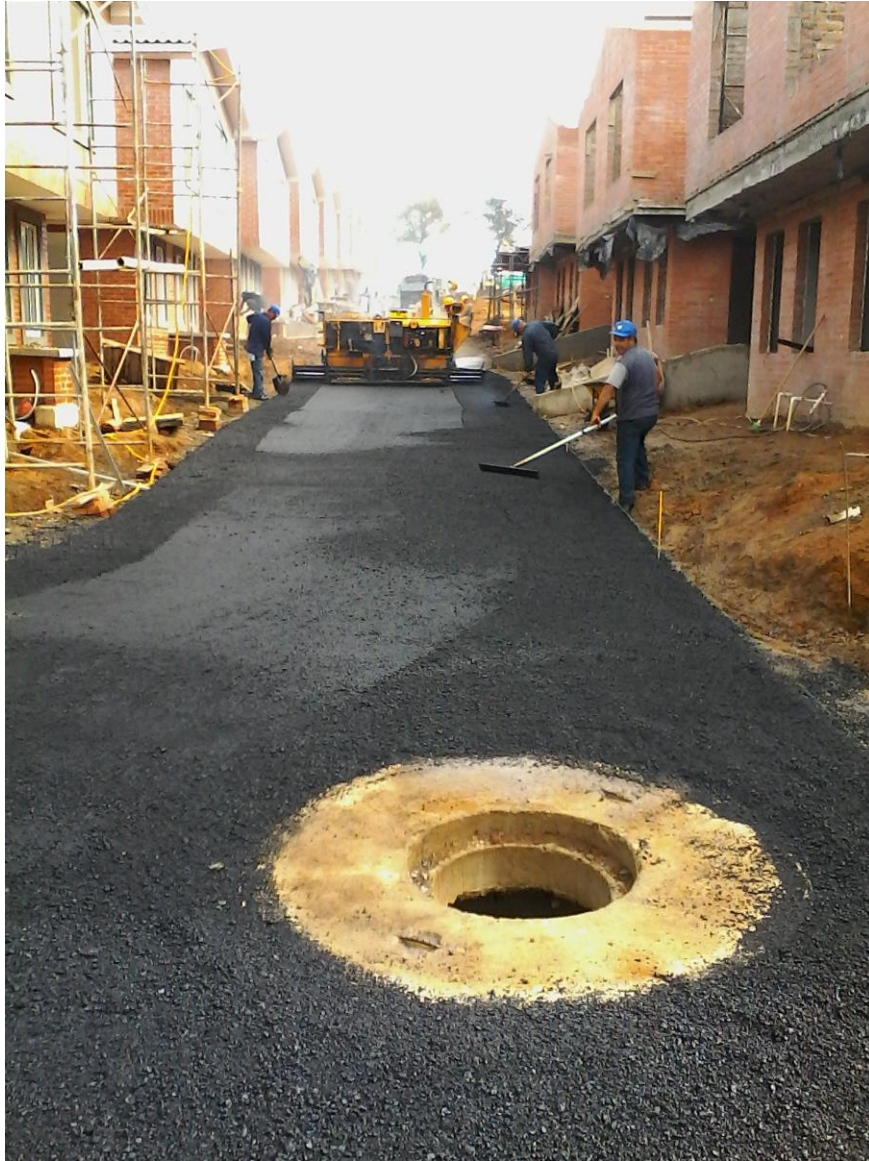
Figura 25. Pavimentación del tramo de vía
