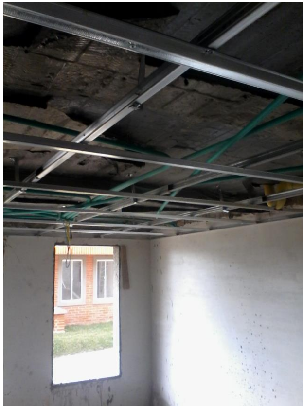
Figura 31. Vivienda estucada con estructura del cielo falso instalada
