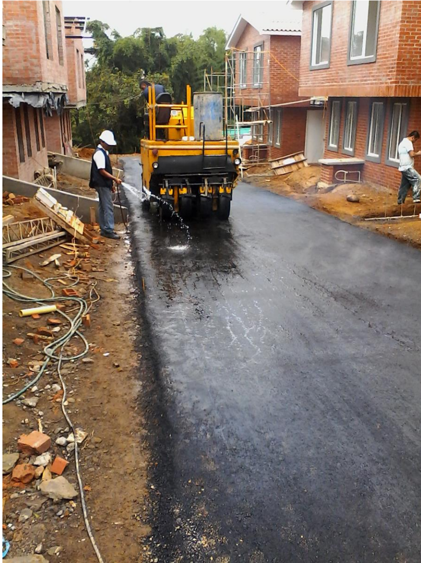
Figura 27. Sellado de la carpeta asfáltica
