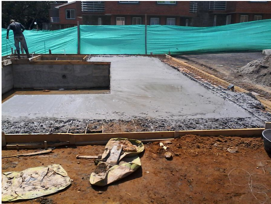
Figura 35. Fundición de Playa y Anden de la Piscina
