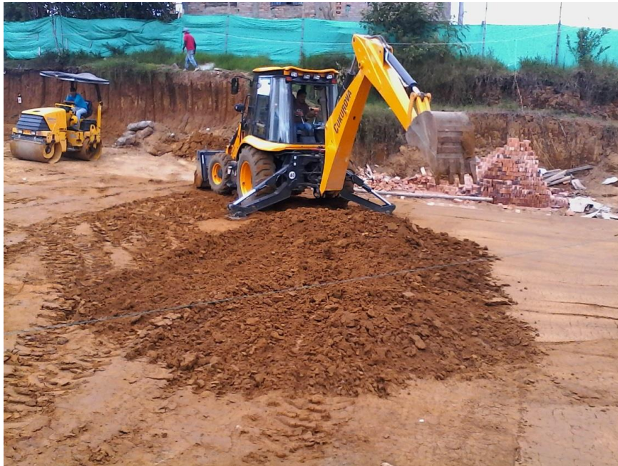
Figura 8. Conformación de terraza con retroexcavadora
