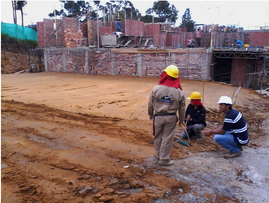
Figura 7. Determinación de nivel de terraza con nivel de manguera
