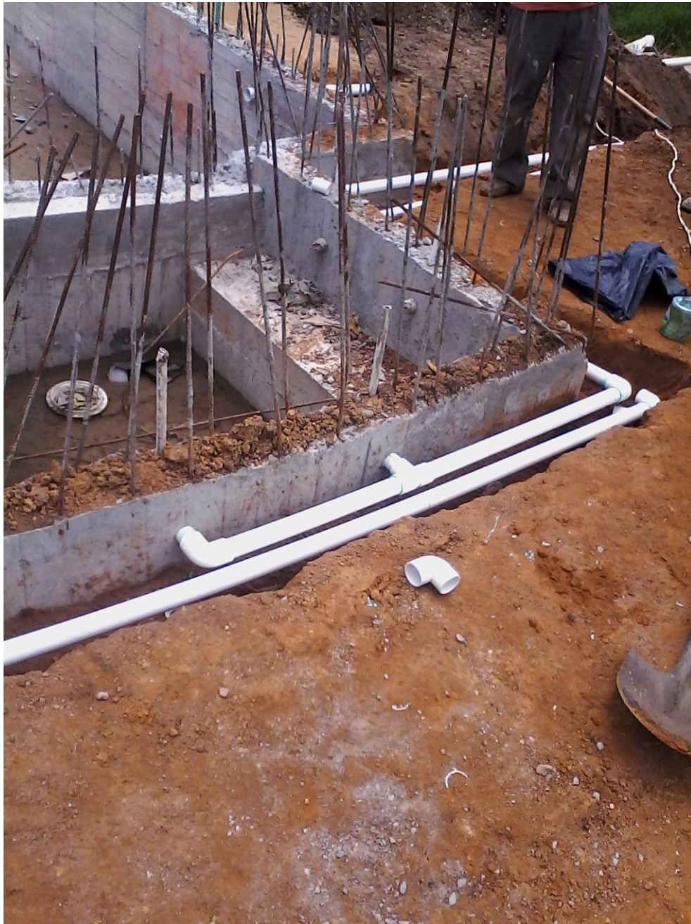
Figura 34. Instalación de la tubería en el Jacuzzi
