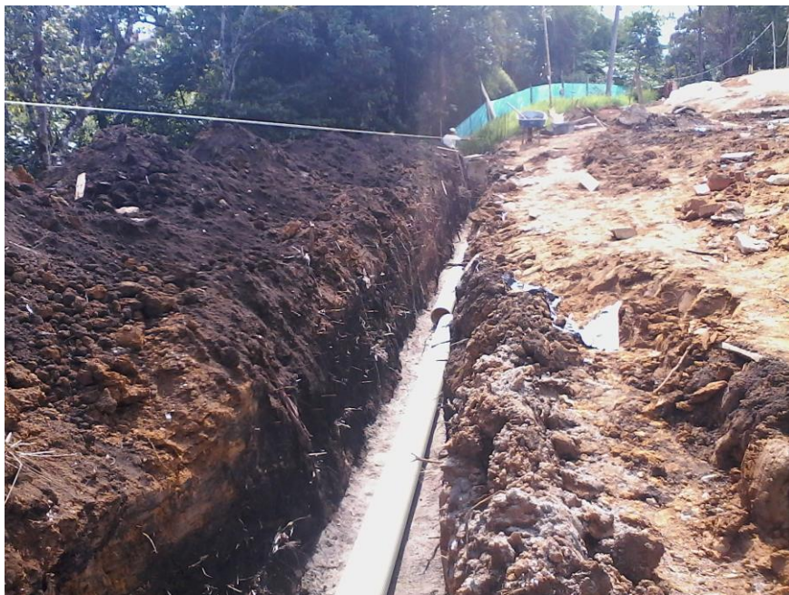
Figura 41. Instalación de la tubería sanitaria
