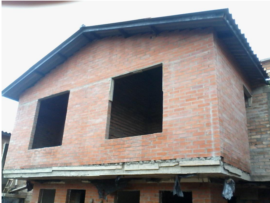
Figura 15. Mampostería estructural a la vista
