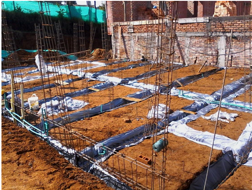
Figura 11. Cimentación antes de la fundición
