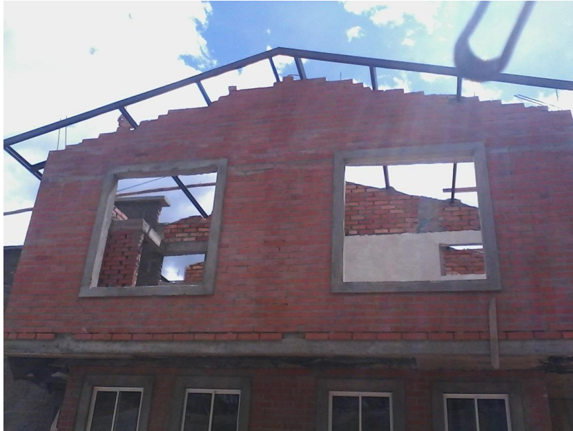
Figura 22. Vivienda con estructura de perlines instalada.
