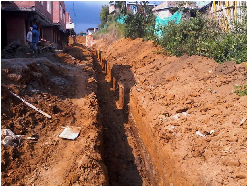
Figura 40. Excavación para instalar tuberías
