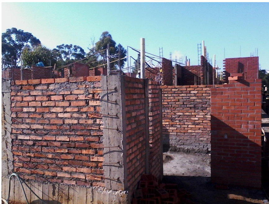
Figura 13. Muros en mampostería común
