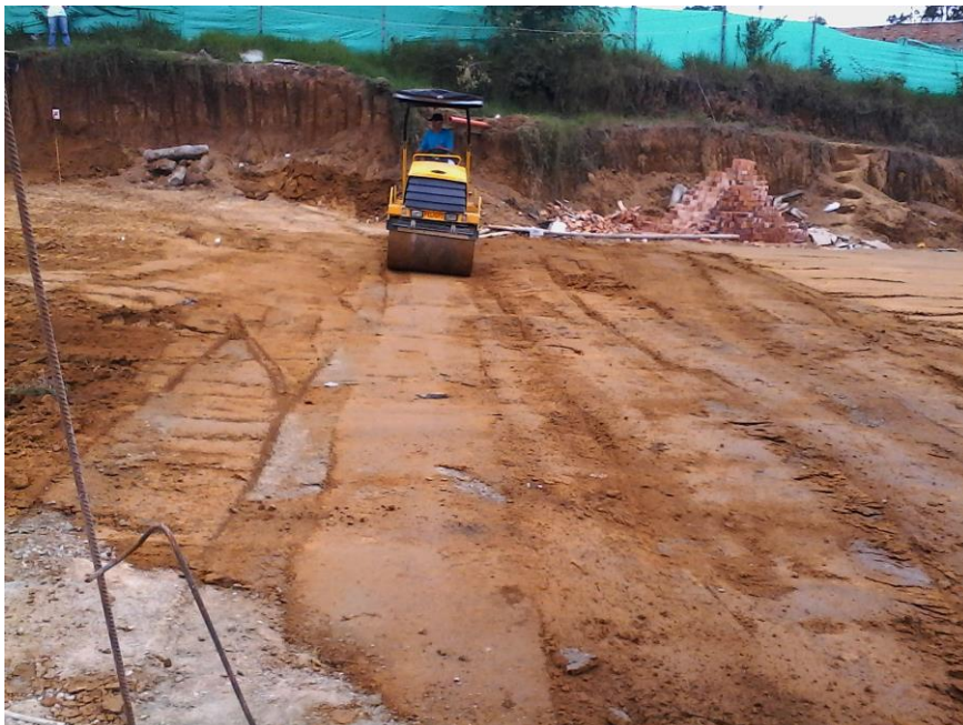
Figura 9. Compactación de terraza con vibro-compactador
