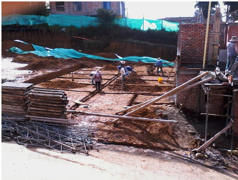
Figura 10. Excavación a mano para cimentación
