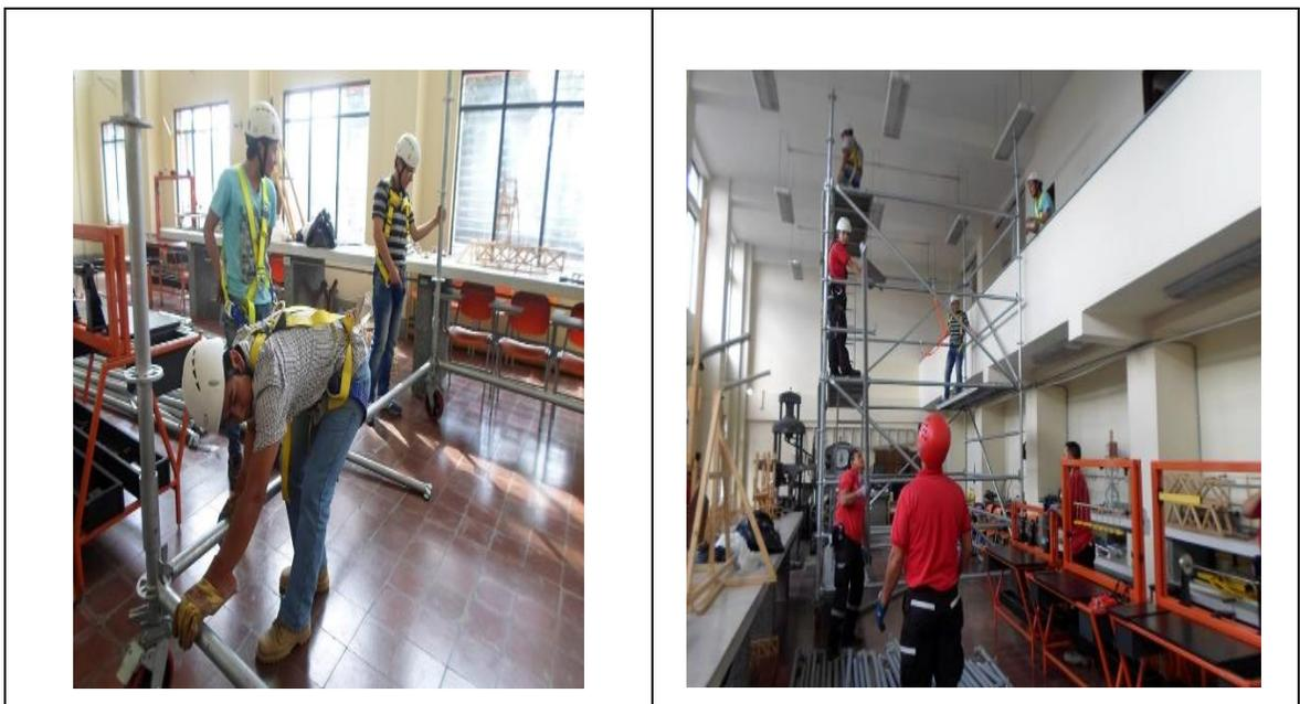
Figura 28. Montaje de andamios utilizados en el laboratorio de estructuras – Fuente: Propia de la investigación.
