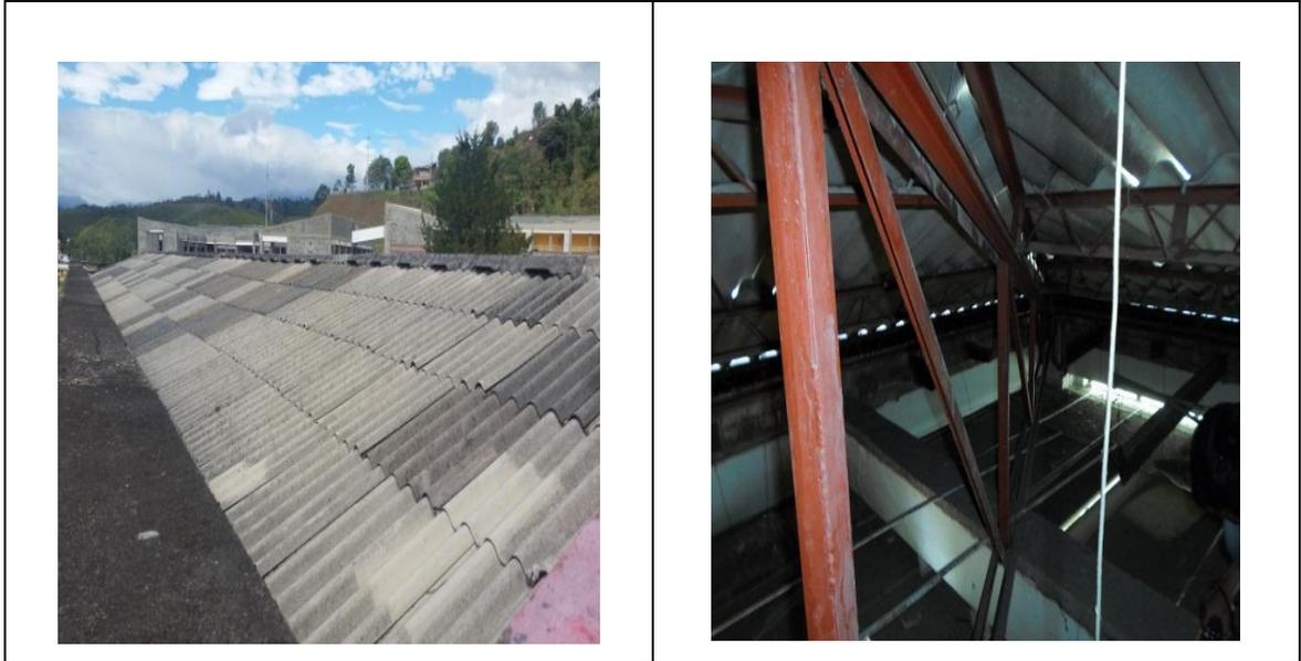
Figura 9. Cubierta del edificio en hojas onduladas de asbesto cemento apoyada sobre una cercha metálica – Fuente: Propia de la investigación.
