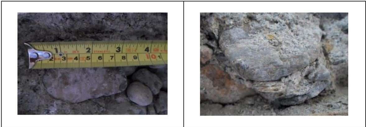
Figura 13. Presencia de sobretamaños en el concreto que conforma los elementos estructurales del edificio – Fuente: Propia de la investigación.
