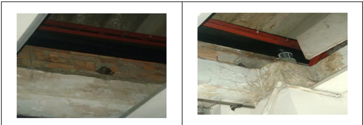
Figura 14. Humedad sobre culatas perimetrales, debido a fugas en canales y/o bajantes o a la falta de mantenimiento periódico de esta clase de elementos – Fuente: Propia de la investigación.
