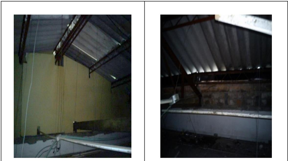
Figura 10. Culata de ladrillo macizo de arcilla que sirve de soporte a la estructura metálica de la cubierta – Fuente: Propia de la investigación.
