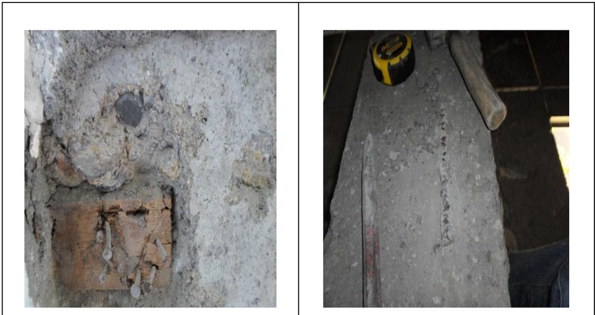
Figura 12. Deficiente proceso constructivo de la edificación – Fuente: Propia de la investigación.
