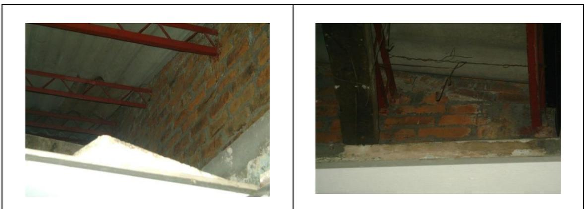
Figura 15. Culata perimetral de ladrillo macizo de arcilla a nivel de cubierta sin confinar - Fuente: Propia de la investigación.
