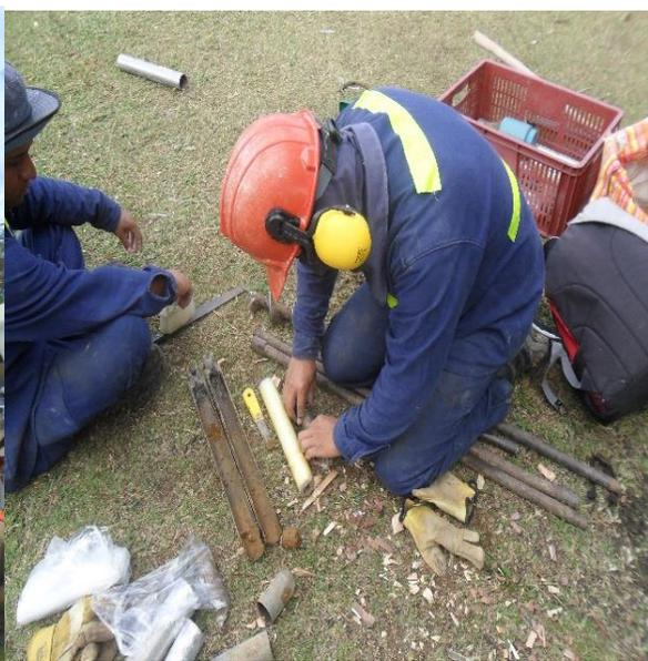
En segundo lugar, se realiza la localización y replanteo del sitio, tomando una medida de 20 mts por 20 mts, haciendo ocho excavaciones cuadradas de 1,20 metros, con una profundidad de 1 metro.
