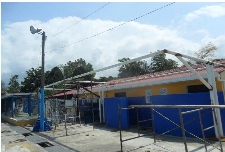
En las áreas de primeros auxilios y las bodegas de herramientas y químicos se elabora la construcción de estructuras metálicas y colocación de la teja en PVC. Posteriormente se construyen alfajías según su diseño.
