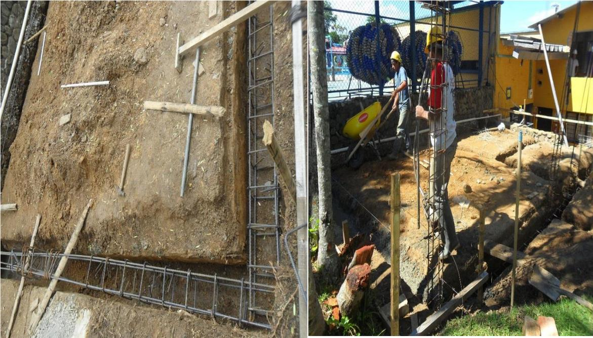
Después se procede a levantar muros con ladrillo, luego de elaborar el concreto a usar, este se colocó en las respectivas columnetas, donde se encuentran los castillos previamente elaboradas.
