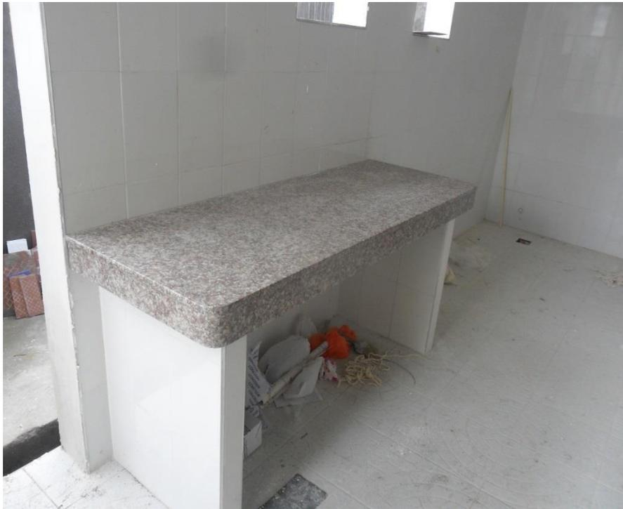
Se realiza la construcción de los mesones en concreto, posteriormente se coloca el grano natural con sus lavamanos y sanitarios, se procede a instalar la división de aluminio y respectivas ventanas.
