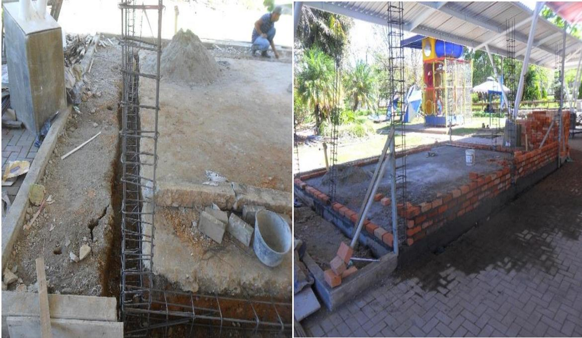
Se arma y se coloca la formaleta por la viga cimentación, realizando la fundición de la viga con concreto estructural 1:2:3 y se nivela. Al otro día se retira la formaleta y se hace acometidas hidráulicas y eléctricas.
