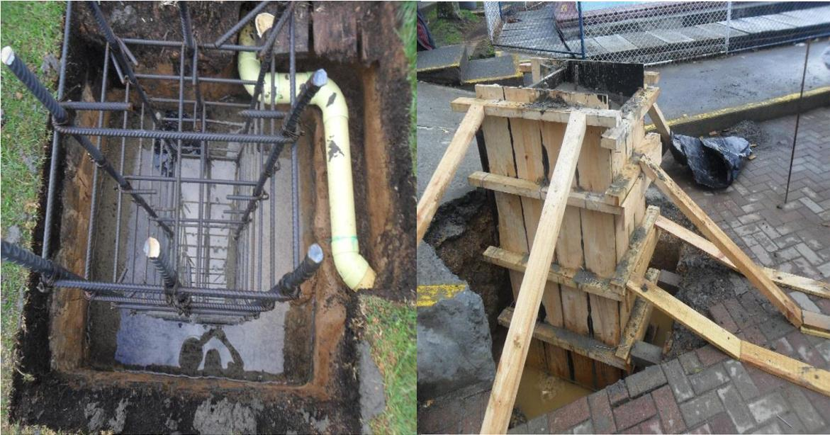
Sobre la base del concreto se anchan las bases metálicas de 0.50 x 0.50 m. en cada uno de los pedestales y según diseño establecido se inicia colocando las estructuras metálicas, luego se colocan tejas de PVC en la cubierta.
