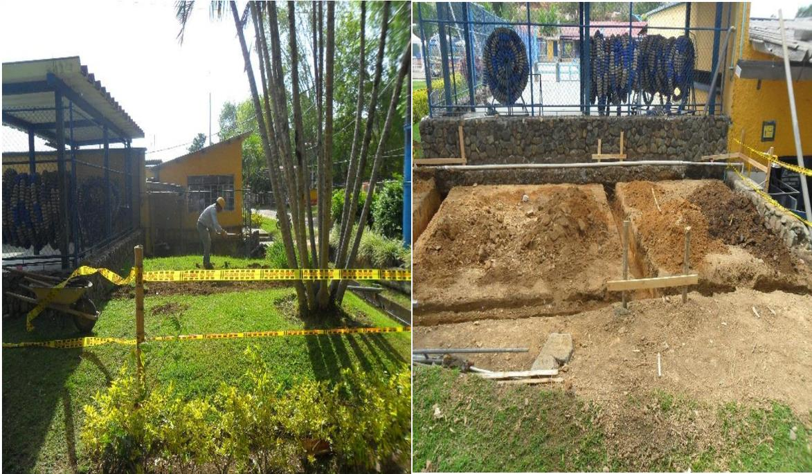
Se construye un solado o plantilla, con el fin de recibir el armado de acero y protegerlo de los sulfatos encontrados en la tierra, es elaborado con una capa de concreto pobre, dando un grosor de 5 cm. Posteriormente se coloca la viga de cimentación de 30 x 30 con su respectivo acero de refuerzo, se ancla todo el acero de los castillos que van en las columnetas para confinar los muros, siguiendo los planos estructurales, luego se vacía el concreto.
