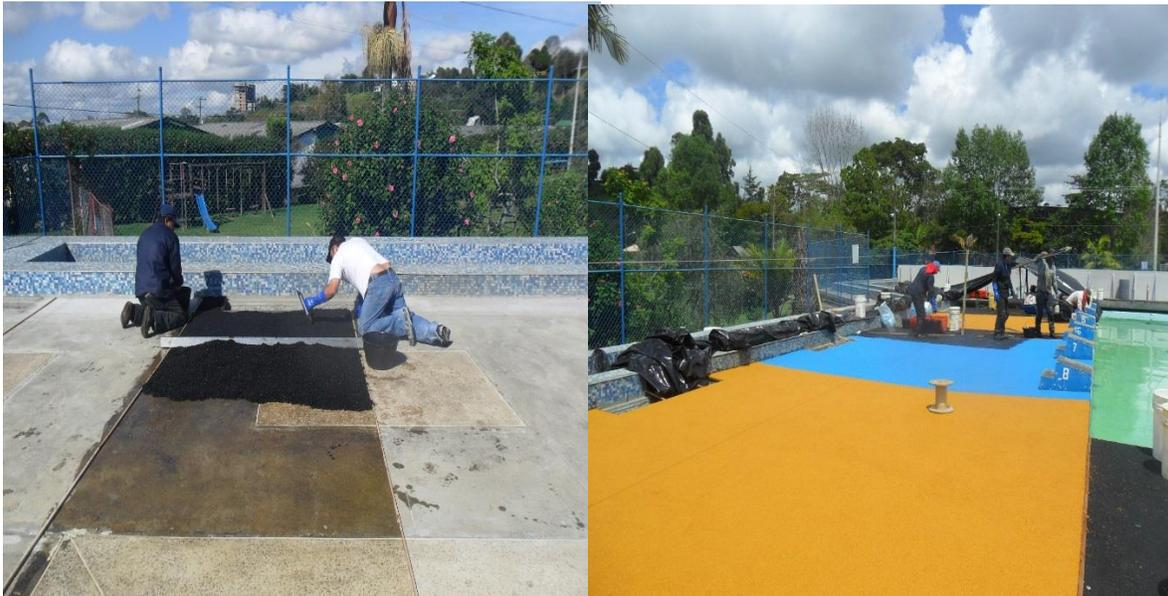
Este material se adhiere a un ligante especial y se coloca con una llana metálica, para luego darle un acabado con pintura.
