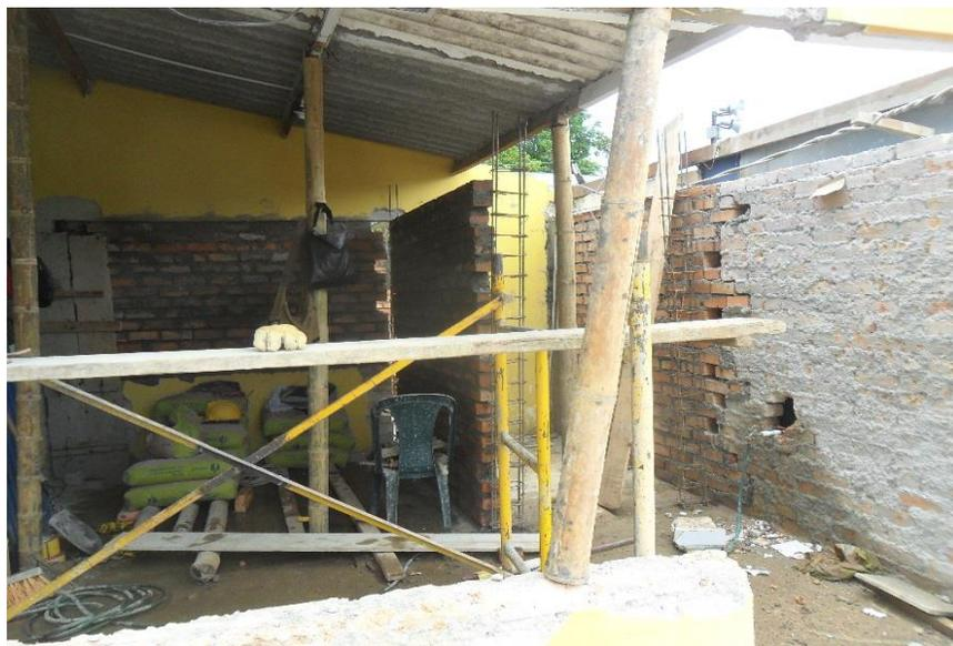
Se procede con la demolición de: muro divisorio en enfermería y herramientas, y de piso; retiro de puertas, ventanas y lavamanos. Posteriormente, se inicia la construcción de muro y columnetas para la demarcación del baño.
