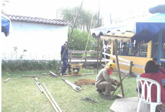
Posteriormente, se realizó cuatro sondeos con equipo liviano de percusión con profundidades variables entre 2,00 y 6,00 m. Luego se hizo ensayos en sitio de penetración estándar, tomando muestras alteradas e inalteradas a diversas profundidades, con tubo Shelby y con cuchara Split Spoon.
