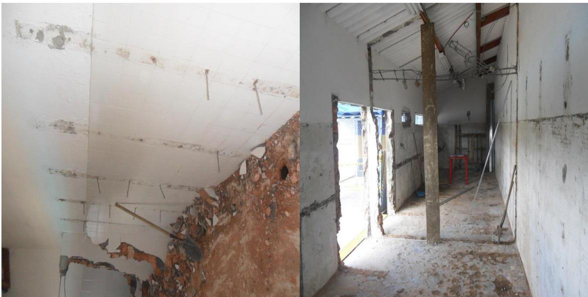
Se realiza demolición de piso primario y retiro de la tubería de gres, con el fin de cambiarla a tubería de PVC en su totalidad. Posteriormente se retiran las conexiones hidráulicas, luego se realiza la construcción de los nuevos muros divisorios entre baños de hombres y mujeres.
