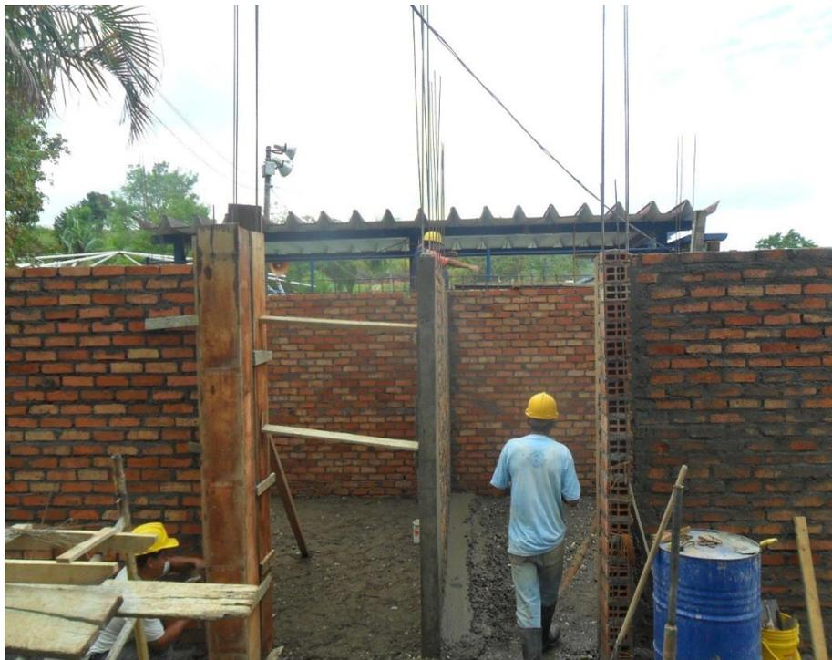
Se hace la viga de amarre de cubierta de 30 x 30 con su respectivo acero de refuerzo. Se realiza un relleno de roca muerta de E= 0,15m. y se coloca un piso primario de 0,07 m.
