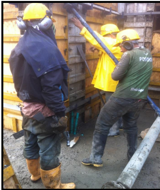
figura 13. Plomo formaleta forsa
