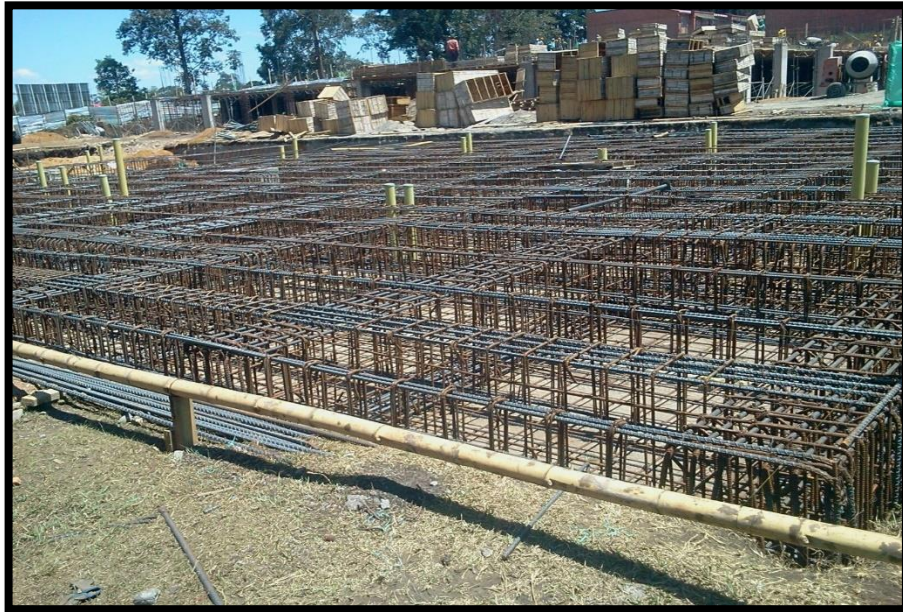
figura 26. vigas y viguetas de cimentación
