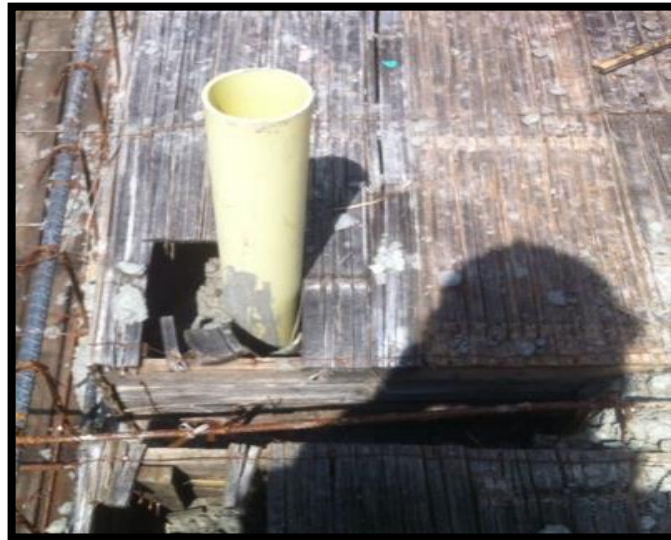
figura 31. Colocación red sanitaria
