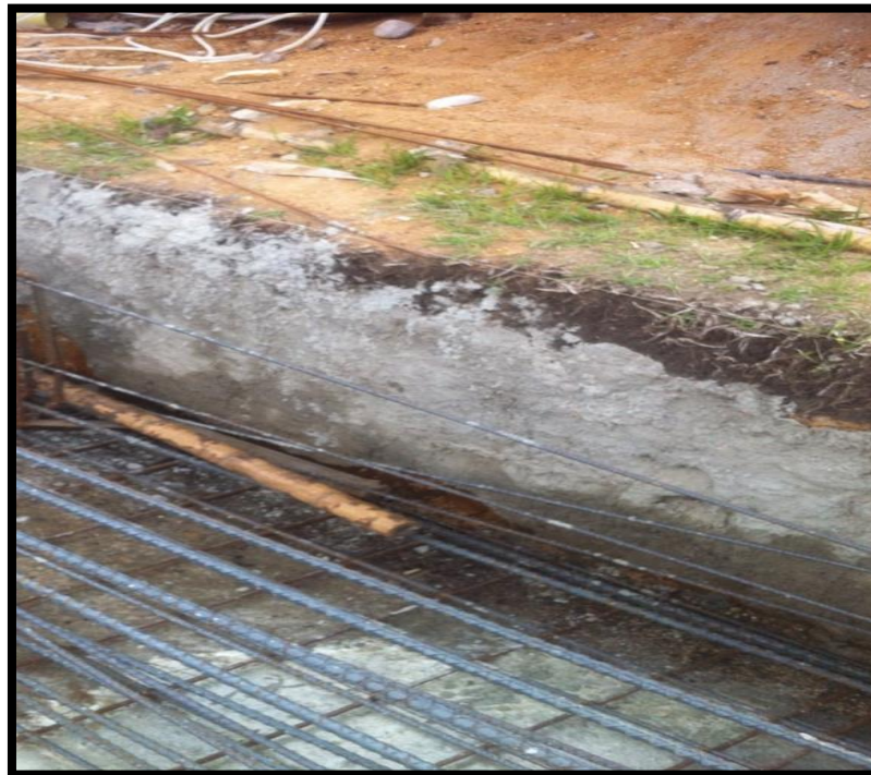
figura 24. Champeo del talud
