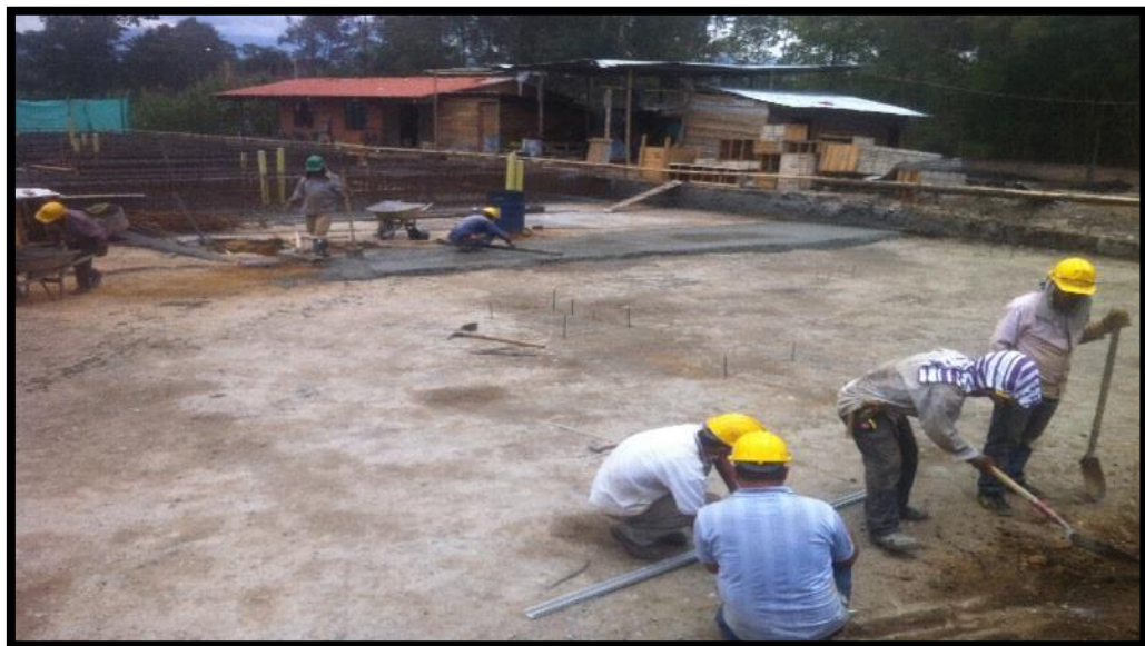
figura 23. Fundición solado de limpieza
