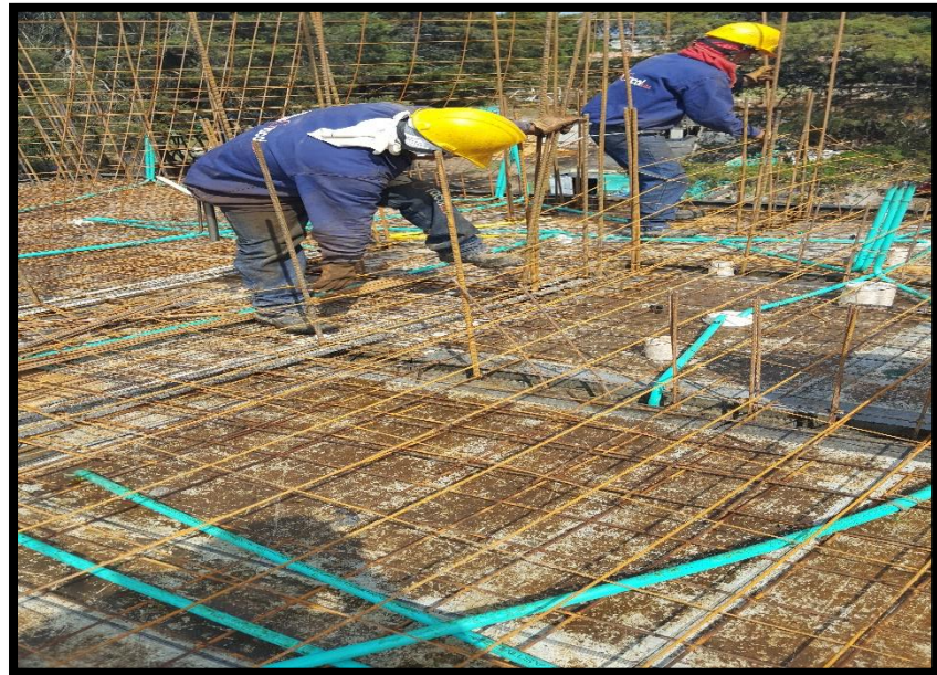
figura 14. Colocacion malla superior
