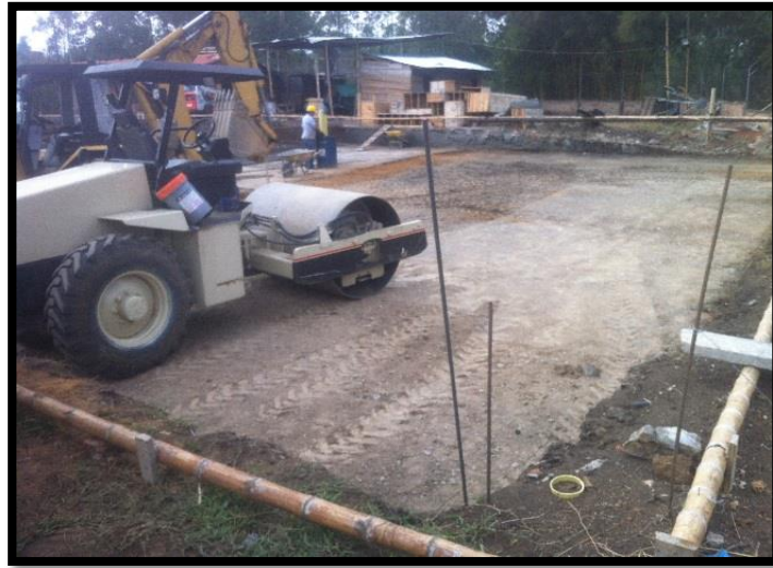
figura 21. Suelo compactado con vibrocompactador
