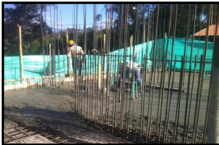
Figura 33. Fundición vigas, viguetas y torta superior
