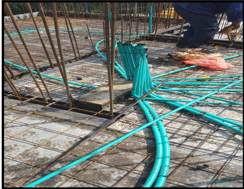
figura 17. Tubería electrica
