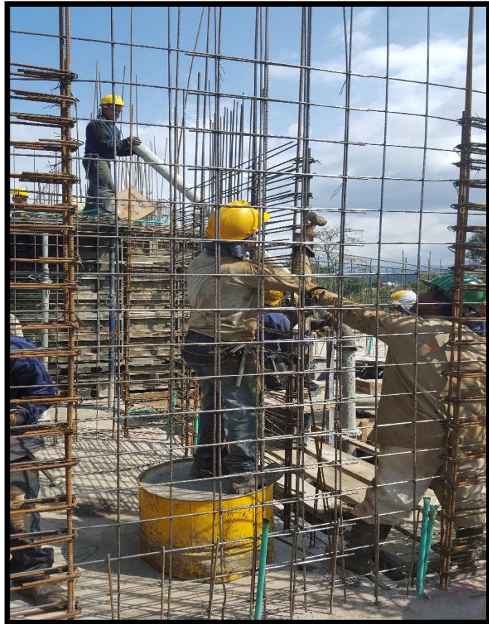
figura 9. Malla en el elemento de borde
