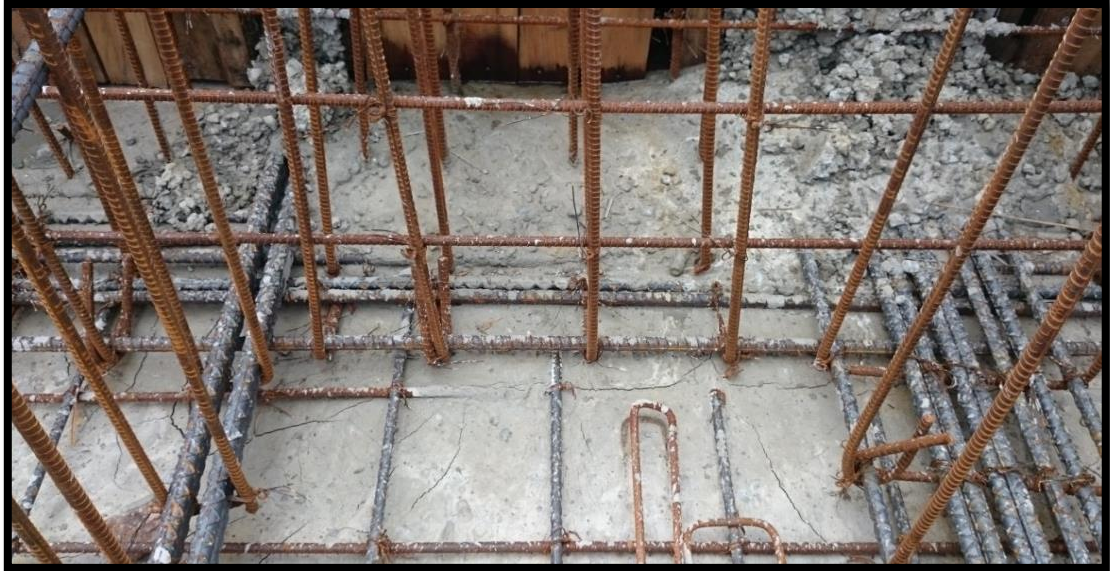
figura 30. Fundición torta inferior de 15 cms de espesor
