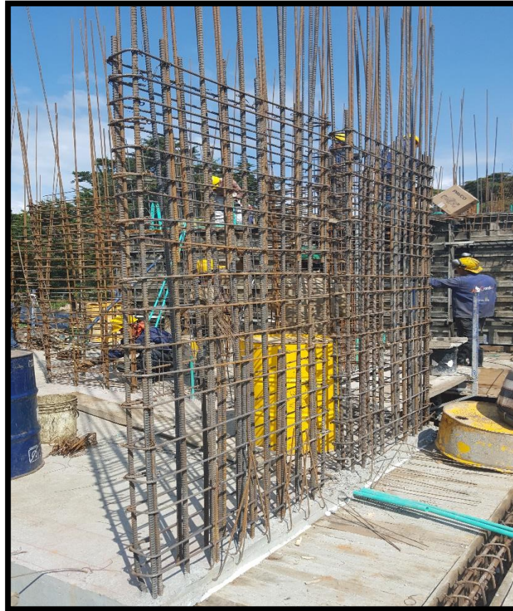
Figura 10. Estribos en el elemento
