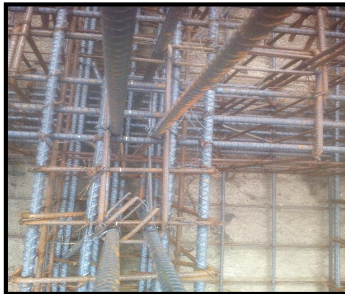
Figura 29. Colocacion arranques
