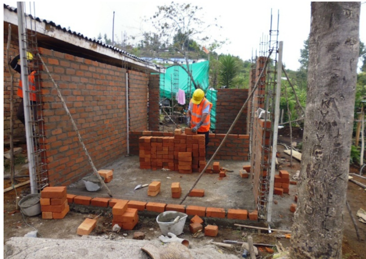
FIGURA 28. Foto mampostería confinada. Sandra Milena Camayo Zambrano. Beneficiario Jebalá - Totoró. Fuente: Archivo Rafael Carvajal
