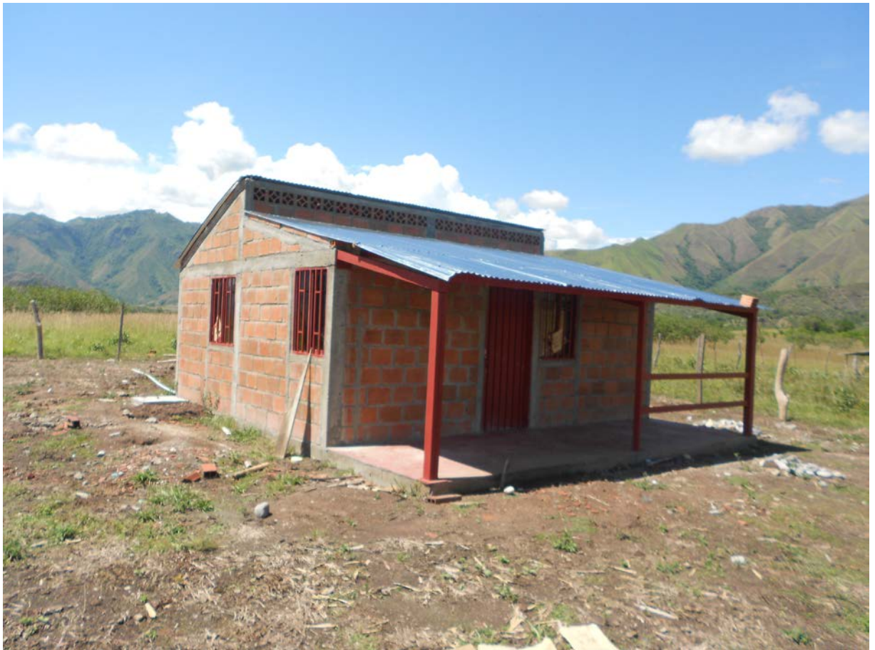
FIGURA 83. Foto VISR Ana Yibi Ramos Valencia. Beneficiario La Balsa - Páez. Entrega oficial al beneficiario del módulo construido. Se firma el recibido a satisfacción. Fuente: Archivo Rafael Carvajal.
