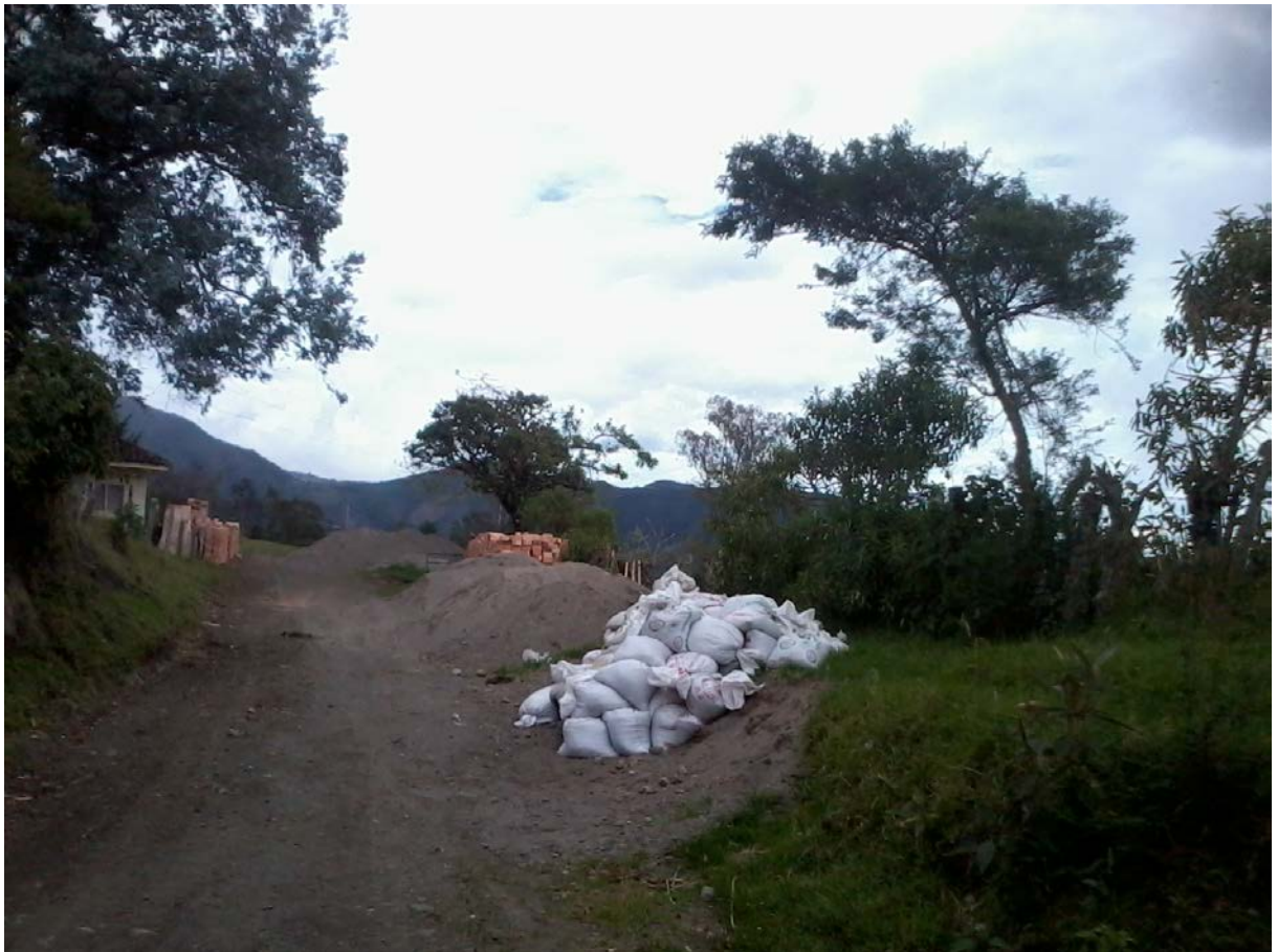
FIGURA 57. Foto en Sotará del sitio donde se dejan los materiales. Los beneficiarios deben bajarlo en tractor hasta el sitio de construcción. Fuente: Archivo Rafael Carvajal.
