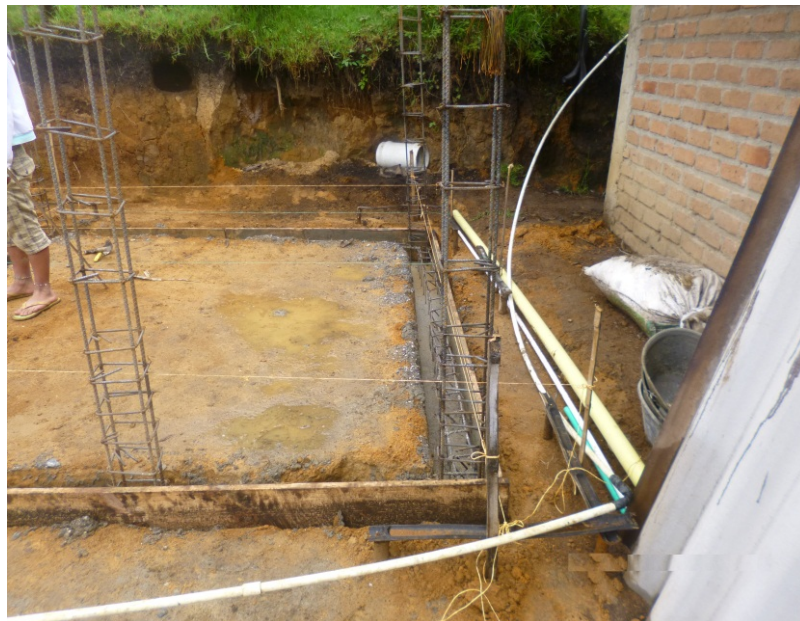
FIGURA 23. Foto viga de cimentación. Yuri HesmitChate. Beneficiario Jebalá Totoró. Fuente: Archivo Rafael Carvajal
