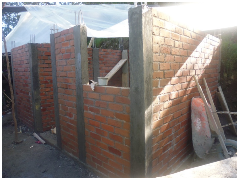
FIGURA 34. Foto columnas en concreto terminadas. Ylia Sánchez Campo. Beneficiario Salado Blanco - Totoró. Fuente: Archivo Rafael Carvajal
