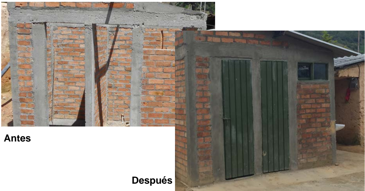
FIGURA 65. Foto MVSB Reynel Chaguendo Yunda. Beneficiario Bella Vista – Totoró. Módulo impermeabilizado con Sika101 mortero. Fuente: Archivo Rafael Carvajal.
