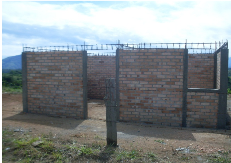
FIGURA 37. Foto columnas en concreto terminadas. Jesús Orlando Gómez. Beneficiario La esperanza - Popayán. Fuente: Archivo Rafael Carvajal
