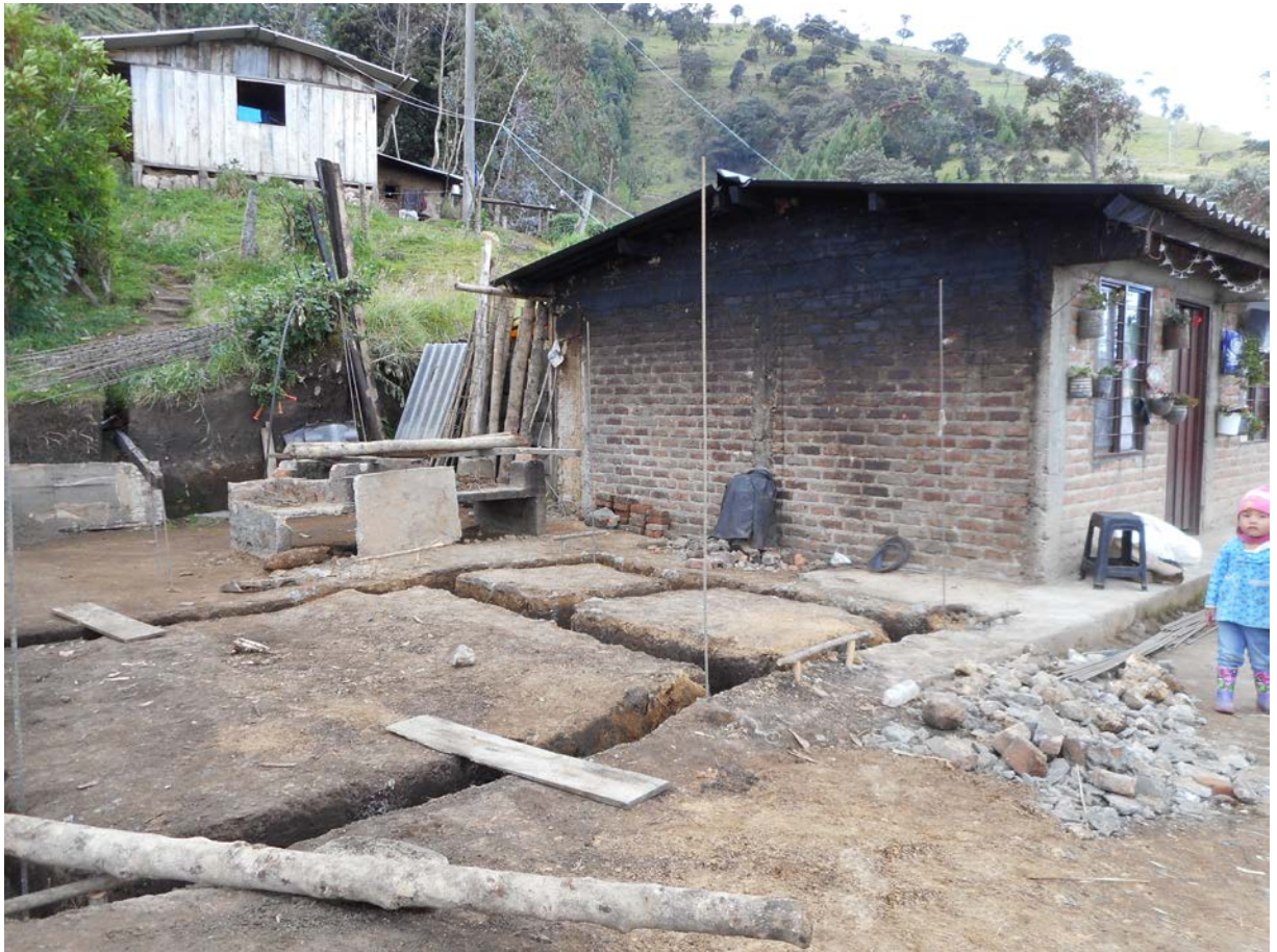
FIGURA 59. Foto MVSb Isabel Mazabuel Rojas. Beneficiario La Siberia - Totoró. Inicio de ejecución de obra incluyendo excavaciones. Fuente: Archivo Rafael Carvajal.
