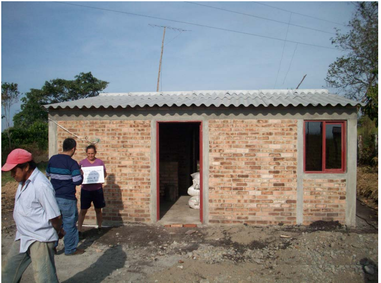
FIGURA 76. Foto VISR Olga Liliana Sánchez. Beneficiario El Danubio - Morales. Entrega oficial al beneficiario del módulo construido. Se firma el recibido a satisfacción. Fuente: Archivo Rafael Carvajal.
