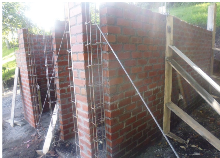
FIGURA 29. Foto mampostería confinada. Yuri HesmitChate. Beneficiario Jebalá - Totoró. Fuente: Archivo Rafael Carvajal
