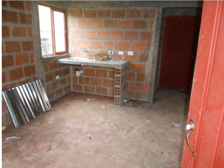
FIGURA 45. Foto puertas y ventana metálicas. Nelson Torres Gutierrez. Beneficiario La Balsa – Municipio de Páez. Fuente: Archivo Rafael Carvajal
