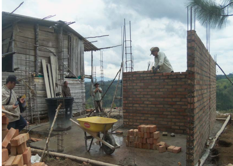
FIGURA 30. Foto mampostería confinada. Ezequiel Guamanga Gómez. Beneficiario La esperanza - Popayán. Fuente: Archivo Rafael Carvajal
