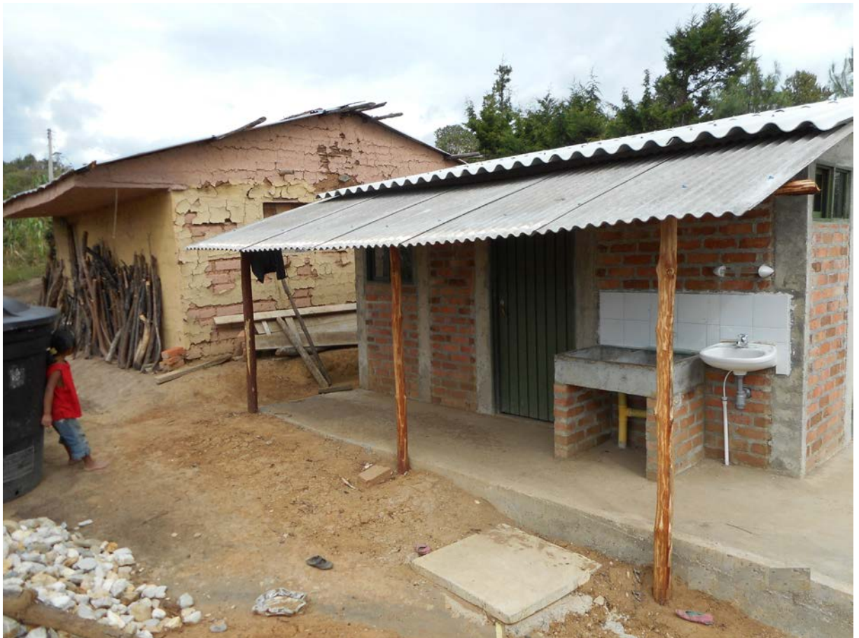
FIGURA 69. Foto MVSB Víctor Golondrino. Beneficiario Jeralá - Totoró. El beneficiario añade una extensión a la cubierta para subsanar una de las quejas del proyecto y es el alero tan pequeño. Fuente: Archivo Rafael Carvajal.
