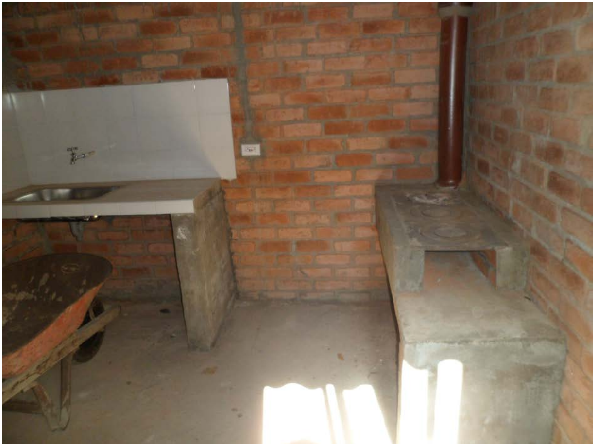
FIGURA 62. Foto MVSB Ylia Sánchez Campo. Beneficiario Salado Blanco - Totoró. Solo queda pendiente la instalación del pozo séptico y los vidrios. Fuente: Archivo Rafael Carvajal.
