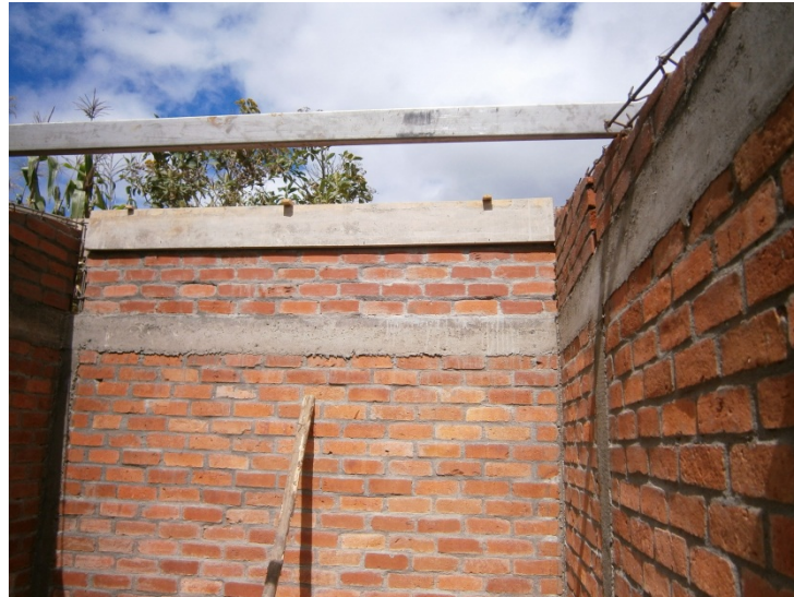
FIGURA 35. Foto construcción viga cinta. María Virginia Golondrino Becoche. Beneficiario Bella Vista - Totoró. Fuente: Archivo Rafael Carvajal
