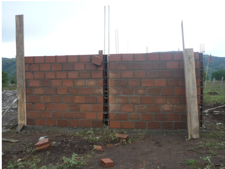
FIGURA 33. Foto mampostería confinada. Aleida Lemus Montenegro. Beneficiario La Balsa – Municipio de Páez. Fuente: Archivo Rafael Carvajal
