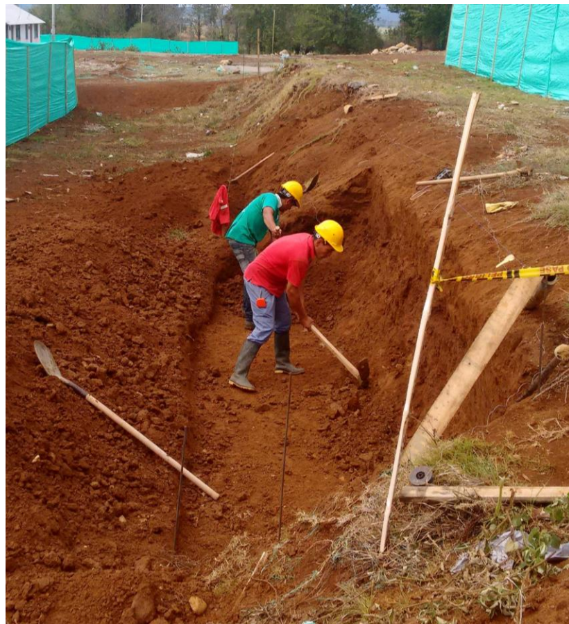
Fig. 7 Excavación a mano sector II Fase III
