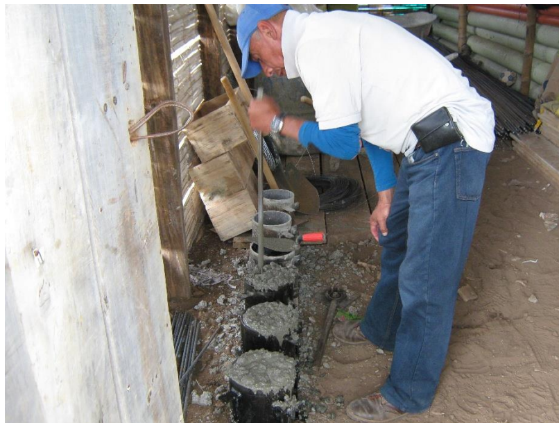
Fig. 40 Llenado de cilindros para ensayo de resistencia a compresión.
