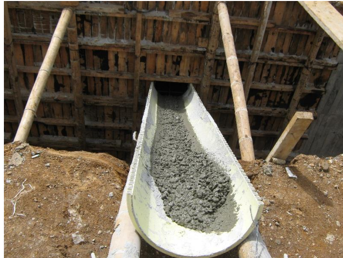
Fig. 31 Vaciado del concreto por ventana.
