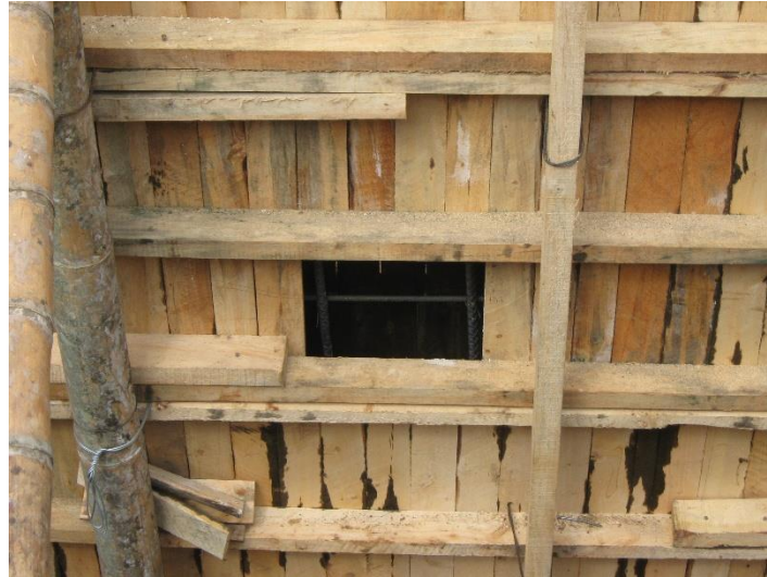
Fig. 29 Ventana para vaciado de concreto.
