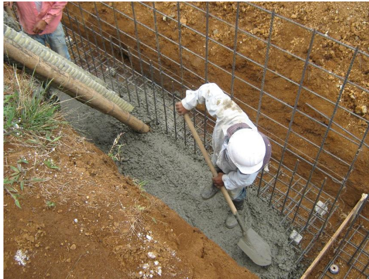
Fig. 18 Vaciado de concreto para zapata usando canaleta.
