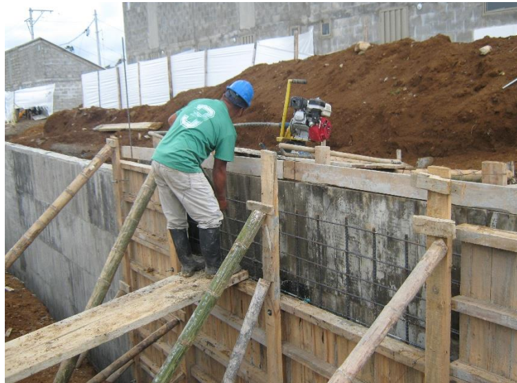
Fig. 34 Vaciado del concreto quitando tableros superiores.
