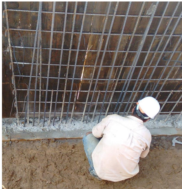
Fig. 46 Realización de los anclajes.
