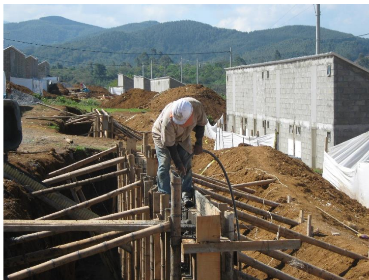
Fig. 36 Vibrado del concreto.
