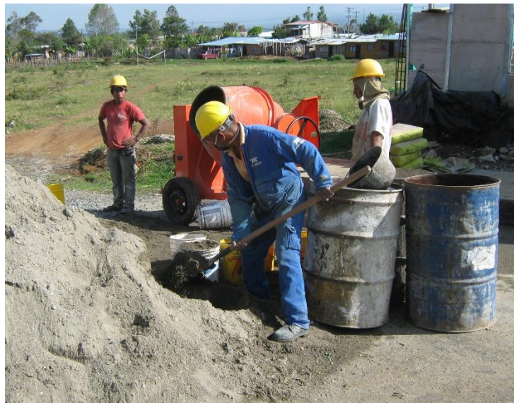
Fig. 14 Elaboración de concreto con mezcladora.
