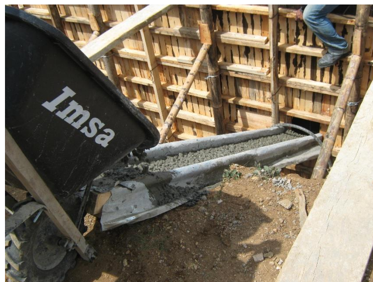
Fig. 32 Vaciado del concreto por ventana.
