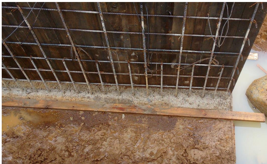
Fig. 44 Acero del brazo fuera del eje.
