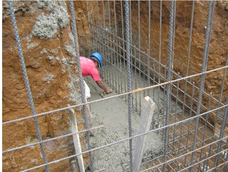
Fig. 16 Fundición zapata muro de contención.
