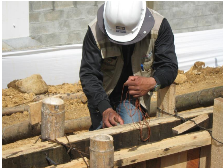
Fig. 28 Chequeo de formaleta en madera.
