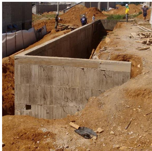
Fig. 24 Muro extremo con ventana para filtro.
