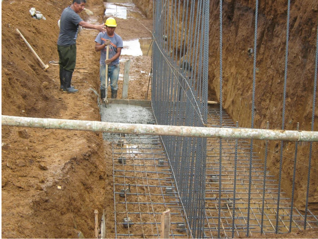
Fig. 11 Revisión acero de refuerzo Sector II Fase III
