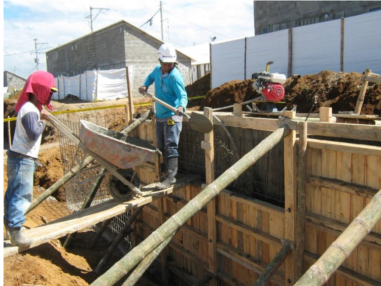
Fig. 33 Vaciado del concreto quitando tableros superiores.
