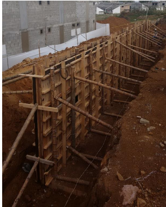
Fig. 23 Encofrado muros centrales de bloque.
