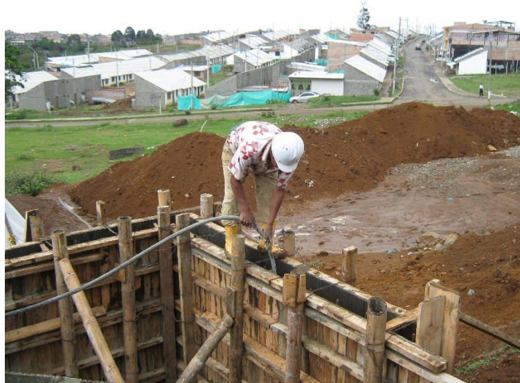
Fig. 35 Vibrado del concreto.
