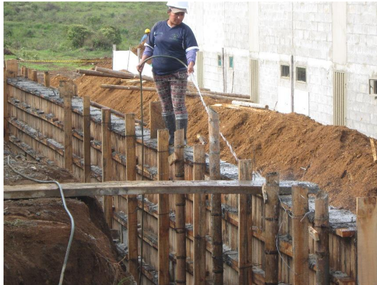
Fig. 41 Curado del concreto.
