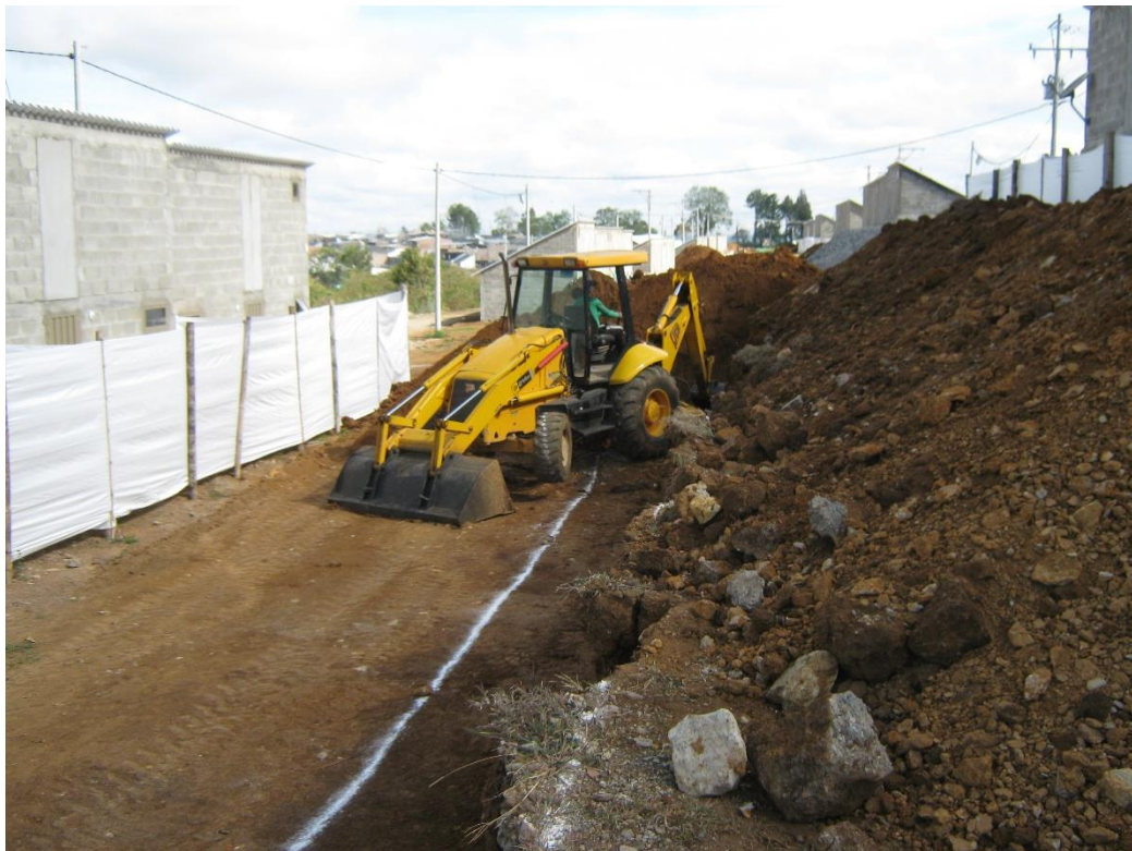
Fig. 8 Excavación mecánica Sector II Fase II
