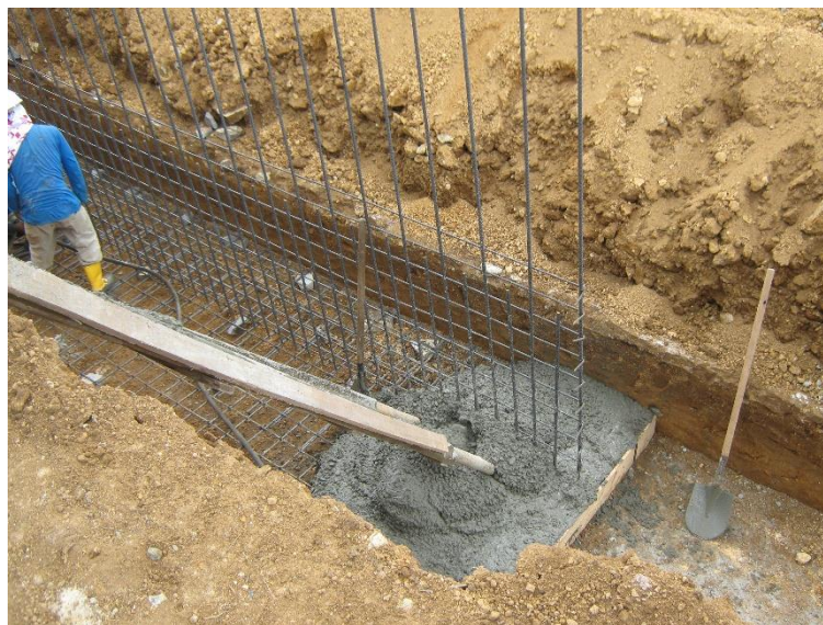
Fig. 19 Vaciado de concreto para zapata usando canaleta.
