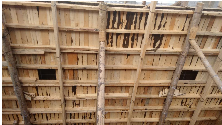
Fig. 30 Ventanas para vaciado de concreto.
