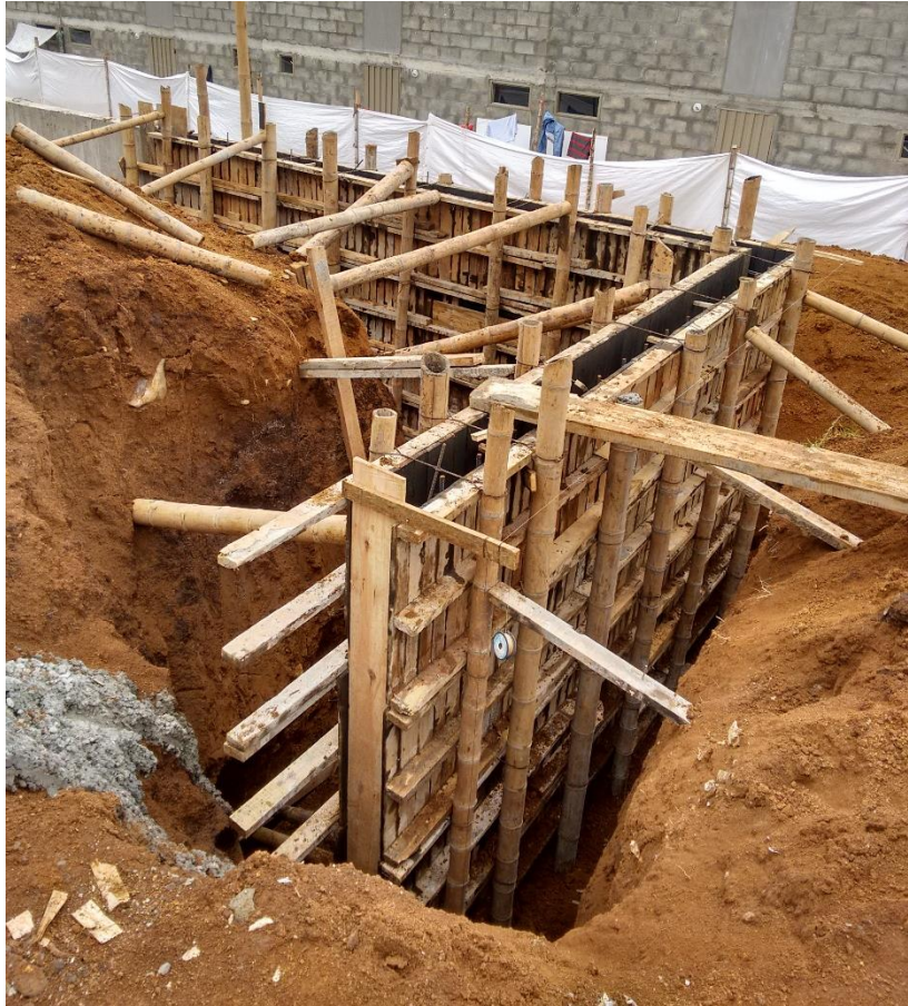
Fig. 22 Encofrado muro longitudinal y lateral.
