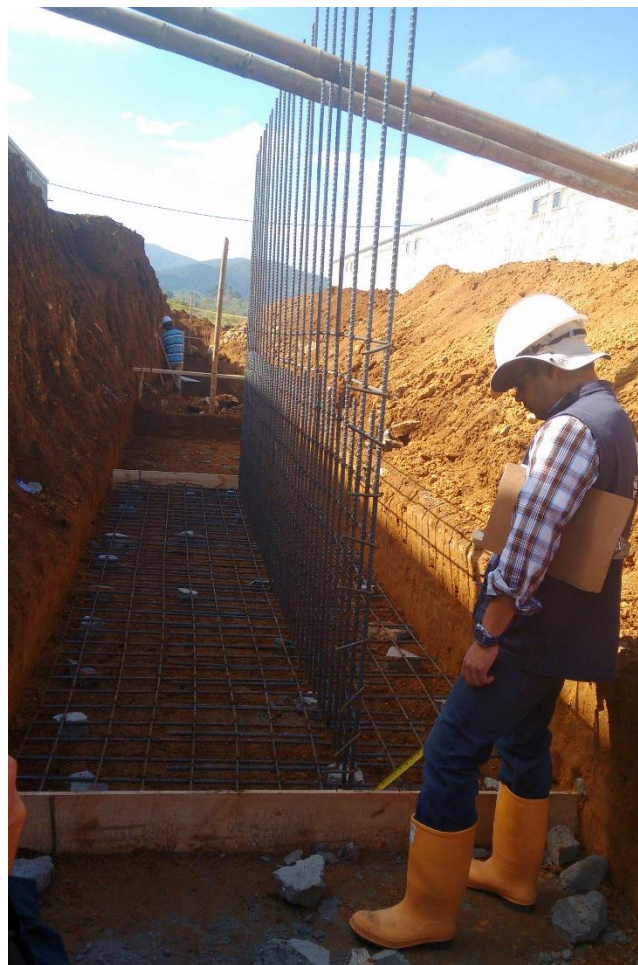
Fig. 10 Revisión acero de refuerzo Sector II Fase II
