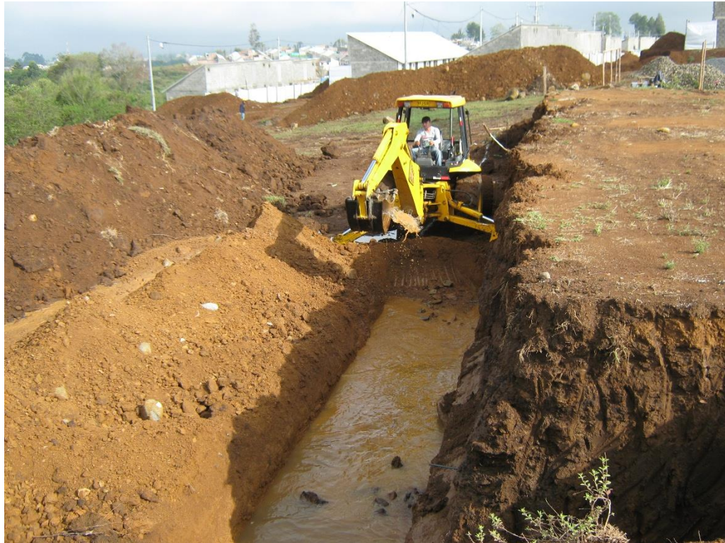
Fig. 9 Excavación mecánica Sector II Fase III
