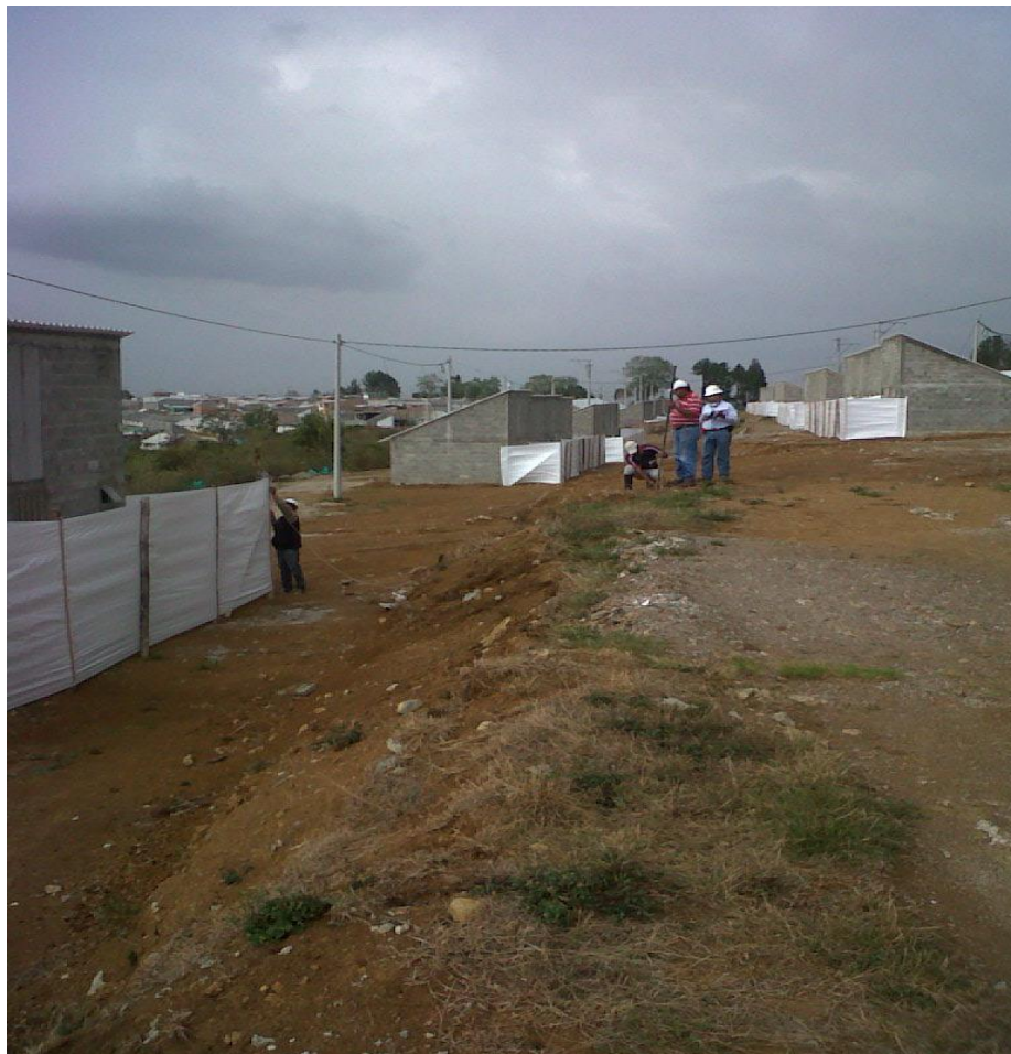
Fig. 5 Localización y replanteo sector II fase II
