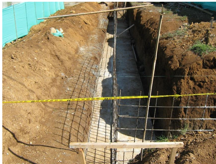
Fig. 17 Zapata muro de contención fundida.
