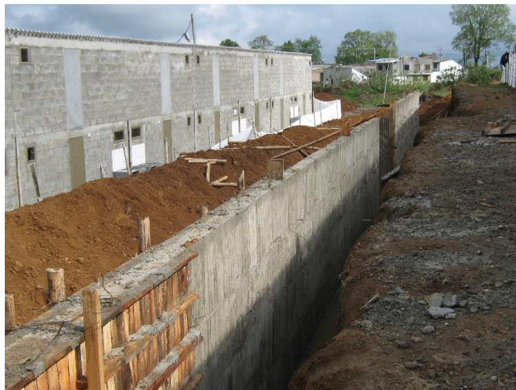
Fig. 42 Muro desencofrado y terminado.
