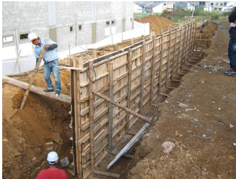
Fig. 26 Colocación de formaleta en madera.
