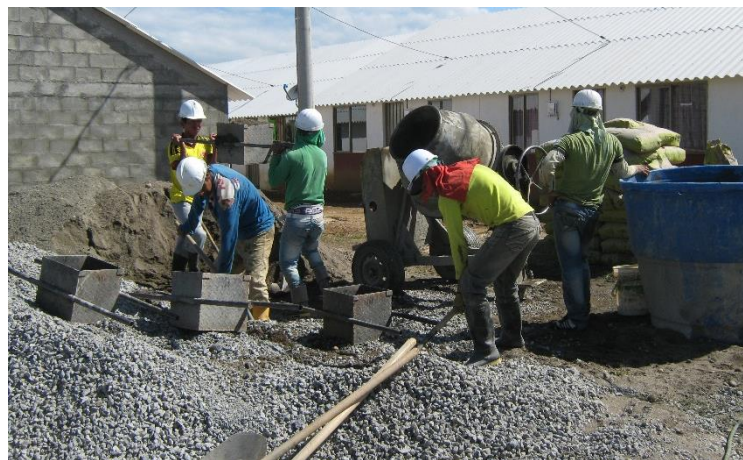
Fig. 15 Dosificación con cajones metálicos.
