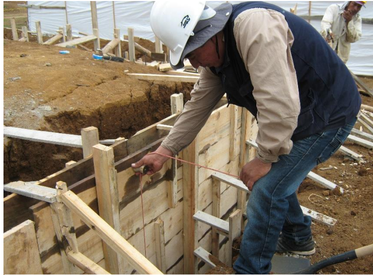
Fig. 27 Chequeo de formaleta en madera.
