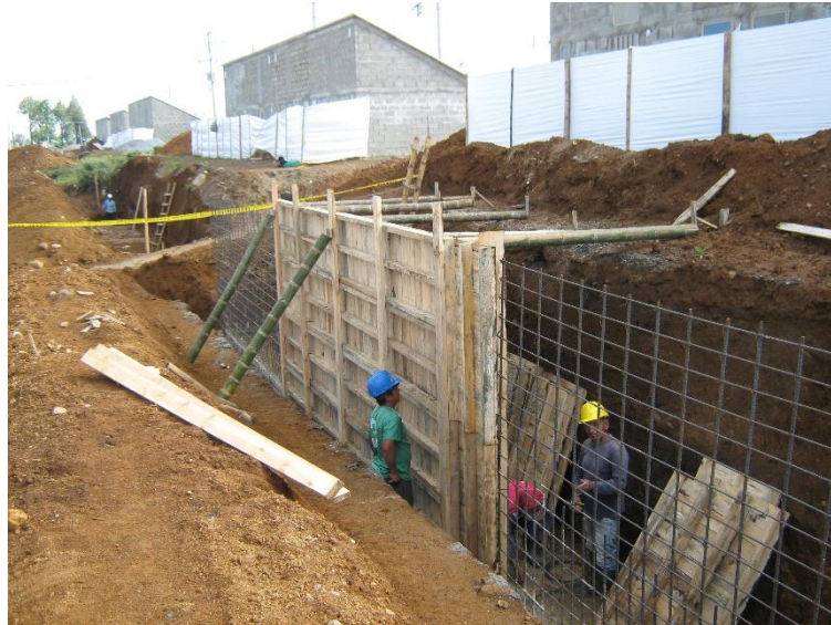
Fig. 25 Colocación de formaleta en madera.
