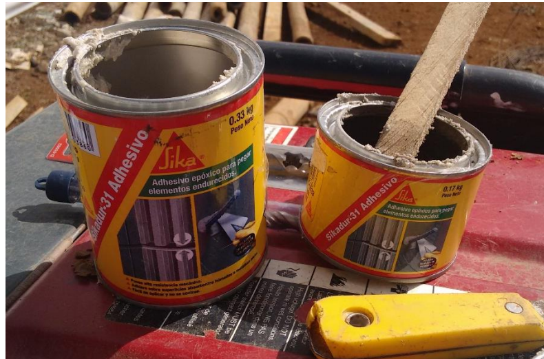
Fig. 45 Adherente usado para los anclajes.
