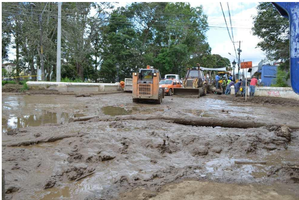
Ilustración 6.Limpieza del puente sobre el Rio Molino, barrio Bolívar, 25 de Diciembre de 2013.
