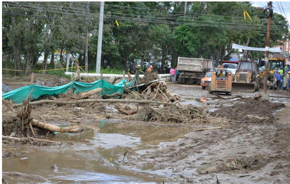
Ilustración 5. Limpieza del puente sobre el Rio Molino, Barrio Bolívar, 25 de Diciembre de 2013.
