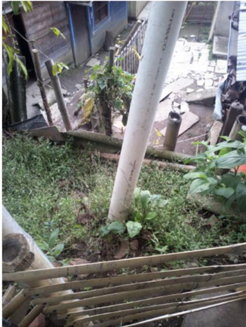
Bajante de aguas lluvias sobre el talud
