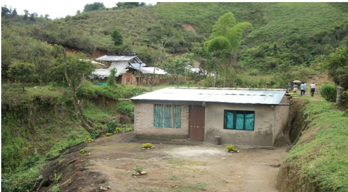
Ilustración 43.vivienda cerca a quebrada, vereda Pueblillo Alto, Popayán cauca 2014.
