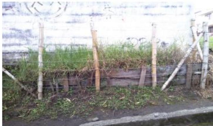
Lateral de la vivienda, cerca en guadua y contención del talud
