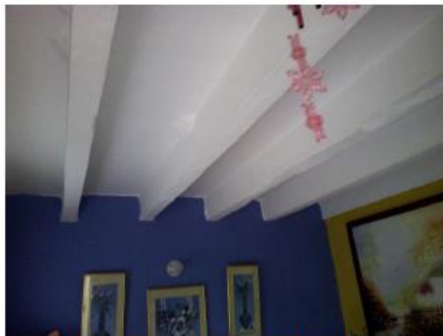
Interior de la vivienda, detalle de losa aligerada.
