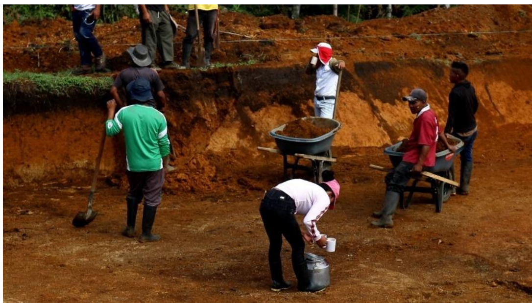
Figura 45. Construcción de estanque de riego, proyecto productivo de tomate de árbol (2020). Fuente: Semillero de Investigación Estudios Etnográficos Audiovisuales.
