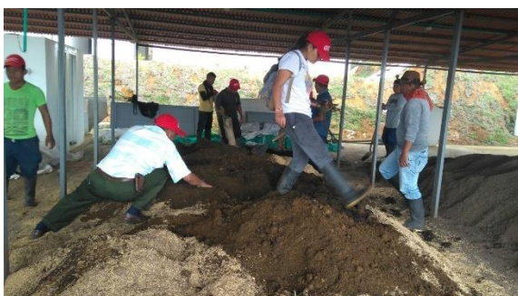
Figura 15. Construcción del ETCR Carlos Perdomo, Caldon, Cauca.
