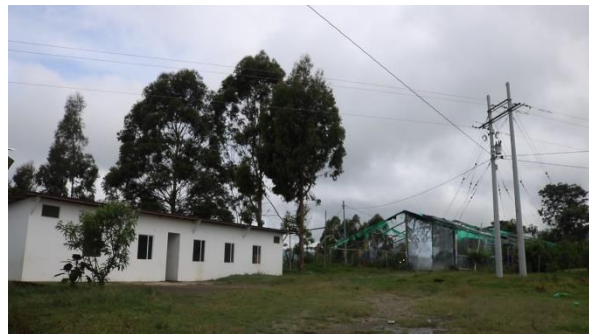
Figura 13. Campamento provisional de llegada, San Antonio, Caldon, Cauca. (2020).
