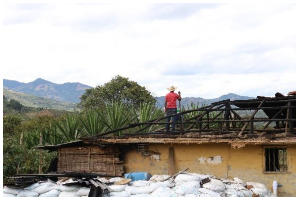
Figura 44. Reconstrucción casa, proyecto productivo de tomate de árbol, Andalucía, Caldono (2019).
