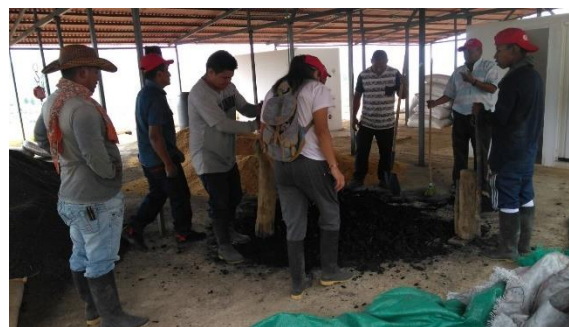
Figura 14. Construcción del ETCR Carlos Perdomo, Caldon, Cauca.
