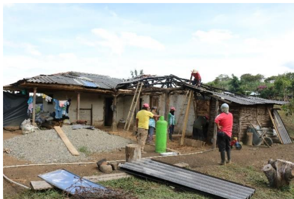
Figura 43. Reconstrucción casa, proyecto productivo de tomate de árbol, Andalucía, Caldono (2019).
