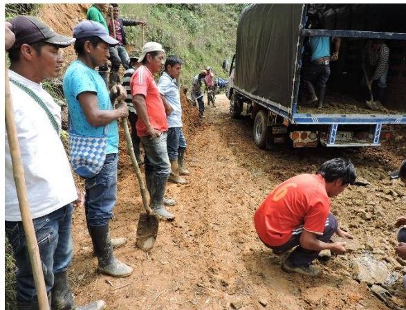
Figura 23. Adecuamiento de vías terciarias (2017). Fuente: Archivo fotográfico excombatientes Carlos Perdomo.
