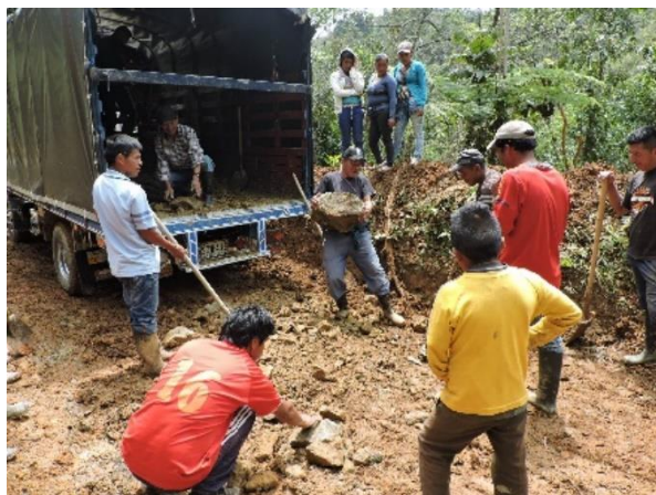
Figura 22. Adecuamiento de vías terciarias (2017). Fuente: Archivo fotográfico excombatientes Carlos Perdomo.
