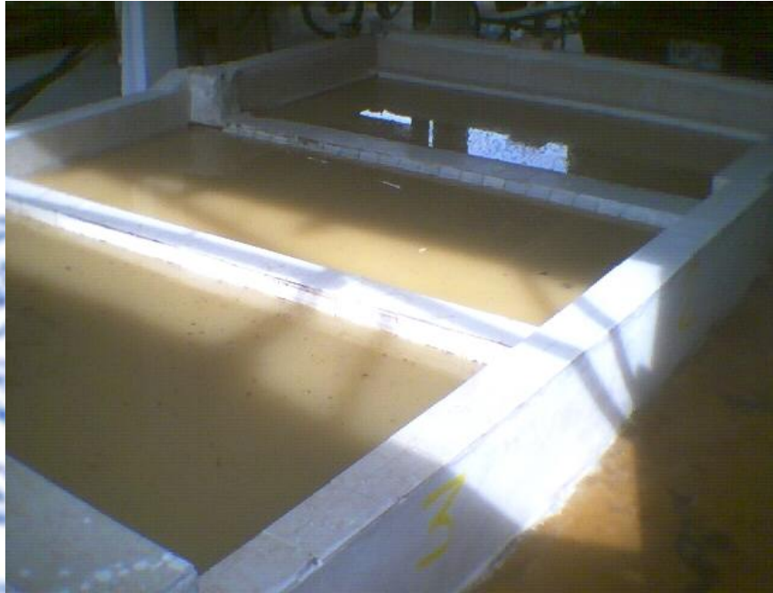
Fotografía J.5. Tanques de fermentación.
