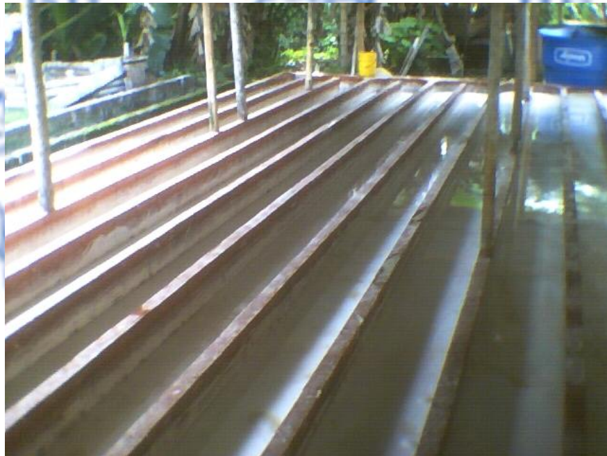
Fotografía J.4. Canales de sedimentación.
