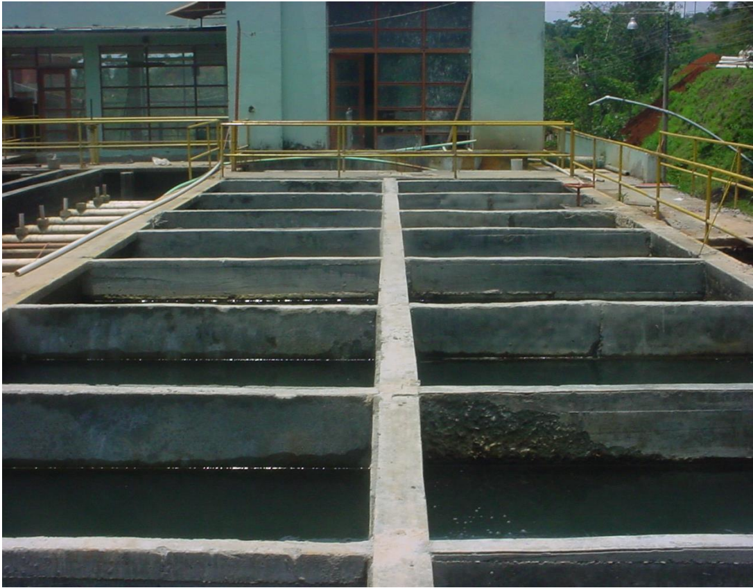
Fotografía 5. Detalle Floculador
