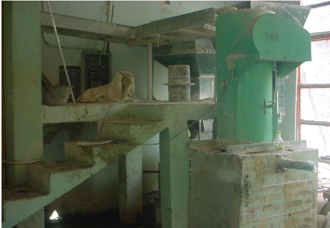
Fotografía 11. Detalle dosificador de solución de Cal
