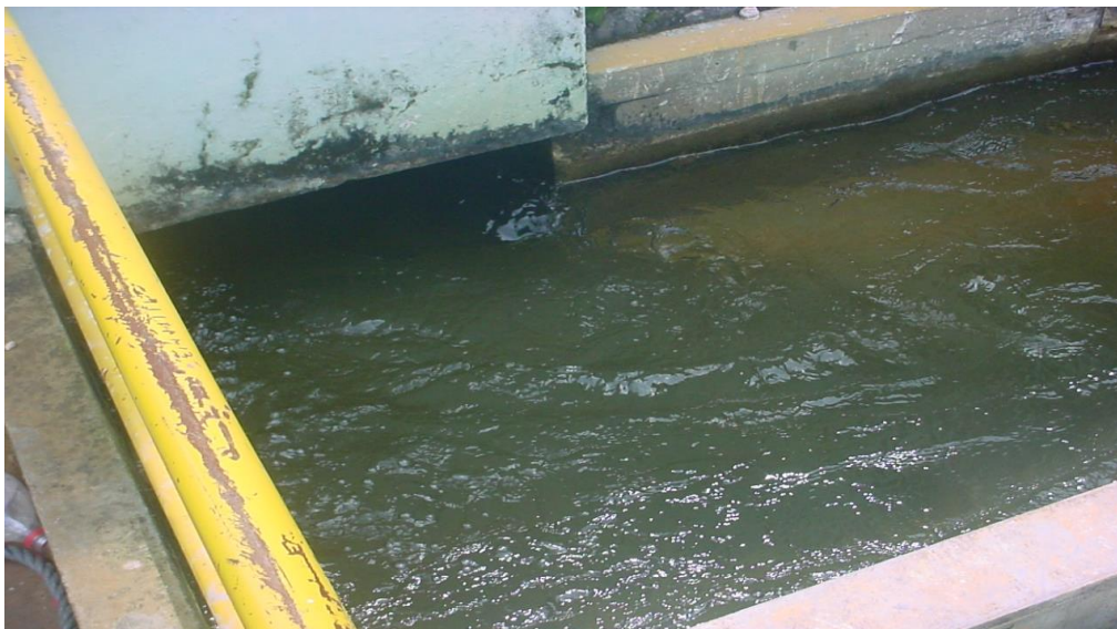
Fotografía 2. Detalle entrada a canaleta Parshall (Punto de muestreo)
