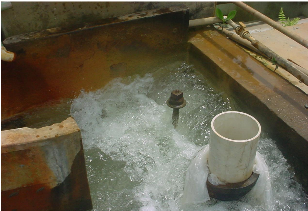
Fotografía 4. Detalle Mezcla Rápida
