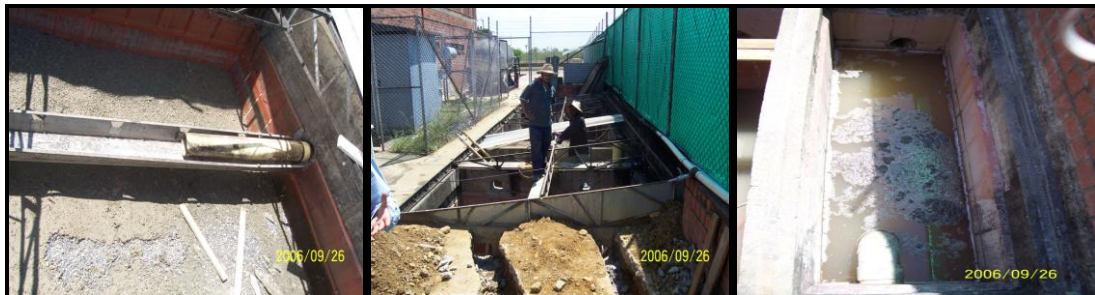
Figura 10. Construcción de la planta de tratamiento preliminar VINCORTE
