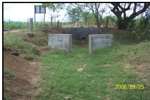
Figura 7. Lugar de captación concesión No 010 de 2005 sin uso
