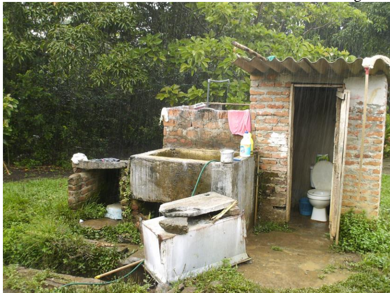
Figura 7. Unidad sanitaria de una vivienda en el sector rural de Dominguillo.
