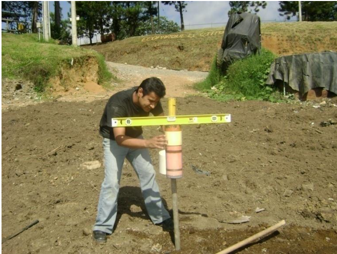
Figura 6. Instalación del pluviómetro
