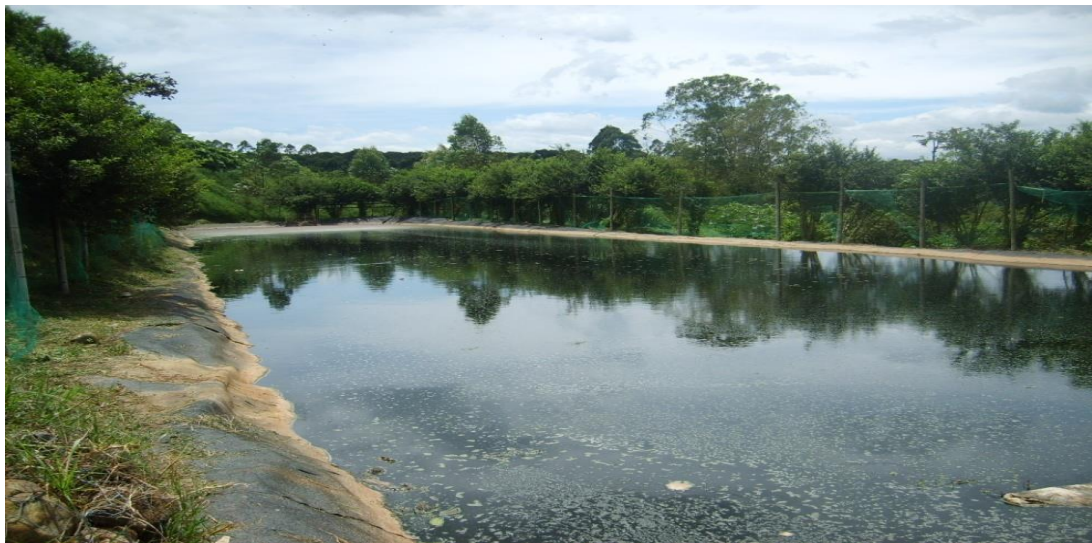
Figura 4. Laguna de estabilización de lixiviados Eco parque “el ojito”.
