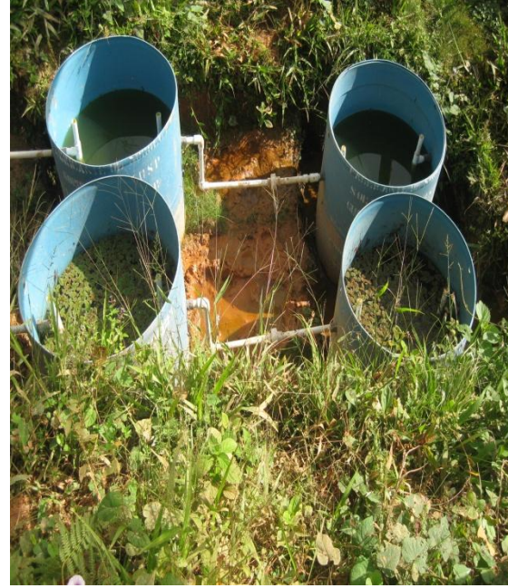
Foto 7. Luminosidad en Tanque 4 y 5
