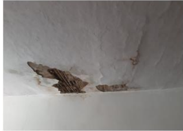
Figura 54. Techo del punto de venta
