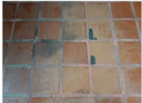
Figura 50. Piso área de elaboración
