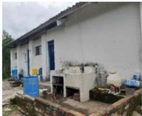
Figura 14. Parte trasera derecha de la planta.
