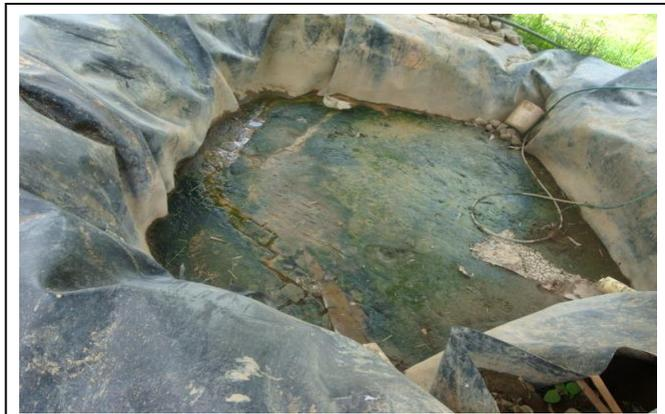
FIGURA 19. Lecho de secado del relleno Sanitario.
