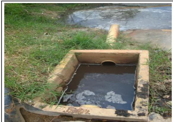
FIGURA 17. Paso del lixiviado del sedimentador a la laguna de estabilizac.
