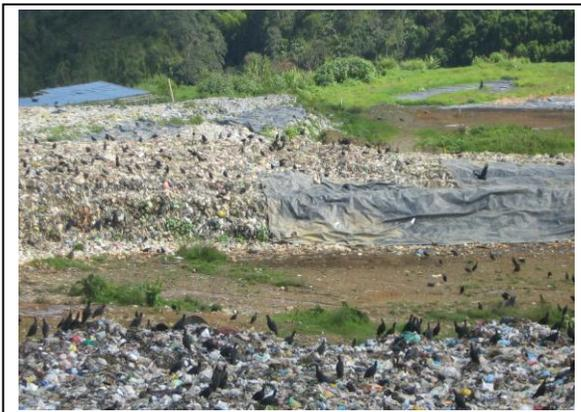
FIGURA 7. Manejo inadecuado de las celdas de residuos sólidos. Febrero-2008.
