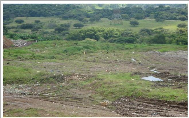
FIGURA 9. Celda de residuos sólidos clausurada, sin nivelación y empradización.
