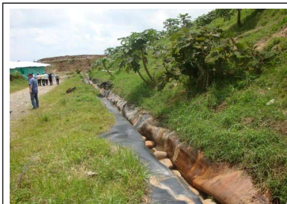
FIGURA 14. Canalización incompleta de aguas lluvias en el Relleno Sanitario.
