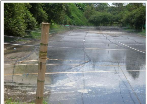
FIGURA 18. Laguna de estabilización de lixiviados del Relleno Sanitario
