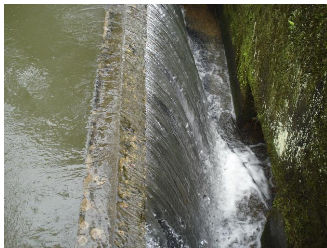
Figura 53. Vertedero de Excesos.
