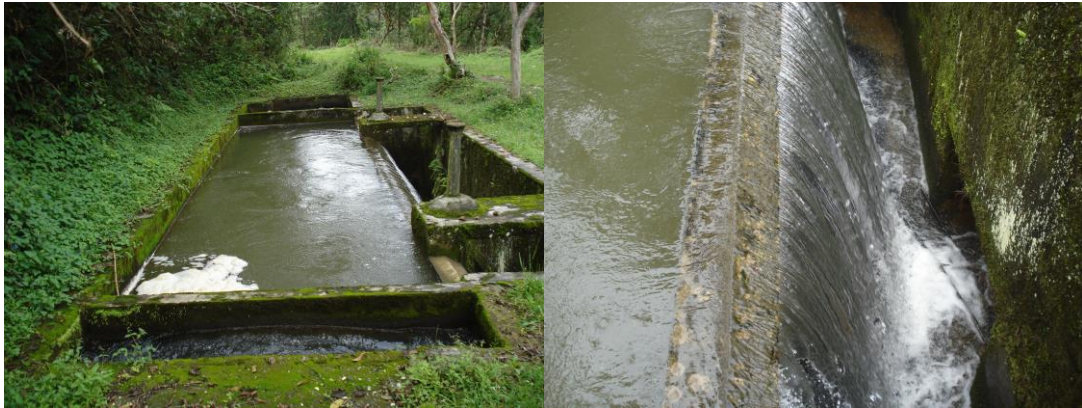
Figura 10. Punto de Aforo. Vertedero de Excesos. Desarenador Río Cauca.
