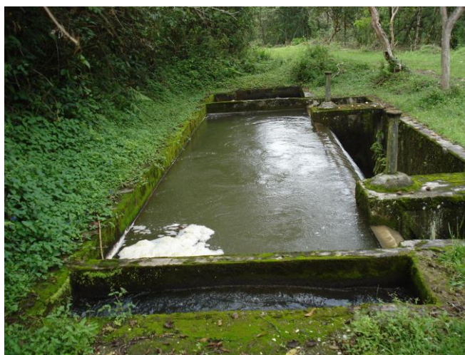
Figura 52. Desarenador Bocatoma Río Cauca.
