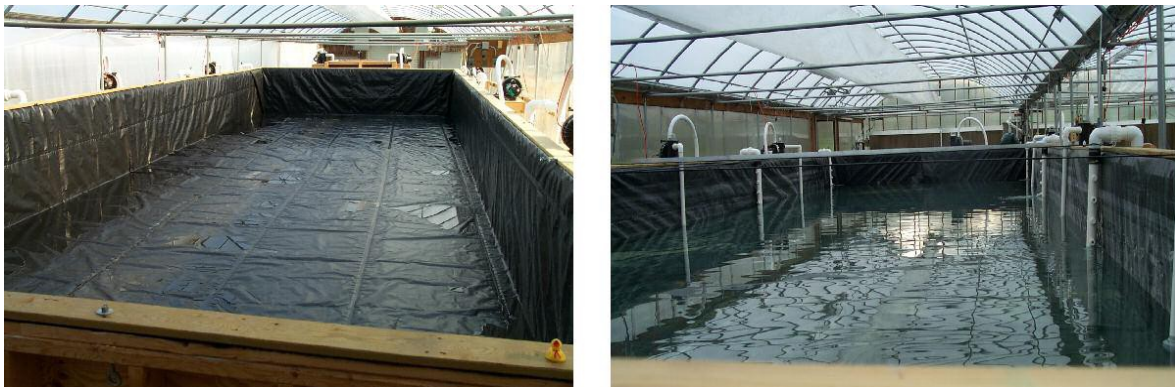
Figura 5. Raceway de celdas mixtas en el invernadero del Freshwater Institute; construido con madera estructural y cubierto con polietileno de alta densidad. Fuente: Labatut et al. , 2007.
