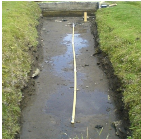
Foto 1. Estanque con adaptación de tubería para el estudio.
