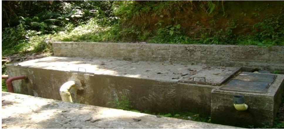
Figura 15. Desarenador
