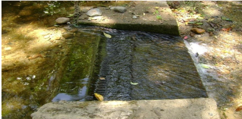
Figura 13. Rejilla, bocatoma microcuenca Esmita
