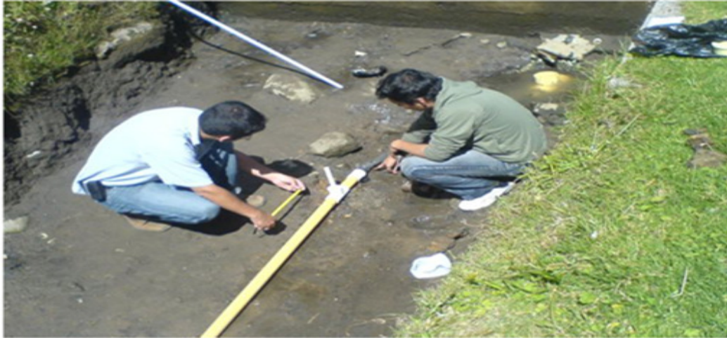
Foto 1. Montaje de tubería en estanque a escala real.
