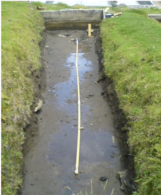
Foto 2. Sistema de recolección de agua y sólidos en el estanque escala real.
