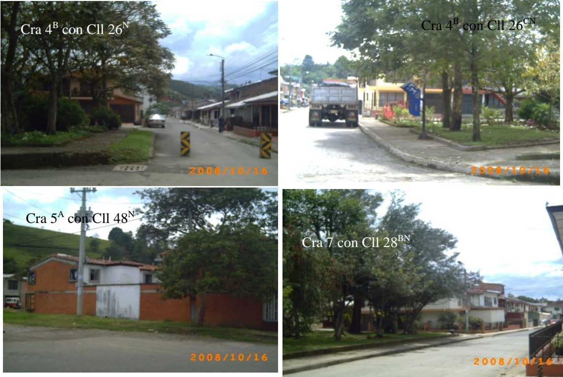
Figura A 3.4 Estado de algunas vías principales en la ruta de reciclaje
