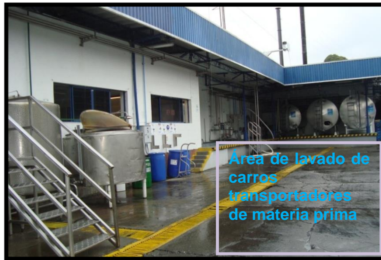
FOTO 2. ESPACIO LIBRE Y TANQUES DEL CIP
