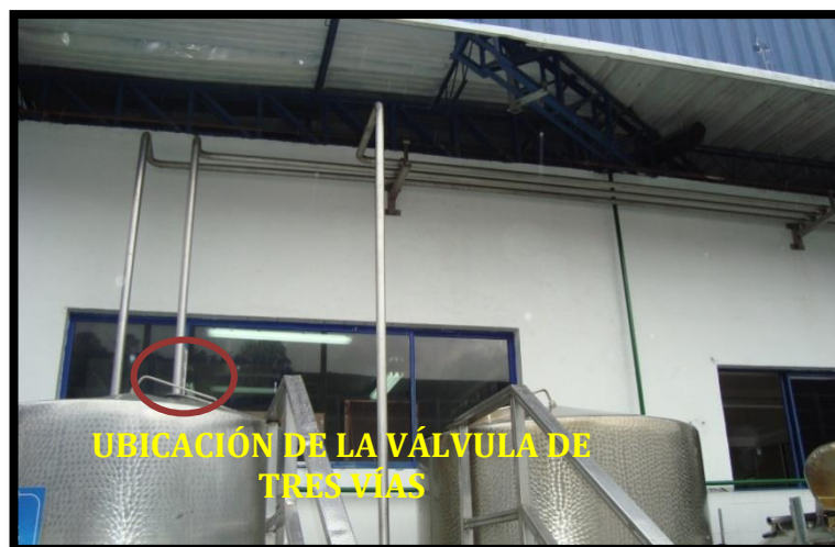
FOTO 5. VÁLVULA DE TRES VÍAS QUE SE ENCUENTRA EN LA LÍNEA DE RETORNO DE LA SOLUCIÓN ALCALINA
