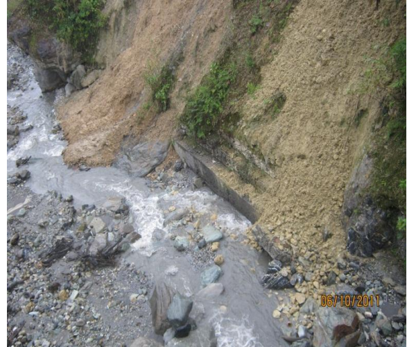
PR80+330 puente Guanacas material derrumbado al costado del cauce.
