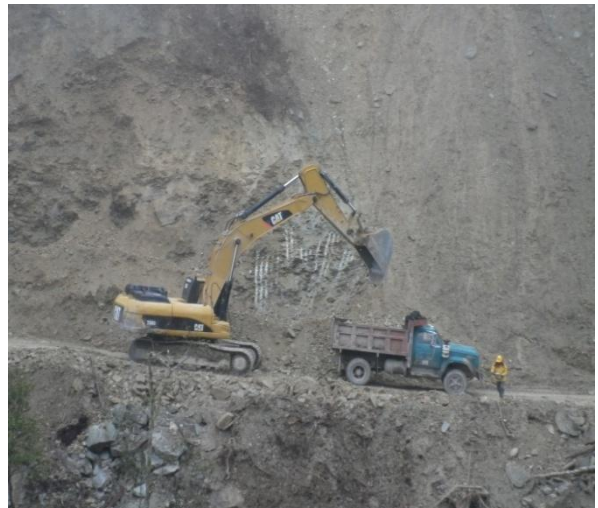
Sedimentadores en planta de triturados Argos /PR80+330 puente Guanacas actividad de corte para la ampliación de la banca
