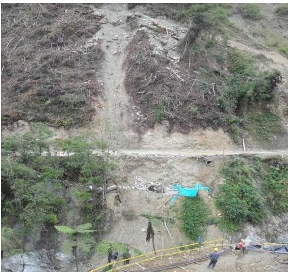
Taludes en el puente Guanacas
