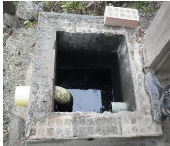
Taller ubicado en la planta de trituración – Trampa de Grasas
