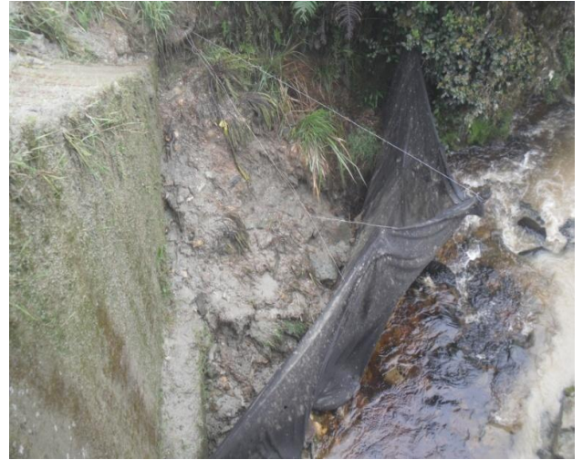
Adición de sólidos suspendidos a la quebrada la Marquesa. / maya en mal estado y sin el debido mantenimiento.
