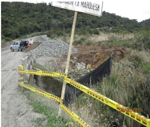
En la quebrada la Marquesa se encontró material destapado y sin la adecuada señalización/ Geotextil sin el adecuado mantenimiento.
