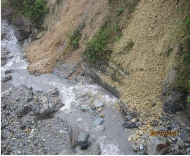
PR80+330 puente Guanacas material derrumbado al costado del cauce.
