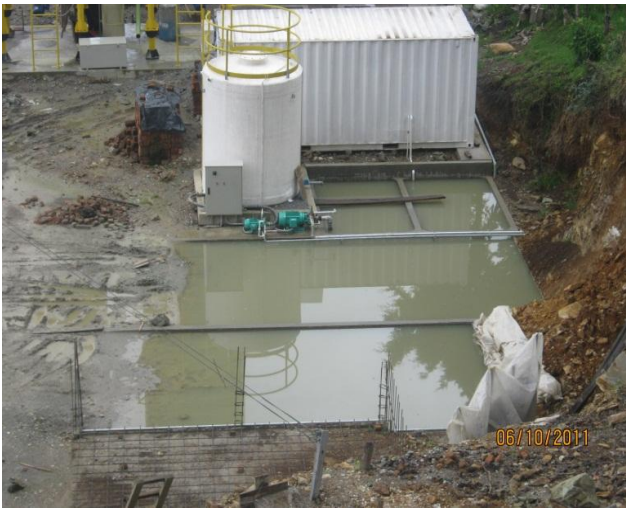
Sedimentadores en planta de triturados Argos /PR80+330 puente Guanacas actividad de corte para la ampliación de la banca
