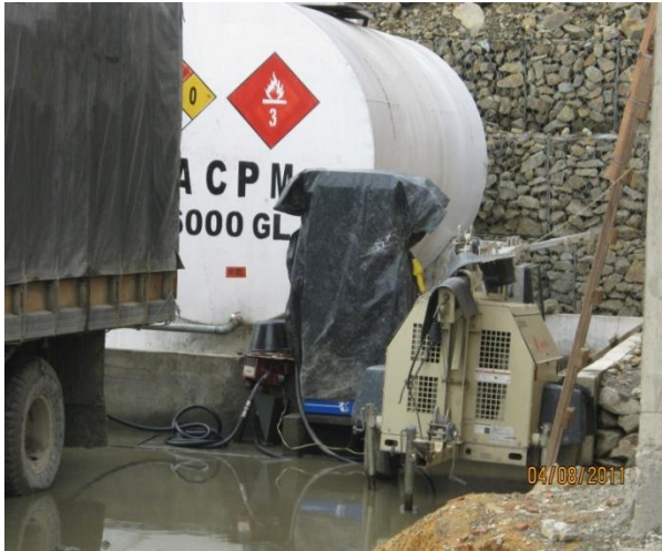
En la Planta de Triturados se evidencia zona de combustible inundada y contaminación directa al Suelo.
