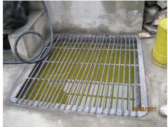
Sitio de acopio de combustibles y construcción de la trampa de grasas en la planta de triturados.
