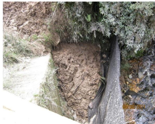
En la quebrada la Marquesa se encontró material destapado y sin la adecuada señalización/ Geotextil sin el adecuado mantenimiento.
