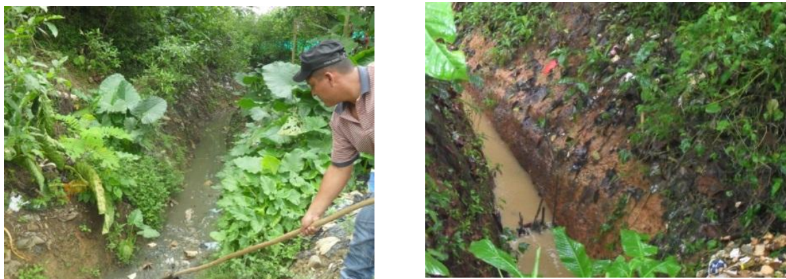
Figuras 29 y 30. Mantenimiento de canales de aguas lluvias
