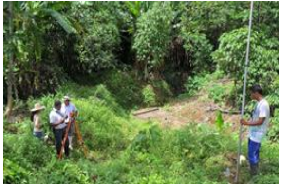
Figura 10. Chequeo de cotas del terreno
