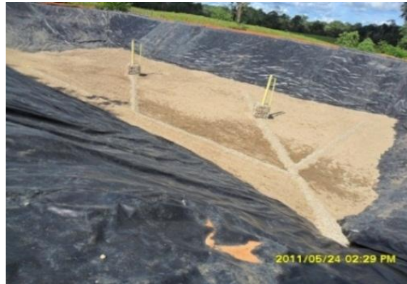
Figura 19. Celda Sur construida
