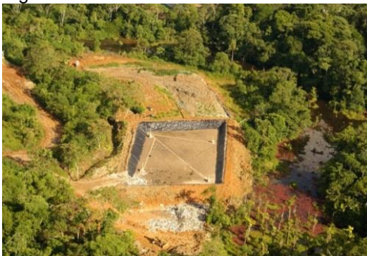
Figura 1. Vista aérea celda 4 Kililí
