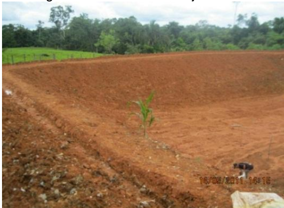
Figura 12. Canal de anclaje
