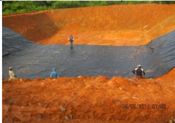
Figura 13. Instalación del sistema impermeabilizante
