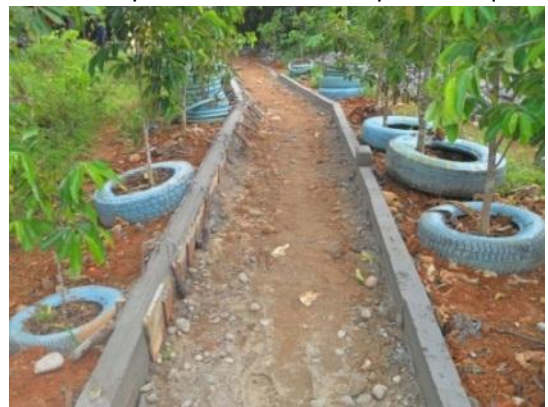
Figura 55. Preparación del terreno para adoquinar
