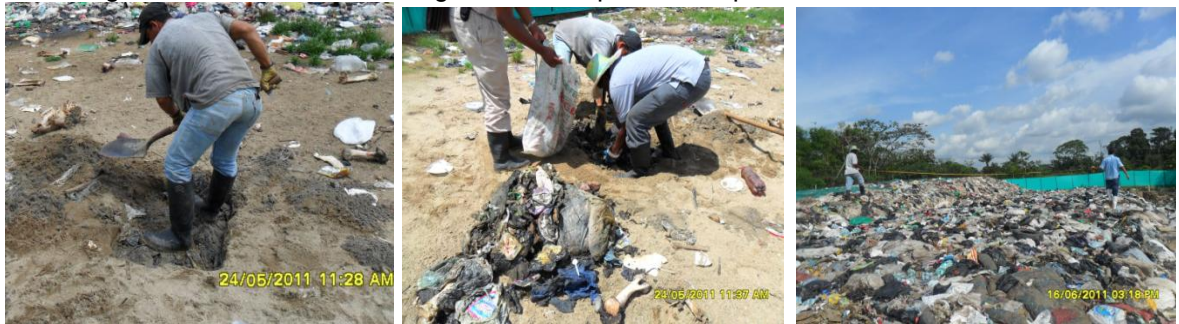
Figura 27. Determinación de grado de compactación aplicado
