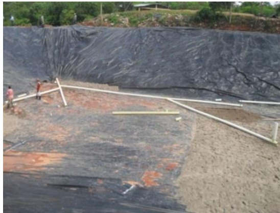
Figura 17. Instalación de sistema de drenaje de lixiviados
