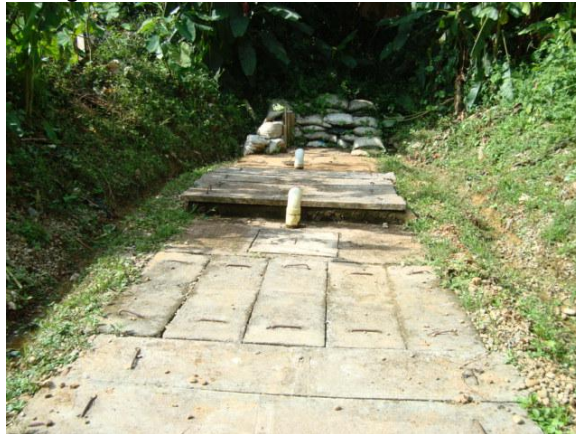
Figura 7. Planta de tratamiento de lixiviado
