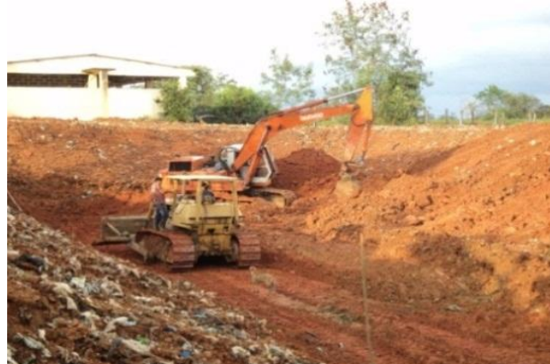
Figura 11. Obtención cotas de fondo (trinchera)
