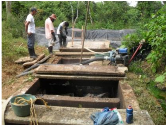
Figuras 31 y 32. Mantenimiento Planta tratamiento de lixiviados
