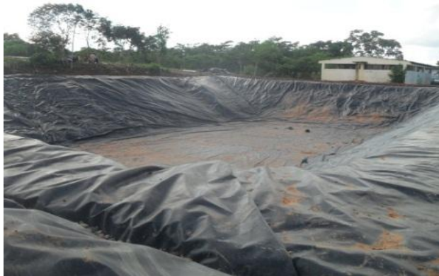
Figura 16. Celda sur Impermeabilizada
