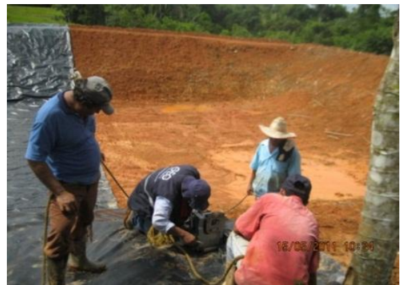
Figuras 14 y 15. Proceso de instalación y sellado
