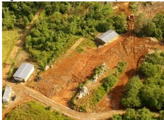
Figuras 4. Relleno sanitario - después
