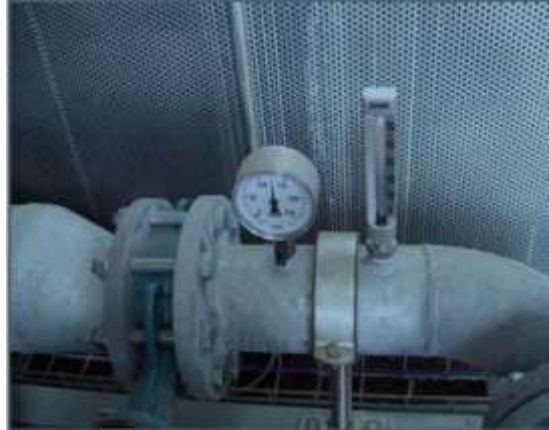
8. Control visual de temperatura y presión.
