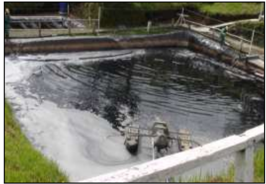
Reactor de lodos activados
