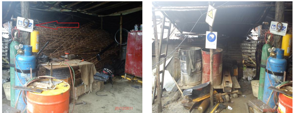
Figura 43. Señales bloqueada con herramientas, falta orden y limpieza taller PR 52 + 800
