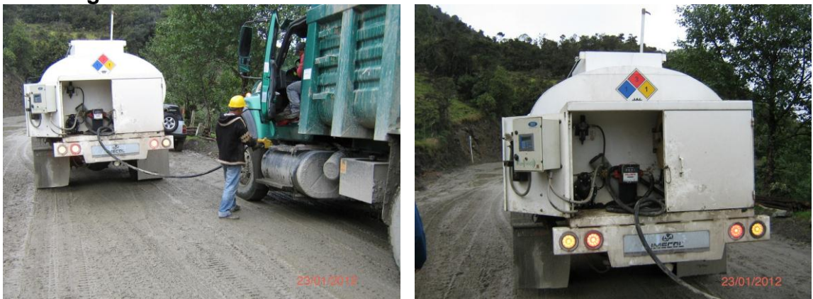
Figura 39. Abastecimiento de combustible en el frente de obra.
