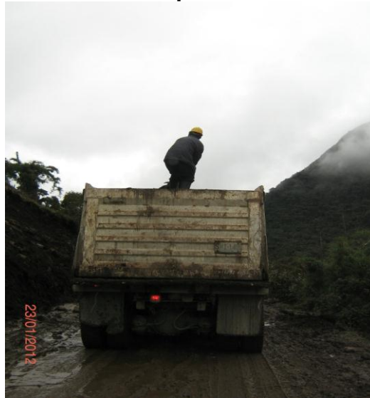
Figura 37. Trabajador realizando cubrimiento de materiales pétreos en volquetas.
