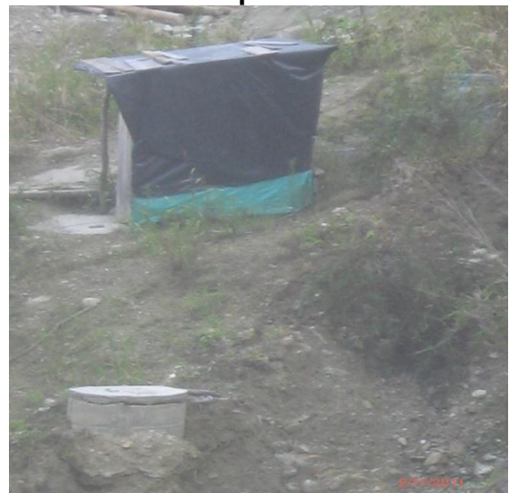
Figura 29. Sanitario provisional del frente de obra puente Guanacas
