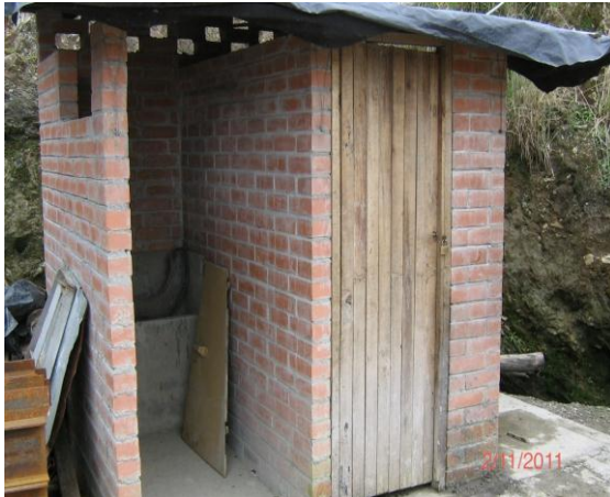
Figura 28. Sanitario provisional de la Planta PR 75 + 500
