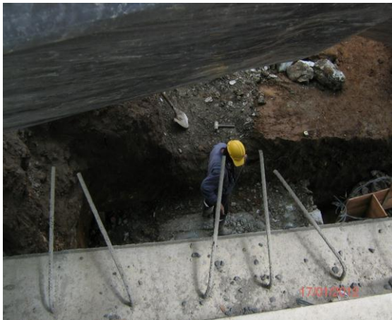
Figura 26. Ampliación del puente Chuscales PR 45 + 000
