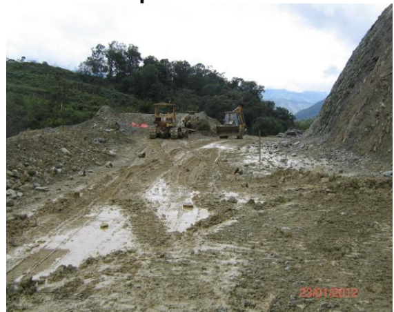
Figura 48. El paso por el puente Guanacas sin señalización preventiva
