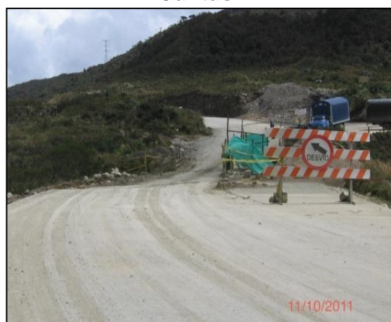
Figura 45. Señalización Puente Juntas
