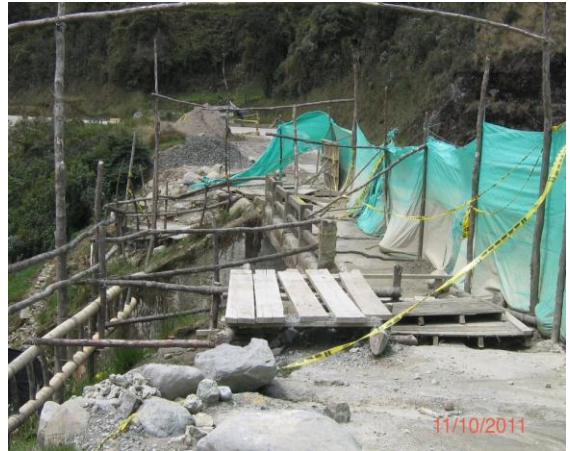
Figura 25. Ampliación Puentes juntas PR49+000
