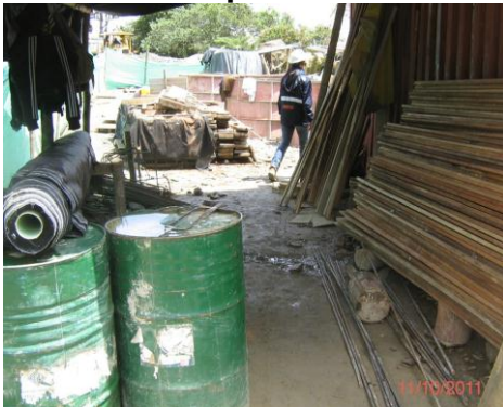
Figura 9. Almacén de materiales de construcción puente Guanacas
