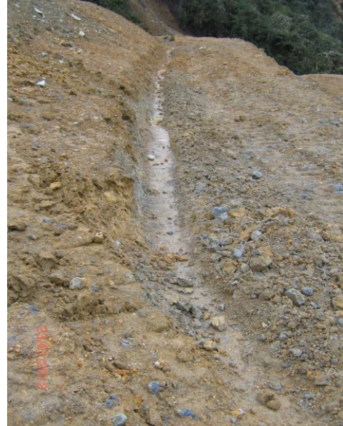
Figura 23. Canal para manejo de aguas lluvias en el SDM del PR 48 + 000
