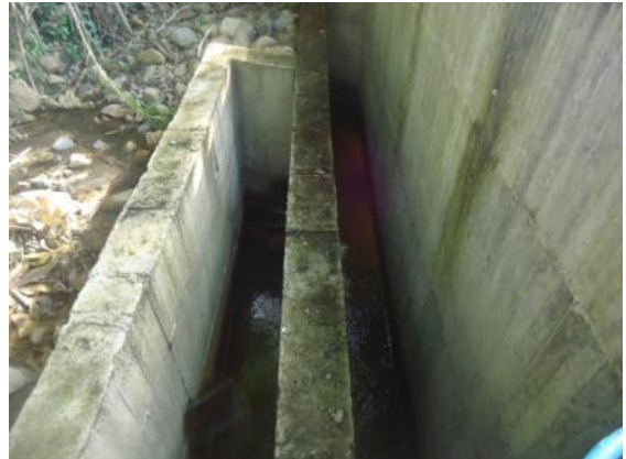
Figura 7. Obras realizadas sobre el lecho del río.
