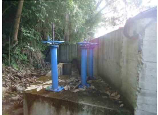
Figura 8. Estructura construida sobre el cauce el río.
