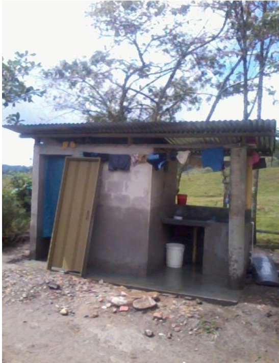
Figura 15. Batería sanitaria construida.
