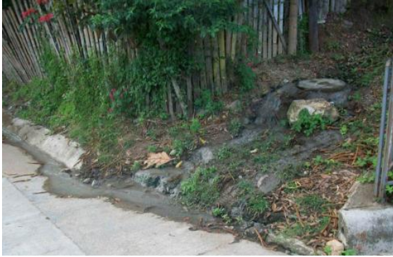
Figura 27. Alcantarilla a un costado de la estación de gasolina que permanece rebosada todo el tiempo.
