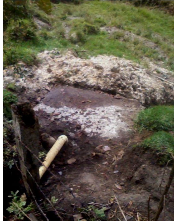
Figura 16. Pozo séptico construido.
