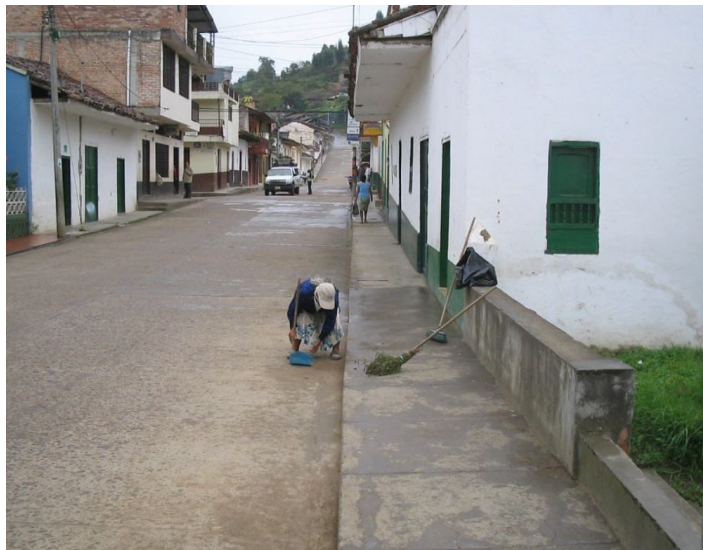
Figura 11 .Estado de las vías luego de las actividades realizadas su limpieza.
