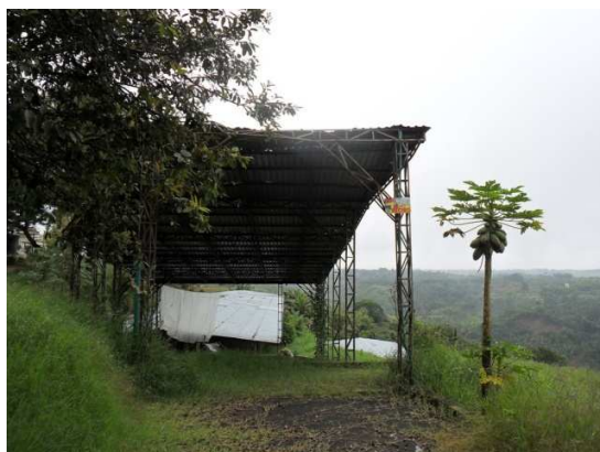
Figura 5. Área de recepción de Residuos
