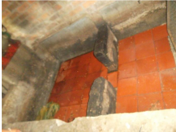
Figura 5. Tanque dual de concreto para fermentación, finca La Viña, vereda Los Tendidos
