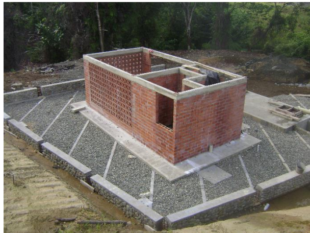
Figura 42. Grado de avance caseta de control EBAR 02.
