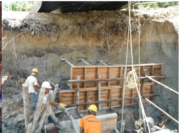
Figura 47. Entibado de formaletas de madera.
