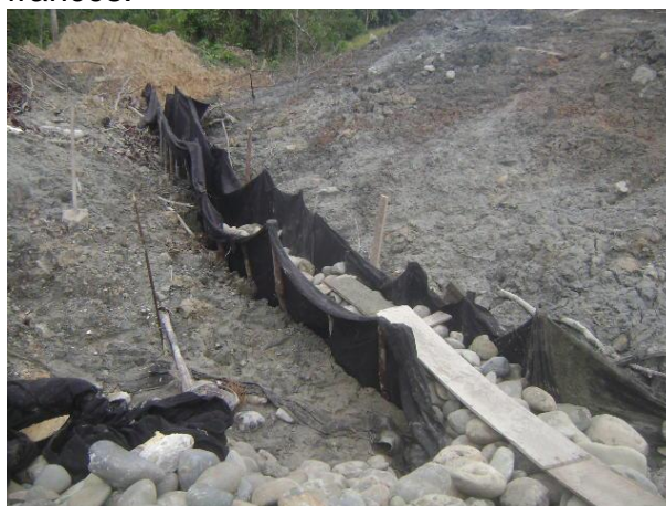
Figura 26. Construcción de filtro francés.
