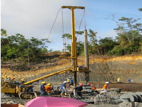
Figura 9. Excavación de pilotes.
