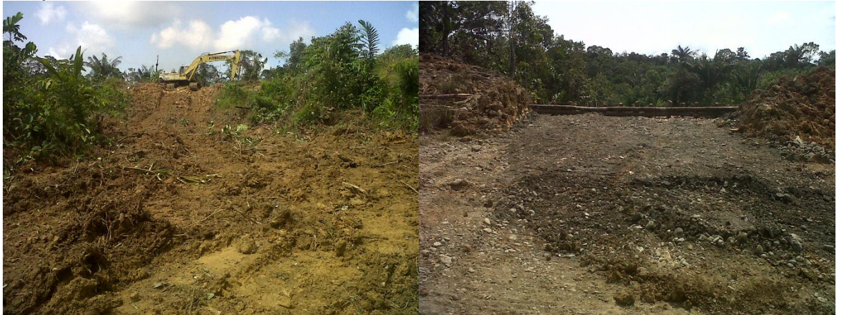
Figura 7. Vía de acceso para la Figura 8. Carreteable para volquetas. maquinaria.
