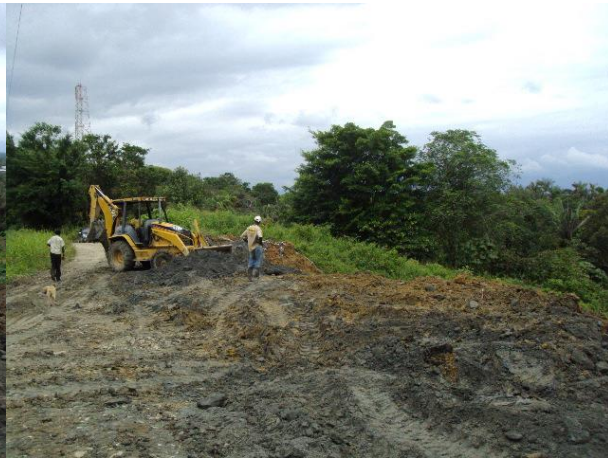
Figura 4. Maquinaria en adecuación de material de excavación en SDM 1.
