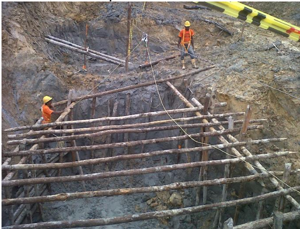
Figura 34. Uso de arnés en actividades de excavación profunda.
