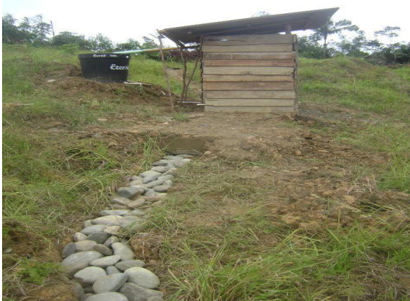
Figura 30. Construcción de baño en la zona de PTAR.
