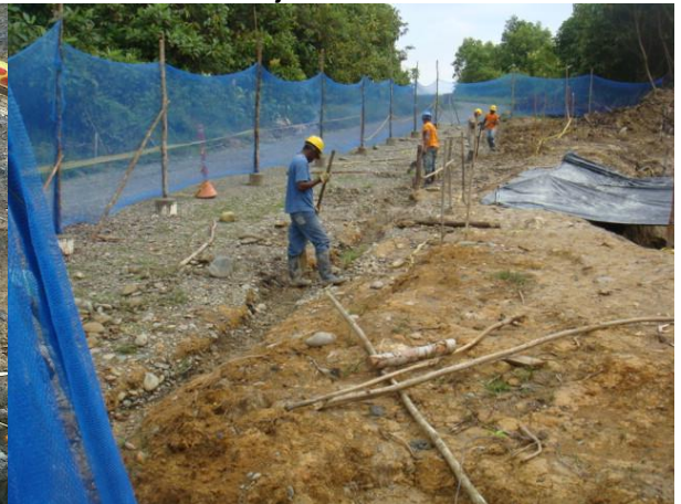
Figura 35. Cerramiento y delimitación del área de trabajo.
