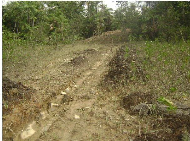
Figura 23. Filtro francés construido en botadero 2.
