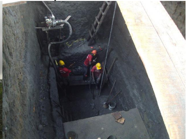
Figura 33. Uso de protectores de oídos en excavaciones profundas con niveles de ruido mayores a 90 db.
