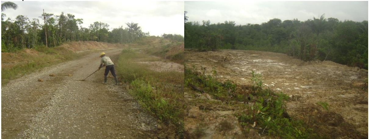
Figura 24. Limpieza de tramo Campamento PTAR – botadero. Figura 25. Estado final del botadero 2.
