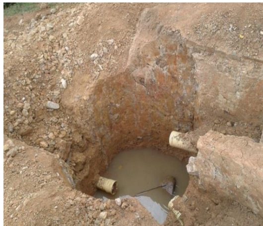
Figura 8. Excavación para construcción de cámara de inspección, 15 de noviembre de 2013.
