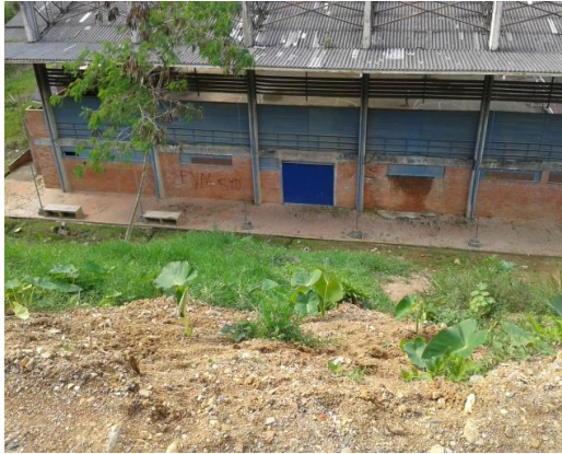
Figura 32. Arrastre de material a instalaciones, 28 de noviembre de 2013.
