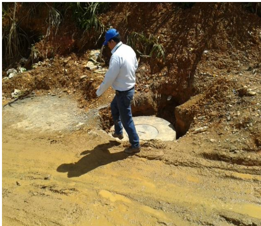
Figura 17. Cámara de inspección sistema de alcantarillado, 28 de noviembre de 2013.
