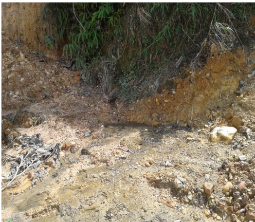
Figura 21. Lodos generados por excavación sistema de alcantarillado, 28 de noviembre de 2013.
