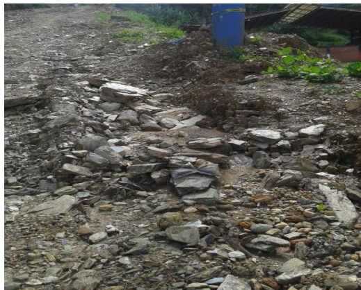
Figura 33. Arrastre de material a instalaciones, 28 de noviembre de 2013.
