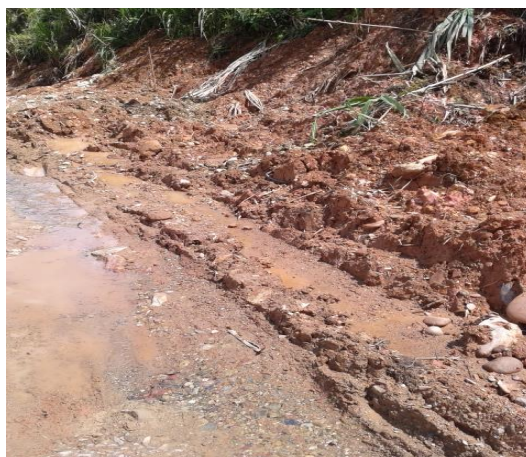
Figura 19. Zona excavada sobre la vía principal, 28 de noviembre de 2013.
