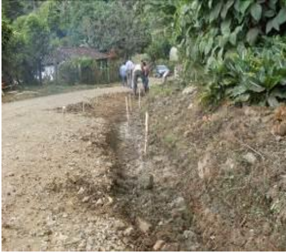
Figura 23. Manejo de aguas superficiales.
