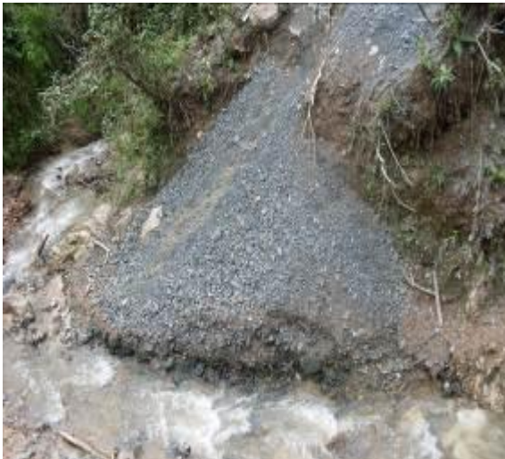
Figura 3. Inadecuado manejo y disposición final de escombros.
