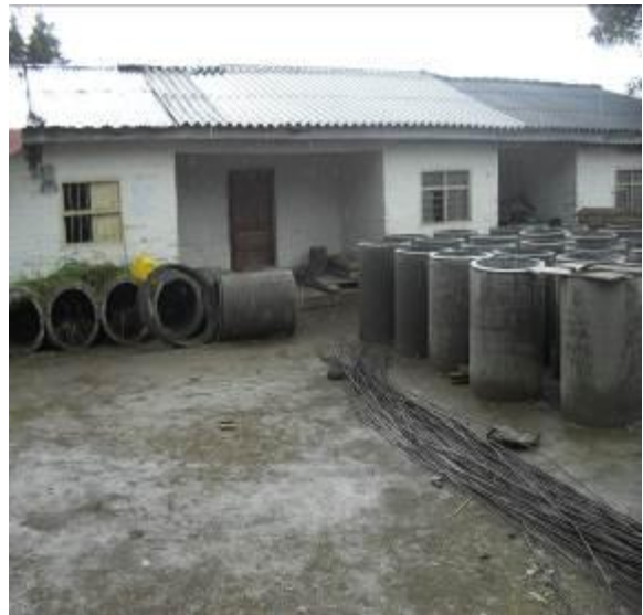
Figura 6. Funcionamiento de campamento y sitios de acopio.
