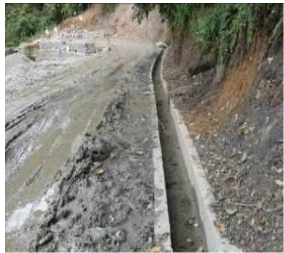
Figura 4. Manejo de aguas superficiales.
