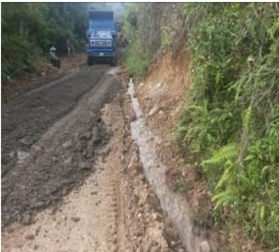
Figura 18. Manejo de aguas superficiales.
