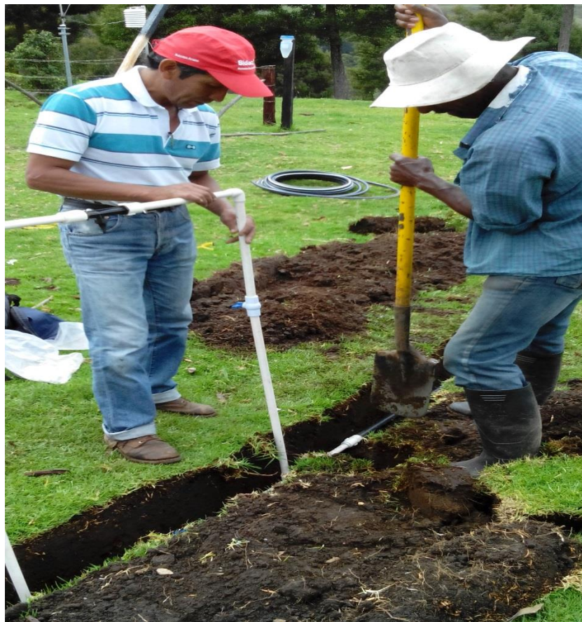
Figura 22. Construcción del sistema de fertiriego. Vereda Santa Elena
