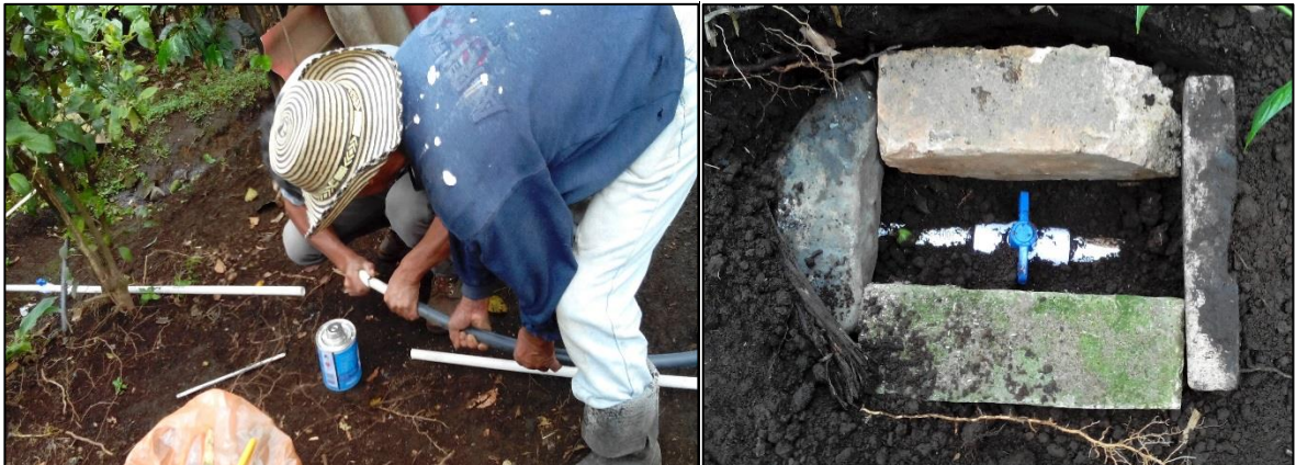
Figura 29. Construcción del sistema de riego. Vereda El Hogar
