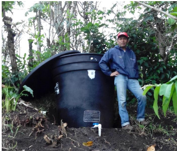
Figura 24. Tanque de almacenamiento de agua. Vereda Santa Elena
