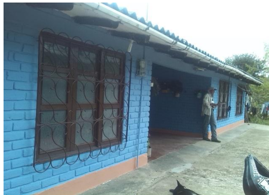
Figura 3 Vivienda de Silvia en paredes de ladrillo
