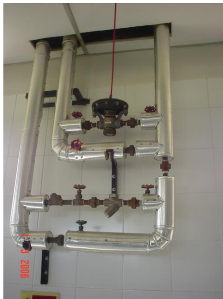
Figura 3.9. Válvula de vapor
